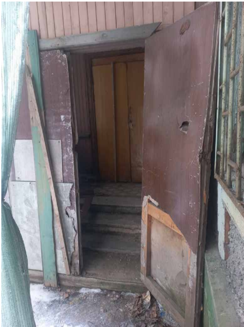
Фото 5. Главный вход в здание.
