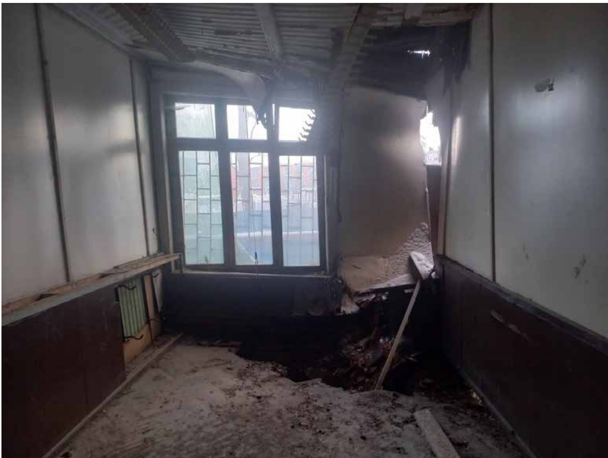
Фото 18. Внутренние помещения. 1 этаж.
