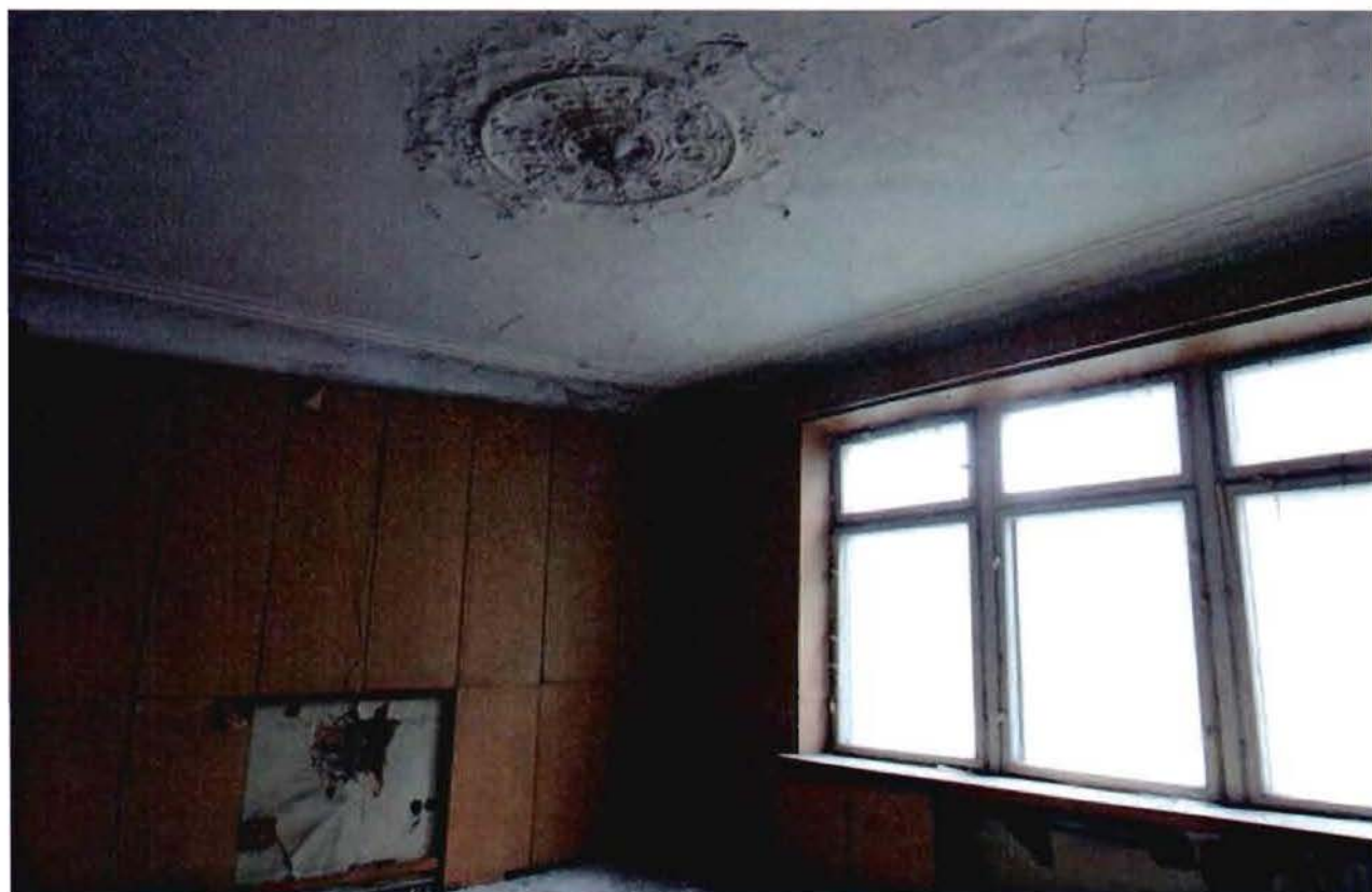
5. Помещение 2-го этажа.
