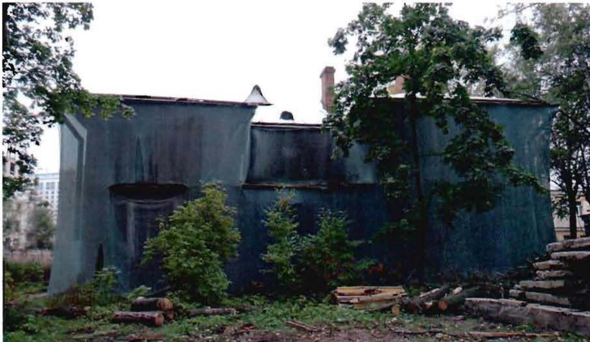
1. Восточный фасад объекта культурного наследия.
