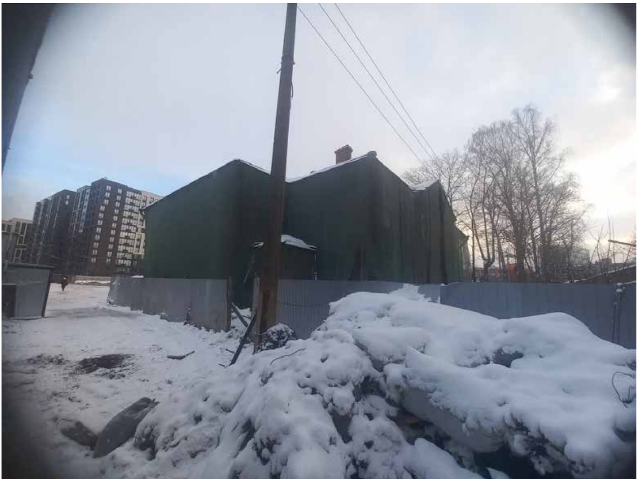
Фото 4. Юго-западный и северо-западный фасады.
