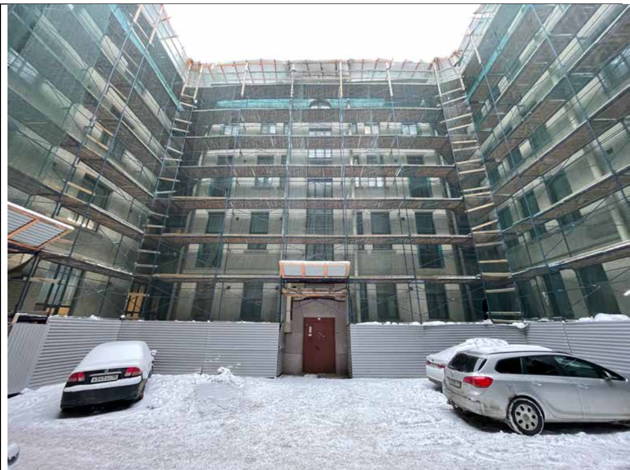
12. Дворовый фасад объекта (2-й двор)
