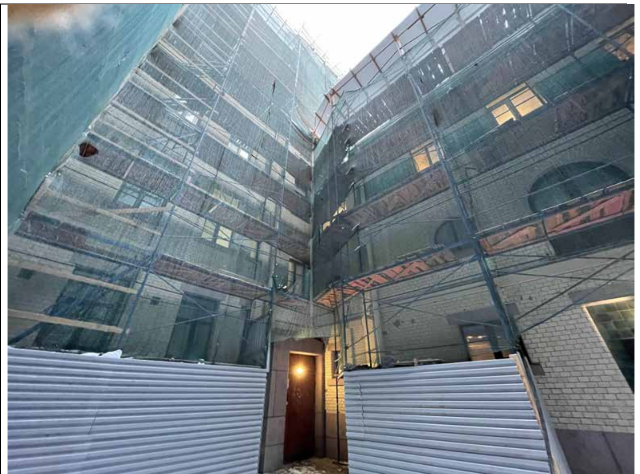
17. Дворовый фасад объекта (3-й двор)
