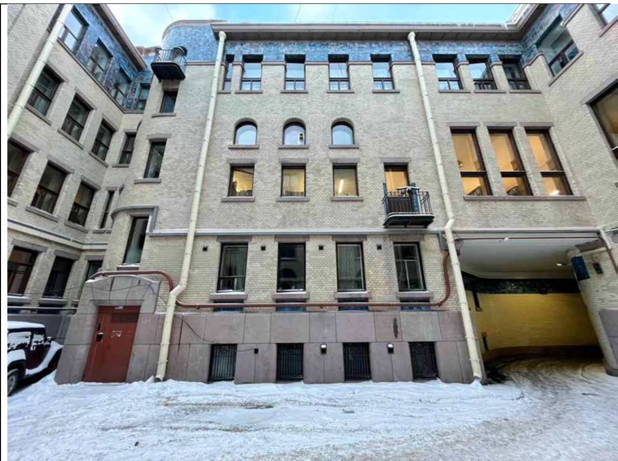
9. Дворовый фасад объекта (1-й двор)
