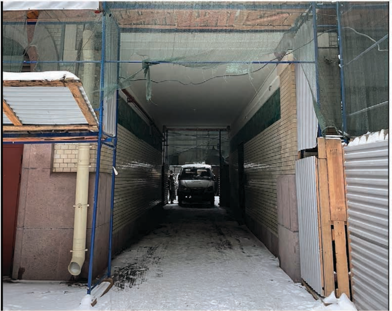
15. Арка дворового фасада между вторым и третьим дворами
