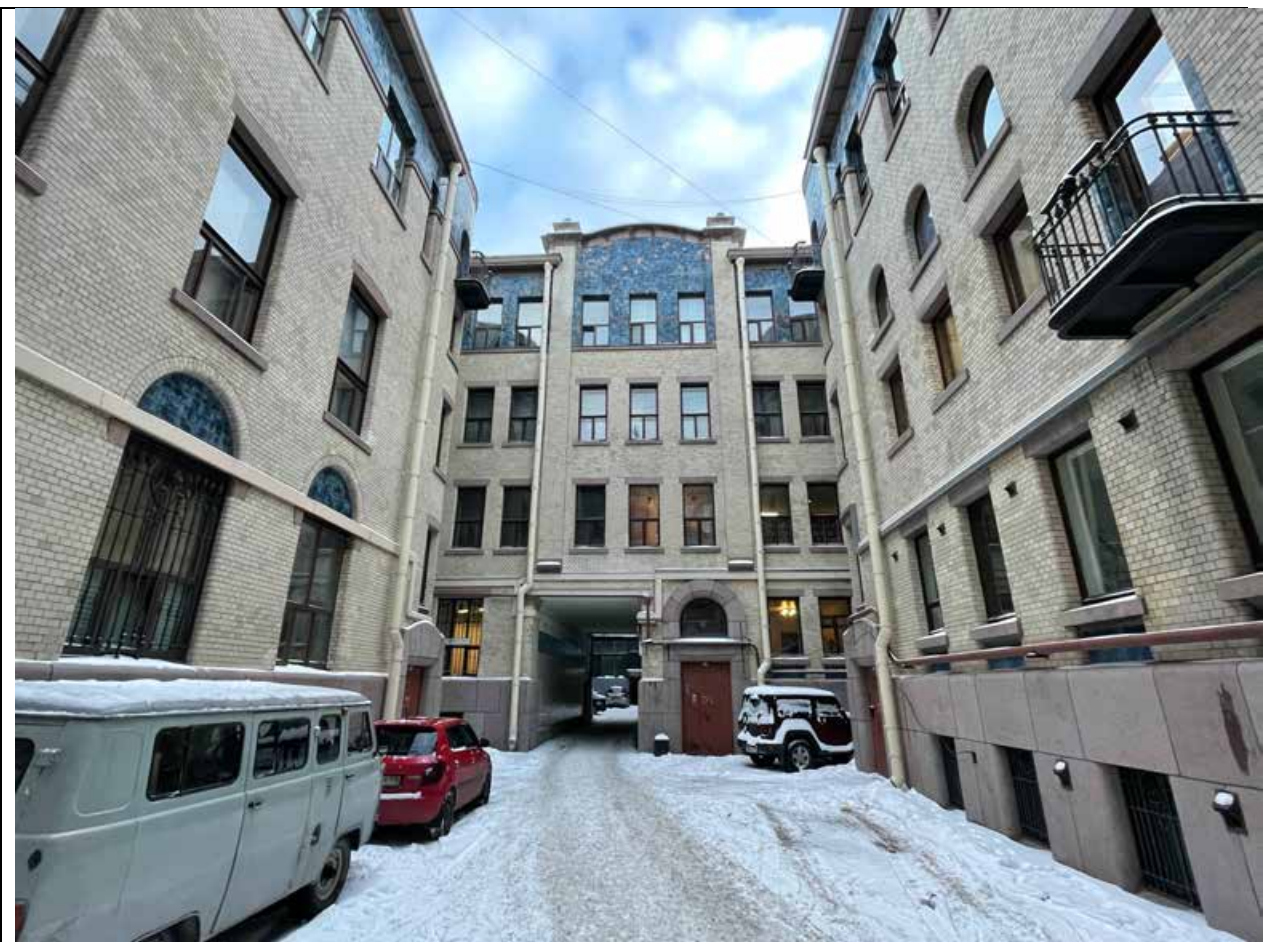
8. Дворовый фасад объекта (1-й двор)
