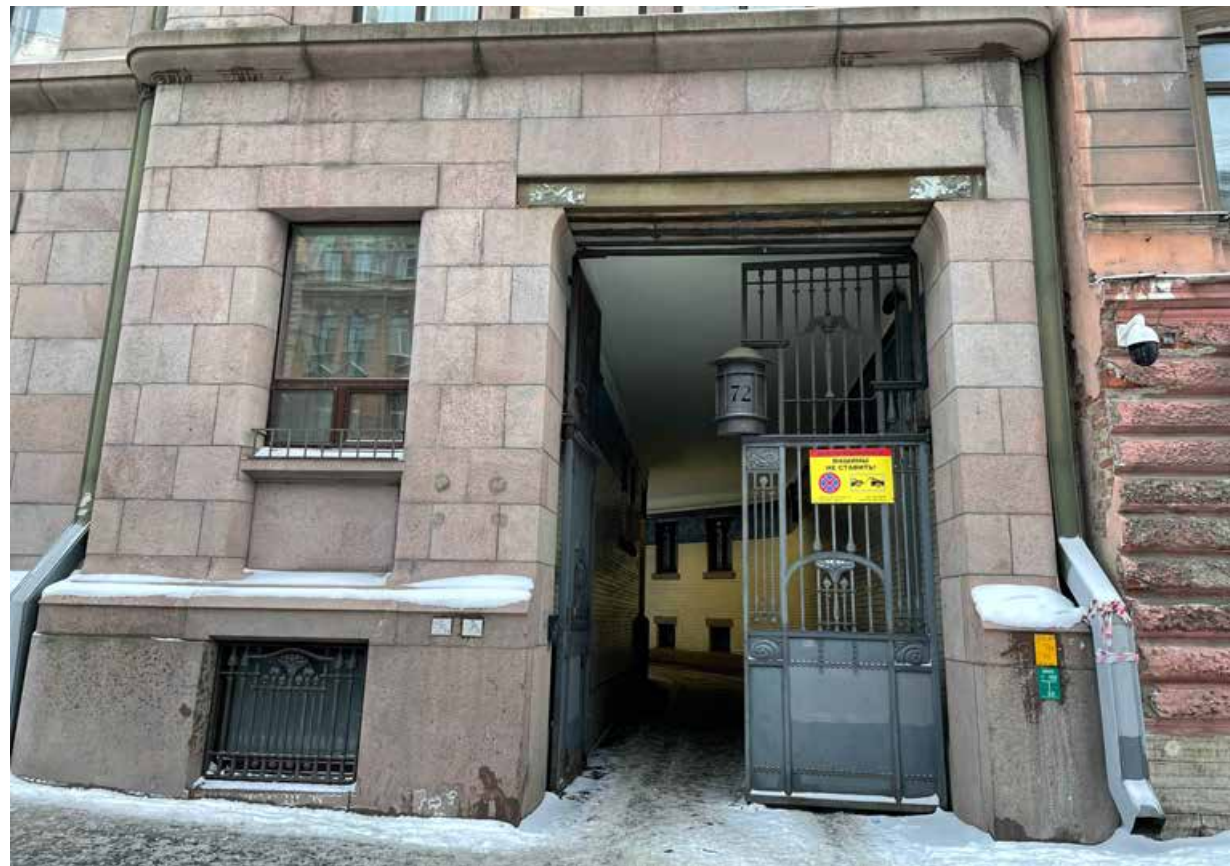
4. Арка лицевого фасада со стороны ул. Марата
