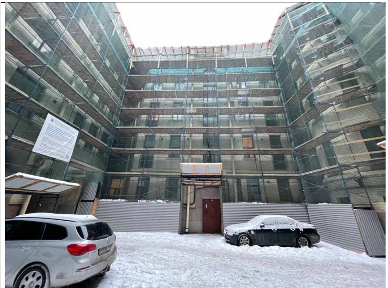
13. Дворовый фасад объекта (2-й двор)
