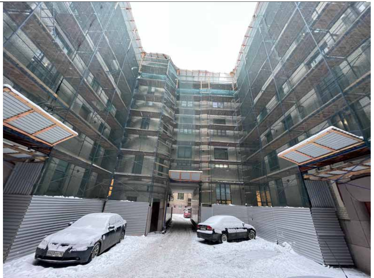
14. Дворовый фасад объекта (2-й двор)
