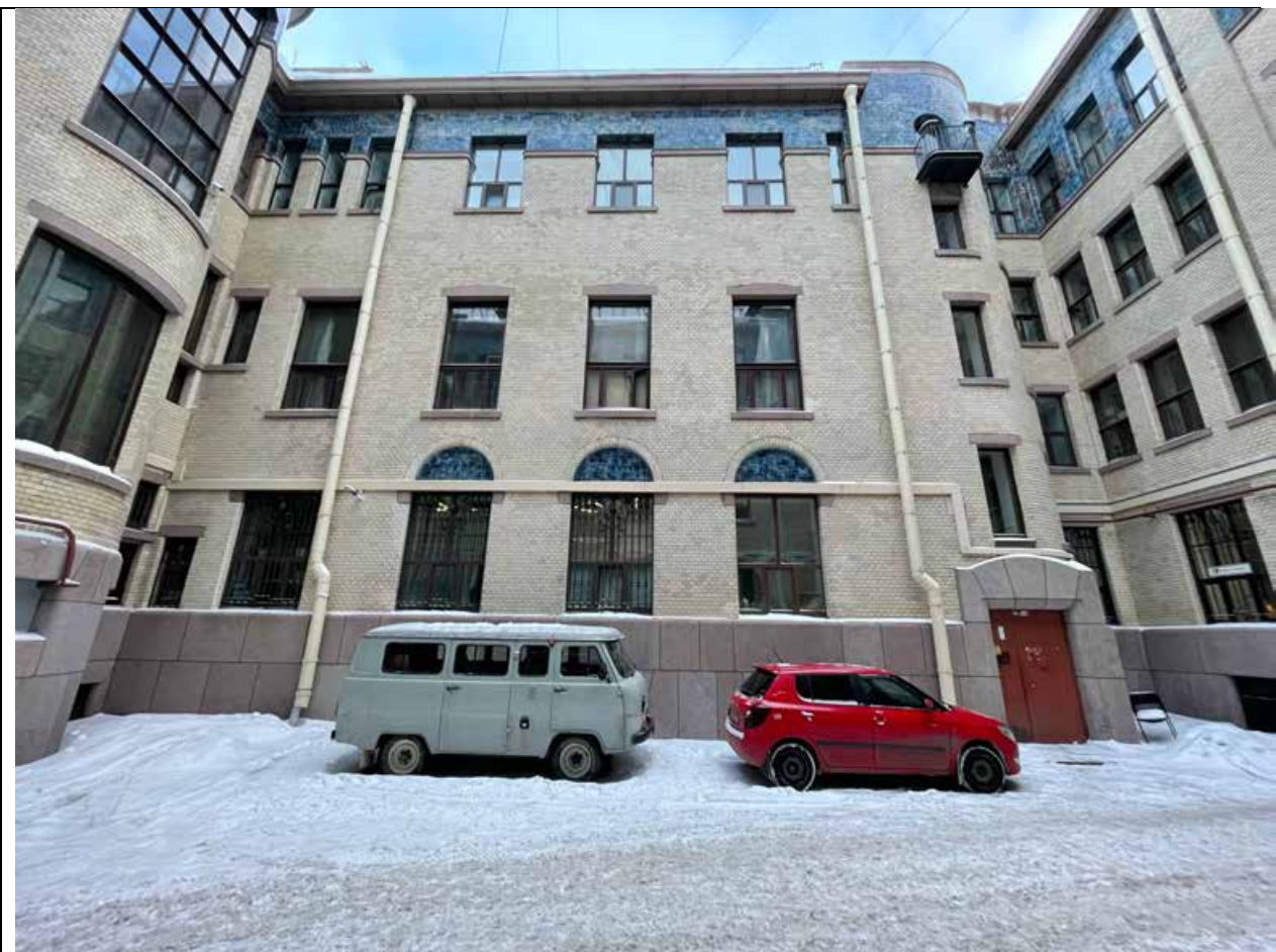
7. Дворовый фасад объекта (1-й двор)
