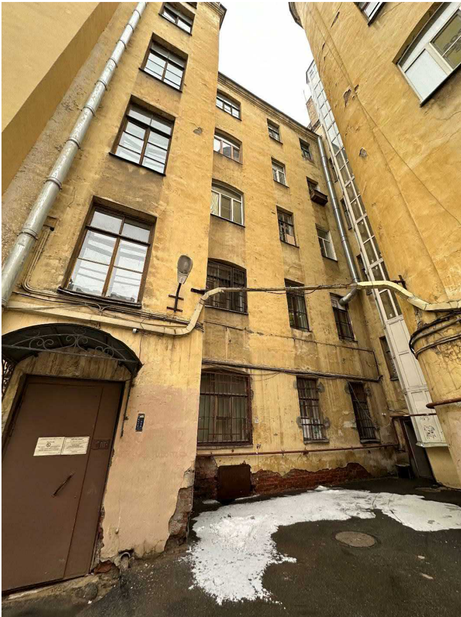
Фото 48. Здание детского сада № 44. Вид со двора
