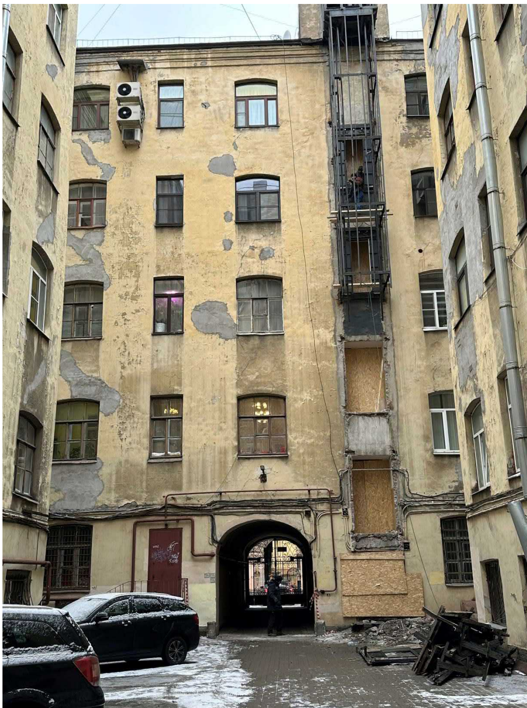
Фото 47. Здание детского сада № 44. Вид со двора
