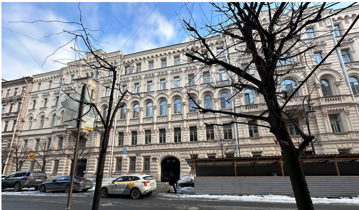
Фото 46. Здание детского сада № 44. Фасад со стороны ул. Пушкинской
