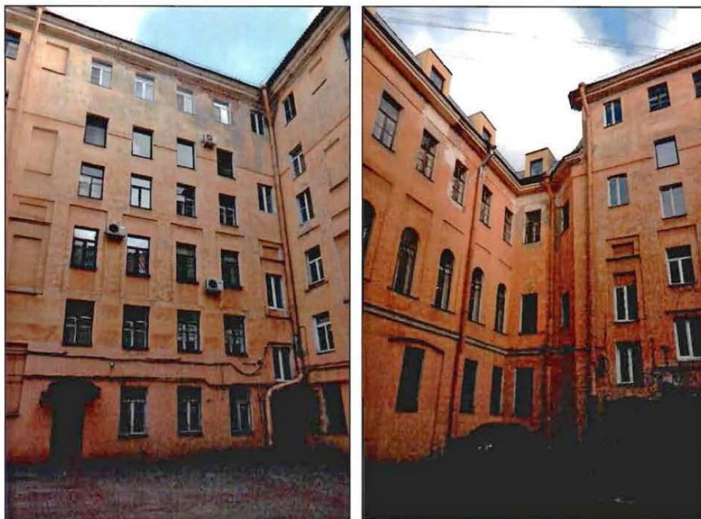
2, 3. Общий вид дворовых фасадов.
