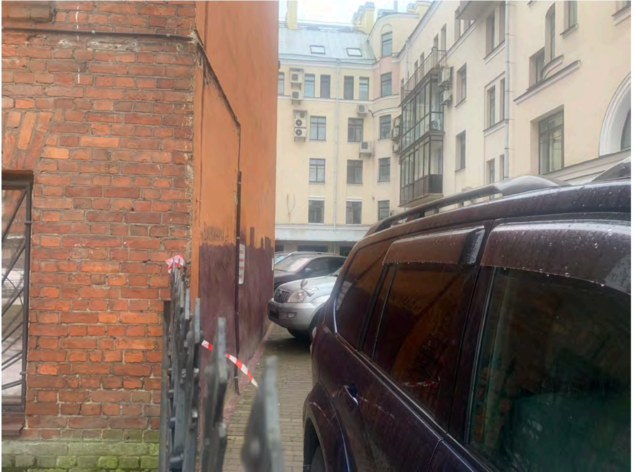
9. Объект культурного наследия регионального значения «Дом В.П. Осетрова» по адресу: г. Санкт-Петербург, ул. Вакуленчука, дом 4, литера А. Фрагмент фасада. Вид с юга.
