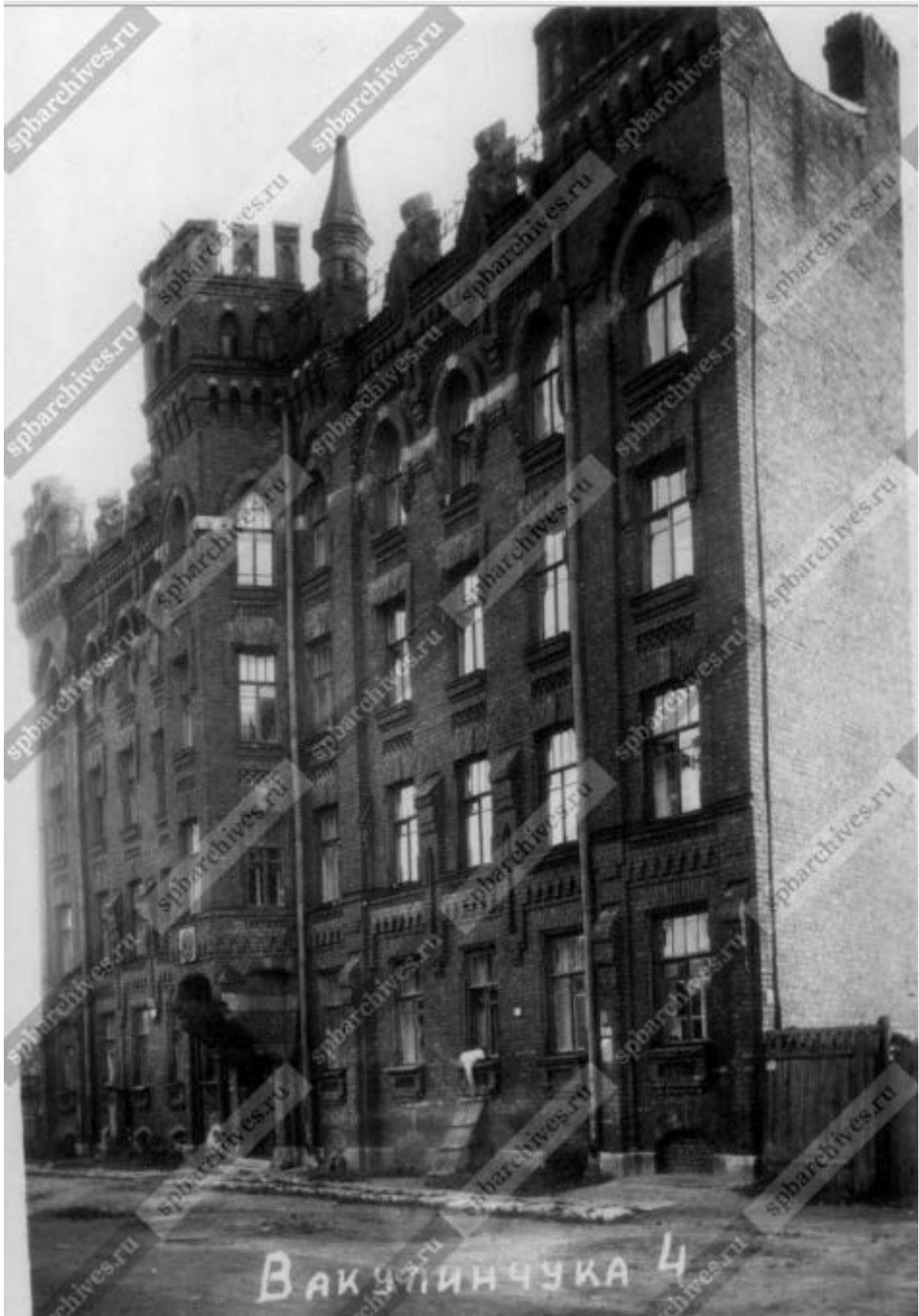
Илл. 21. Угловой фасад дома №4 на улице Вакуленчука (бывший доходный дом О.П.Строковой, архитектор Н.Н. Клименко, 1900 г.). Дата съёмки: 1961 г.// ЦГАКФФД СПб. Архивный шифр: Гр 73525.
