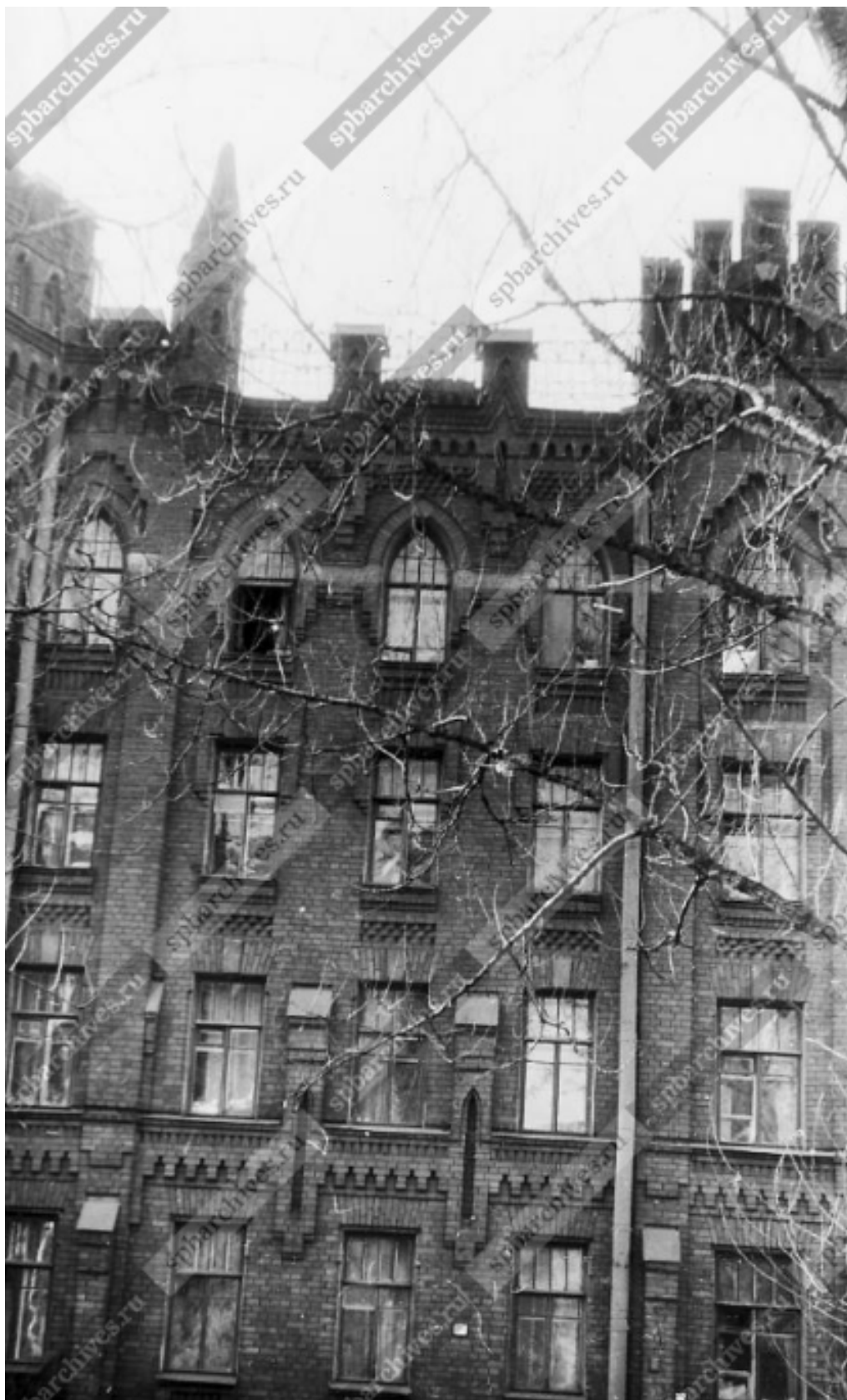
Илл. 22. Вид части центрального фасада жилого дома № 4 на улице Вакуленчука (бывший доходный дом О.П.Строковой, архитектор Н.Н.Клименко, 1900 г.). Дата съёмки: 03 апреля 1988 г. // ЦГАКФФД СПб. Архивный шифр: Ар 225978.
