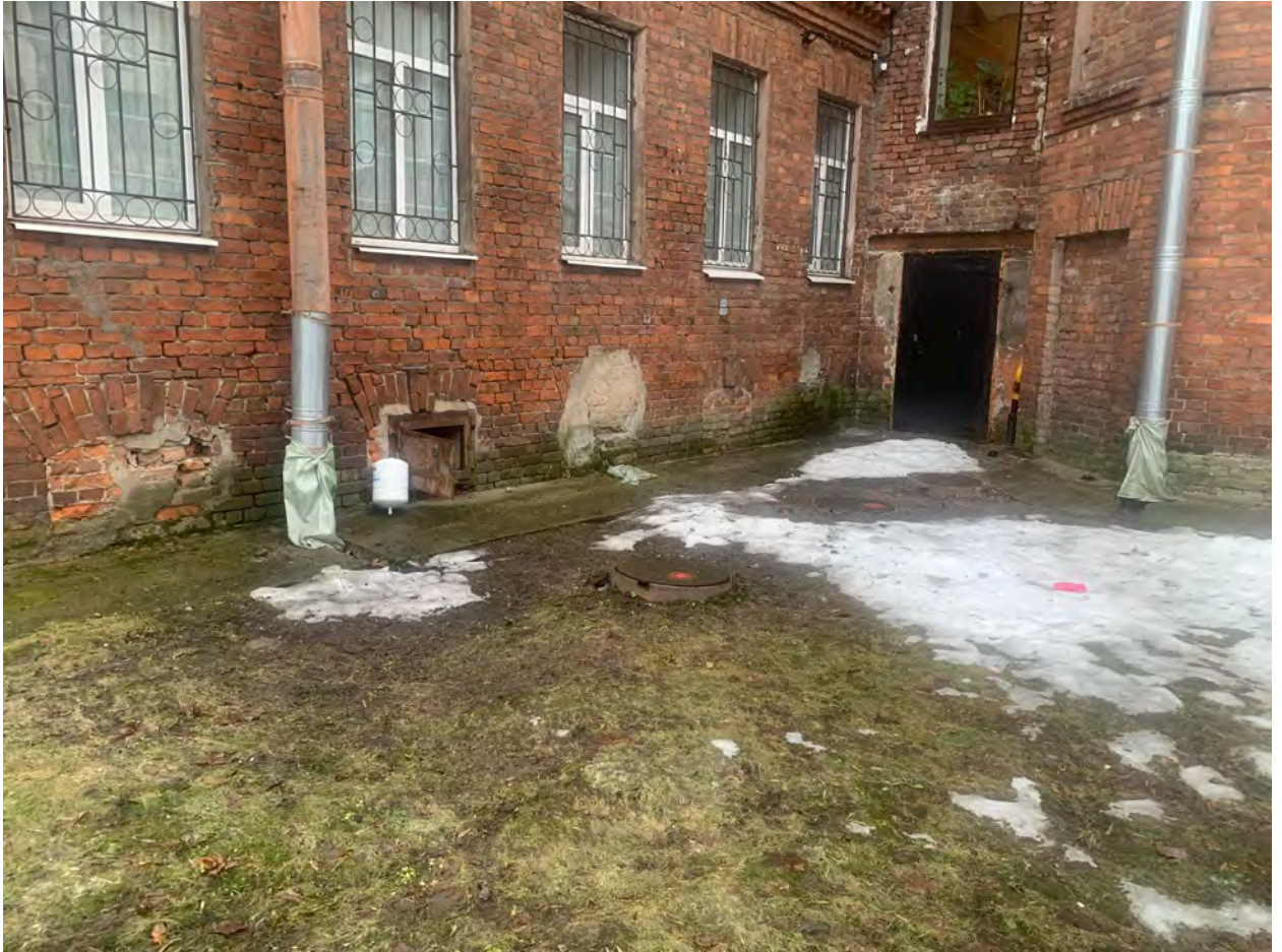
11. Объект культурного наследия регионального значения «Дом В.П. Осетрова» по адресу: г. Санкт-Петербург, ул. Вакулчука, дом 4, литера А. Фрагмент фасада. Вид с запада.
