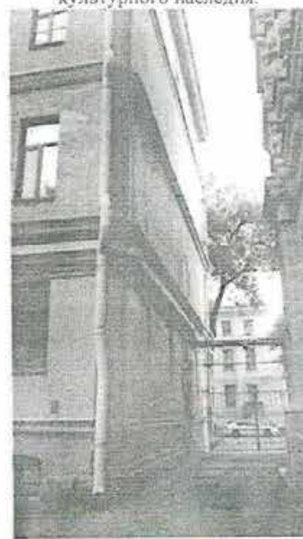
4. Южный фасад объекта культурного наследия.
