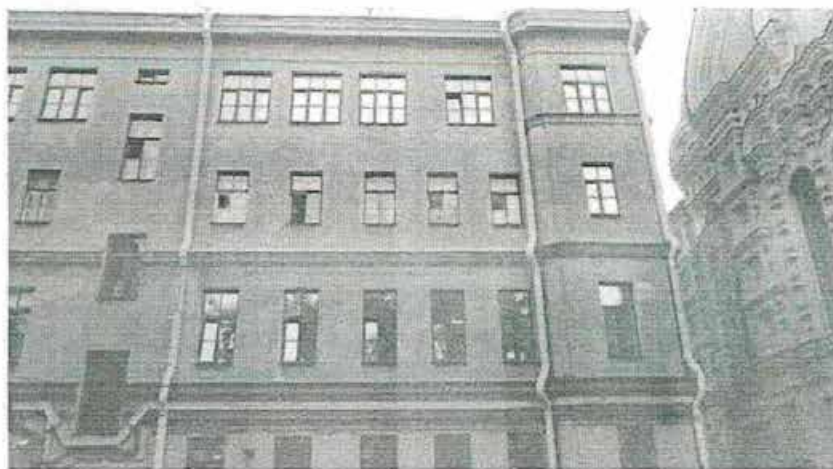
8. Фрагмент западного фасада объекта культурного наследия.
