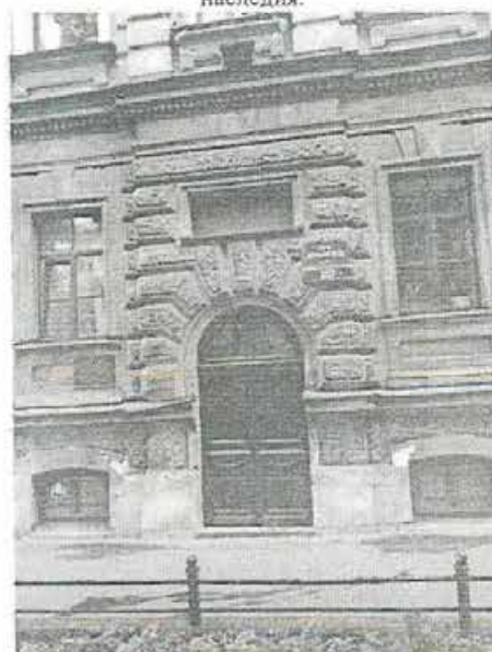
3. Вход со стороны восточного фасада объекта культурного наследия.
