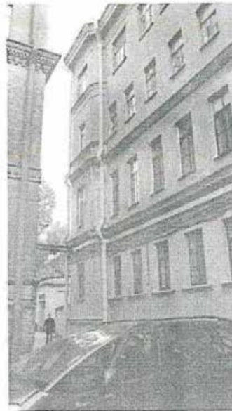
6. Фрагмент западного фасада объекта культурного наследия.
