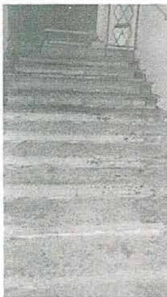
12. Внутренняя планировочная структура объекта культурного наследия. Лестница главного входа.
