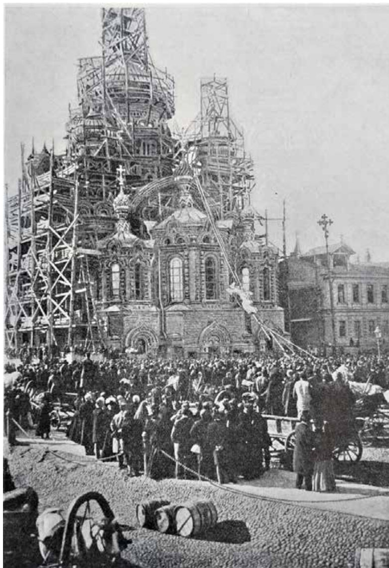
6. Строительство храма Успения Пресвятой Богородицы. Подъем главного креста. Из книги «Косяков В.А. Постройка храма и переустройство прочих зданий подворья Киево-Печерской лавры в С.-Петербурге - СПб., 1900». Фотография. 1897 г. Источник: интернет-ресурс https://pastvu.com .
