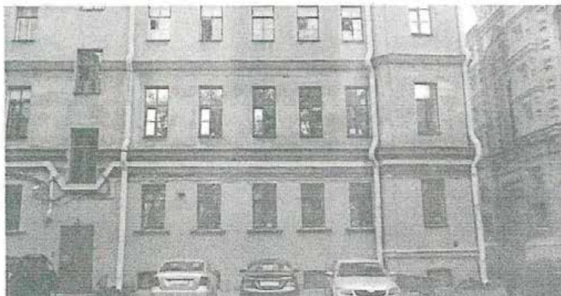
7. Фрагмент западного фасада объекта культурного наследия.
