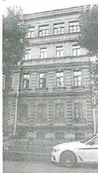
2. Фрагмент восточного фасада объекта культурного наследия.
