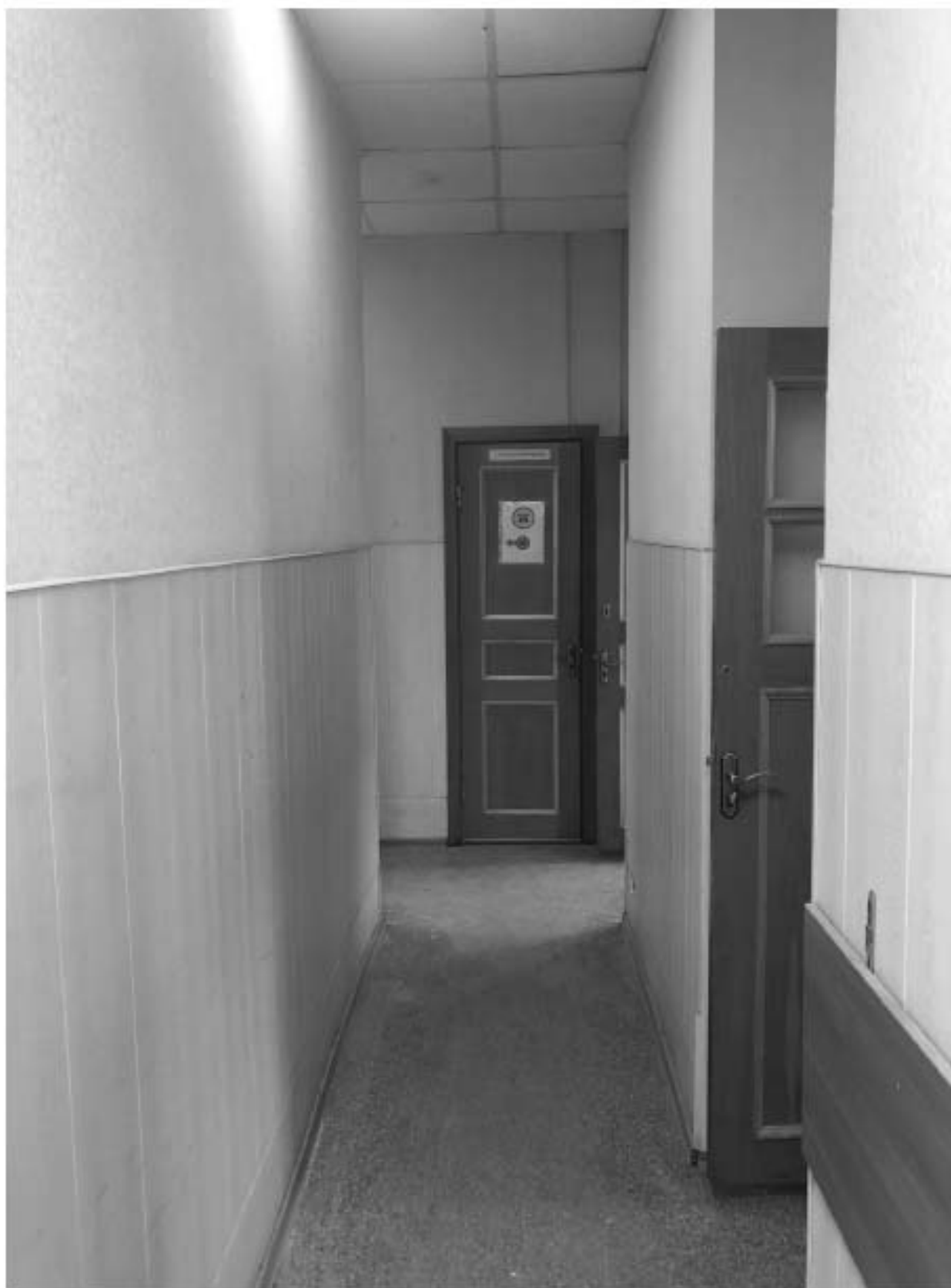
20. Фрагмент интерьера коридора (помещение 3/21.9).
