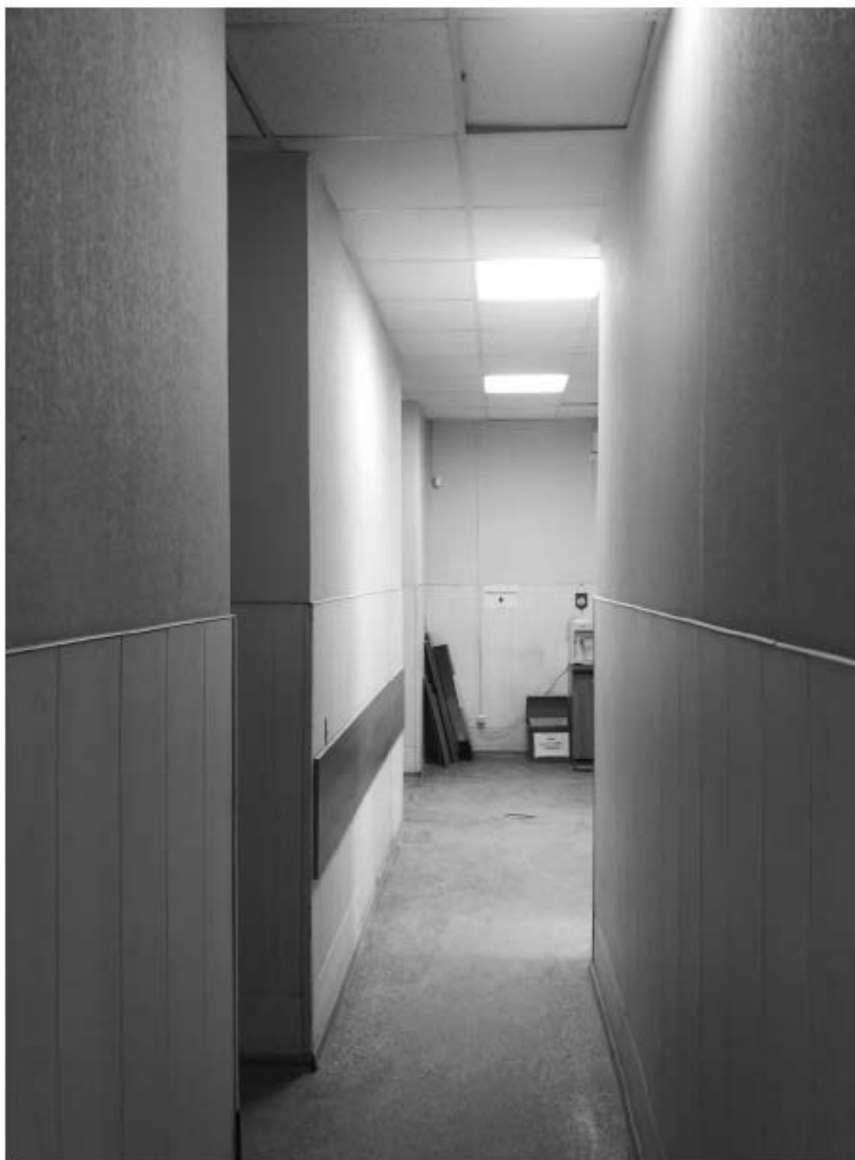
12. Фрагмент интерьера коридора (помещение 3/21.9);
