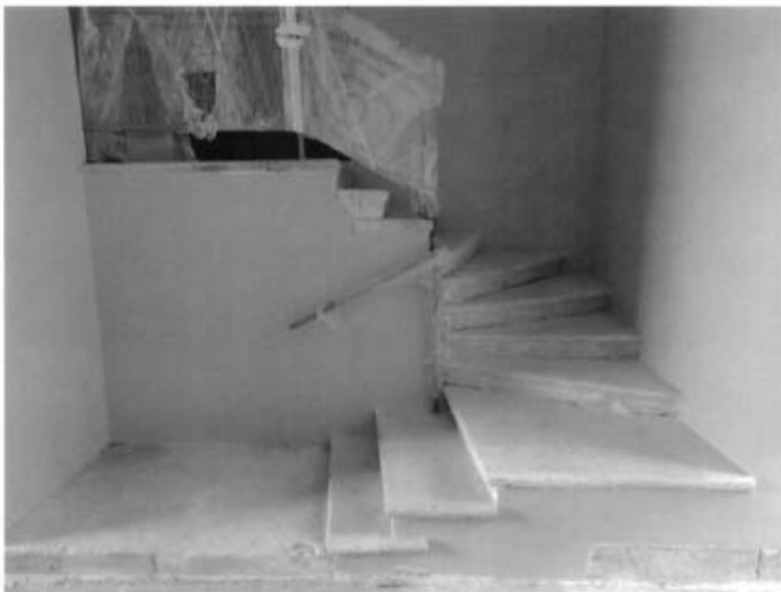
3. Крыльцо со ступенями в воротном проезде объекта культурного наследия
