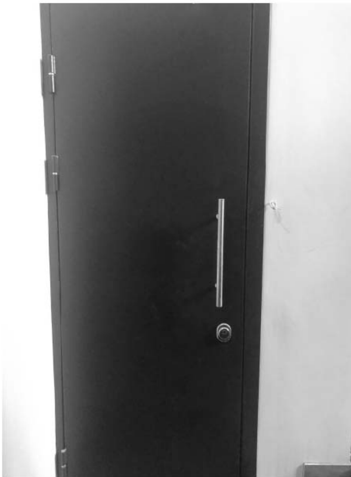
3. Вид на входную дверь в помещение;
