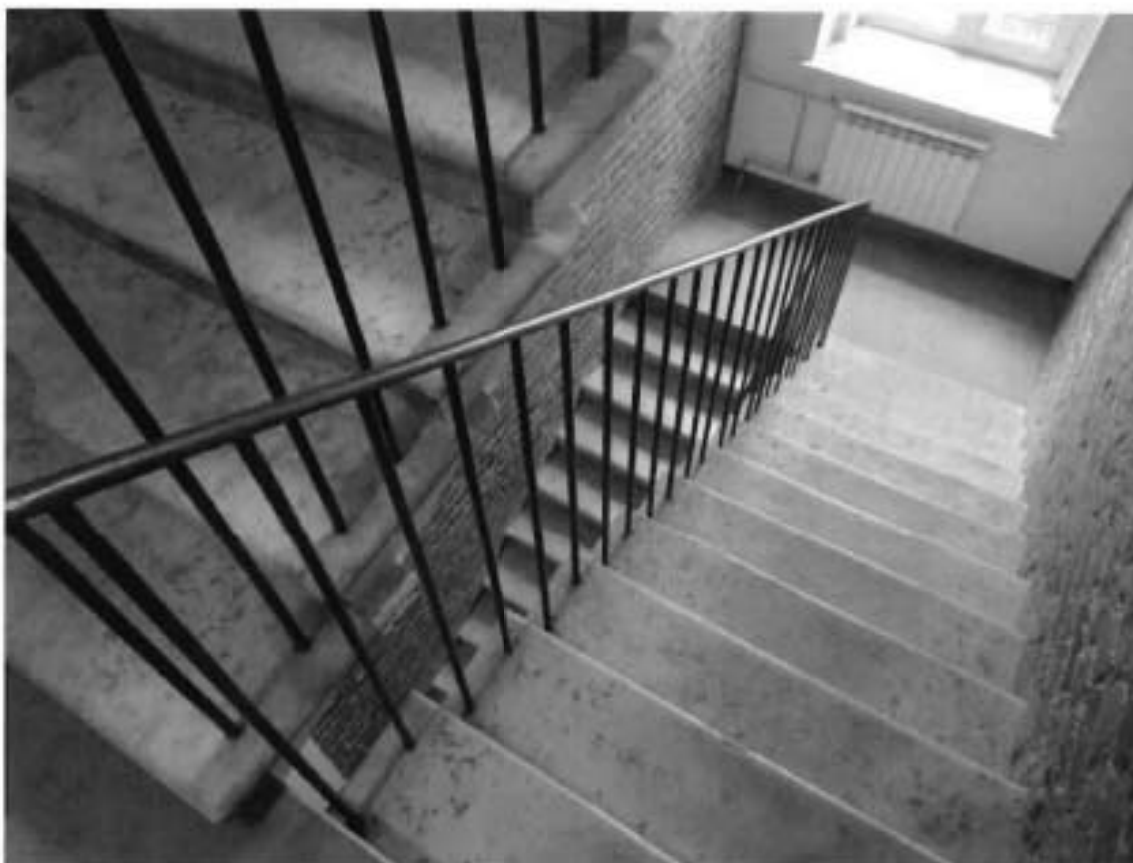
4. Лестница Л-1 объекта культурного наследия
