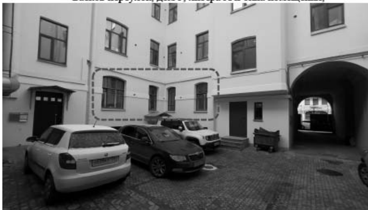
2. Вид на объект культурного наследия регионального значения «Дом А.И. Ерошенко», расположенного по адресу: г. Санкт-Петербург, Басков переулок, дом 5, литера А и окна помещения;
