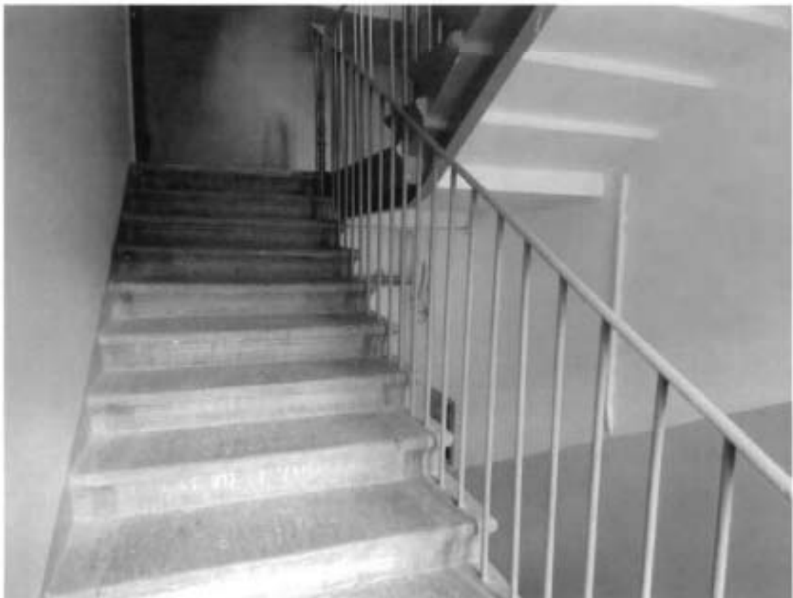
7. Лестница Л-3 объекта культурного наследия
