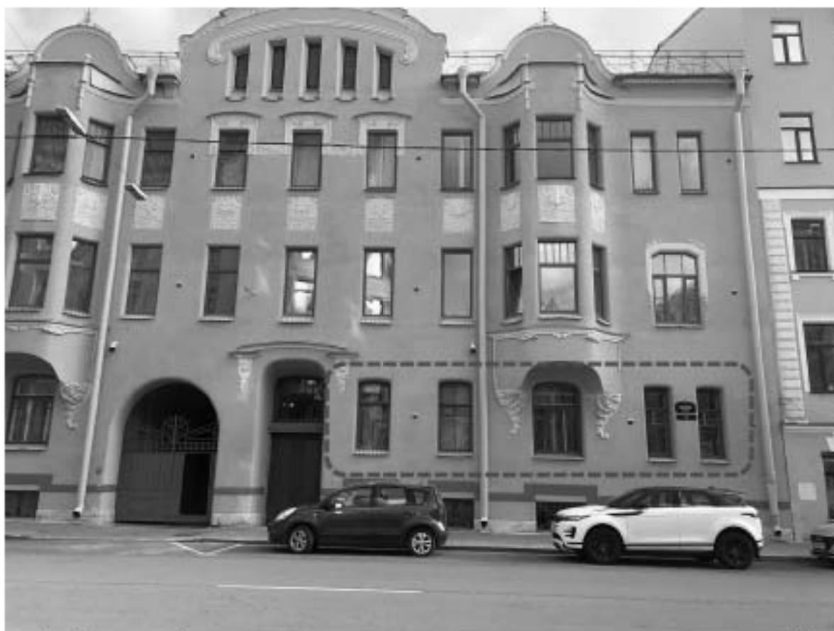
1. Вид на объект культурного наследия регионального значения «Дом А.И. Ерошенко», расположенного по адресу: г. Санкт-Петербург, Басков переулок, дом 5, литера А и окна помещения;
