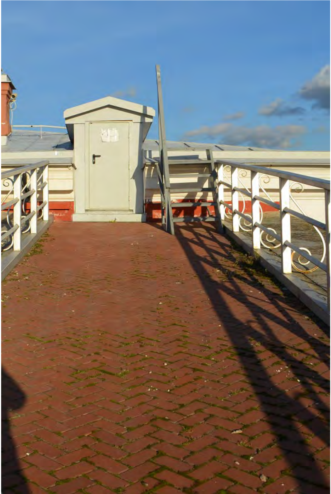
Фото 09. ОКН федерального значения «Кавальер Анны Иоанновны». Вход в чердачные помещения. Съёмка 24.07.2023 г.
