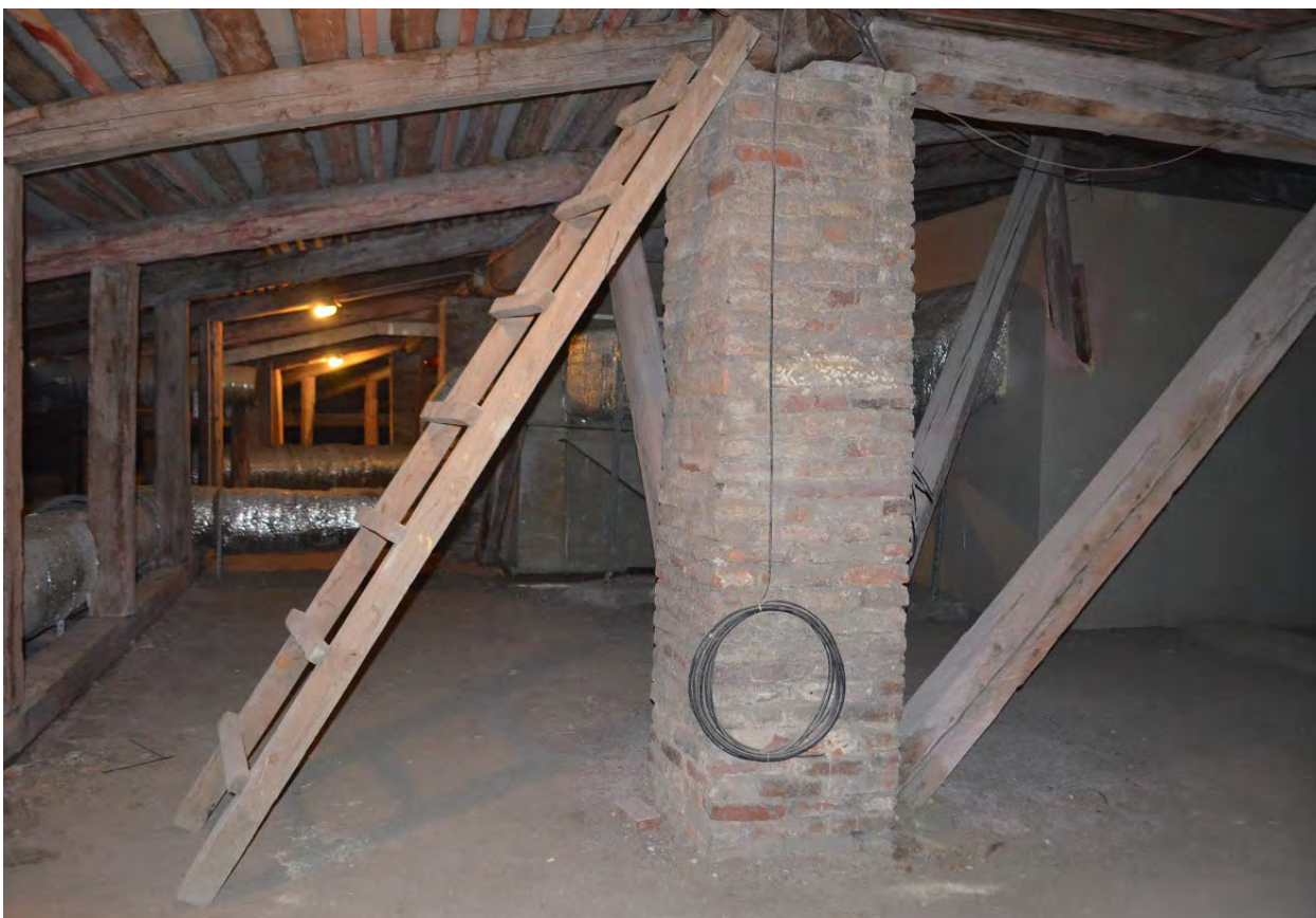
Фото 12. ОКН федерального значения «Кавальер Анны Иоанновны». Чердак. Стропильная система. Фрагмент. Съёмка 24.07.2023 г.
