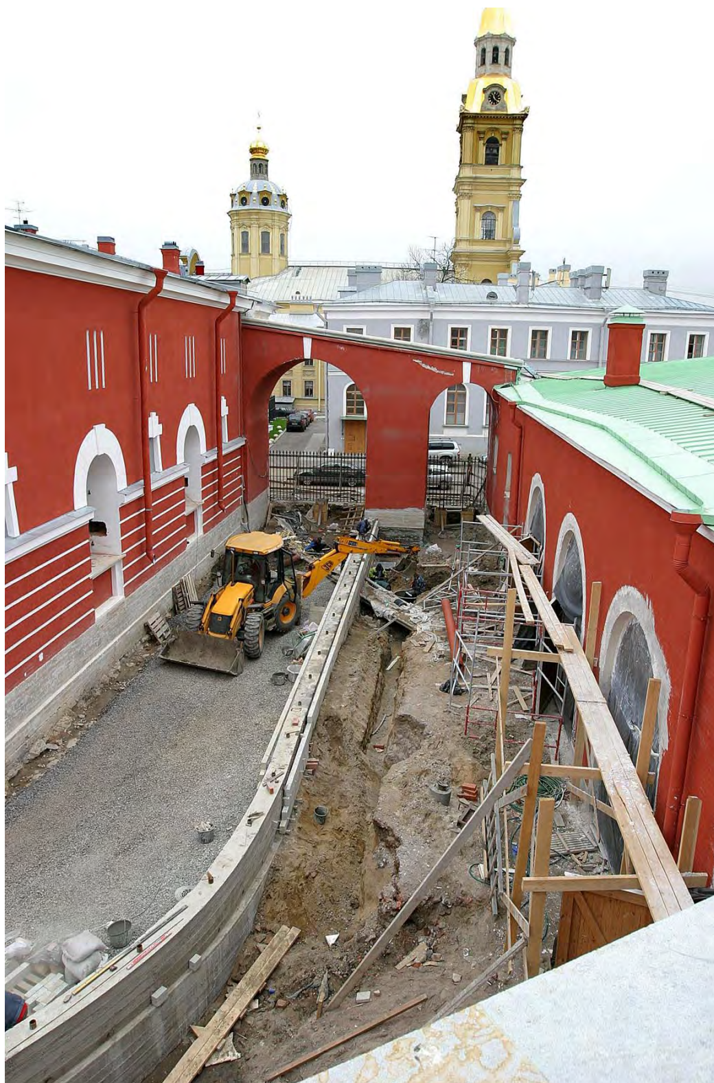
Илл.57. Фотография 2011 г. Работы по устройству подпорных стен музеефицированного канала вдоль кавальера Анны Иоанновны. КГИОП.
