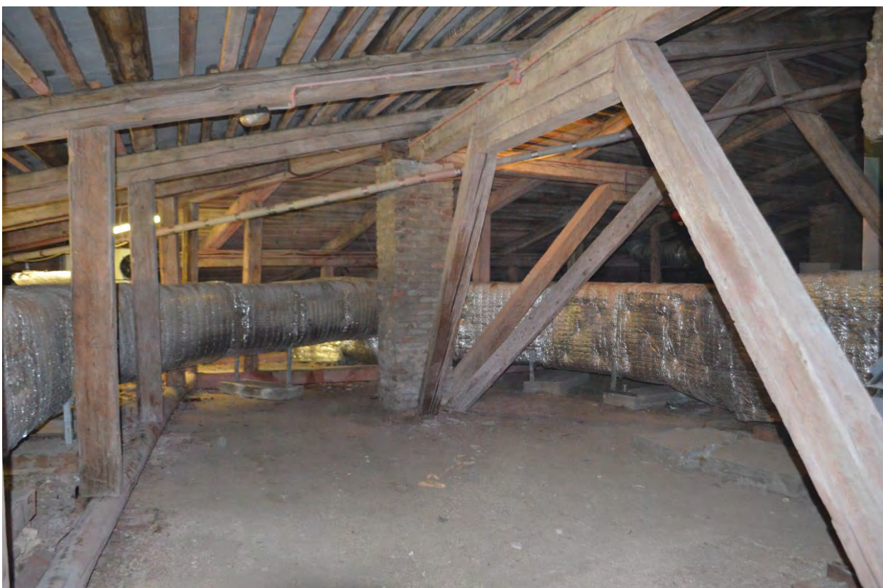
Фото 19. ОКН федерального значения «Кавальер Анны Иоанновны». Чердак. Стропильная система. Фрагмент. Съёмка 24.07.2023 г.
