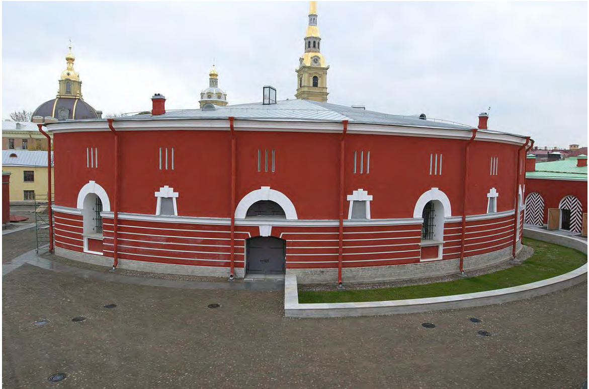
Илл.58. Фотография 2014 г. Общий вид на северную сторону кавальера Анны Иоанновны. КГИОП.
