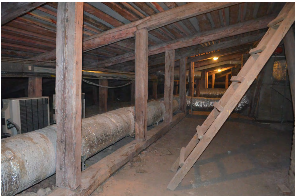
Фото 13. ОКН федерального значения «Кавальер Анны Иоанновны». Чердак. Стропильная система. Фрагмент. Съёмка 24.07.2023 г.
