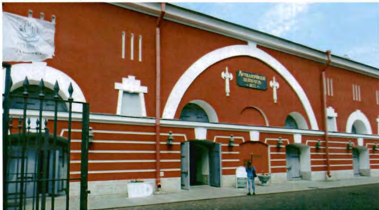
1. Вид на южный фасад.
