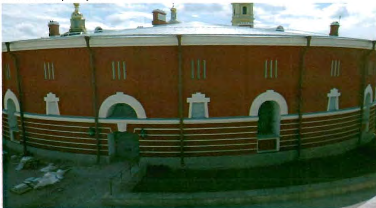
2. Вид на северный фасад.
