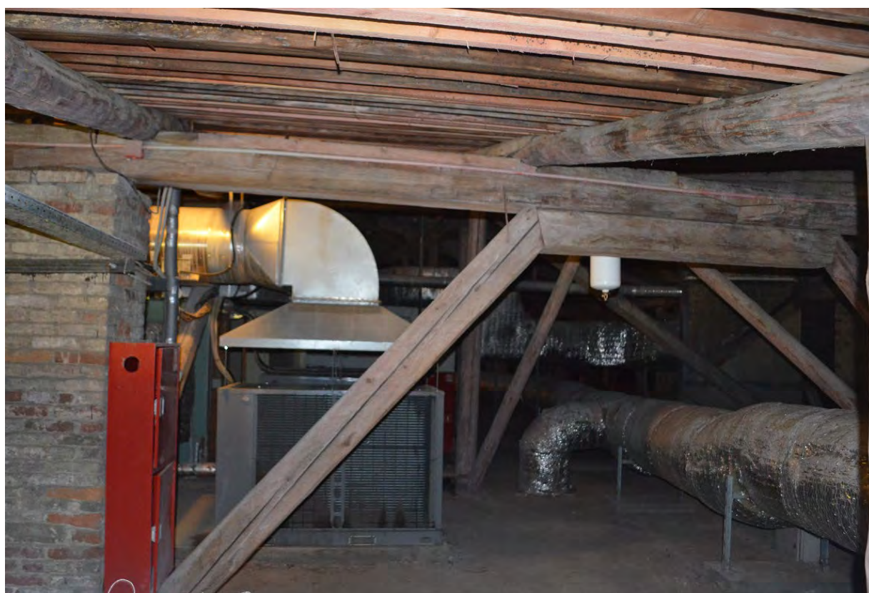
Фото 17. ОКН федерального значения «Кавальер Анны Иоанновны». Чердак. Стропильная система. Фрагмент. Съёмка 24.07.2023 г.
