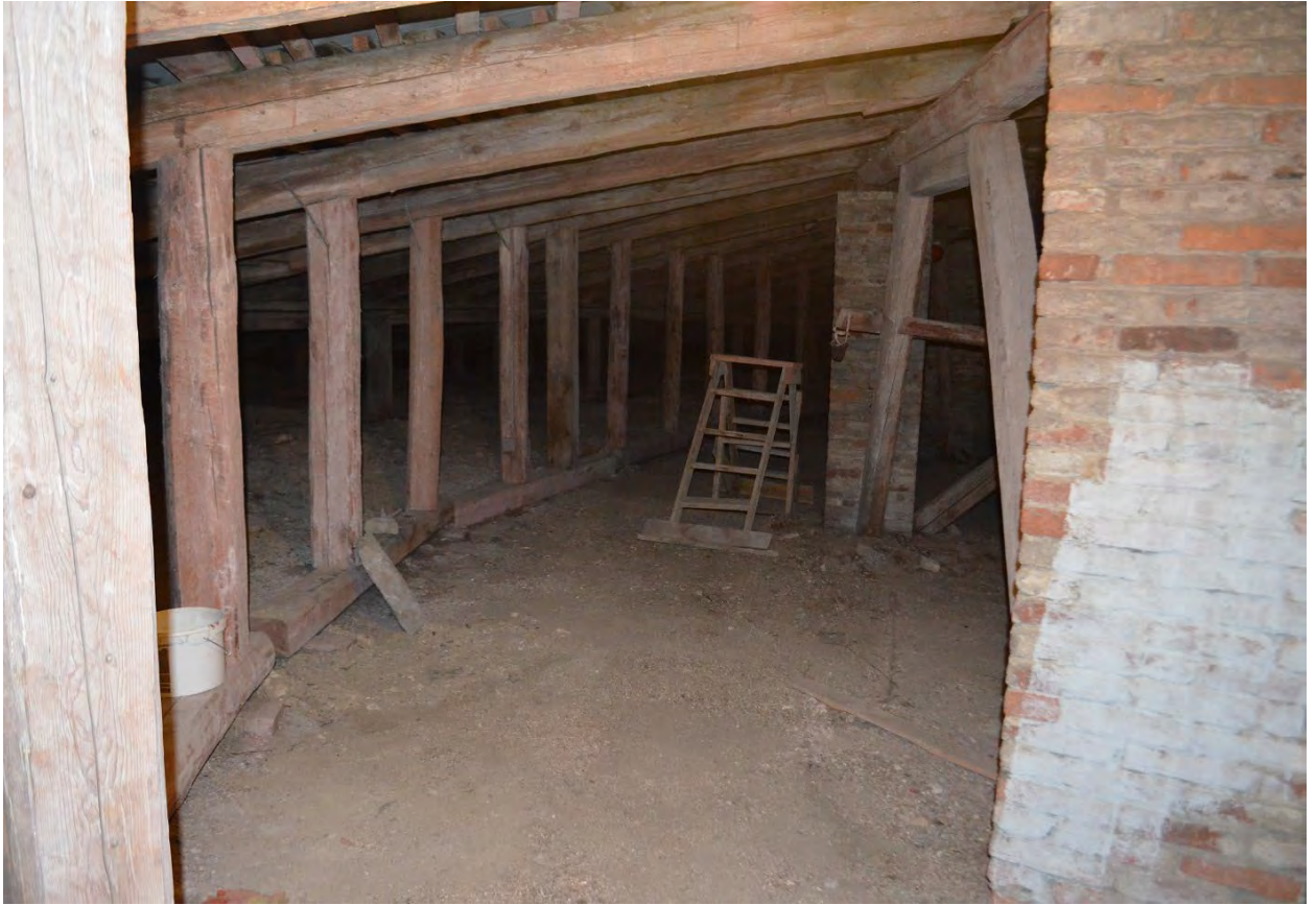
Фото 20. ОКН федерального значения «Кавальер Анны Иоанновны». Чердак. Стропильная система. Фрагмент. Съёмка 24.07.2023 г.
