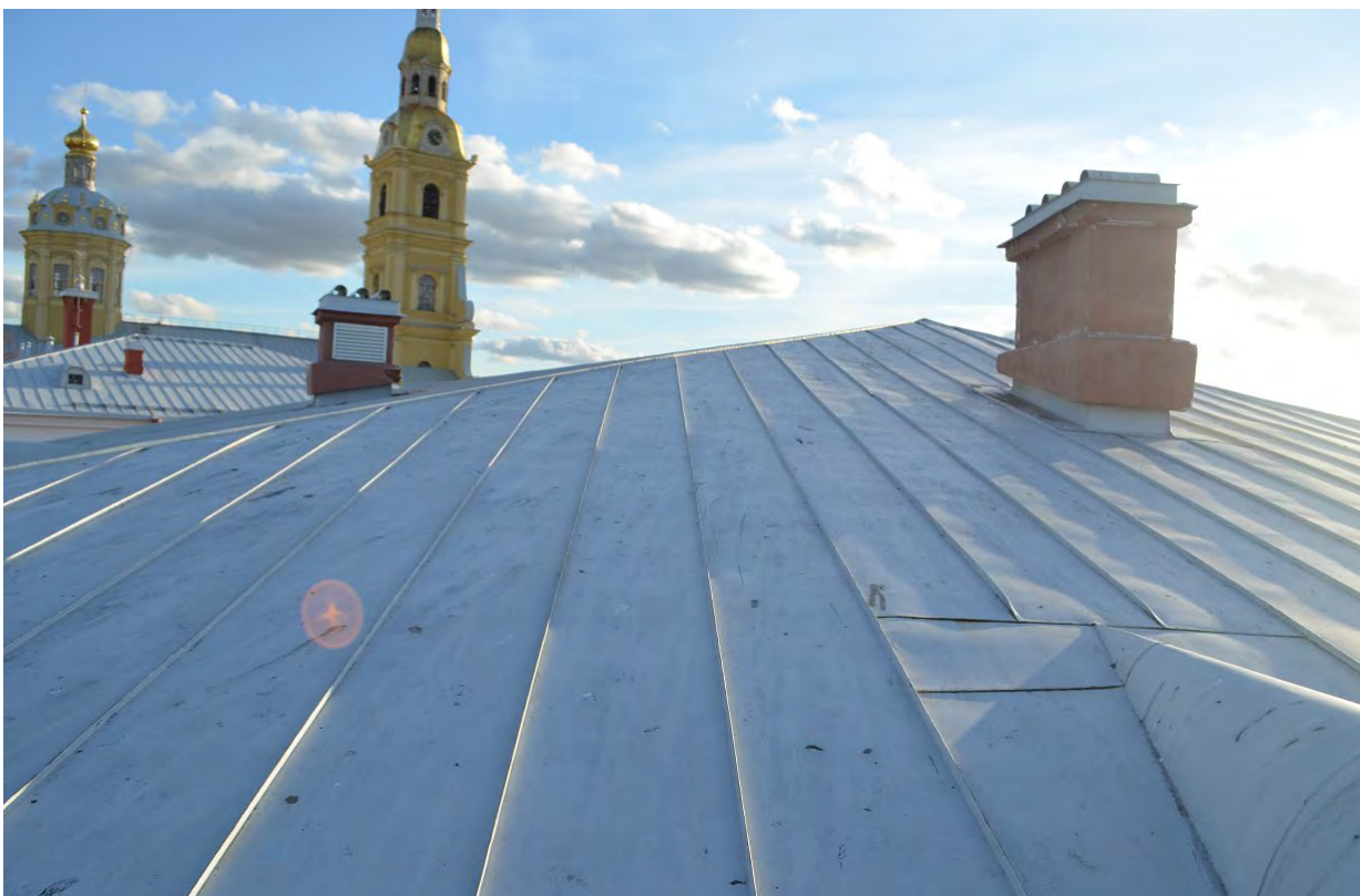
Фото 04. ОКН федерального значения «Кавальер Анны Иоанновны». Крыша. Фрагмент. Дымовые трубы. Съёмка 24.07.2023 г.
