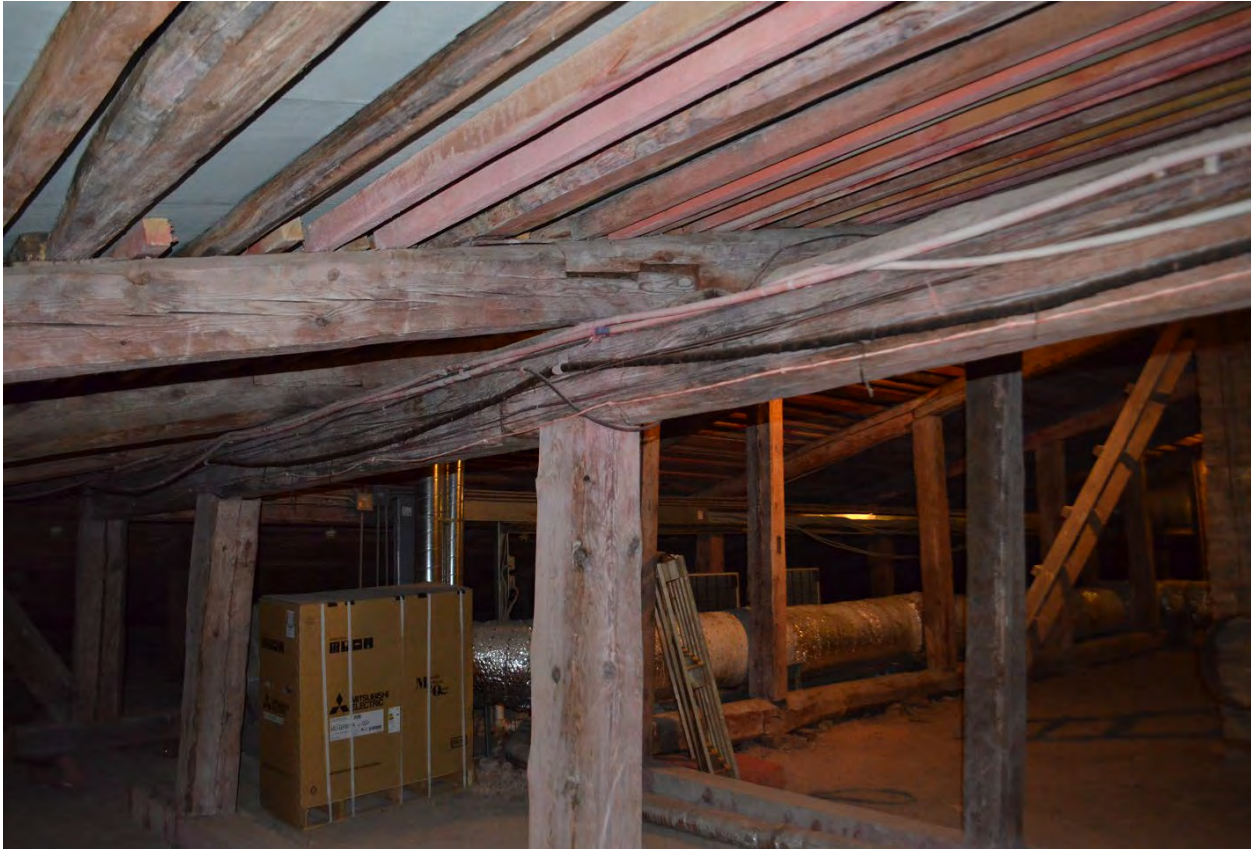
Фото 14. ОКН федерального значения «Кавальер Анны Иоанновны». Чердак. Стропильная система. Фрагмент. Съёмка 24.07.2023 г.
