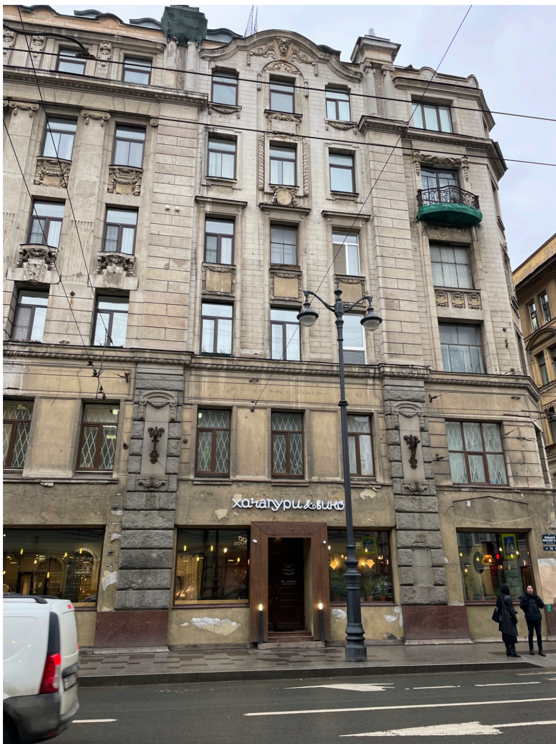
7. “Доходный дом А.А. Антоновой”. Санкт-Петербург, Большой пр., П.С., дом 74, лит.А. Лицевой фасад по Большому пр. Правая часть. Фото:26.01.2024.
