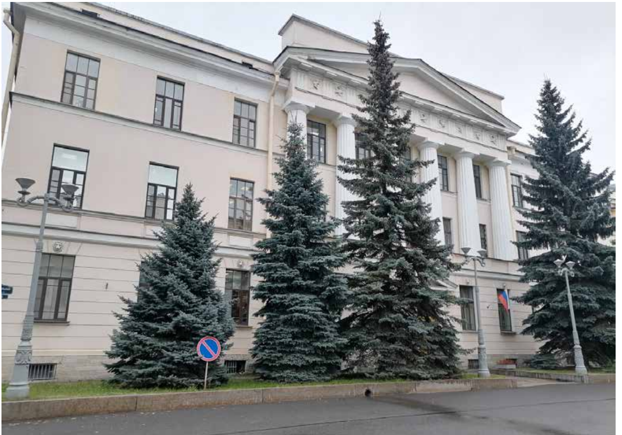
3. Главный фасад (южный). Вид с запада.
