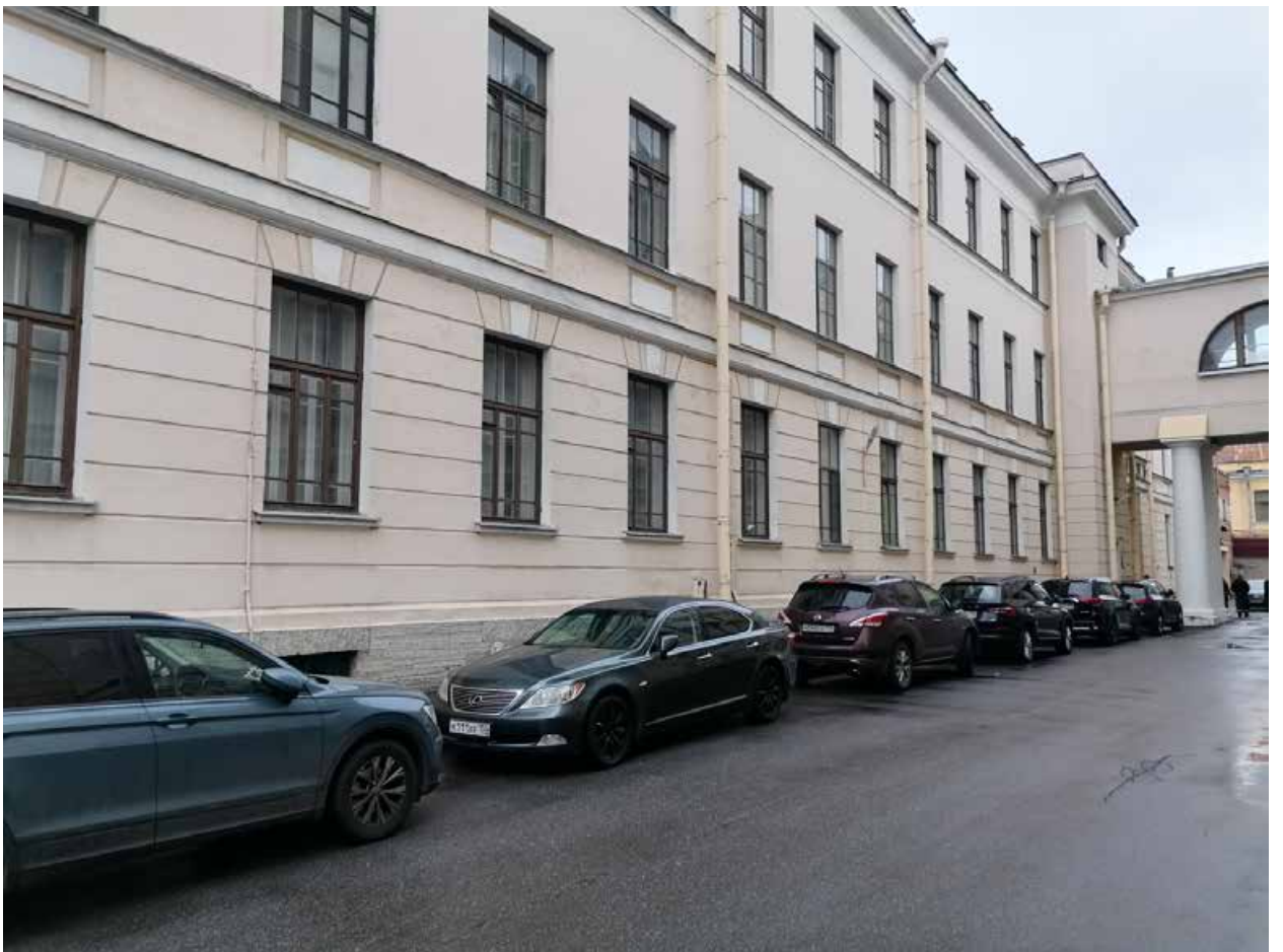
4. Боковой фасад (восточный).
