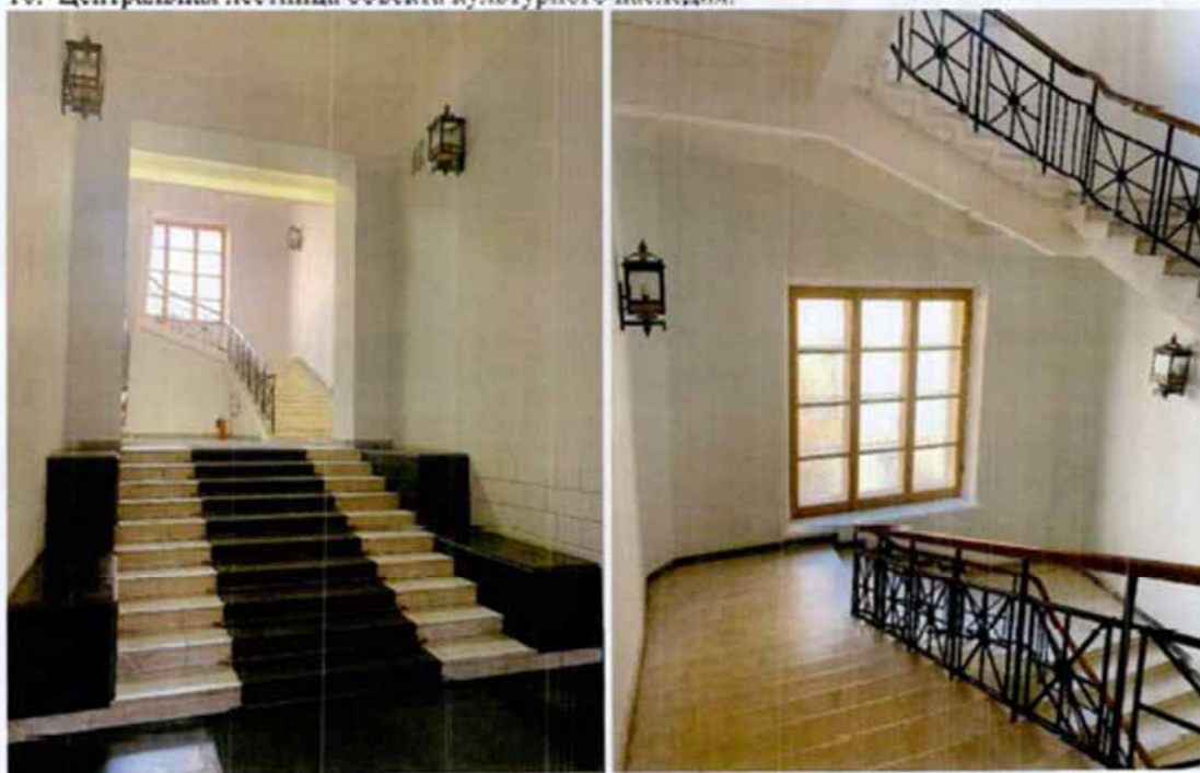
10. Центральная лестница объекта культурного наследия.
