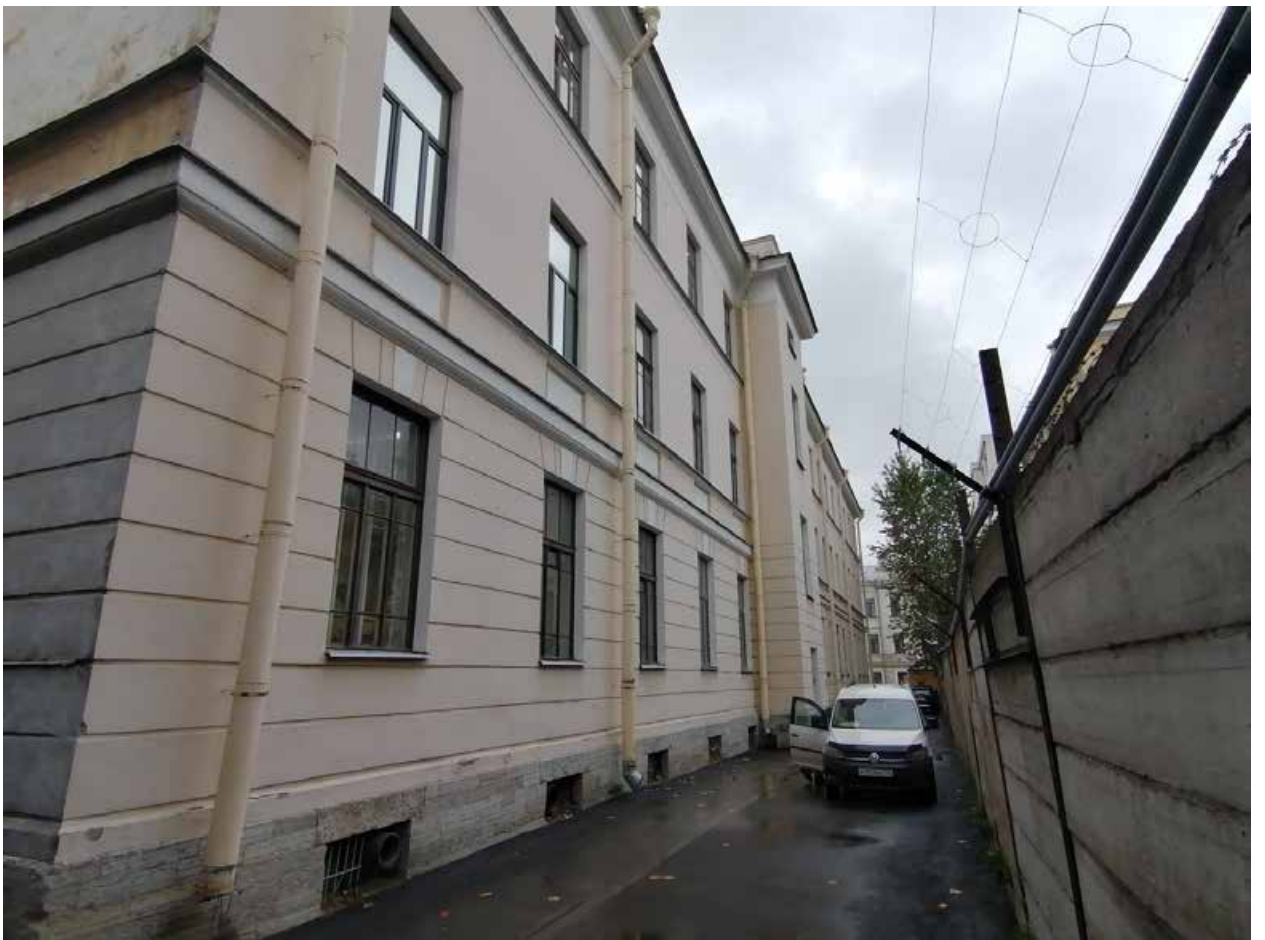
6. Боковой фасад (западный). Вид с севера.
