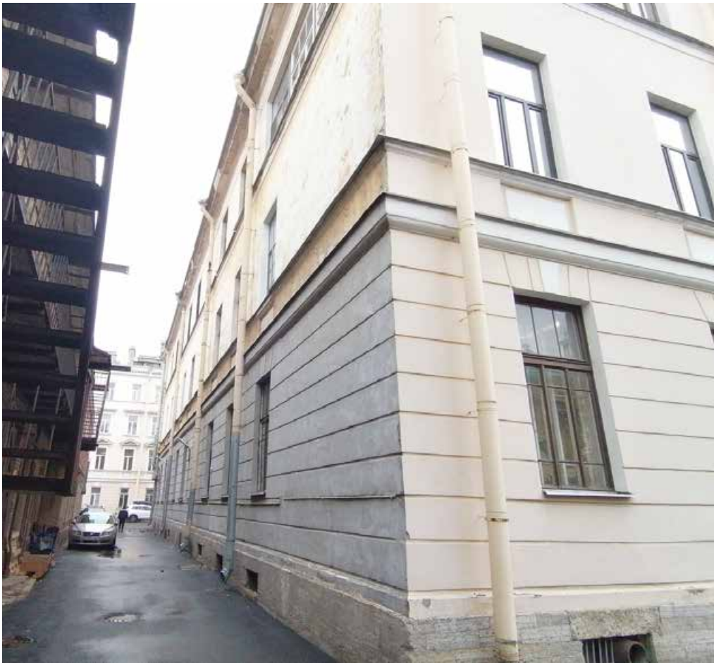
7. Северный фасад. Направление съемки – 3-В.
