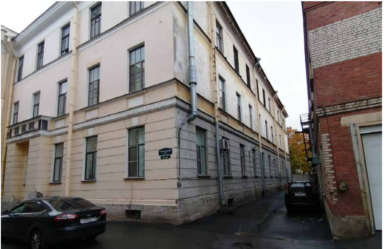
5. Фрагмент восточного и северного фасада.
