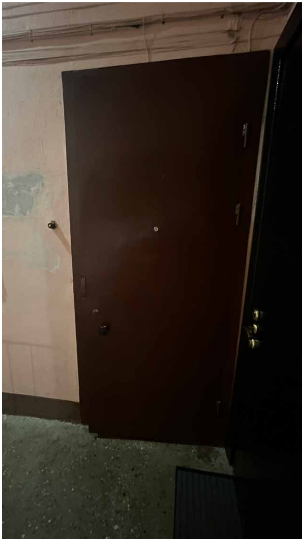
2. Вид на входную дверь в квартиру;
