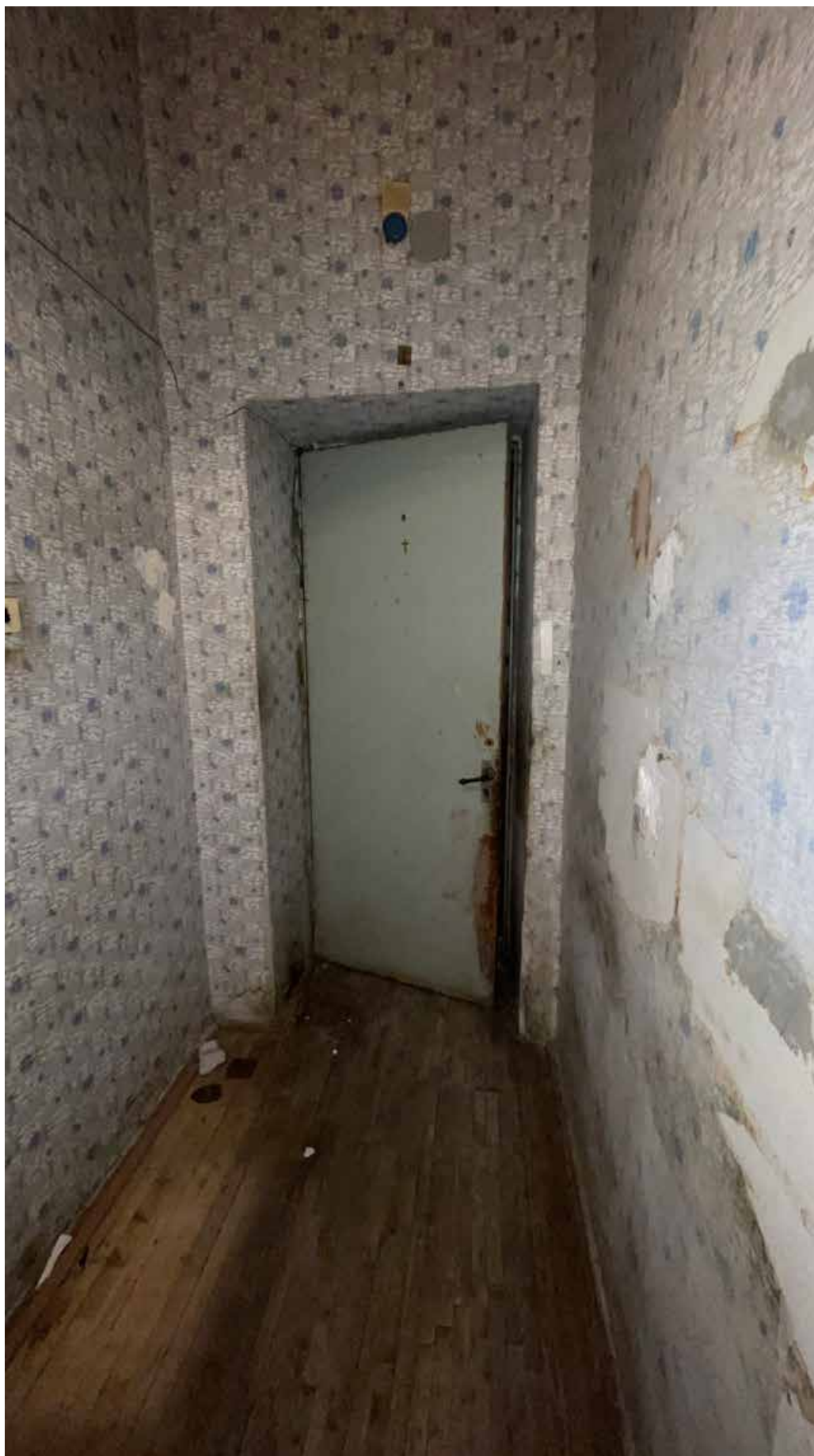
3. Вид на входную дверь в квартире;
