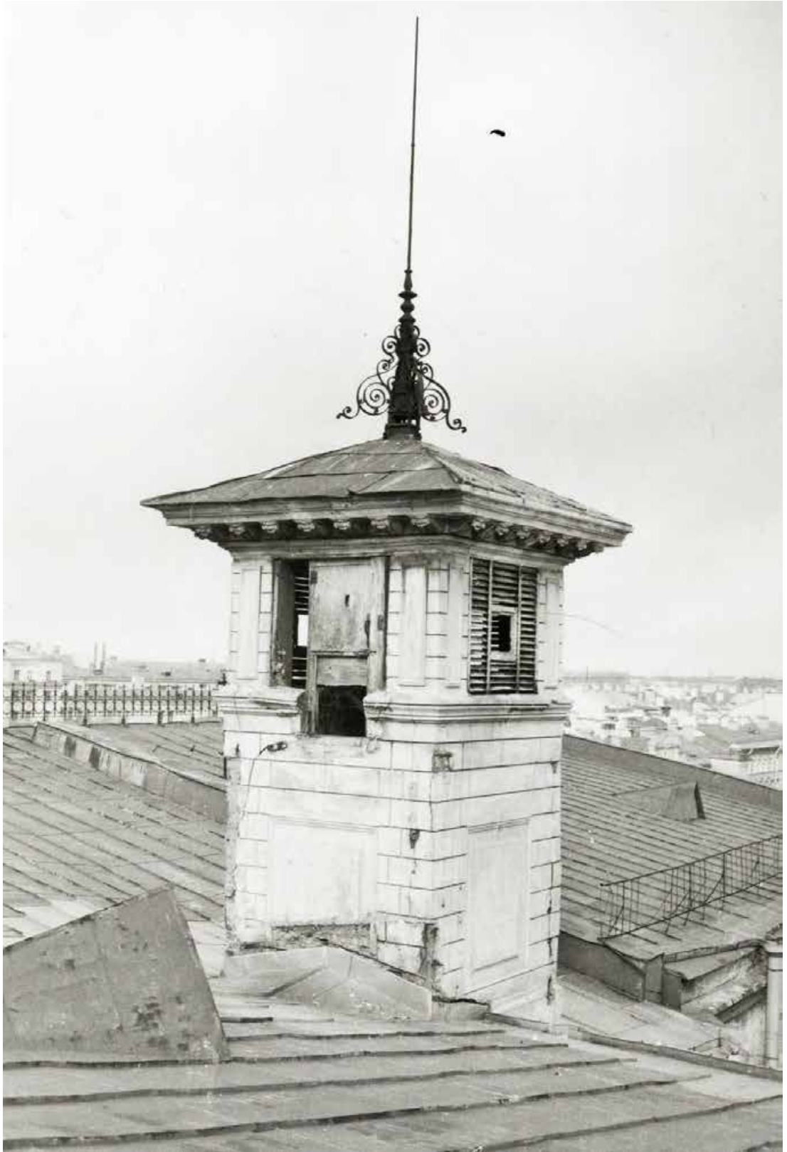
Ил. 201. Ленинградская государственная консерватория ордена Ленина имени Н.А. Римского-Корсакова (Театральная пл., 3). Вентиляционная башня на крыше здания. 1981 г. Автор съемки неизвестен. ЦГА КФФД. Ар 209155.
