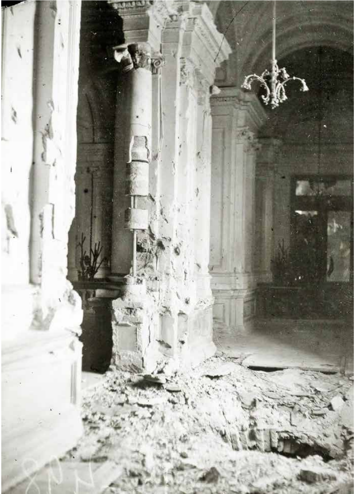
Ил. 179. Стена и часть пола первого этажа Ленинградской государственной консерватории имени Н.А. Римского-Корсакова (Театральная пл., 3), разрушенные в результате взрыва снаряда. 1943 г.
