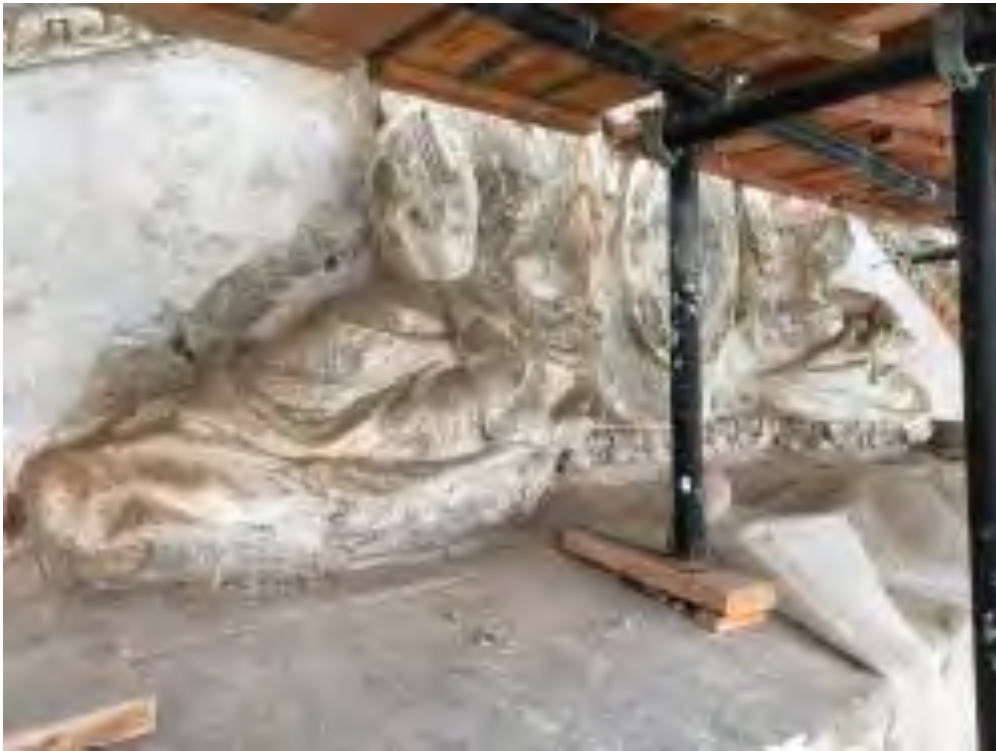
269. Фрагмент тимпана фронтона южного фасада. Фото 2019 г.
