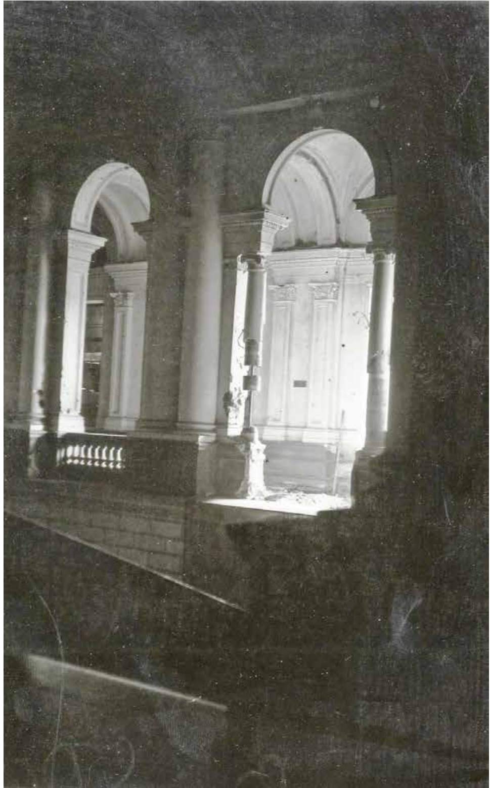
Ил. 181. Разрушения в здании Ленинградской государственной консерватории имени Н.А. Римского-Корсакова (Театральная пл., 3), произведенные на центральной лестнице в результате взрыва тяжелого снаряда. 1943 г. Автор съемки неизвестен. ЦГА КФФД. Вр 500. ЦГА СПб. Ф.8557. Оп.9. Д.8. Л.18.
