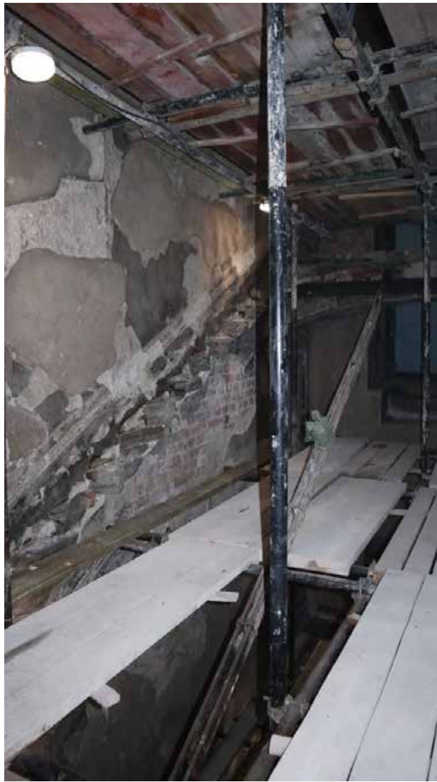
Фото 6. Вид на пролет между 3 и 4 этажами.
