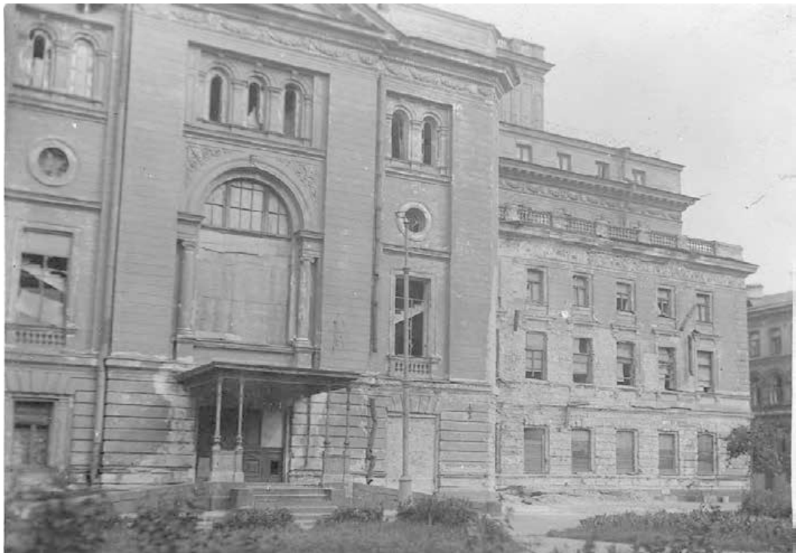
Ил. 187. Часть главного фасада здания Ленинградской государственной консерватории имени Н.А. Римского-Корсакова (Театральная пл., 3), поврежденного артиллерийским обстрелом.
