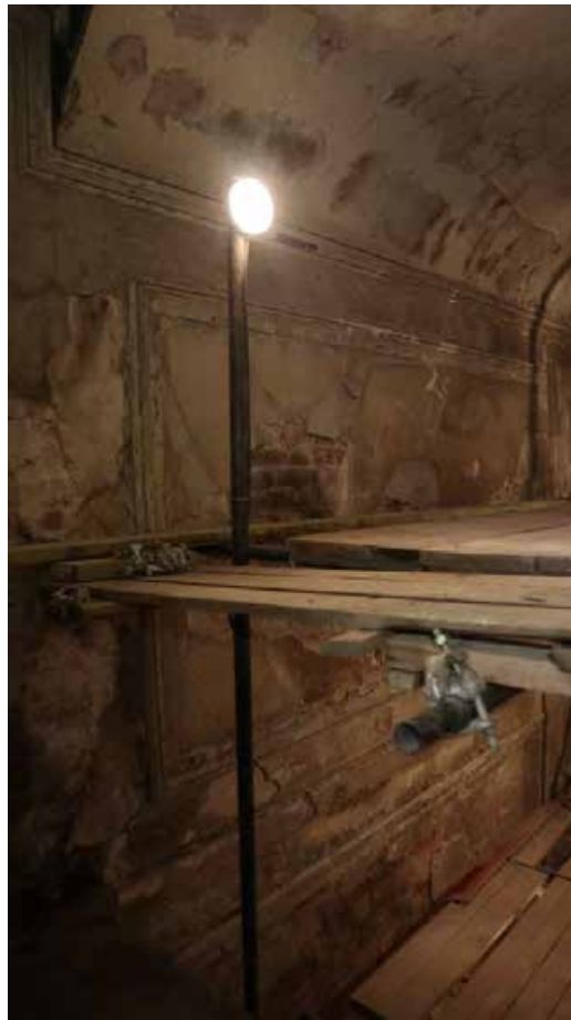
Фото 10. Лестничная клетка в уровне 5 этажа.
