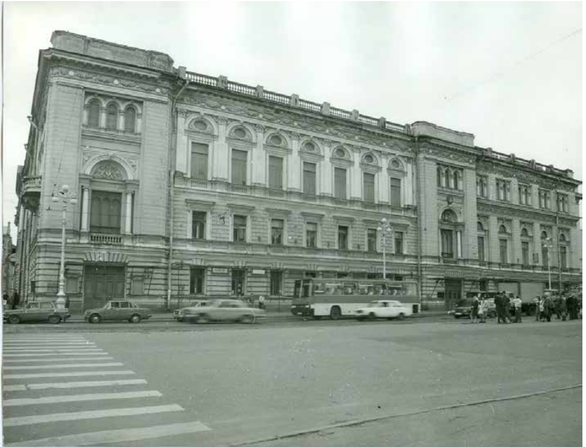
Ил. 206. Фасад по улице Глинки здания Ленинградской государственной консерватории имени Н.А. Римского-Корсакова (Театральная пл., 3). Дата съемки: 1991 г. Автор съемки: С.А. Шмидт. КГИОП. 437/5.
