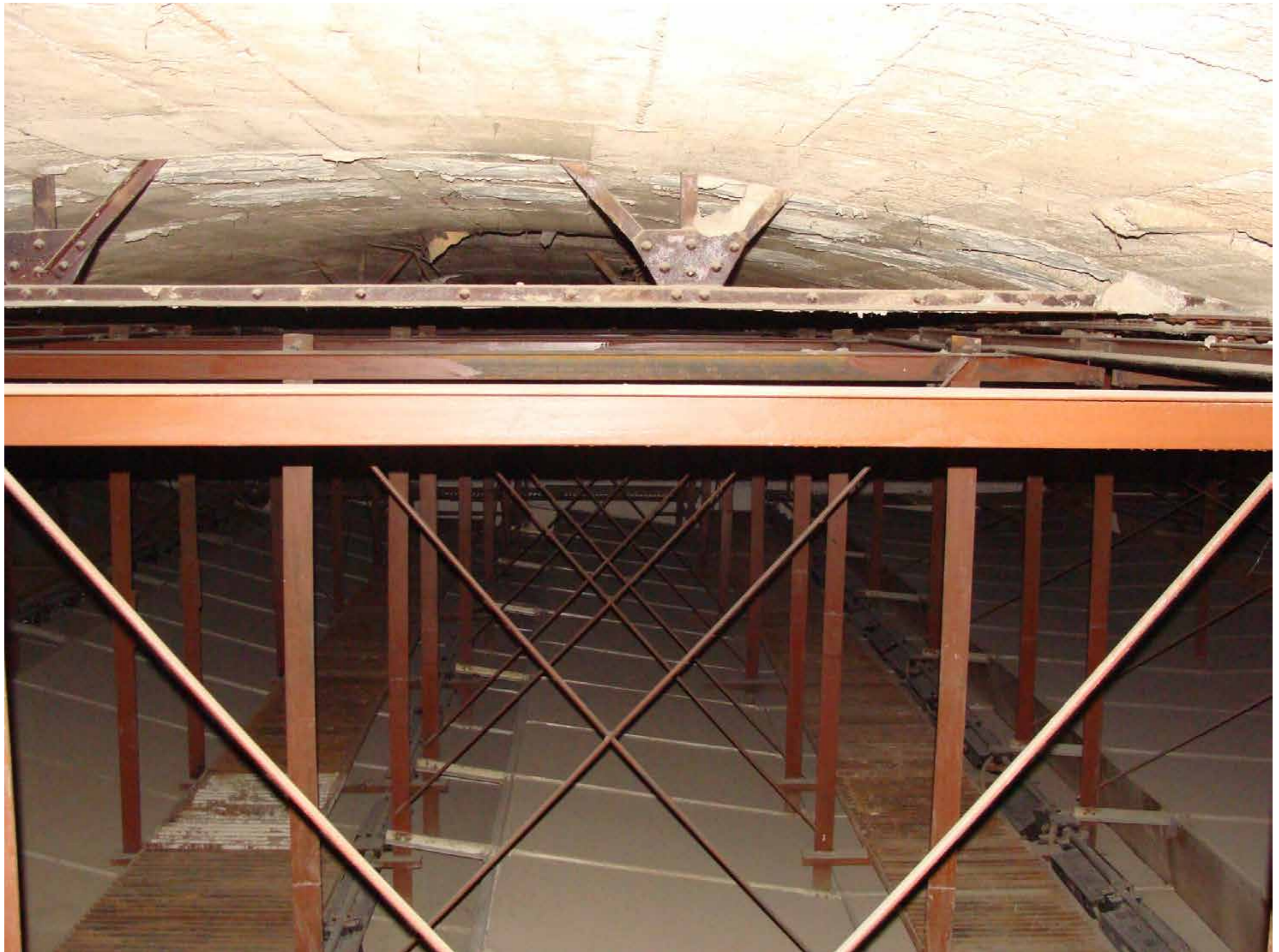
Ил. 229. Здание С.-Петербургской Консерватории им. Н. А. Римского-Корсакова. Железобетонное перекрытие зала с фрагментами исторических (1912 г. ?) металлических ферм сверху, акустический плафон из щитов внизу (1960-е гг.). Фото 2012 года.
