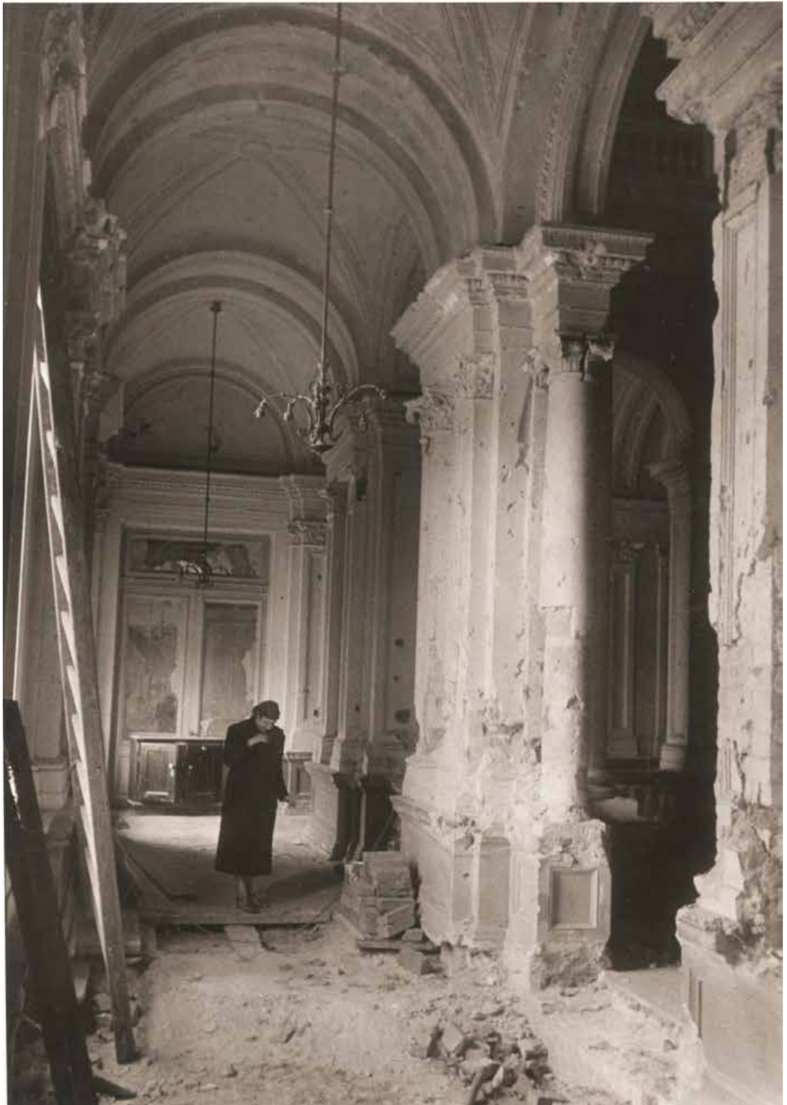
Ил. 180. Ленинградская государственная консерватория Разрушения в интерьере. 1940-е г. /до 1945 г./ Автор съемки неизвестен. Архив КГИОП. 15405/1.
