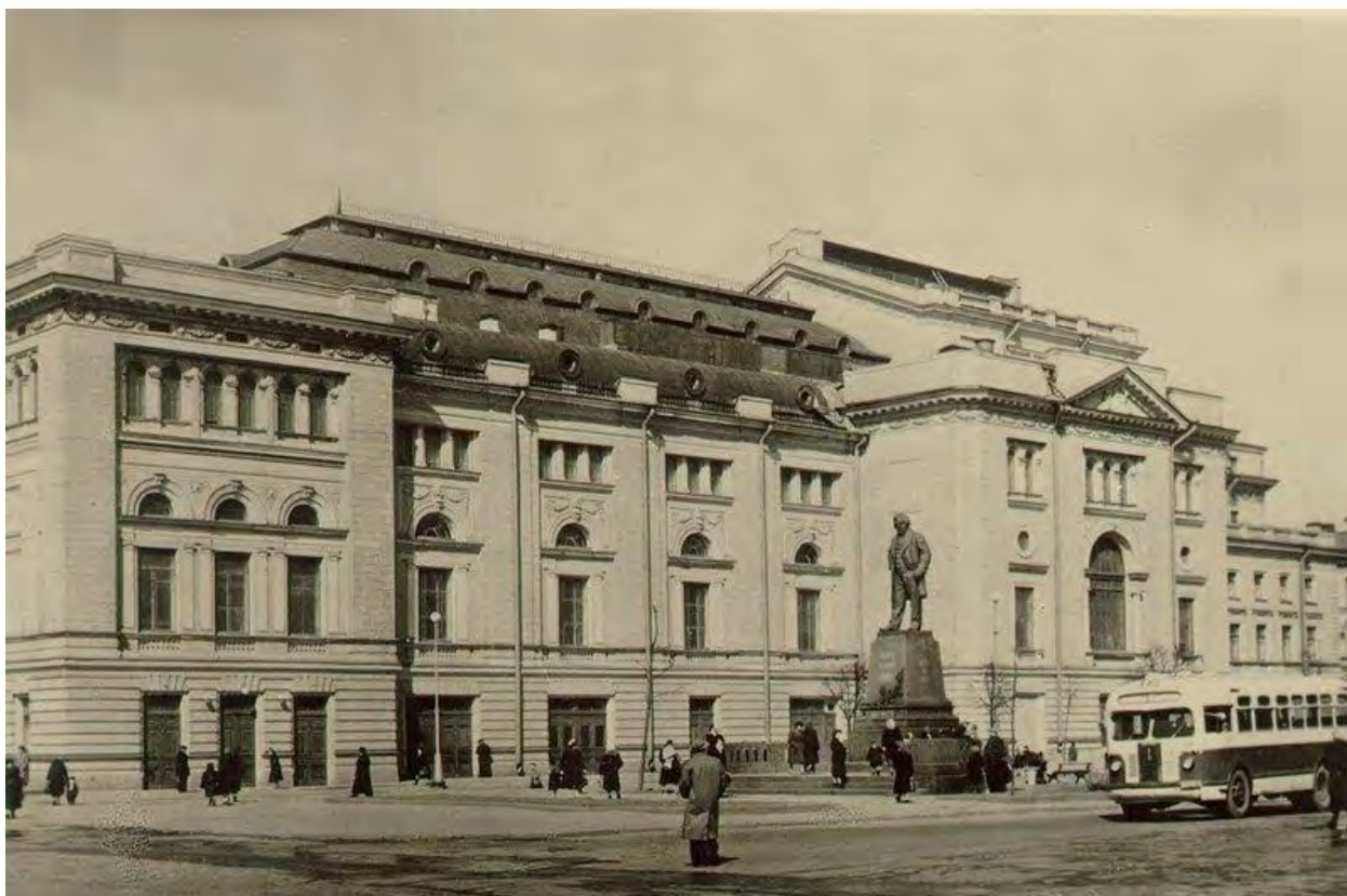
264. Фото 1953 г. Здание Консерватории. Южный фасад.
