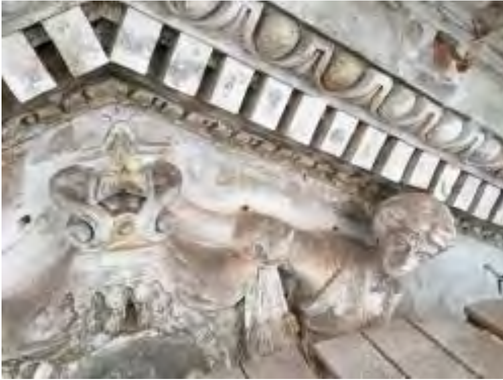
268. Фрагмент тимпана фронтона южного фасада. Фото 2019 г.
