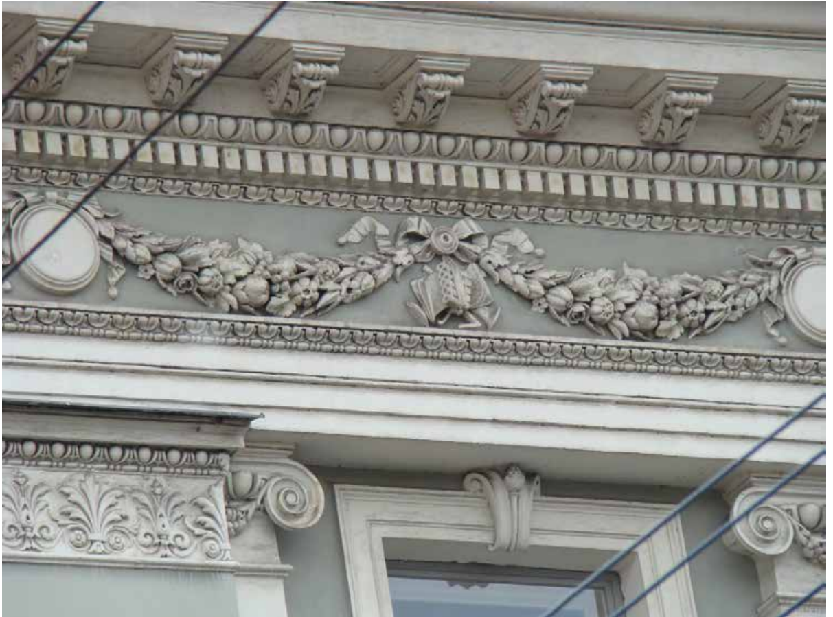
Ил. 213. Здание С.-Петербургской Консерватории им. Н. А. Римского-Корсакова. Фрагмент верхней части восточного ризалита северного фасада. Капитель пилястры, верхняя часть наличника окна четвертого этажа и антаблемент. Фото 2012 года.
