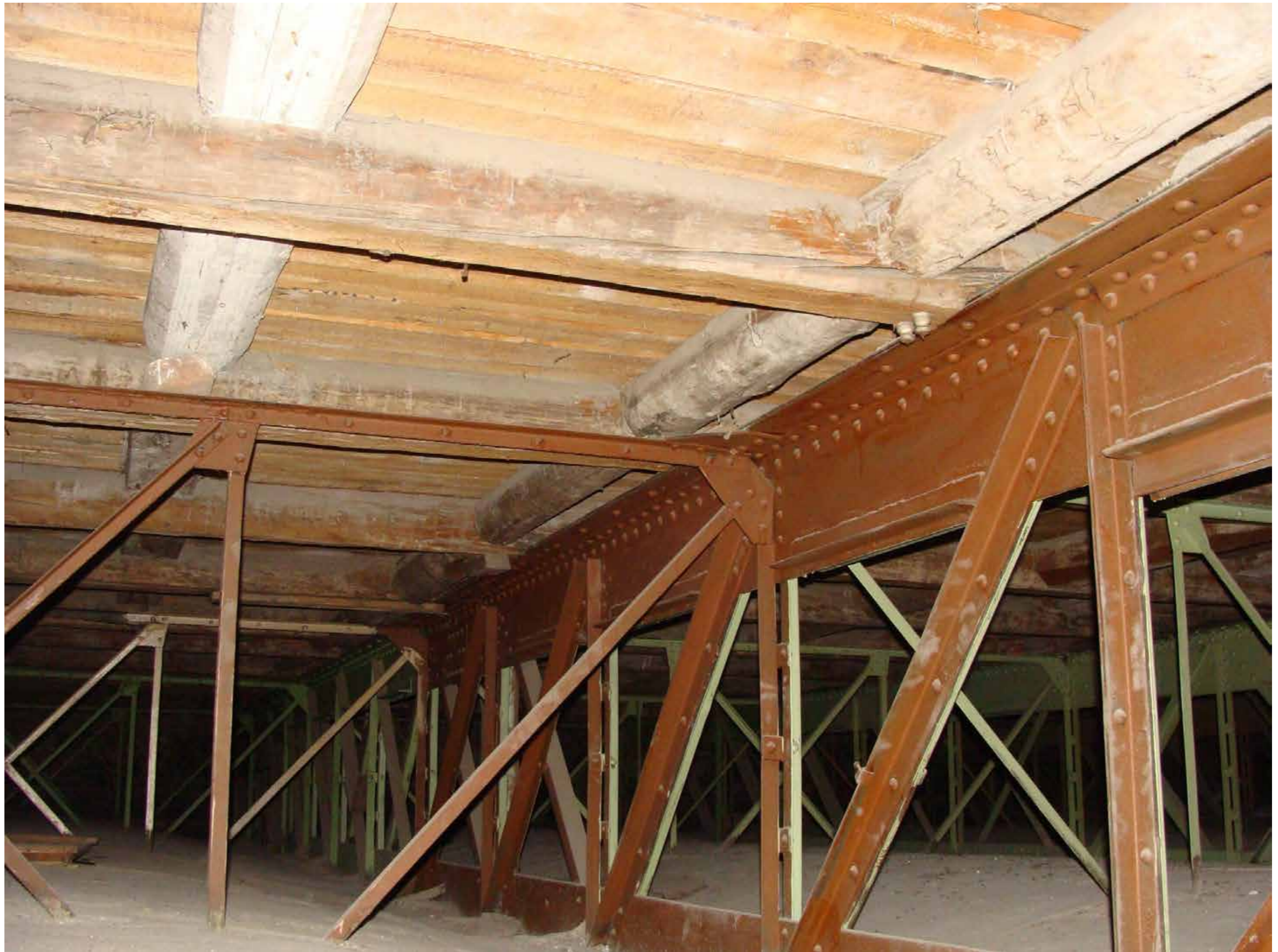
Ил. 228. Здание С.-Петербургской Консерватории им. Н. А. Римского-Корсакова. Железобетонное перекрытие внизу, исторические металлические фермы (1912 г. ?), деревянное перекрытие декорационного залаверху. Фото 2012 года.
