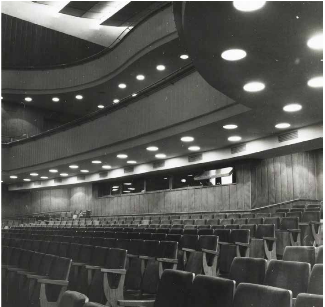
Ил. 203. Ленинградская государственная консерватория ордена Ленина имени Н.А. Римского-Корсакова (Театральная пл., 3). Вид части Большого зала им. А.Г. Рубинштейна. Дата съемки: 1981 г. Автор съемки неизвестен. ЦГА КФФД. Бр 68943.
