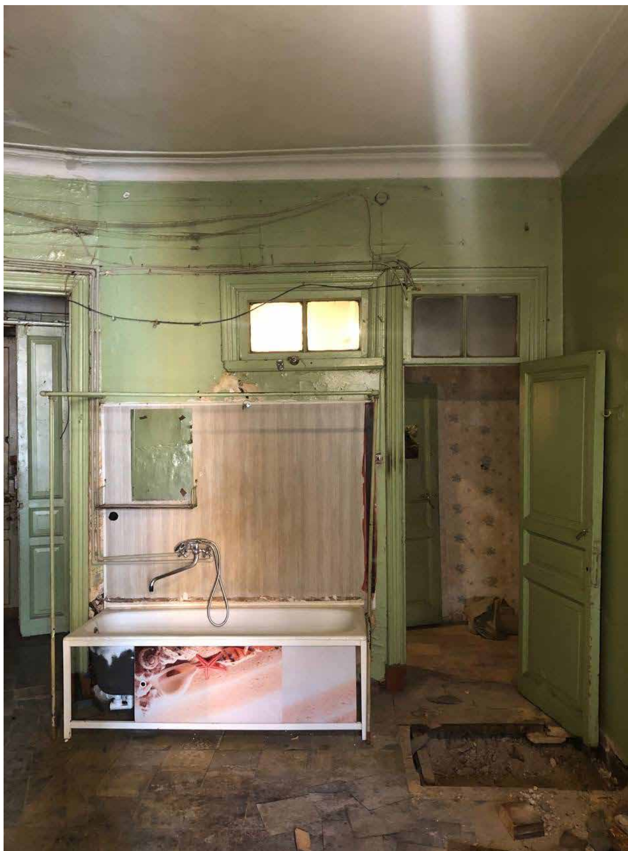
3. Фрагмент интерьера кухни (помещение 10/18.9);
