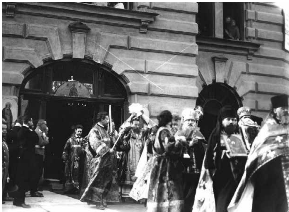
Илл. 62. Закладка Николо-Александровского («Барградского») храма на перекрестке пр. Бакунина и 2-й Советской ул. Фрагмент восточного фасада дома И. В. Галунова. 1913 г. ЦГАКФФД СПб. Гр 23043
