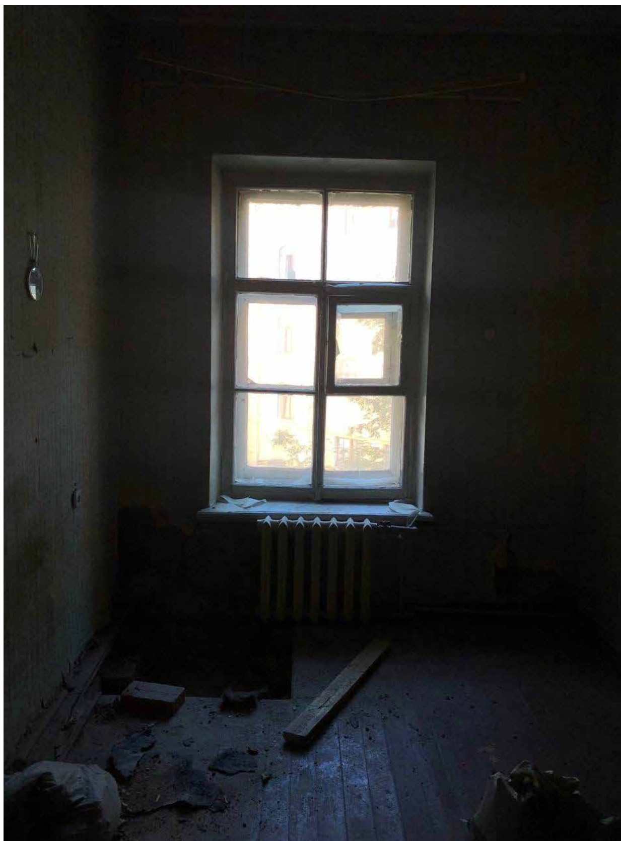
6. Фрагмент интерьера комнаты (помещение 9/17.1);
