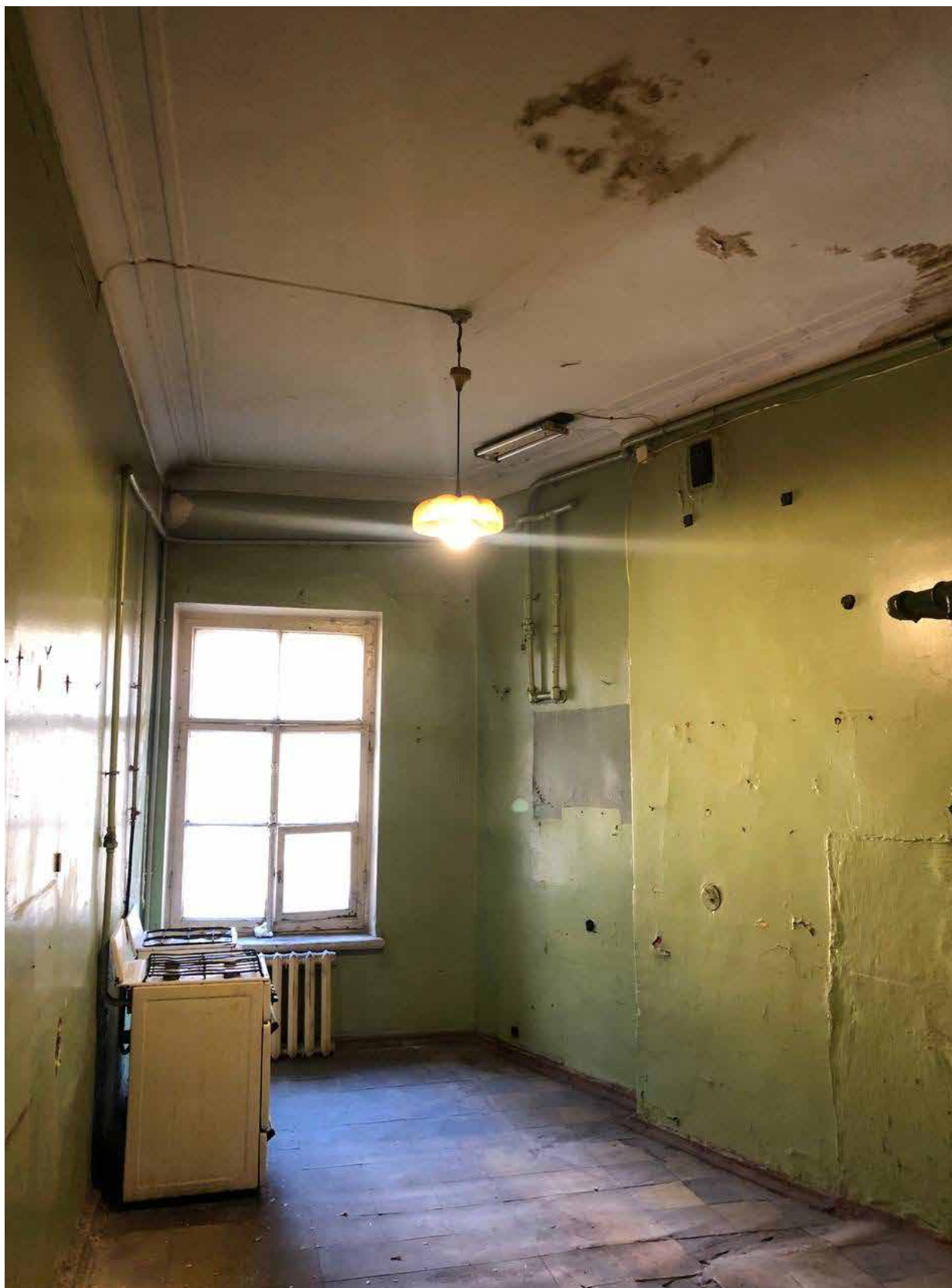
4. Фрагмент интеръера кухни (помещение 10/18.9);
