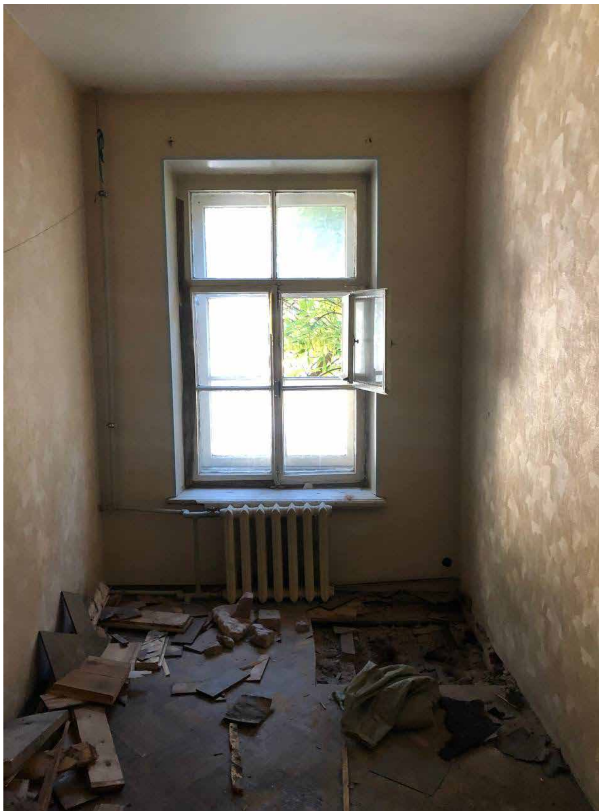
9. Фрагмент интерьера комнаты (помещение 7/28.1);
