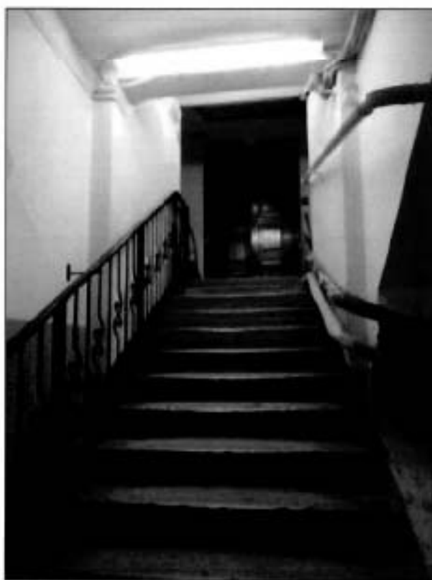
22. Лестница в уровне подвала.
