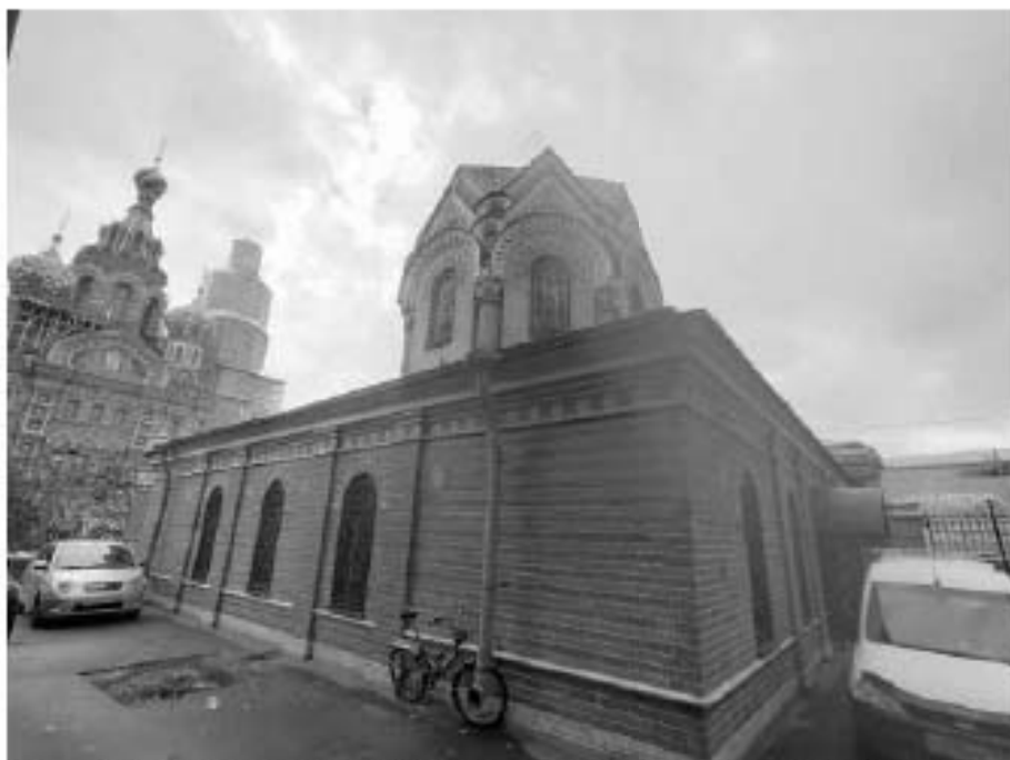
5. «Часовня с ризницей», Грибоедова наб., 2-а. Восточный фасад. Общий вид. Фото 13.10.2023г.
