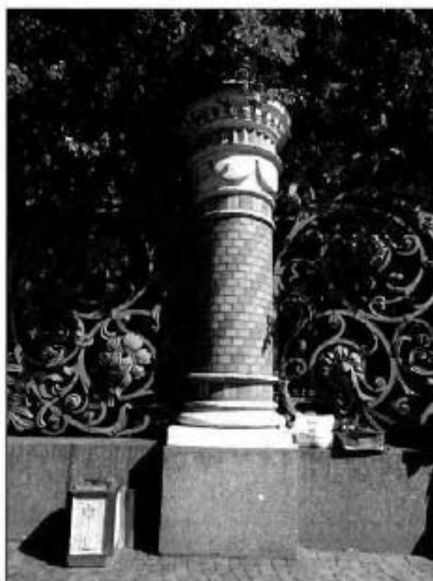
3. «Ограда». Фрагмент решетки.
