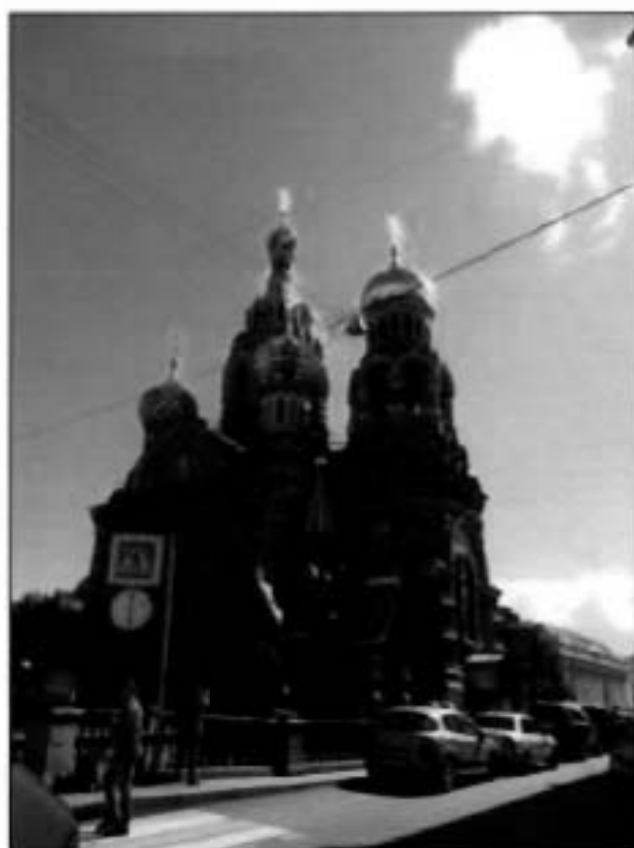
9. «Собор». Общий вид с северо-запада.
