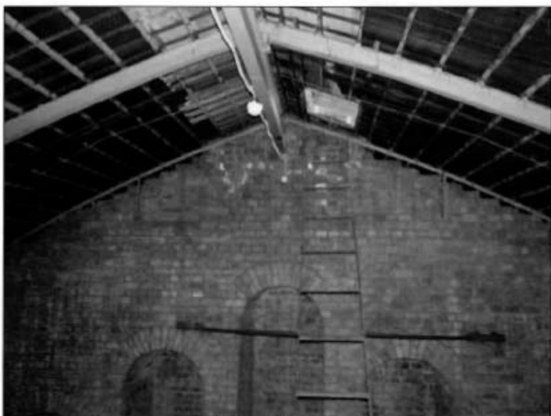
18. Чердак. Общий вид.
