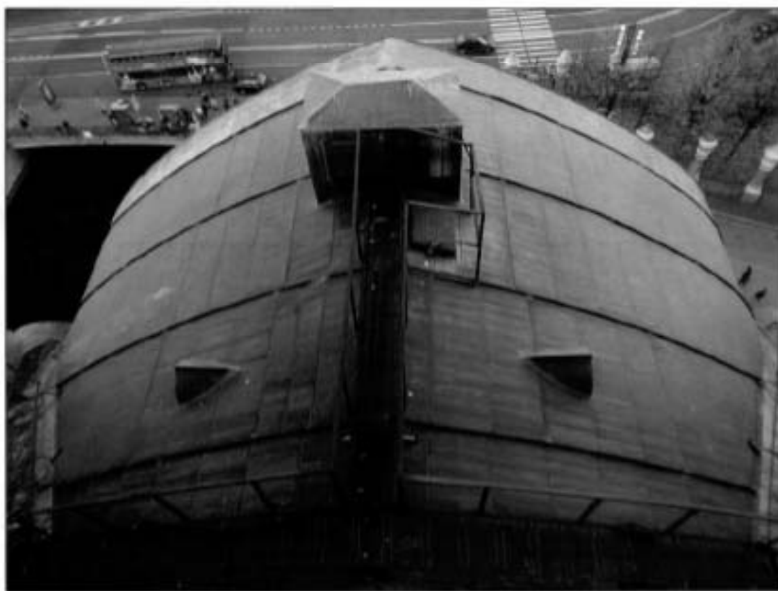
16. «Собор». Кровельное покрытие. Фрагмент.
