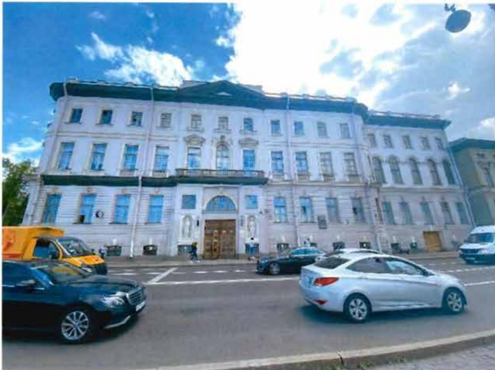
2. Северный лицевой фасад объекта культурного наследия.
