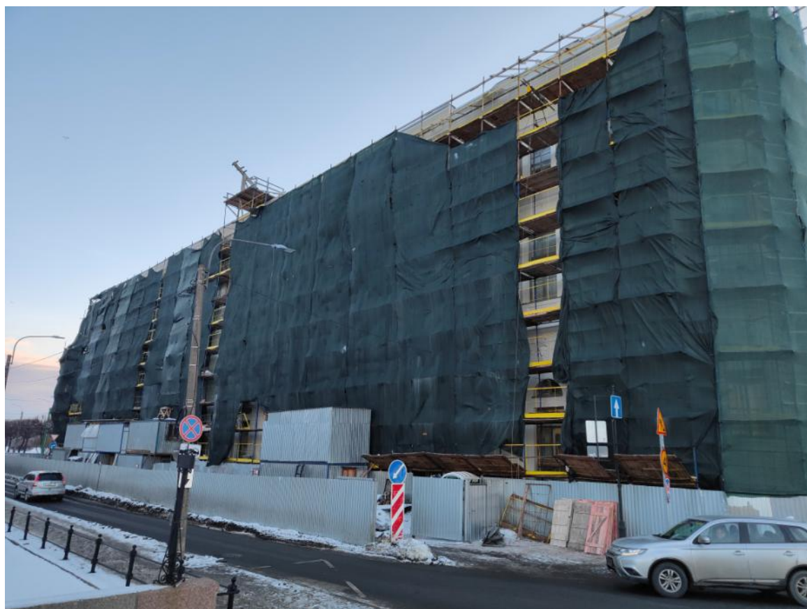
Фото 2 Лицевой фасад объекта культурного наследия федерального значения «Дом Бецкого И.И. (принца Ольденбургского П.Г.)» (По набережной Лебяжьей канавки)
