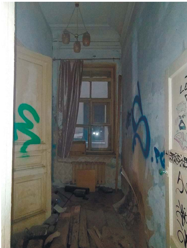
Фото 23. Окно с видом в световой колодец. Фрагмент двери между смежными комнатами (пом. 3 и 4).
