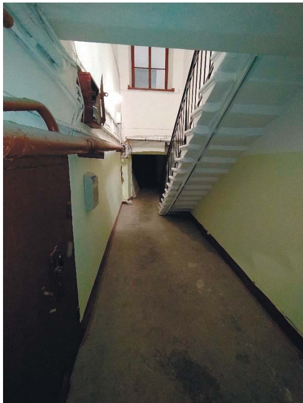
Фото 15. Лестничная клетка ЛК5 в уровне цокольного этажа. Вид с северо-запада.
