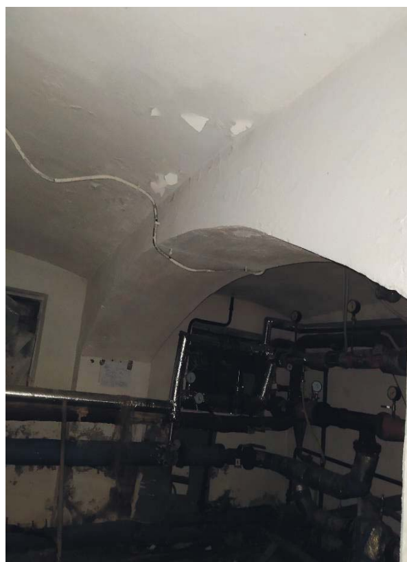
Фото 14. Перекрытие над цокольным этажом здания в пределах теплоцентра под кв. № 41 (большой отсек справа от входа в теплоцентр). Вид большую на подпружную арку.
