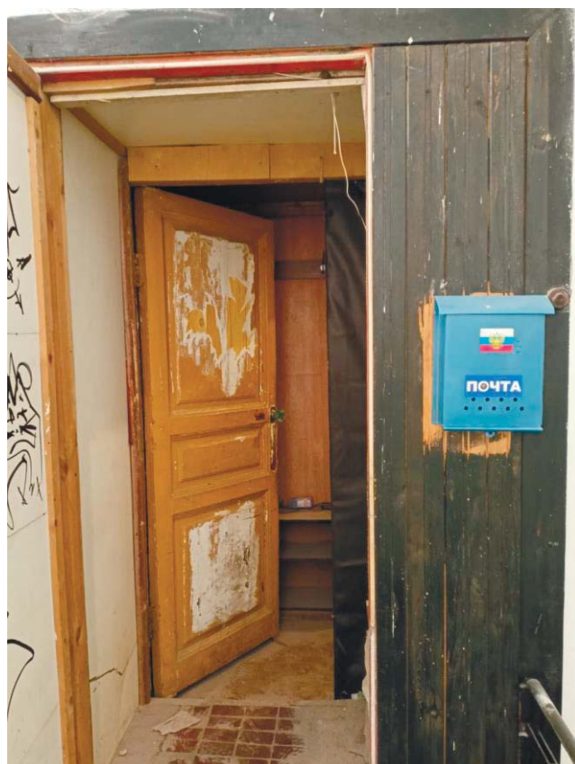
Фото 20. Вход в квартиру № 41. Вид со стороны лестничной площадки
