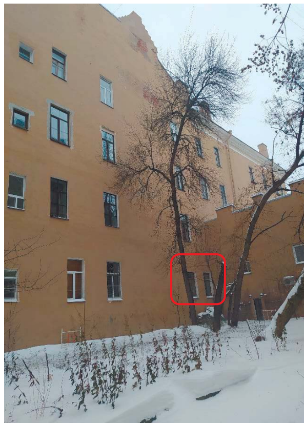
Фото 7. Фрагмент северо-восточного фасада здания. Вид со стороны внутреннего двора дома № 13 по Большому проспекту Васильевского острова. Вид на окна кв. № 41
