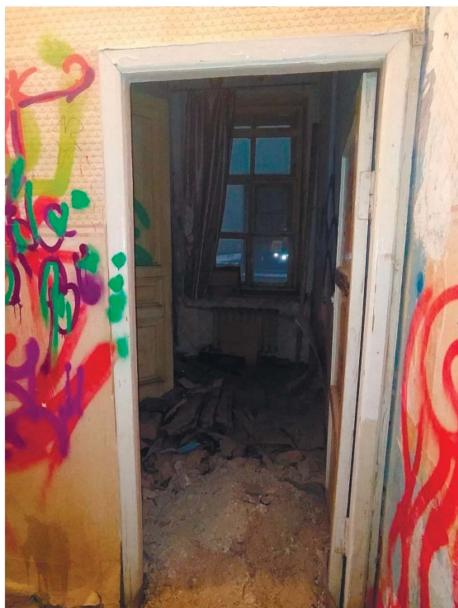
Фото 22. Вход в комнату (пом. 3).
