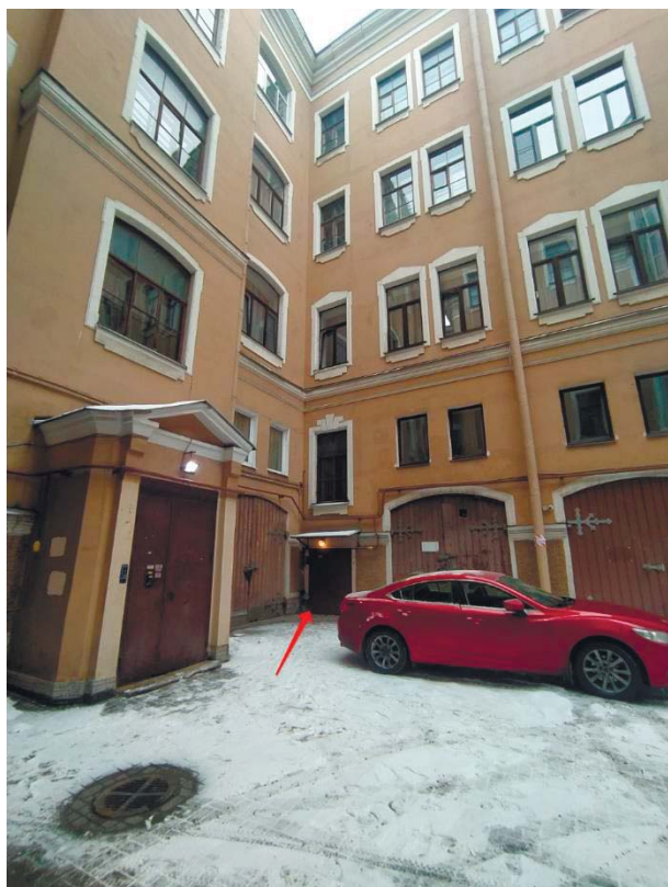
Фото 5. Северный двор. Северо-западный дворовой фасад. Вход в парадную.
