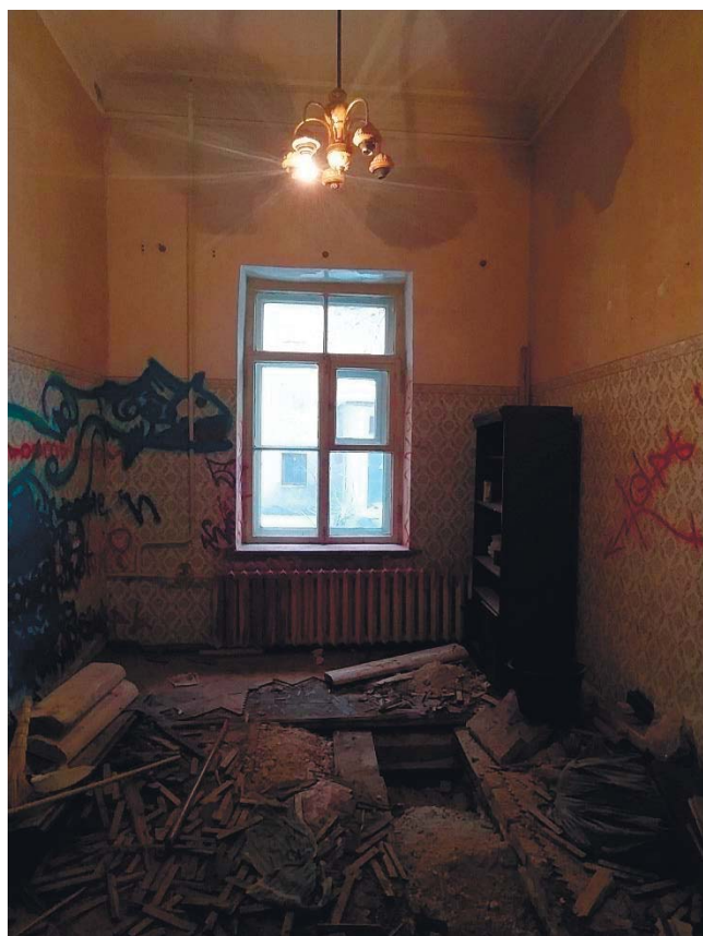
Фото 26. Вид на окно комнаты (пом. 4).
