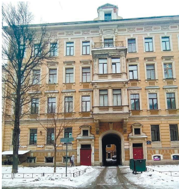
Фото 2. Фрагмент юго-западного лицевого фасада по 4-й линии В.О.
