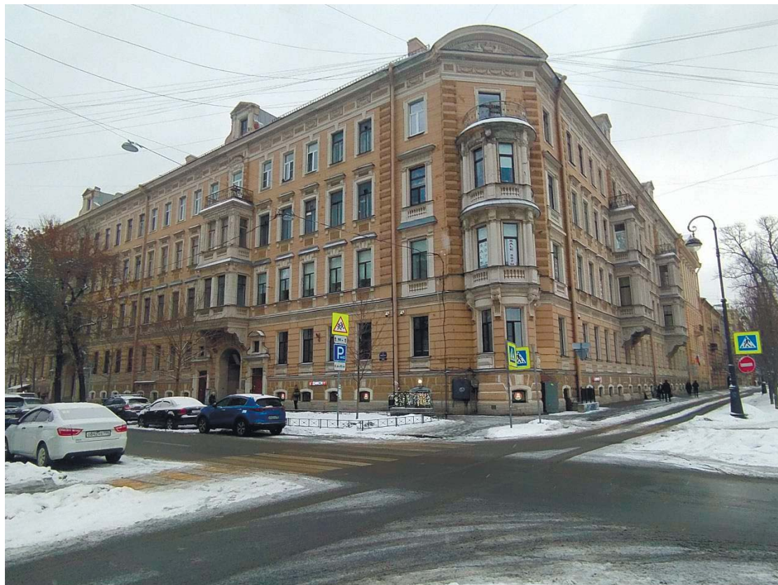
Фото 1. Общий вид здания («Дом Л.Е. Кенига»). Вид от угла на пересечении 5-й линии и Большого проспекта Васильевского острова.
