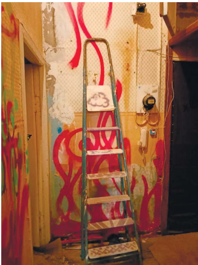
Фото 31. Коридор квартиры (пом. 1) Вид со стороны кухни (пом. 5.).
