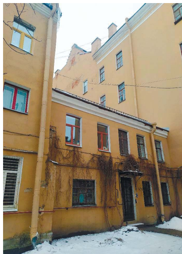
Фото 9. Фрагмент северо-восточного фасада здания. Вид со стороны общего внутреннего двора восточного флигеля дома № 5 по 4-й линии и дома № 8 по 3-ей линии Васильевского острова.
