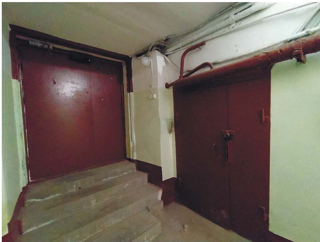
Фото 12. Лестничная клетка ЛК5 в уровне цокольного этажа. Вид с юго-востока. Выход из парадной (слева). Вход в техническое помещение - теплоцентр (справа).
