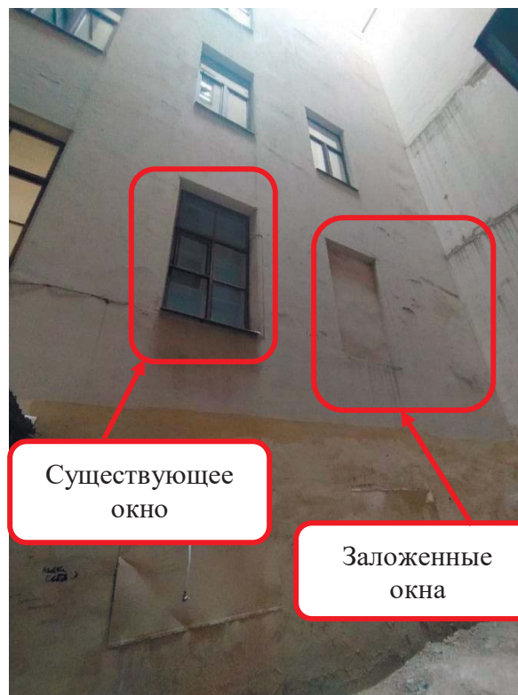
Фото 11. Северо-западный фасад светового колодца. Существующее окно в комнате № 3 квартиры № 41 согласно техпаспорту на квартиру от 25.01.2018 г. На архивном плане квартиры от 1947 года окно на месте заложенного проёма отсутствует.
