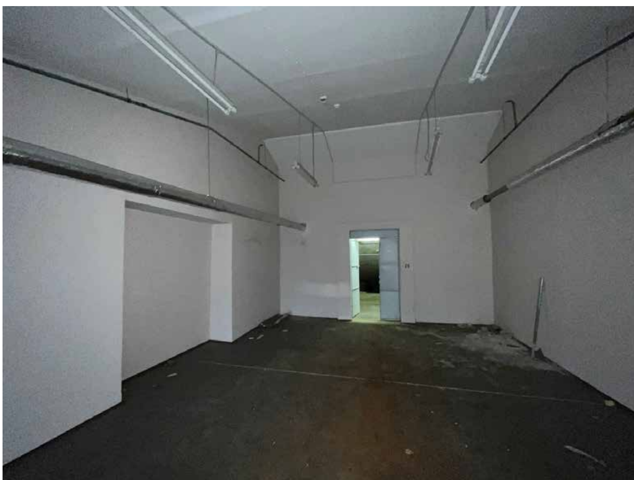
Фото №47. Помещение третьего этажа (мансарда).
