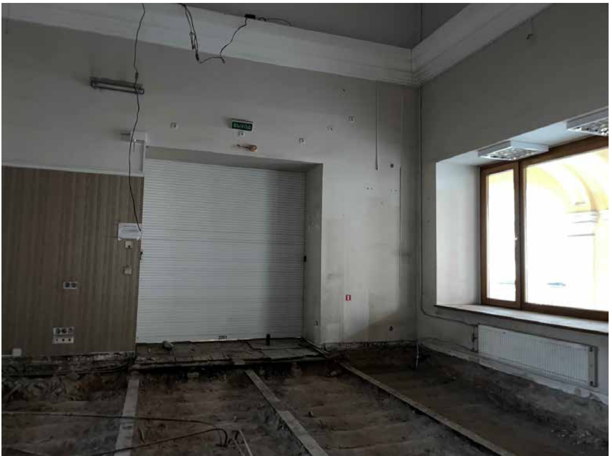
Фото №17. Второй этаж. Выход в вестибюль.
