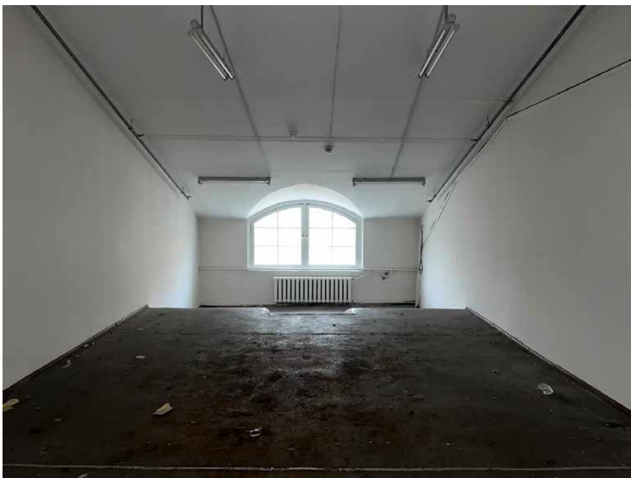
Фото №44. Помещение третьего этажа (мансарда).
