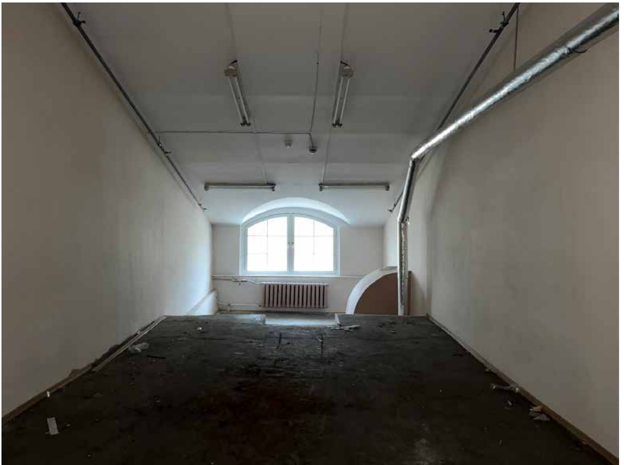
Фото №38. Помещение третьего этажа (мансарда).
