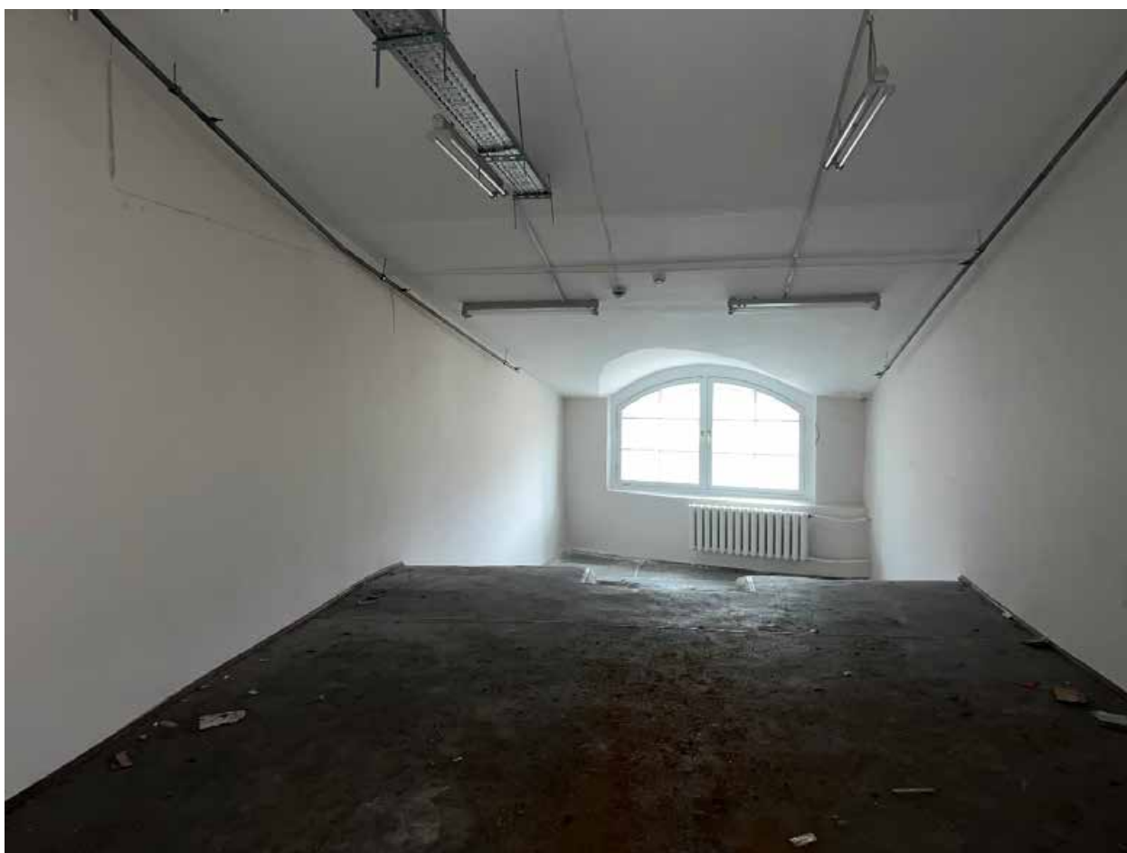
Фото №48. Помещение третьего этажа (мансарда).
