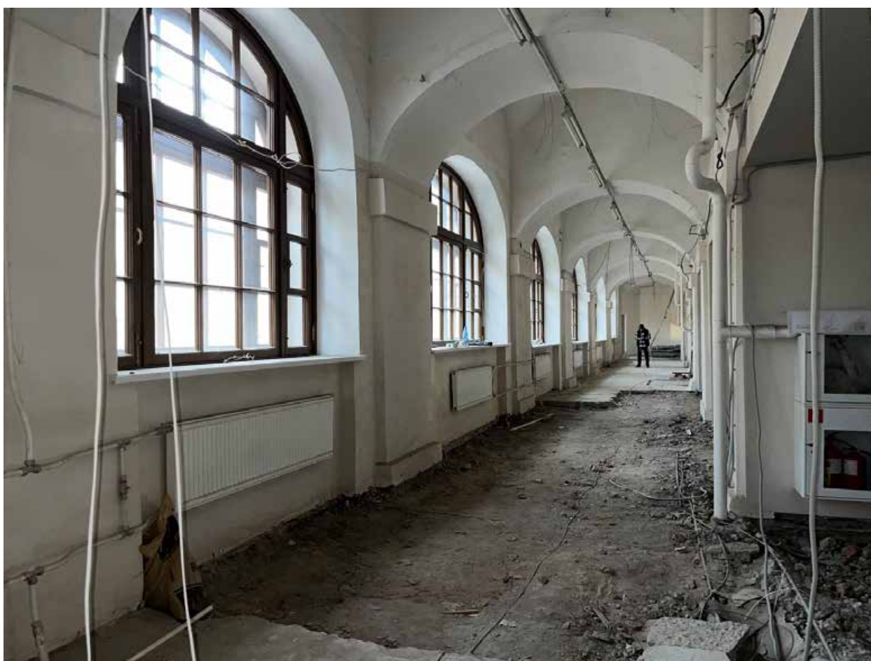
Фото №21. Второй этаж. Галерея вдоль стены дворового фасада.
