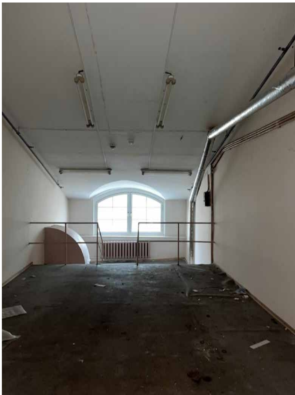
Фото №34. Помещение третьего этажа (мансарда).
