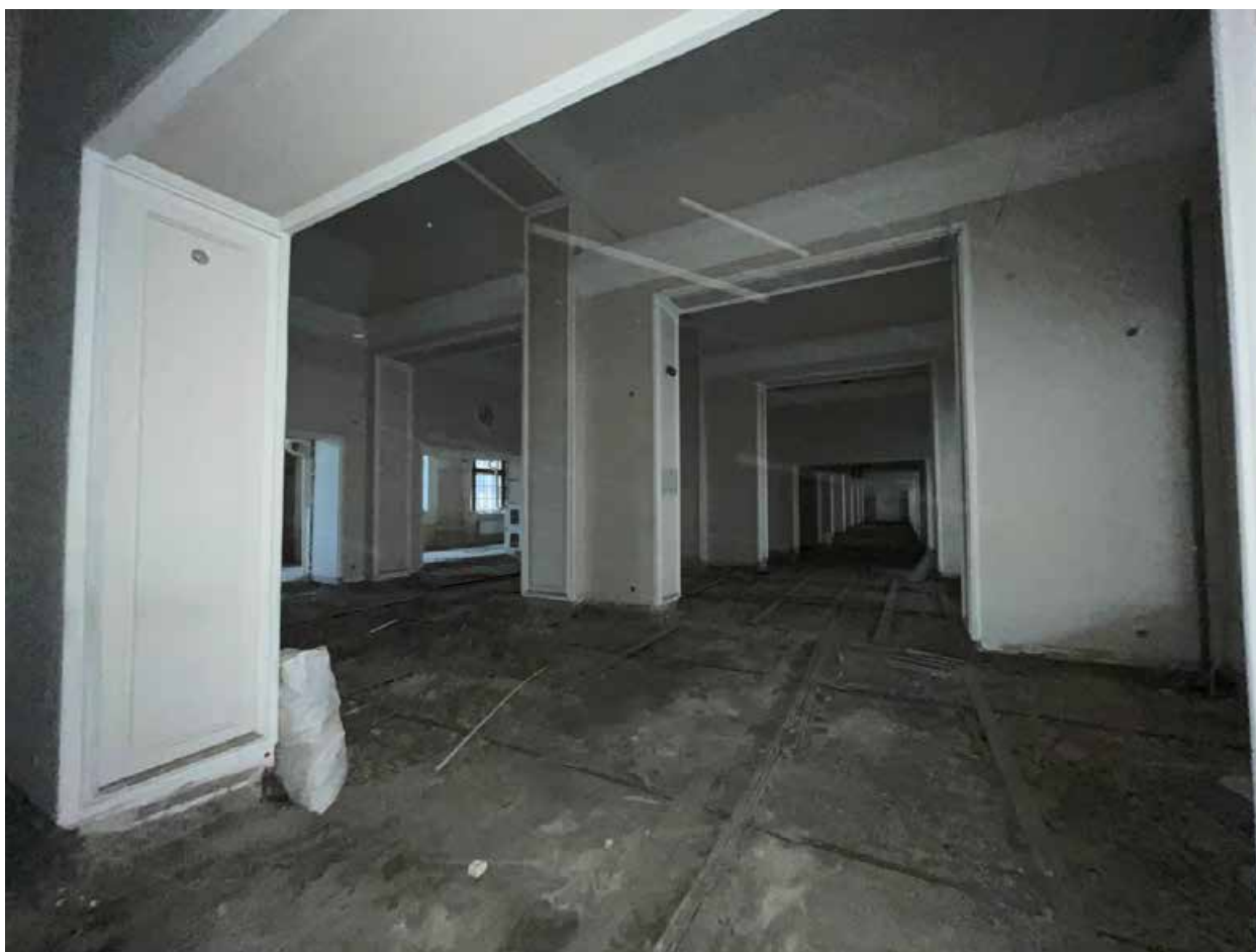
Фото №25. Второй этаж. Общий вид помещений.
