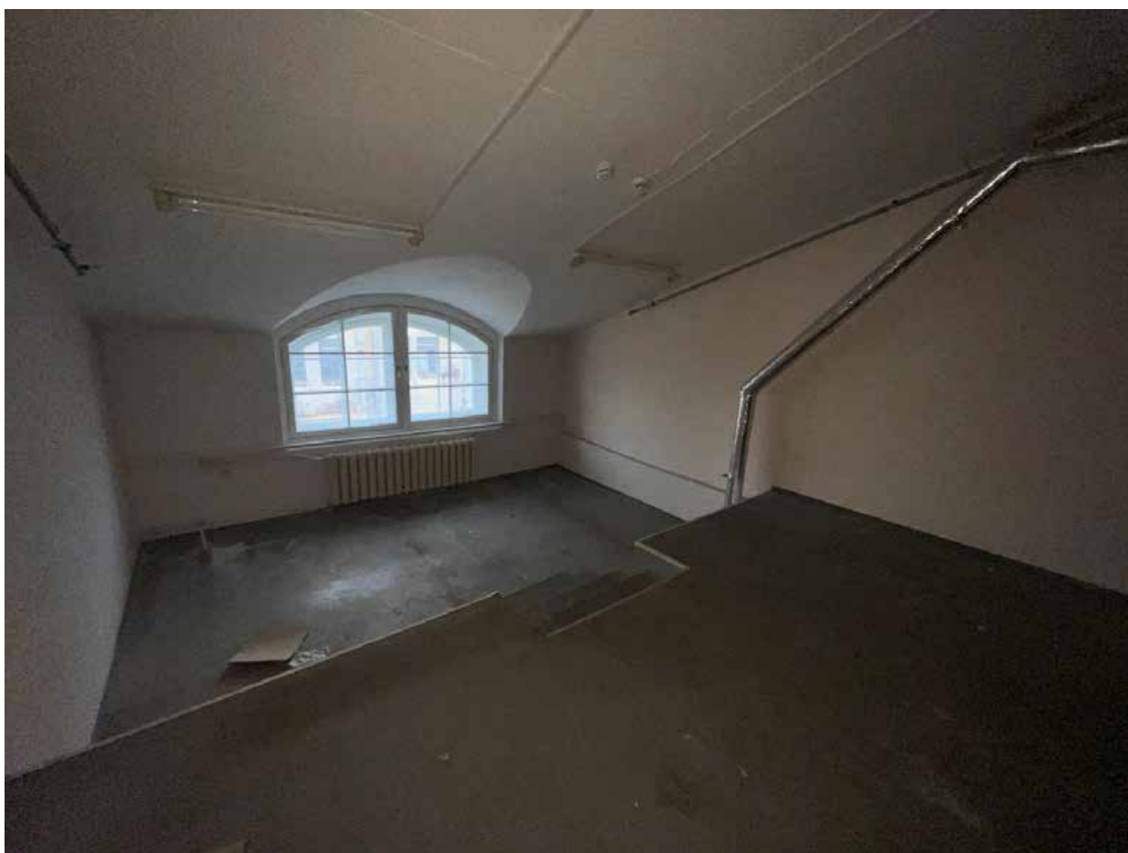
Фото №43. Помещение третьего этажа (мансарда).
