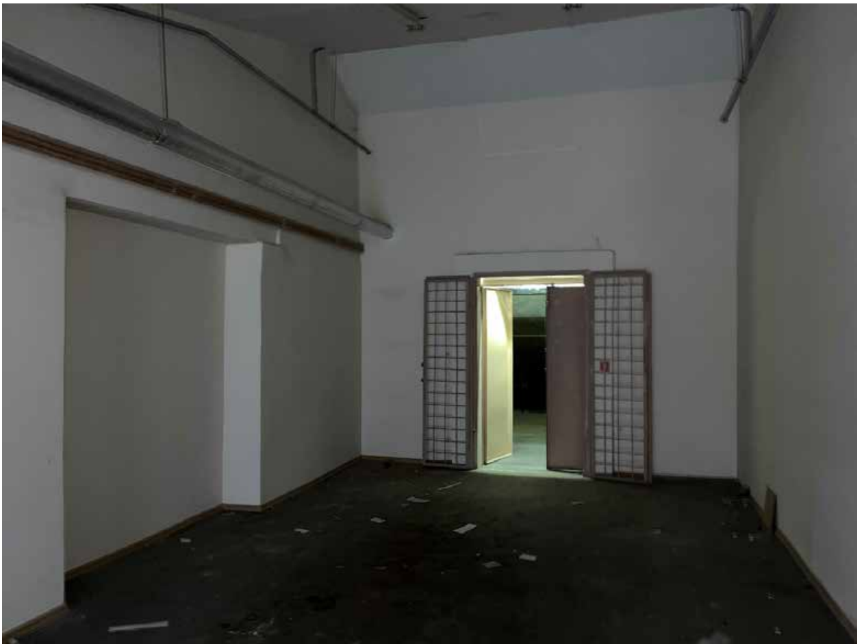
Фото №35. Помещение третьего этажа (мансарда).
