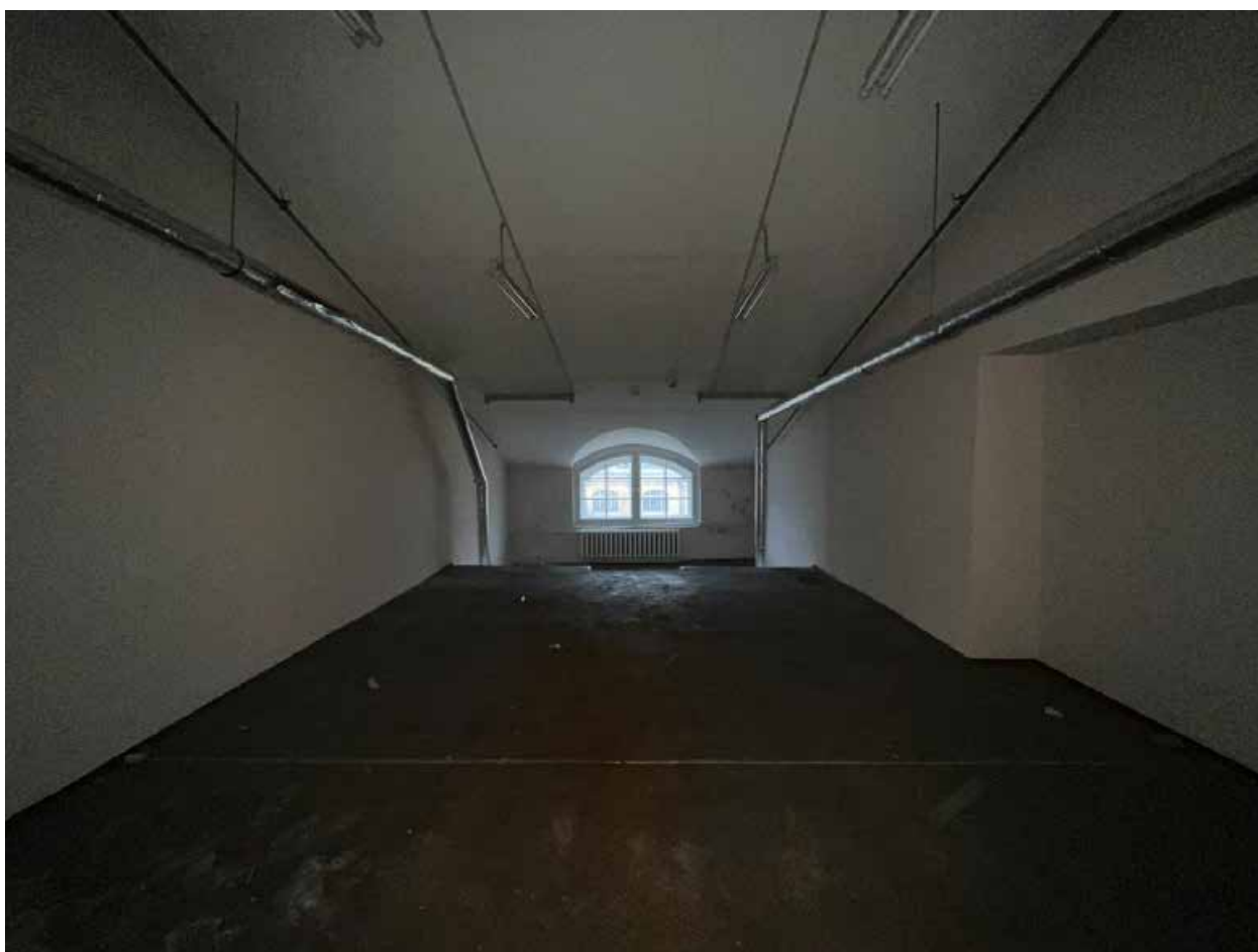
Фото №46. Помещение третьего этажа (мансарда).
