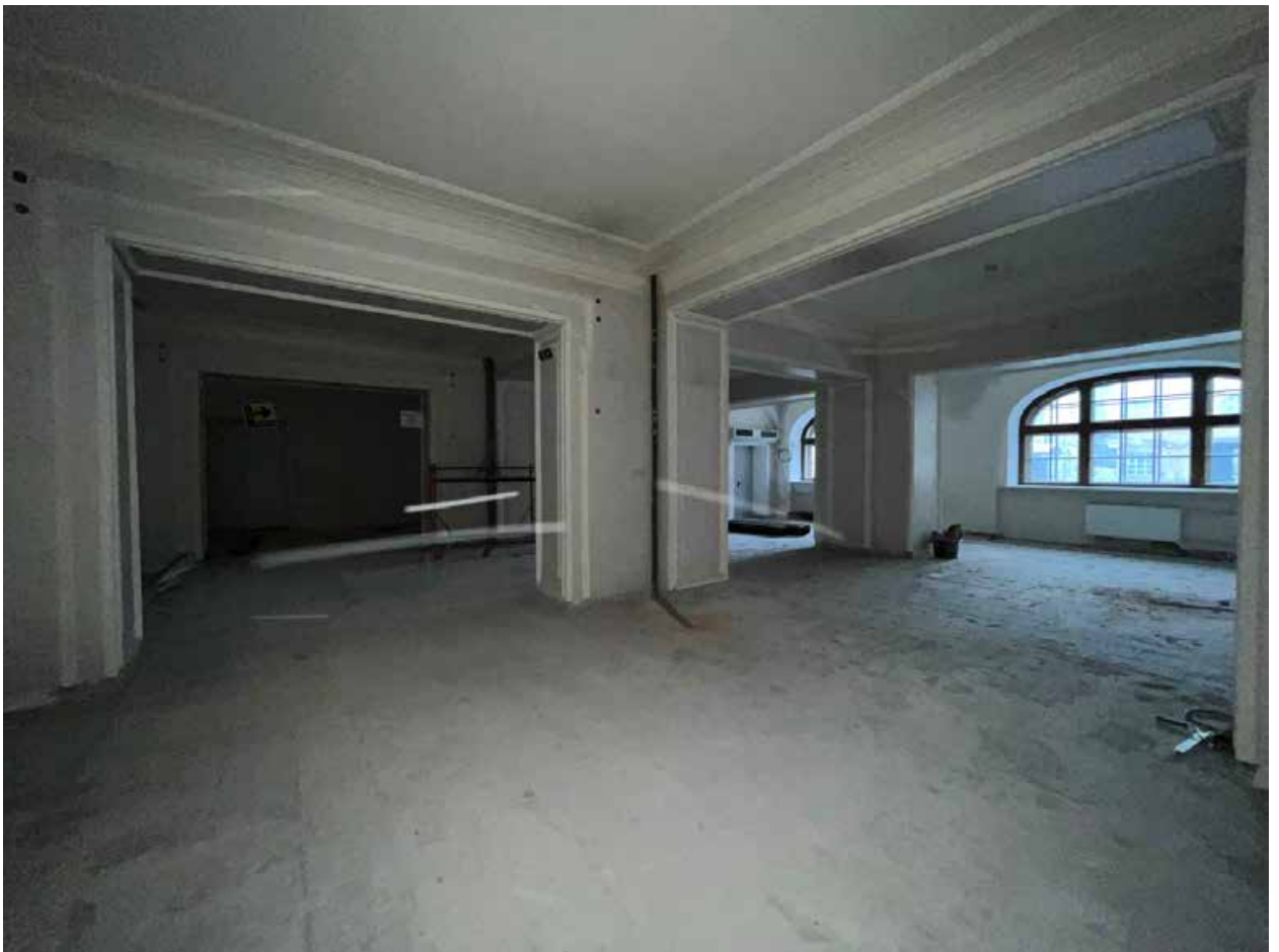
Фото №14. Первый этаж. Общий вид помещений.
