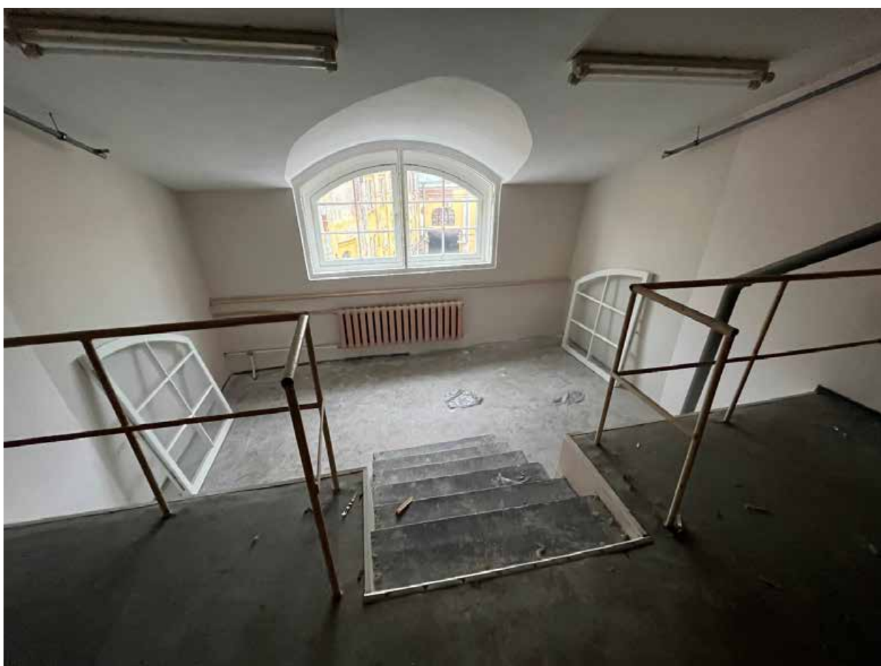
Фото №27. Помещение третьего этажа (мансарда).
