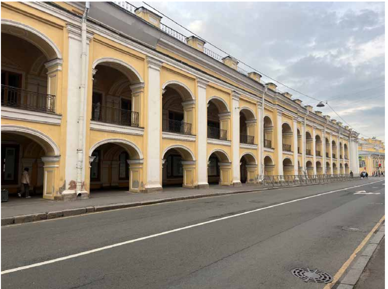
Фото №4. Лицевой фасад Ломоносовской улице.
