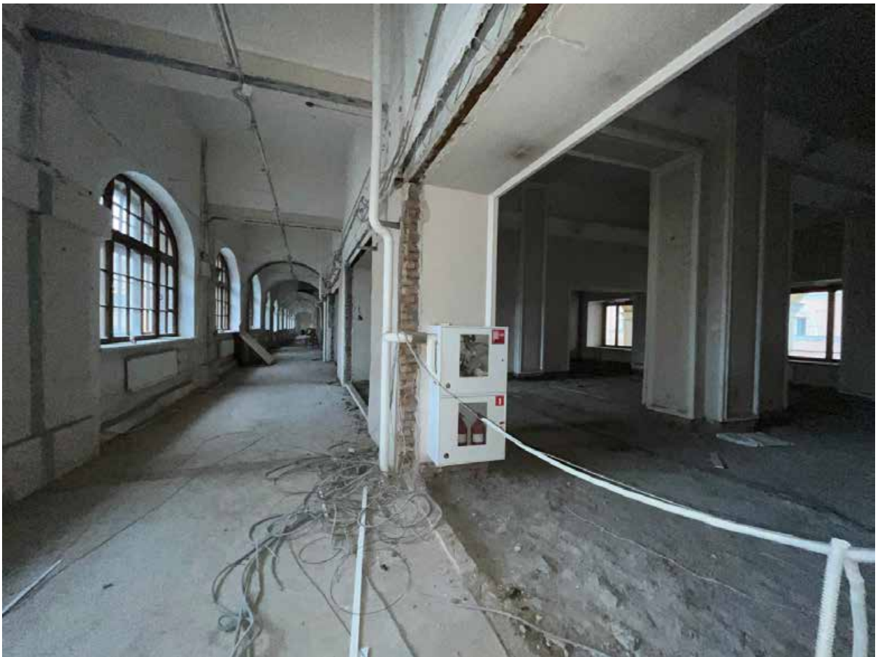
Фото №23. Второй этаж. Общий вид помещений.
