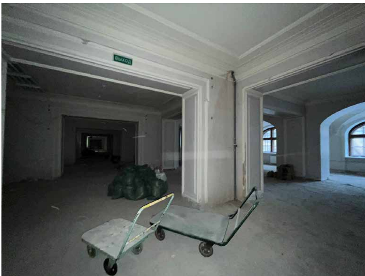
Фото №10. Первый этаж. Общий вид помещений.
