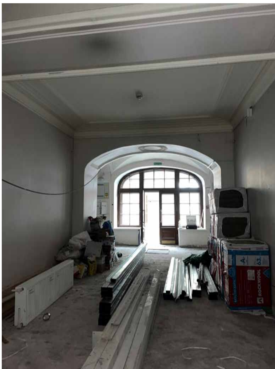
Фото №12. Первый этаж. Вход со стороны двора.
