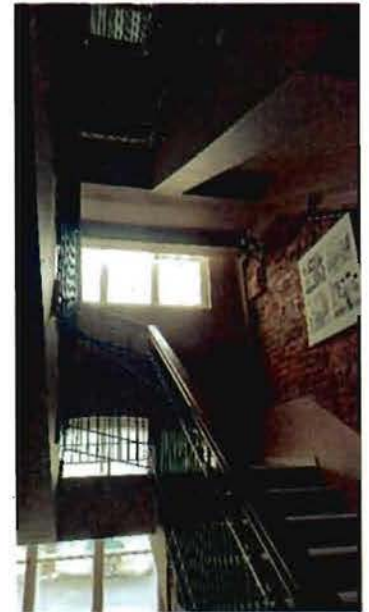
7. Лестница. (Невский пр-кт, дом 35, лит. В)
