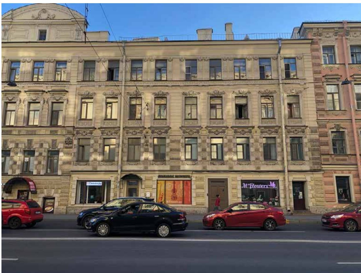
1. Северо-восточный лицевой фасад объекта культурного наследия федерального значения «Дом, где жили: в 1877-1916 гг. - композитор Направник Э.Ф., в 1882-1908 гг. - композитор Стравинский И.Ф., в 1946-1982 гг. - геолог Наливкин Д.В.», расположенного по адресу: г. Санкт-Петербург, улица Глинки 3-5-7, литера А. 10.07.2022
