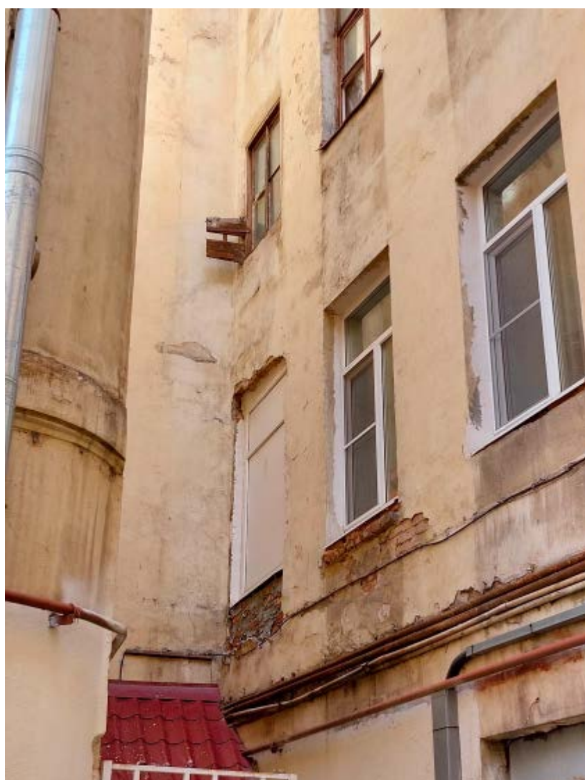
3. Юго-западный дворовый фасад объекта культурного наследия федерального значения «Дом, где жили: в 1877-1916 гг. - композитор Направник Э.Ф., в 1882-1908 гг. - композитор Стравинский И.Ф., в 1946-1982 гг. - геолог Наливкин Д.В.», расположенного по адресу: г. Санкт-Петербург, улица Глинки 3-5-7, литера А. 10.07.2022
