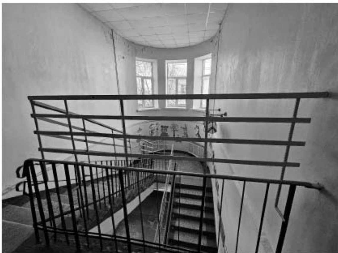
101. Выявленный объект культурного наследия «Особняк Е.А. Брюно», по адресу: г. Санкт-Петербург, Почтамтская ул., д. 19-21, лит. А. Общий вид парадной лестницы в уровне 2-го этажа.
