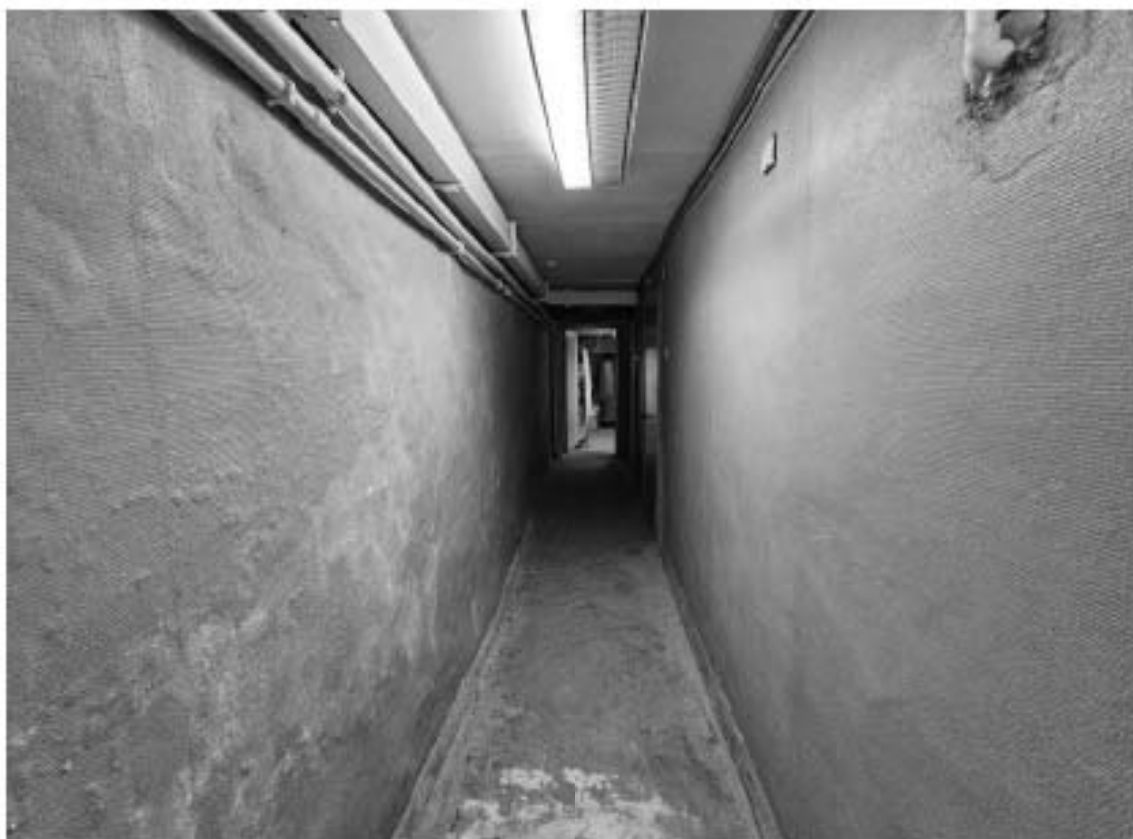
15. Выявленный объект культурного наследия «Особняк Е.А. Брюн», по адресу: г. Санкт-Петербург, Почтамтская ул., д. 19-21, лит. А. Фрагмент пом. 2-Н (6) в уровне цокольного этажа.
