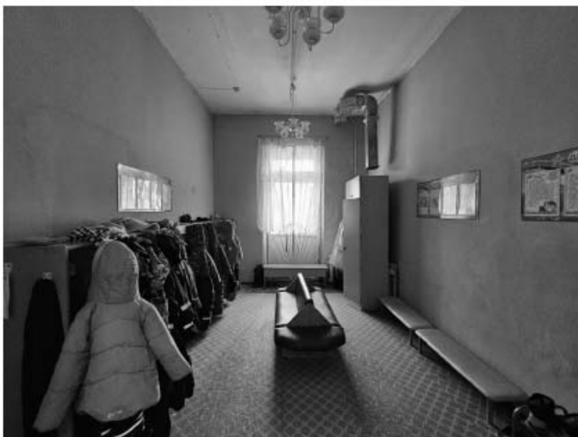
63. Выявленный объект культурного наследия «Особняк Е.А. Брюн», по адресу: г. Санкт-Петербург, Почтамтская ул., д. 19-21, лит. А. Общий вид пом. 7-Н (3) в уровне 1-го этажа.
