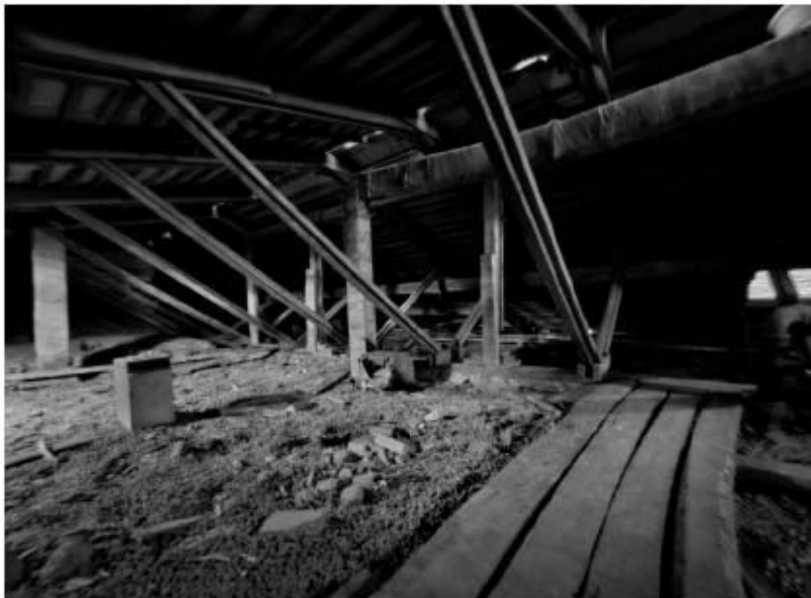
121. Выявленный объект культурного наследия «Особняк Е.А. Брюн», по адресу: г. Санкт-Петербург, Почтамтская ул., д. 19-21, лит. А. Фрагмент стропильной системы двускатной крыши лицевого корпуса.
