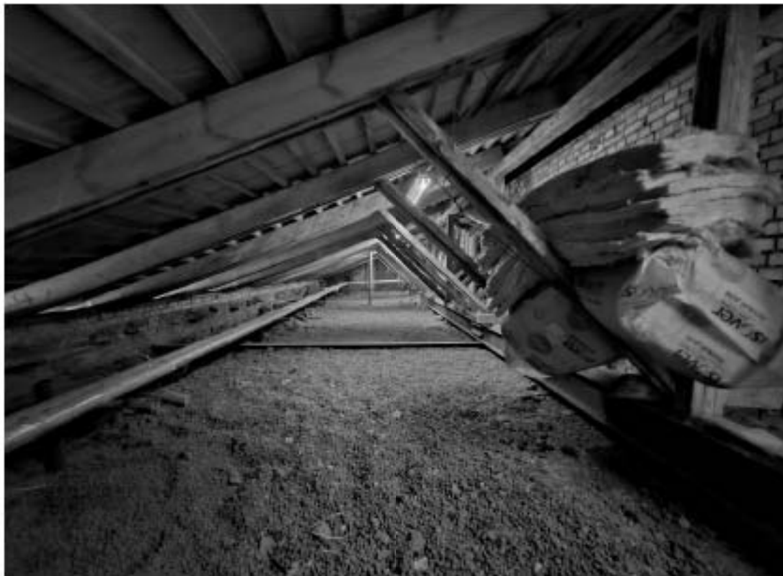
123. Выявленный объект культурного наследия «Особняк Корсаковой», по адресу: г. Санкт-Петербург, Почтамтская ул., д. 19-21, лит. А. Общий вид стропильной системы двускатной крыши дворового корпуса.
