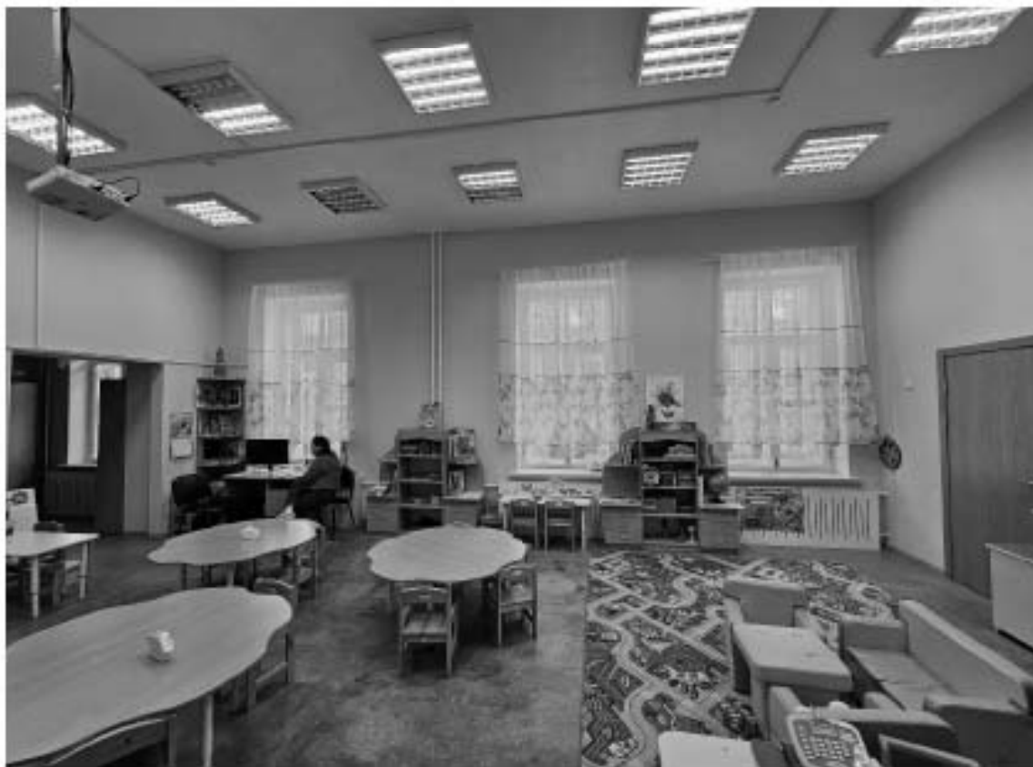
109. Выявленный объект культурного наследия «Особняк Корсаковой», по адресу: г. Санкт-Петербург, Почтамтская ул., д. 19-21, лит. А. Общий вид пом. 10-Н (3) в уровне 2-го этажа.
