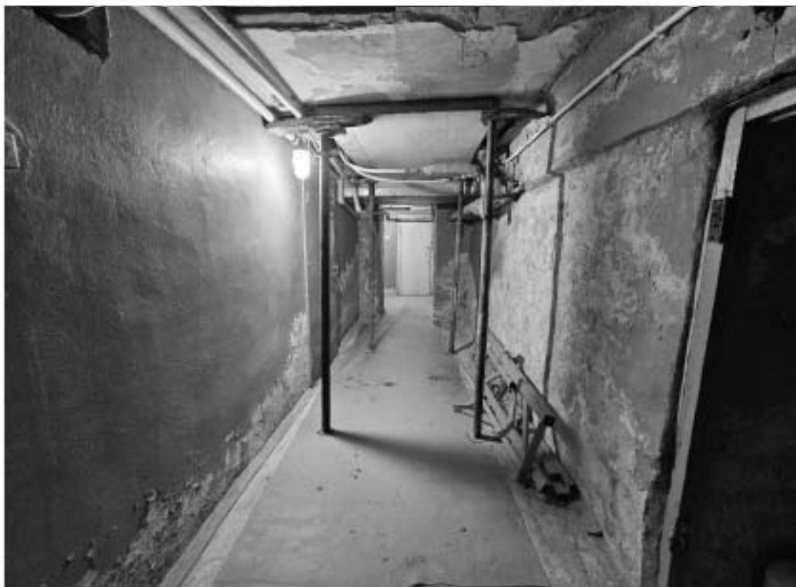
21. Выявленный объект культурного наследия «Особняк Е.А. Брюн», по адресу: г. Санкт-Петербург, Почтамтская ул., д. 19-21, лит. А. Общий вид пом. 1-Н (1) в уровне цокольного этажа.
