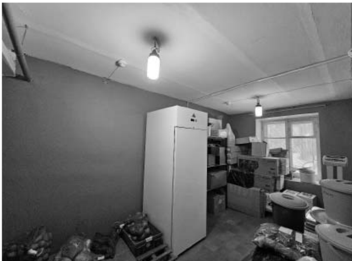
16. Выявленный объект культурного наследия «Особняк Е.А. Брюн», по адресу: г. Санкт-Петербург, Почтамтская ул., д. 19-21, лит. А. Общий вид пом. 2-Н (4) в уровне цокольного этажа.
