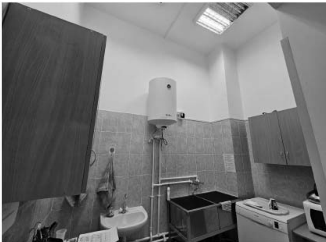
114. Выявленный объект культурного наследия «Особняк Корсаковой», по адресу: г. Санкт-Петербург, Почтамтская ул., д. 19-21, лит. А. Общий вид пом. 11-Н (3) в уровне 2-го этажа.
