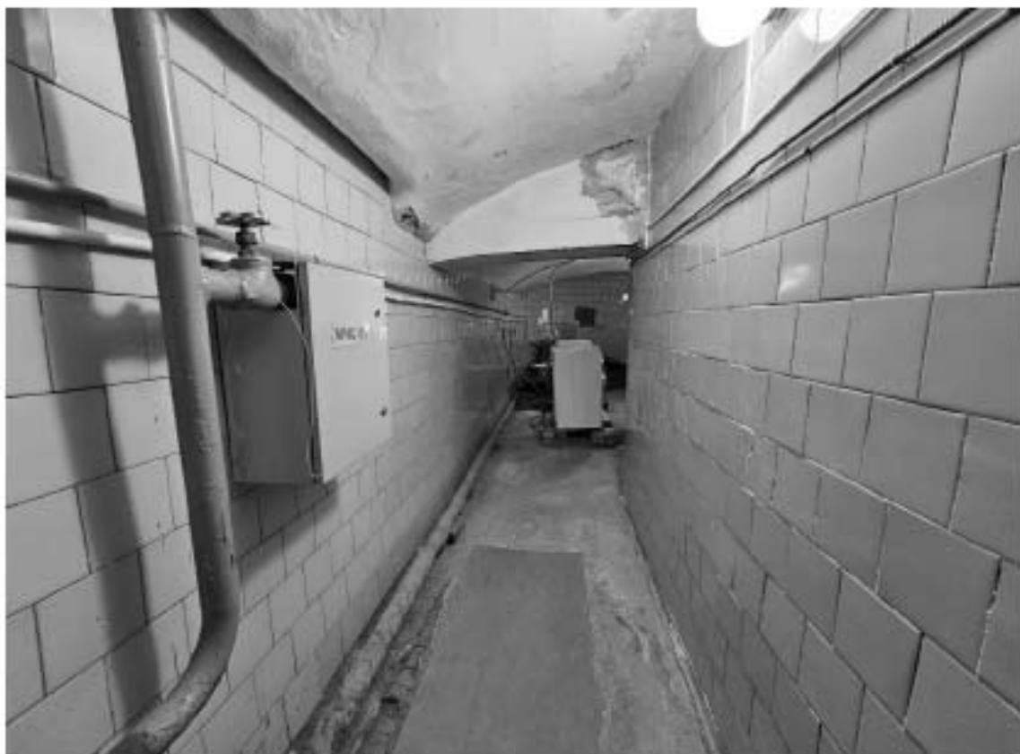
32. Выявленный объект культурного наследия «Особняк Е.А. Брюн», по адресу: г. Санкт-Петербург, Почтамтская ул., д. 19-21, лит. А. Фрагмент пом. 1-Н (11) в уровне цокольного этажа.
