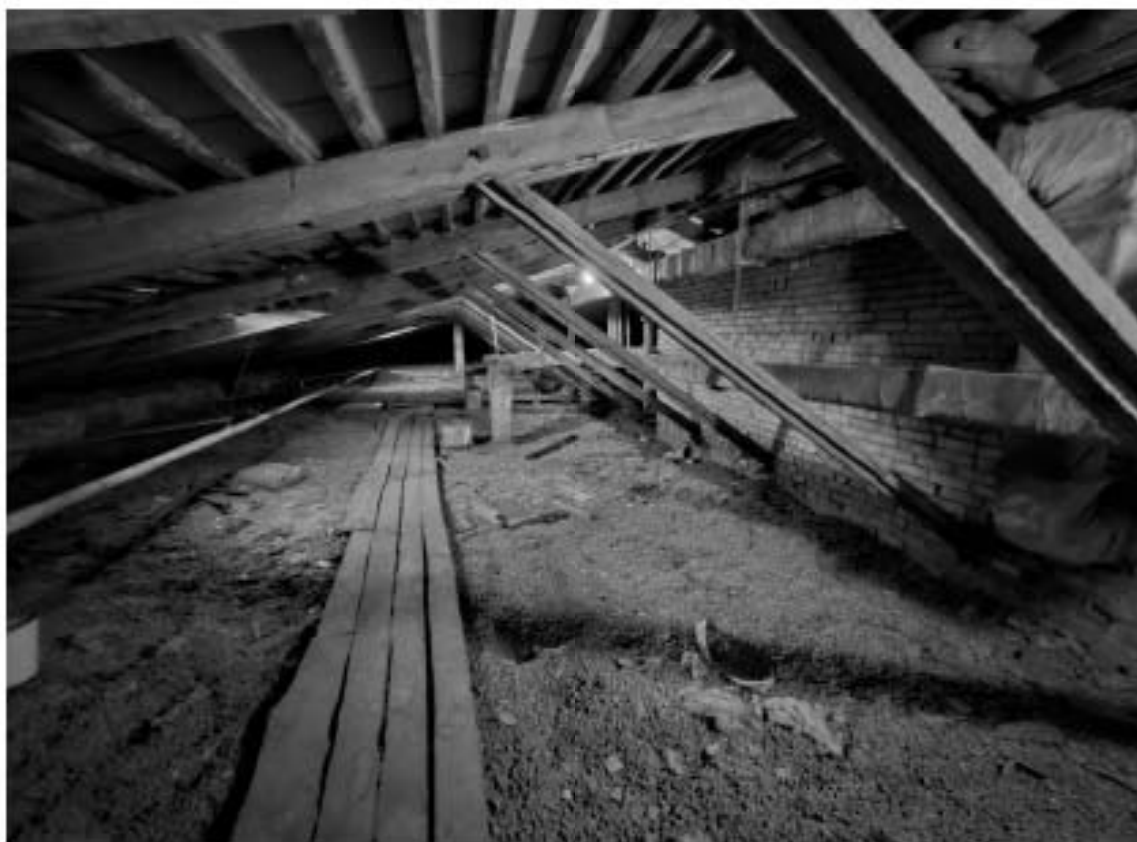
120. Выявленный объект культурного наследия «Особняк Е.А. Брюн», по адресу: г. Санкт-Петербург, Почтамтская ул., д. 19-21, лит. А. Фрагмент стропильной системы двускатной крыши лицевого корпуса.
