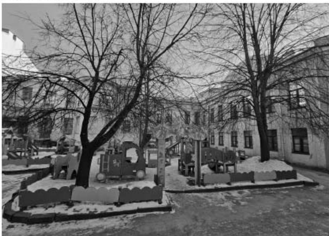
8. Общий вид северо-западного дворового фасада лицевого корпуса выявленного объекта культурного наследия «Особняк Е.А. Брюн», северо-западного дворового фасада лицевого корпуса и северо-восточного дворового фасада дворового корпуса выявленного объекта культурного наследия «Особняк Корсаковой», по адресу: г. Санкт-Петербург, Почтамтская ул., д. 19-21, лит. А.
