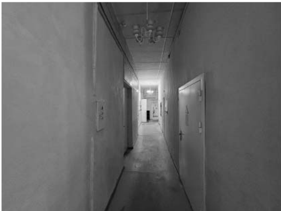
66. Выявленный объект культурного наследия «Особняк Е.А. Брюн», по адресу: г. Санкт-Петербург, Почтамтская ул., д. 19-21, лит. А. Общий вид пом. 7-Н (1) в уровне 1-го этажа.
