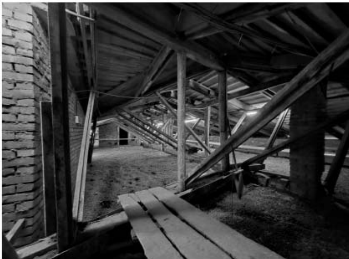
124. Выявленный объект культурного наследия «Особняк Корсаковой», по адресу: г. Санкт-Петербург, Почтамтская ул., д. 19-21, лит. А. Общий вид стропильной системы двускатной крыши лицевого корпуса.
