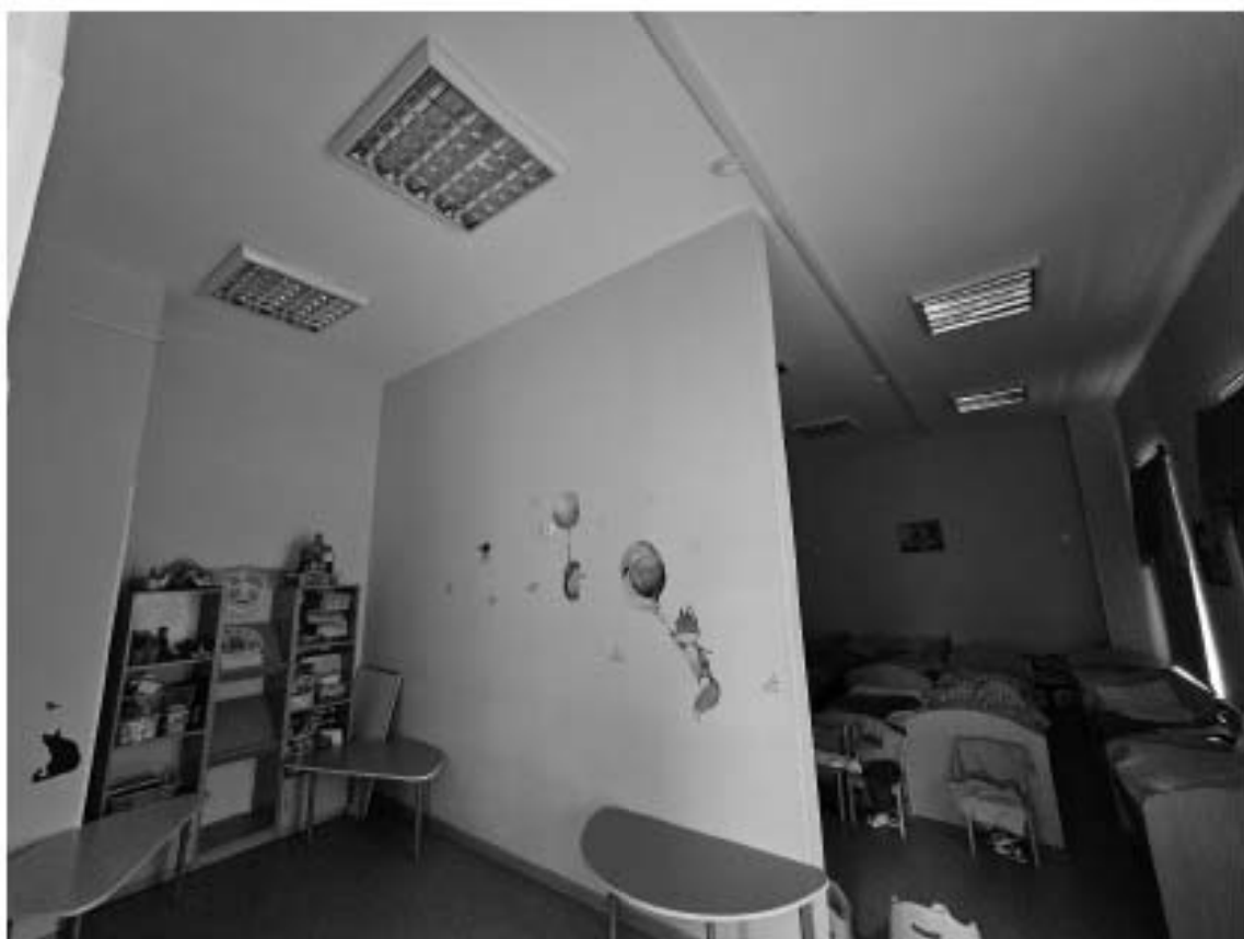
47. Выявленный объект культурного наследия «Особняк Корсаковой», по адресу: г. Санкт-Петербург, Почтамтская ул., д. 19-21, лит. А. Общий вид пом. 4-Н (2) в уровне 1-го этажа.
