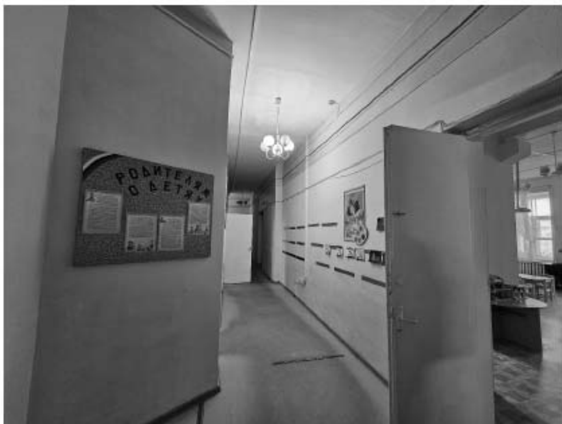
57. Выявленный объект культурного наследия «Особняк Е.А. Брюн», по адресу: г. Санкт-Петербург, Почтамтская ул., д. 19-21, лит. А. Общий вид пом. 7-Н (1) в уровне 1-го этажа.
