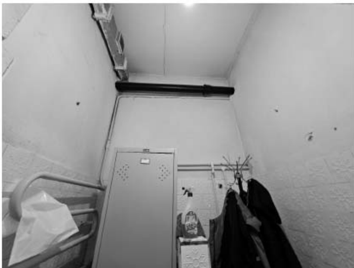
69. Выявленный объект культурного наследия «Особняк Е.А. Брюн», по адресу: г. Санкт-Петербург, Почтамтская ул., д. 19-21, лит. А. Общий вид пом. 8-Н (2) в уровне 1-го этажа.
