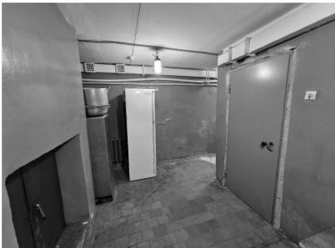
14. Выявленный объект культурного наследия «Особняк Е.А. Брюн», по адресу: г. Санкт-Петербург, Почтамтская ул., д. 19-21, лит. А. Фрагмент пом. 2-Н (6) в уровне цокольного этажа.
