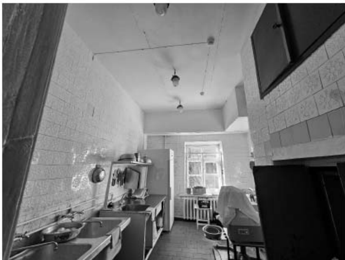
71. Выявленный объект культурного наследия «Особняк Е.А. Брюн», по адресу: г. Санкт-Петербург, Почтамтская ул., д. 19-21, лит. А. Общий вид пом. 8-Н (6) в уровне 1-го этажа.
