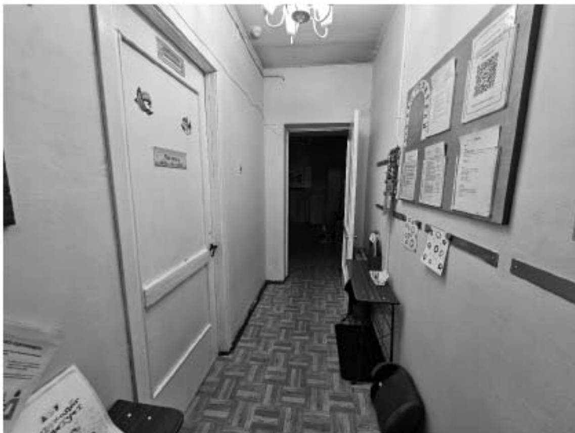
86. Выявленный объект культурного наследия «Особняк Е.А. Брюн», по адресу: г. Санкт-Петербург, Почтамтская ул., д. 19-21, лит. А. Общий вид пом. 13-Н (1) в уровне 2-го этажа.
