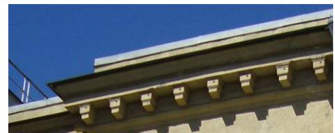
профилированный венчающий карниз с двухчастными сухариками;
