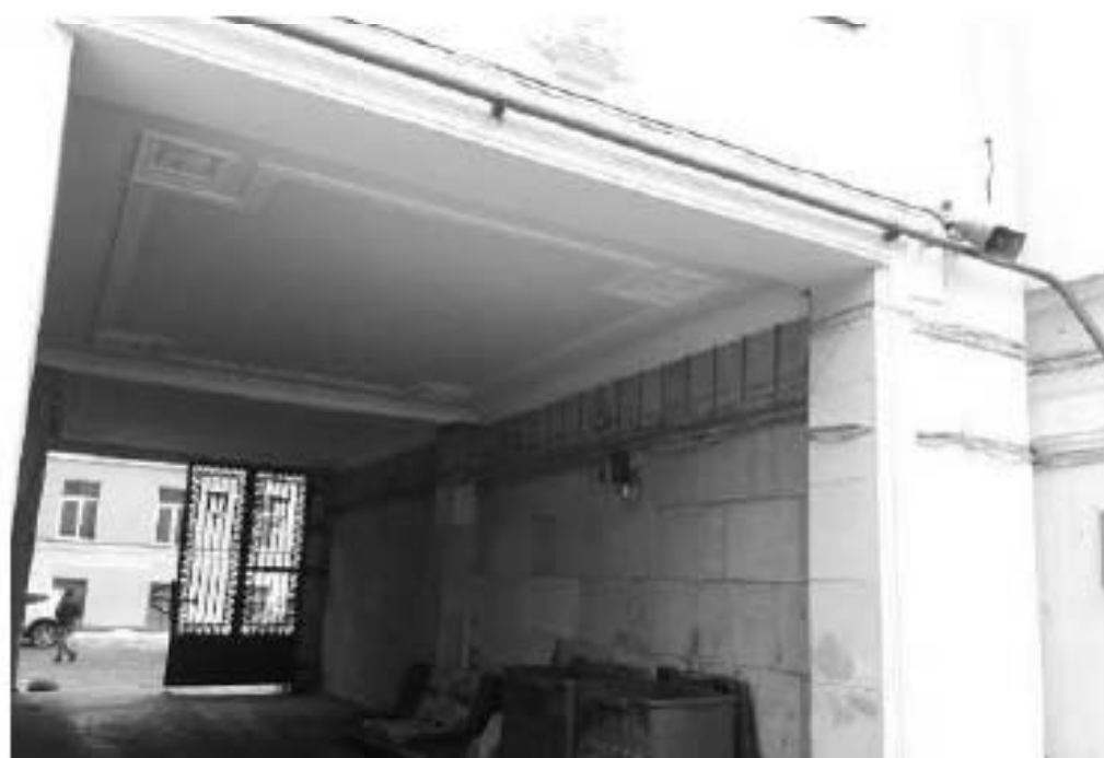
7. Дом Яковлевых (Евментьева А.Ф.). Гороховая ул., д. 57, лит. А. Воротный проезд. Фото мест установки оборудования и кабельных трасс. Штиглиц М.С. 06.03.2022.
