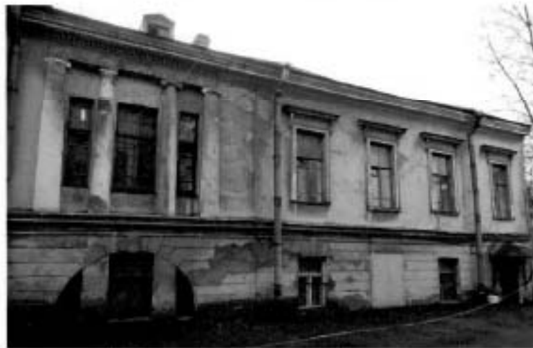
10. Фрагмент северного дворового фасада здания.
