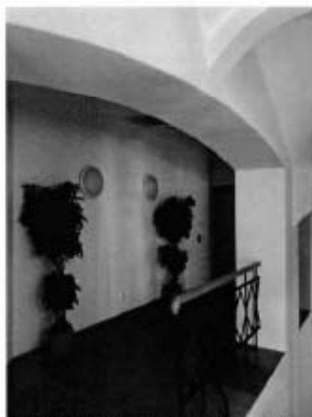
10. Помещение лестничной клетки объекта культурного наследия.
