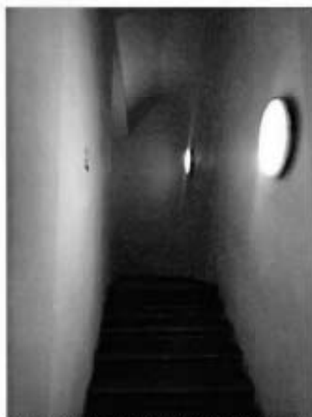
9. Помещение лестничной клетки объекта культурного наследия.
