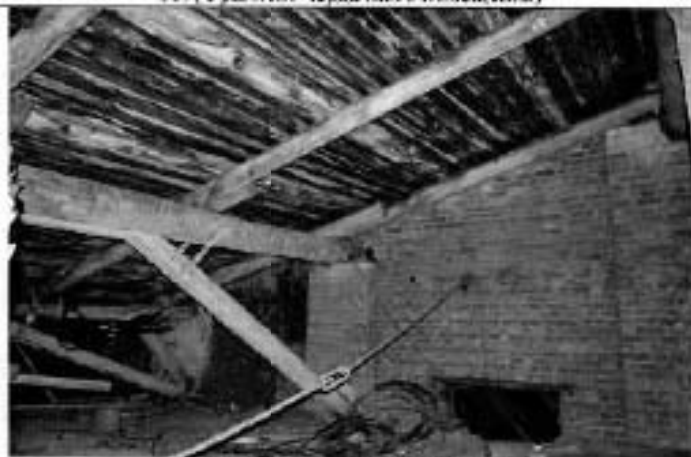
17. (Фрагмент чердачного помещения)
