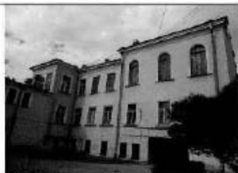
5. (Фрагмент юго-восточного дворового фасада)
