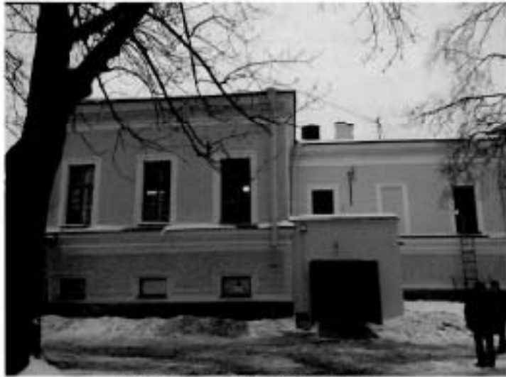
15. Северный дворовый фасад здания.
