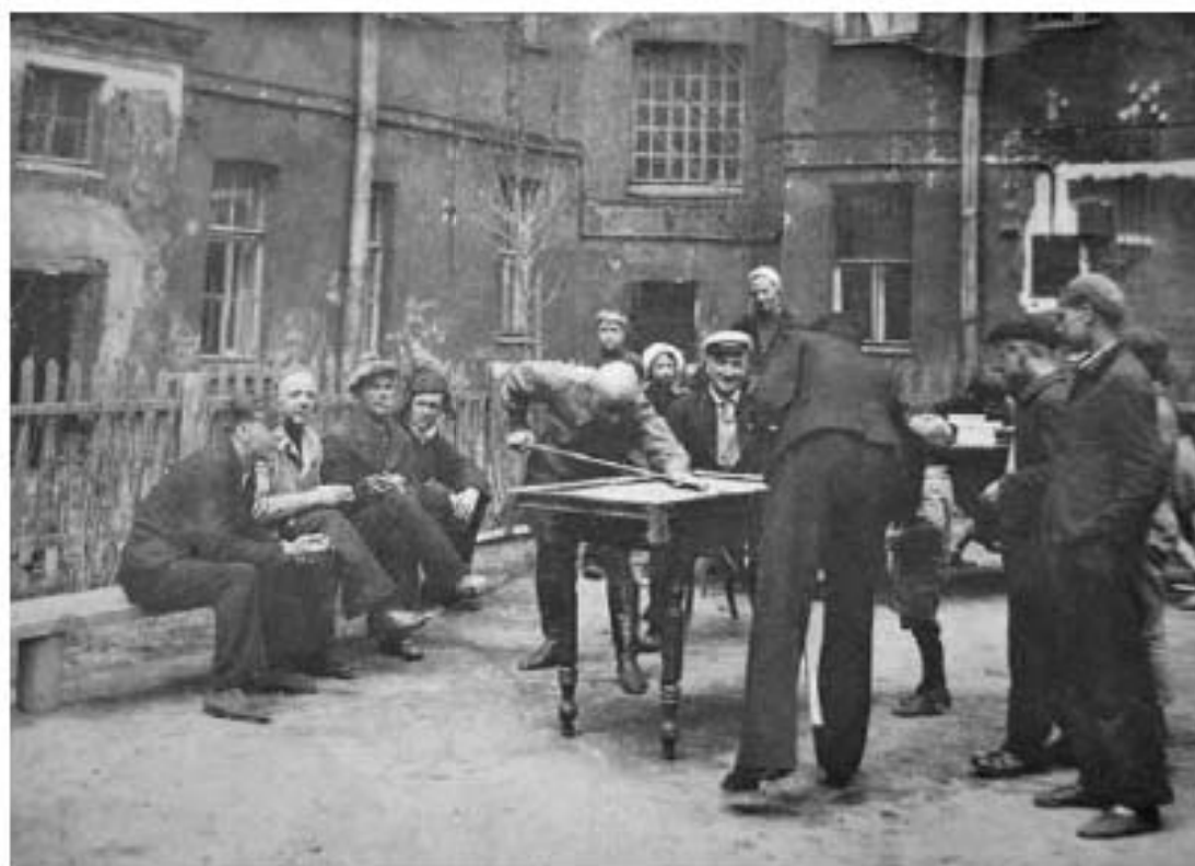
47. Доходный дом (в составе «Здания при Латвийской лютеранской церкви Христа Спасителя»). Загородный пр., д. 64, лит. А. Вид со двора. Фото 1940 г. (24).
