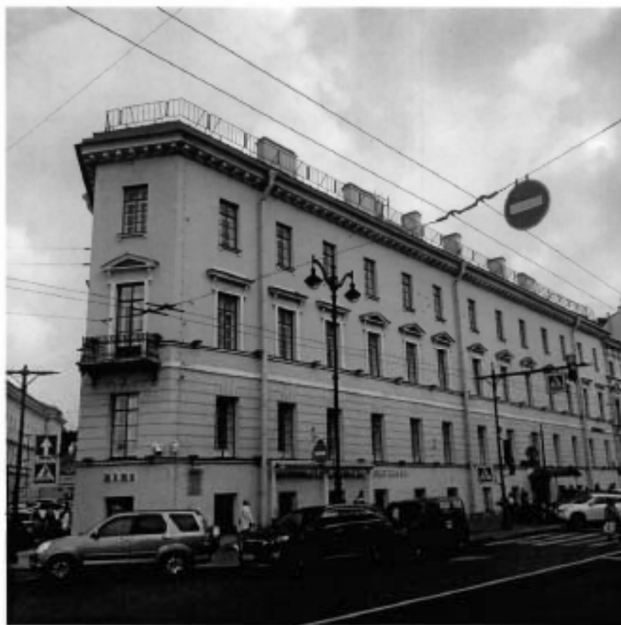
1. Общий вид объекта культурного наследия.
