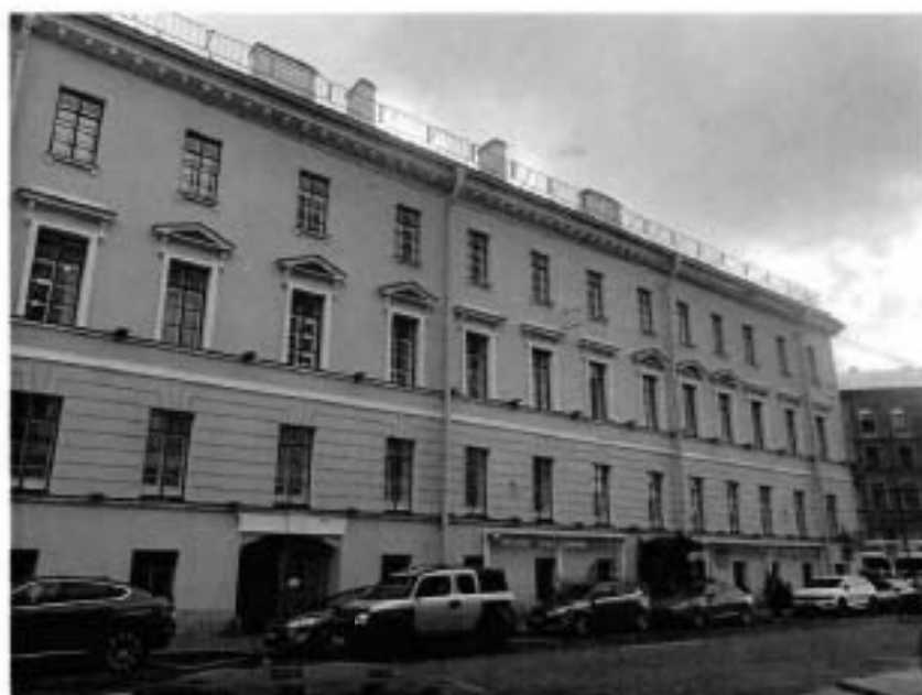
3. Фрагмент западного фасада объекта культурного наследия.
