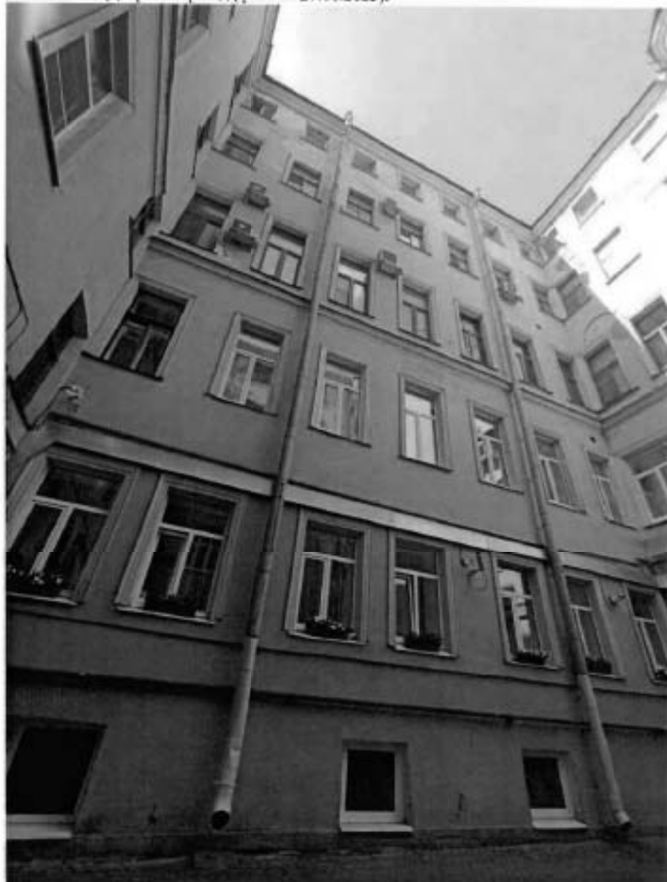
8. Здание 12. Дворовой фасад (фото от 27.06.2023).
