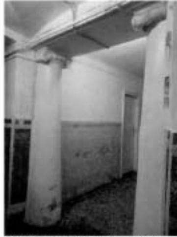
11. Фрагмент интерьера 1-го этажа здания.
