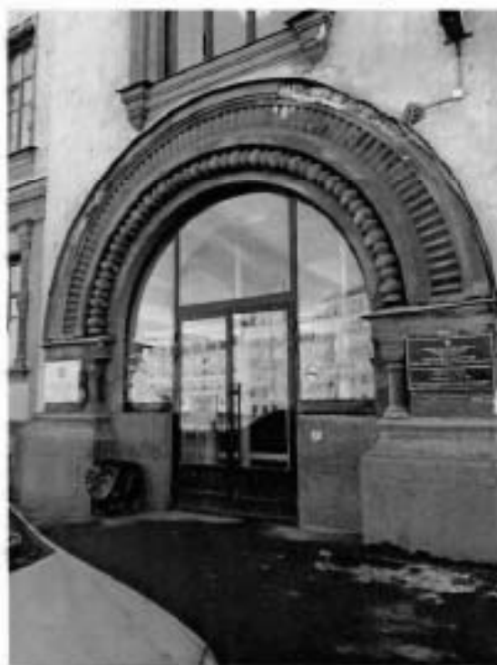
5. Фрагмент объекта культурного наследия с северной стороны. Двери.
