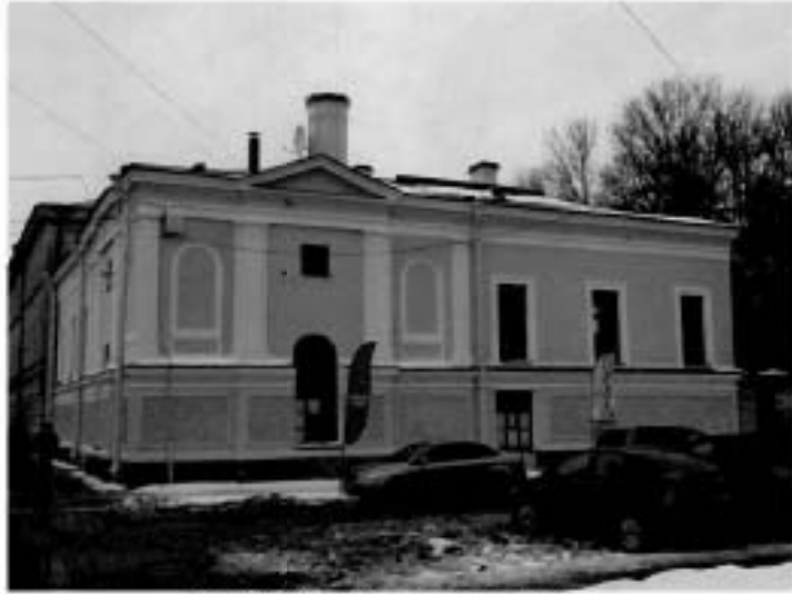
14. Восточный лицевой фасад здания.
