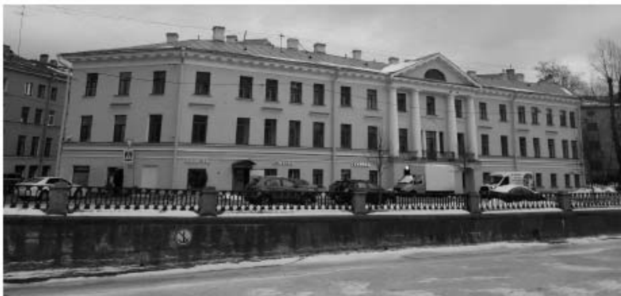
10. Дом Сутугиных. Грибоедова канала наб., д. 106, лит. А. Лицевой фасад. Фото мест установки оборудования и кабельных трасс. Штиглиц М.С. 06.03.2022.
