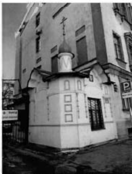
9. Фрагмент объекта культурного наследия с северной стороны. Здание часовни.
