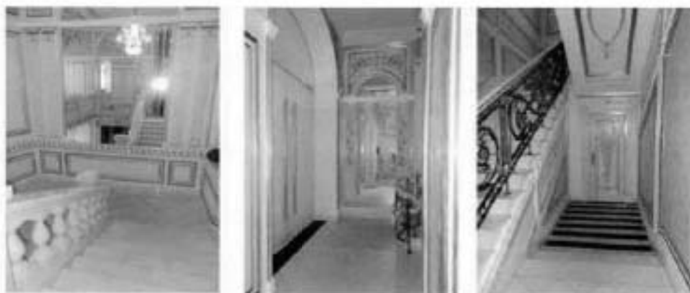
17, 18, 19. Коридорные помещения. Лестница.
