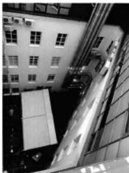
5. Фрагмент территории внутреннего дворового пространства и дворовых фасадов объекта культурного наследия.
