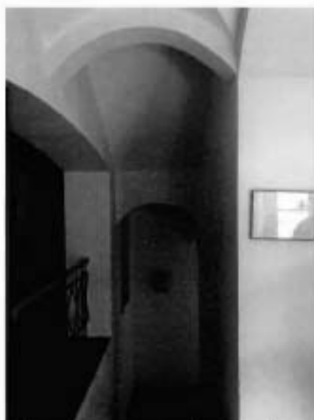
8. Помещение лестничной клетки объекта культурного наследия.
