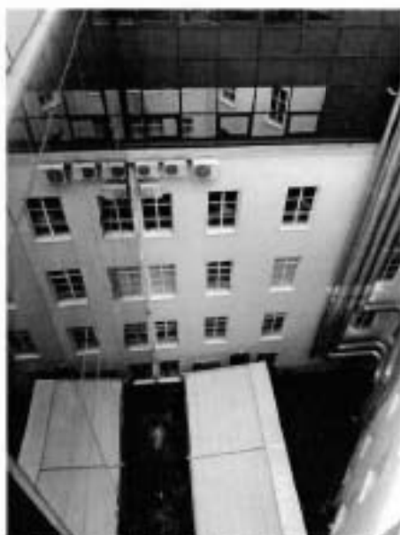
4. Фрагмент территории внутреннего дворового пространства и дворовых фасадов объекта культурного наследия.
