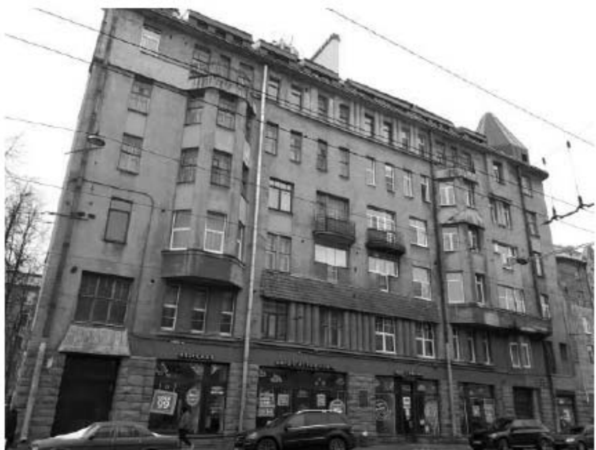
33. Доходный дом (в составе «Здания при Латвийской лютеранской церкви Христа Спасителя»). Загородный пр., д. 64, лит. А. Фото мест установки оборудования и кабельных трасс. Штиглиц М.С. 06.03.2022.
