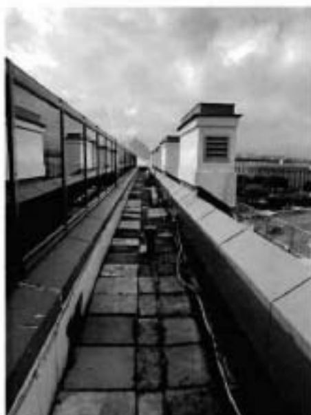
7. Фрагмент эксплуатируемой кровли объекта культурного наследия.
