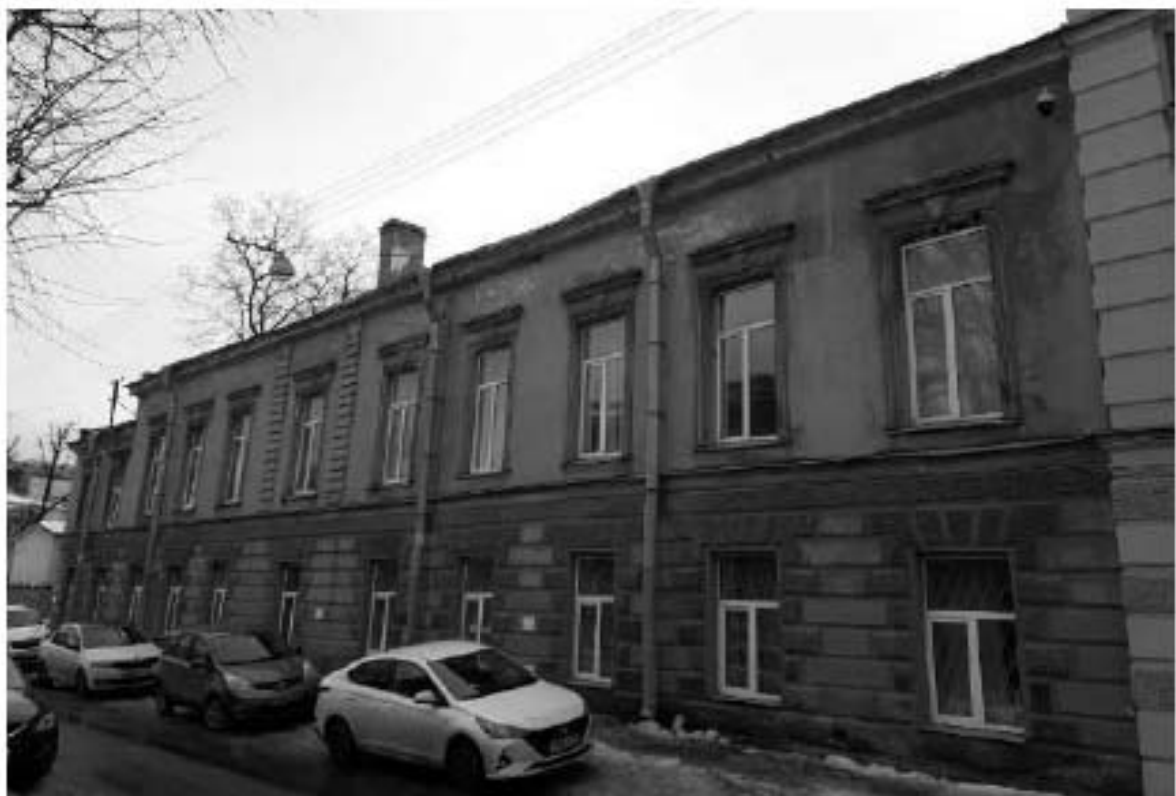
31. Демидовский дом призрения трудящихся. Мойки наб. реки, д. 108, лит. А. Фото мест установки оборудования и кабельных трасс. Штиглиц М.С. 06.03.2022.
