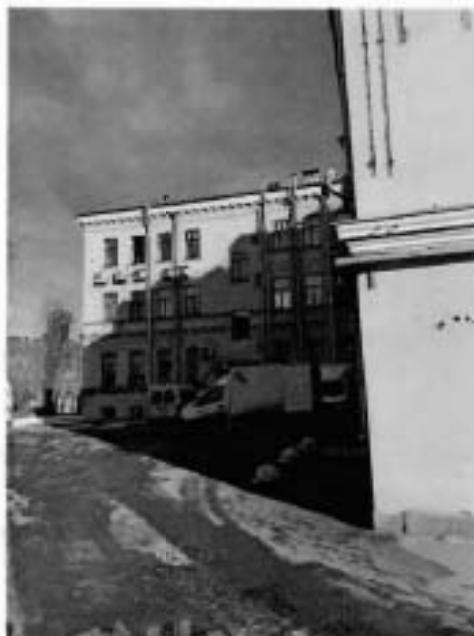
6. Фрагмент объекта культурного наследия с юго-западной стороны.
