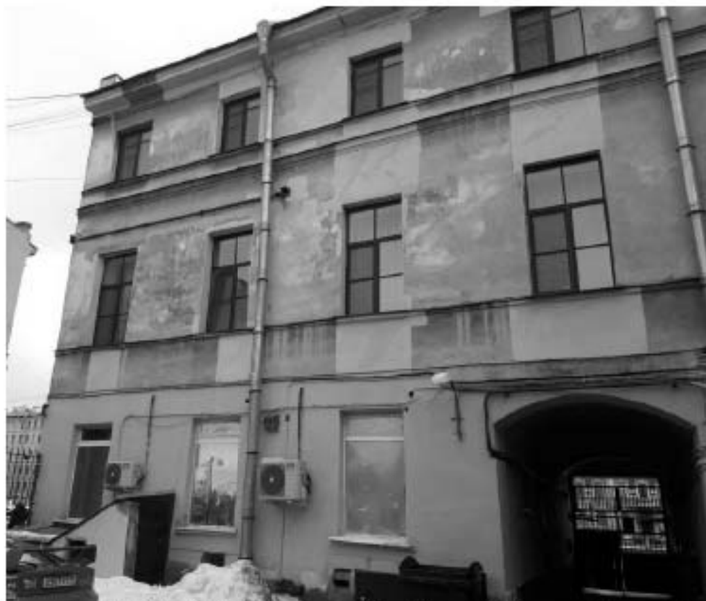
23. Дома Полторацкой С.М. (три). Фонтанки реки наб., д. 97, лит. А. Дворовый фасад. Фото мест установки оборудования и кабельных трасс. Штиглиц М.С. 06.03.2022.
