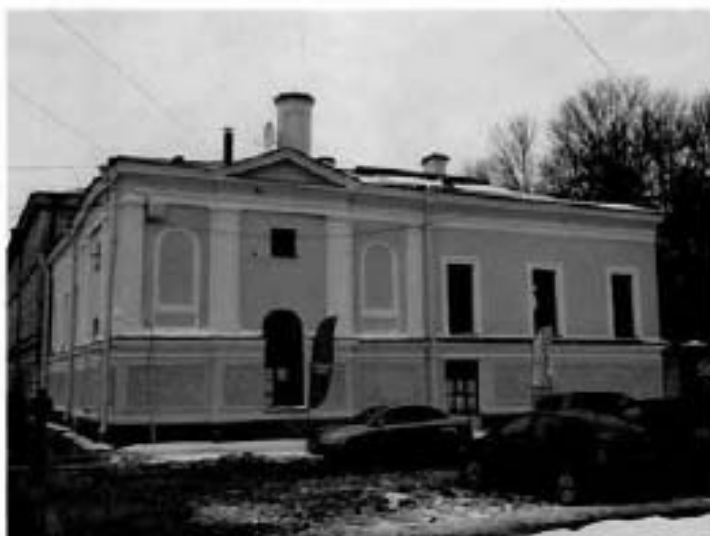
14. Восточный лицевой фасад здания.
