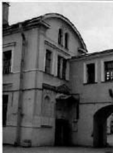
18. (Фрагмент центральной части северного фасада)
