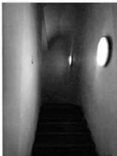
9. Помещение лестничной клетки объекта культурного наследия.
