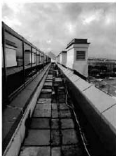
7. Фрагмент эксплуатируемой кровли объекта культурного наследия.
