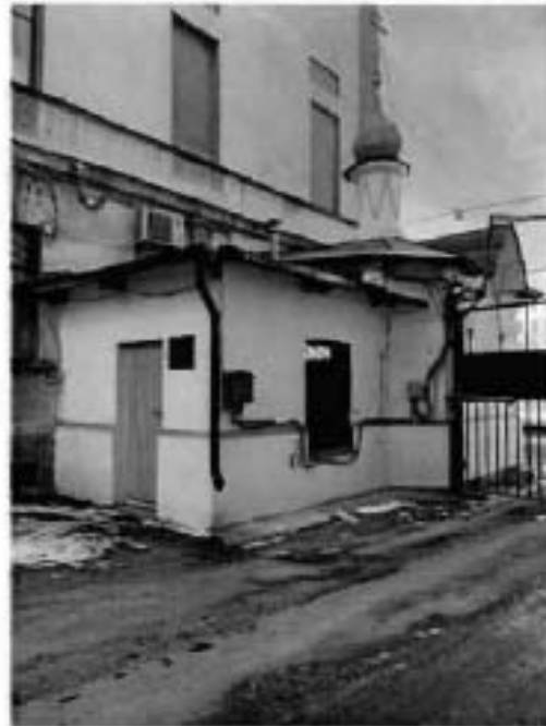
10. Фрагмент объекта культурного наследия с восточной стороны. Здание часовни.
