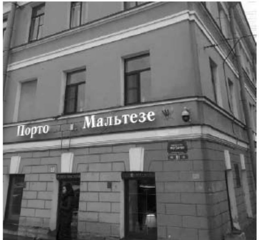
5. Дом Яковлевых (Евментьева А.Ф.). Гороховая ул., д. 57, лит. А. Лицевой фасад. Фото мест установки оборудования и кабельных трасс. Штиглиц М.С. 06.03.2022.
