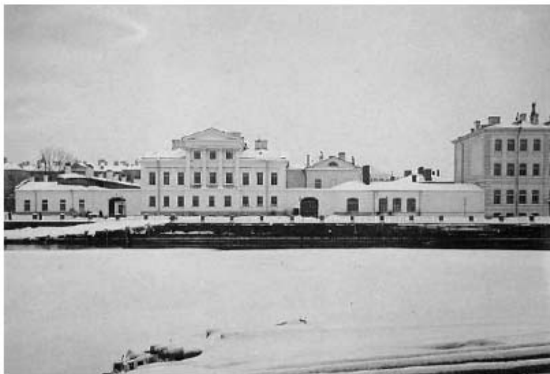
28. Главное здание по наб. р. Фонтанки (в составе «Крестовоздвиженская община сестер милосердия»). Фонтанки реки наб., д. 154, лит. Г. Общий вид здания общины и лечебницы. Фото начала 1900-х гг.(24).
