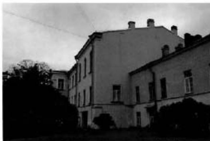
4. (Фрагмент юго-восточного дворового фасада)
