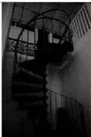
14. (Витовая лестница в уровне 3-го этажа)
