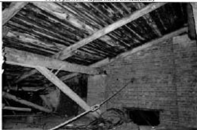
17. (Фрагмент чердачного помещения)
