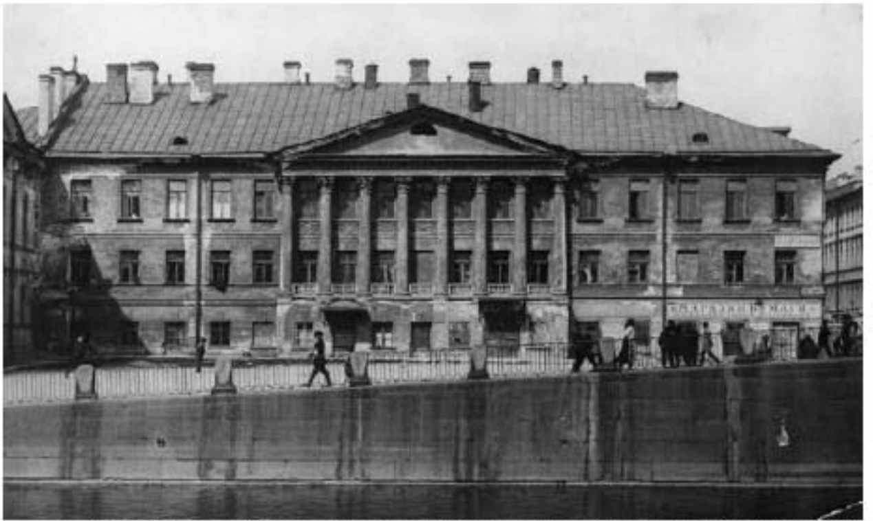
8. Дом Яковлевых (Евментьева А. Ф.). Гороховая ул., д. 57, лит. А. Фото 1940 г. (24).
