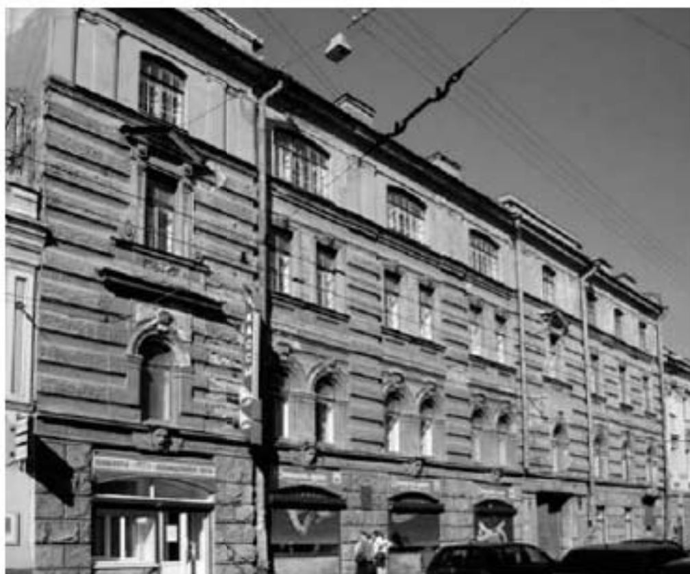
6. Дом Компании для хранения и залога громоздких движимостей. Гороховая ул., д. 47, лит. А. Фото начала 2000-х гг. (24).
