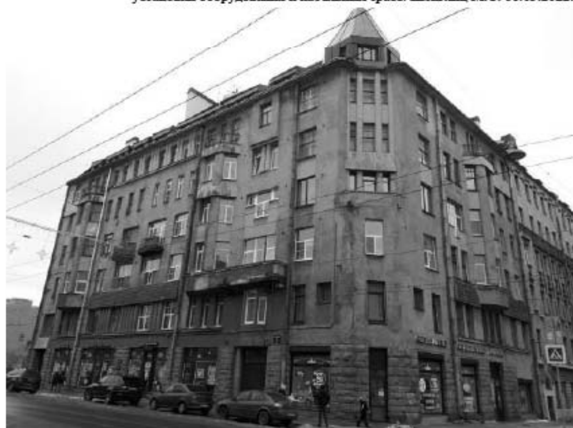
32. Доходный дом (в составе «Здания при Латышской лютеранской церкви Христа Спасителя»). Загородный пр., д. 64, лит. А. Фото мест установки оборудования и кабельных трасс. Штиглиц М.С. 06.03.2022.
