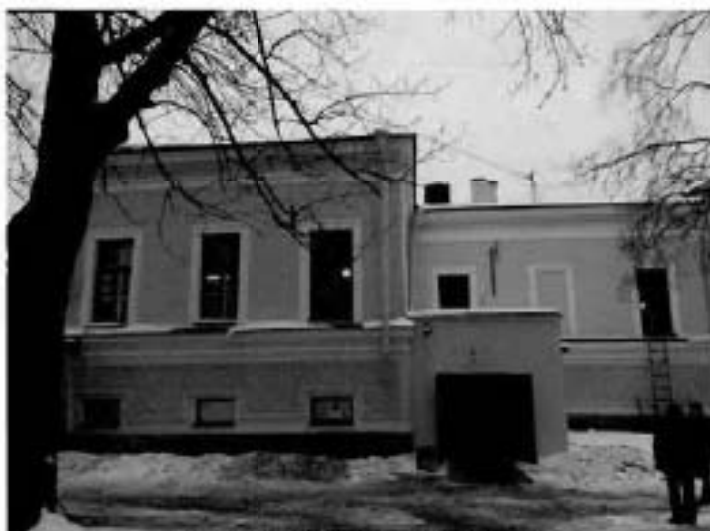
15. Северный дворовый фасад здания.
