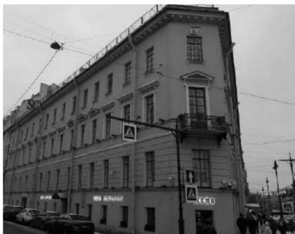
9. Дом, где в 1847-1849 гг. жил писатель Достоевский Ф.М. Малая Морская ул., д. 23, лит. А. Лицевой фасад. Фото мест установки оборудования и кабельных трасс. Штиглиц М.С. 06.03.2022.
