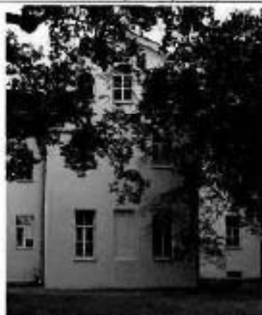
21. (Фрагмент центральной части восточного фасада)
