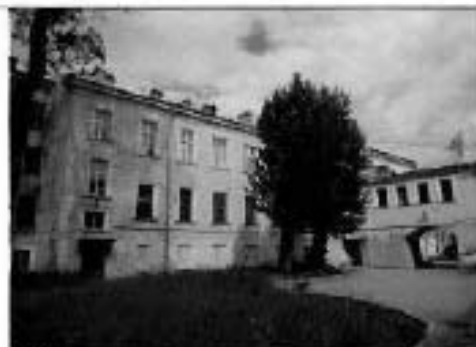
6. (Фрагмент восточного дворового фасада)
