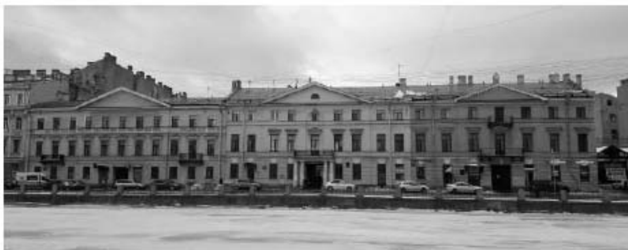
21. Дома Полторацкой С.М. (три). Фонтанки реки наб., д. 97, лит. А. Лицевой фасад. Фото мест установки оборудования и кабельных трасс. Штиглиц М.С. 06.03.2022.
