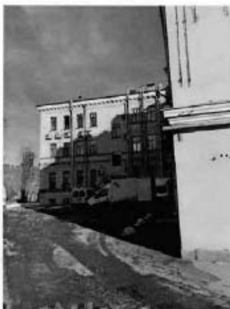
6. Фрагмент объекта культурного наследия с юго-западной стороны.
