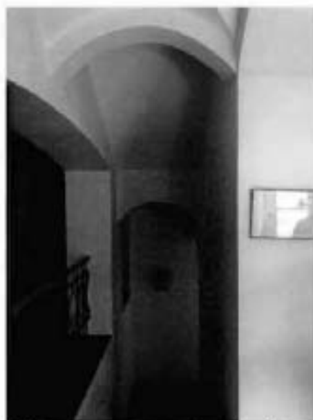
8. Помещение лестничной клетки объекта культурного наследия.
