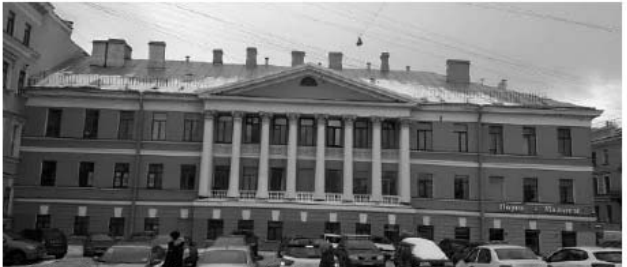
4. Дом Яковлевых (Евментьева А.Ф.). Гороховая ул., д. 57, лит. А. Лицевой фасад. Фото мест установки оборудования и кабельных трасс. Штиглиц М.С. 06.03.2022.
