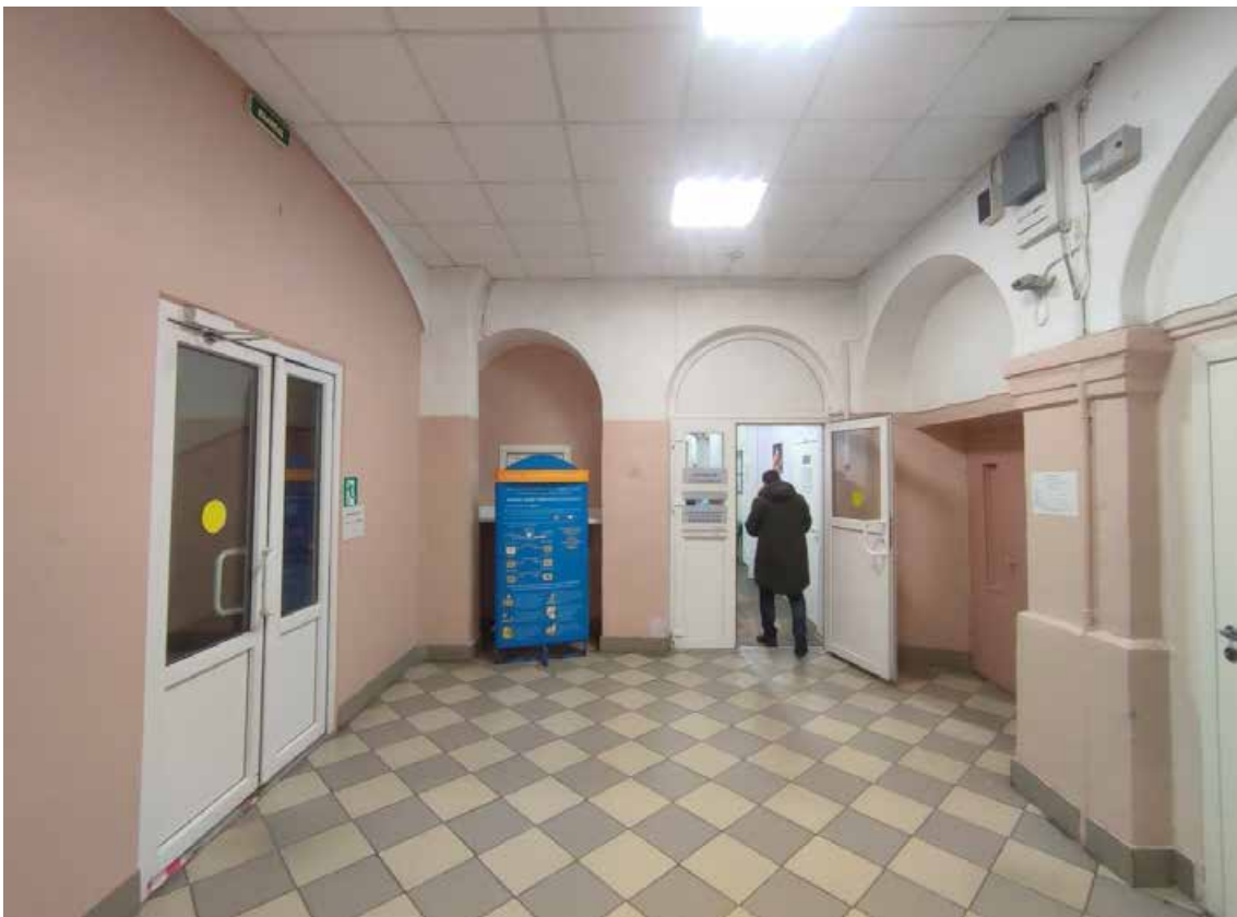
11. Объект культурного наследия регионального значения «Главный корпус Волковской богадельни», расположенный по адресу: г. Санкт-Петербург, набережная реки Волковки, дом 3, литера А. Общий вид пом. 5-Н (36) в уровне 2-го этажа.
