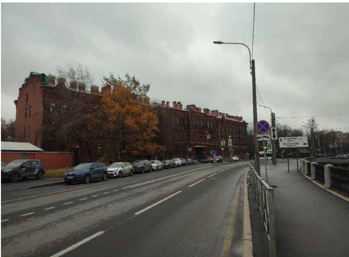
1. Объект культурного наследия регионального значения «Главный корпус Волковской богадельни», расположенный по адресу: г. Санкт-Петербург, набережная реки Волковки, дом 3, литера А. Общий вид объекта с северо-запада.
