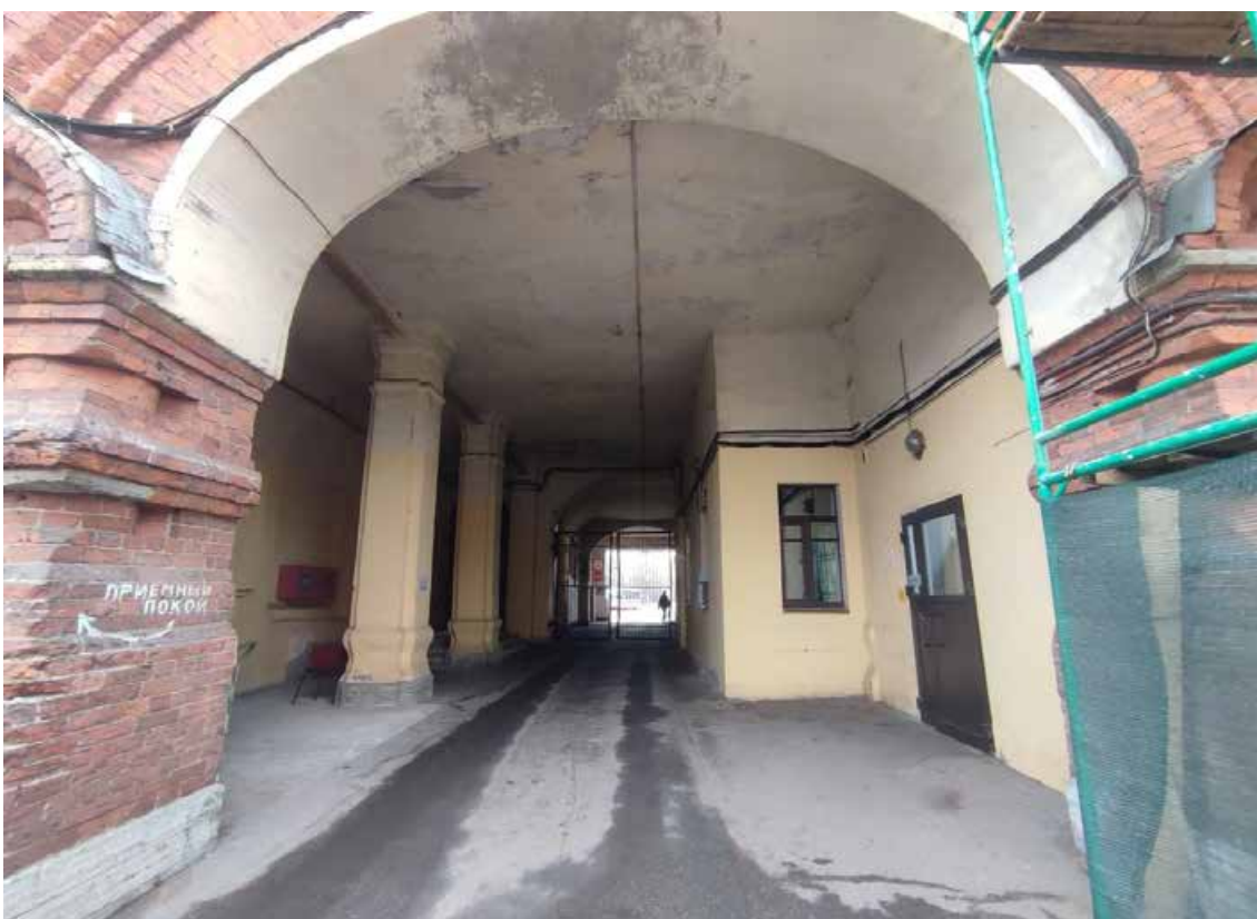
6. Объект культурного наследия регионального значения «Главный корпус Волковской богадельни», расположенный по адресу: г. Санкт-Петербург, набережная реки Волковки, дом 3, литера А. Общий вид воротного проезда со стороны дворовой территории.
