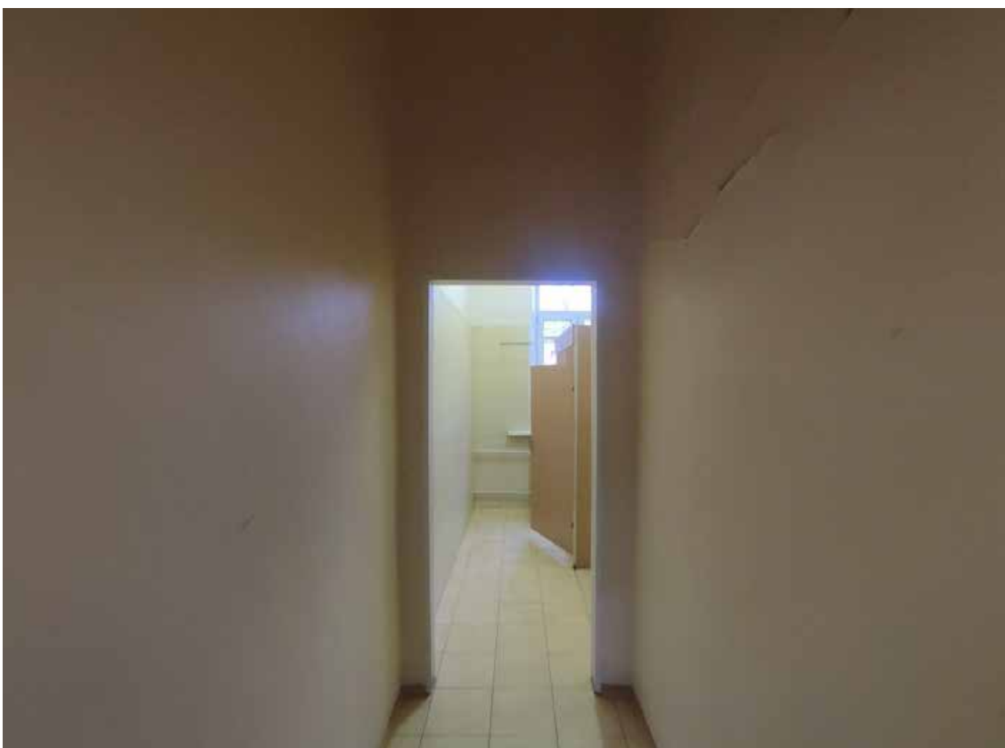
31. Объект культурного наследия регионального значения «Главный корпус Волковской богадельни», расположенный по адресу: г. Санкт-Петербург, набережная реки Волковки, дом 3, литера А. Общий вид пом. 5-Н (6) в уровне 2-го этажа.
