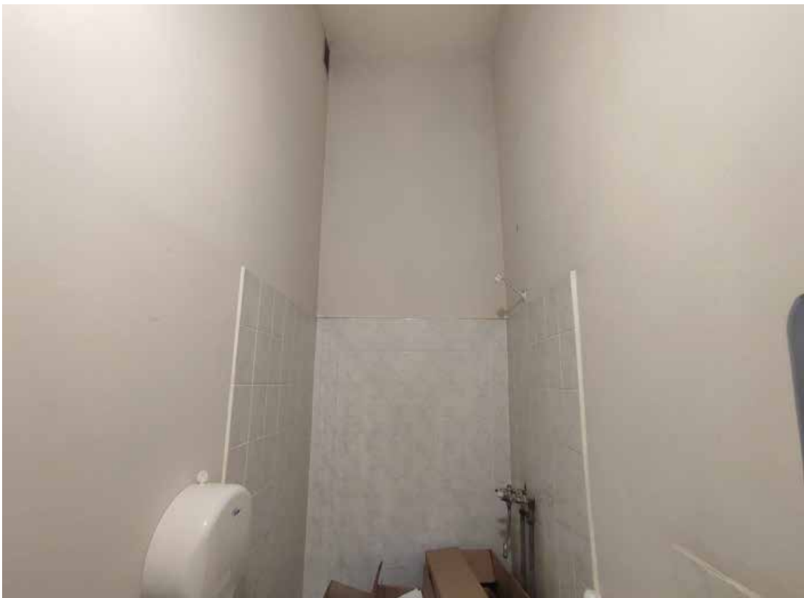
14. Объект культурного наследия регионального значения «Главный корпус Волковской богадельни», расположенный по адресу: г. Санкт-Петербург, набережная реки Волковки, дом 3, литера А. Общий вид пом. 5-Н (45) в уровне 2-го этажа.
