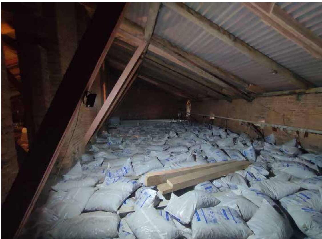
41. Объект культурного наследия регионального значения «Главный корпус Волковской богадельни», расположенный по адресу: г. Санкт-Петербург, набережная реки Волковки, дом 3, литера А. Фрагмент стропильной системы крыши в юго-западной части здания.
