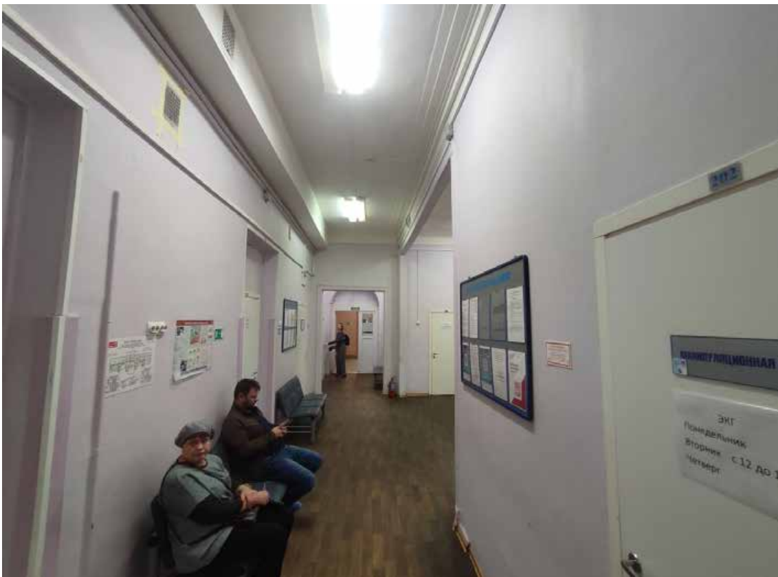
26. Объект культурного наследия регионального значения «Главный корпус Волковской богадельни», расположенный по адресу: г. Санкт-Петербург, набережная реки Волковки, дом 3, литера А. Общий вид пом. 5-Н (28) в уровне 2-го этажа.
