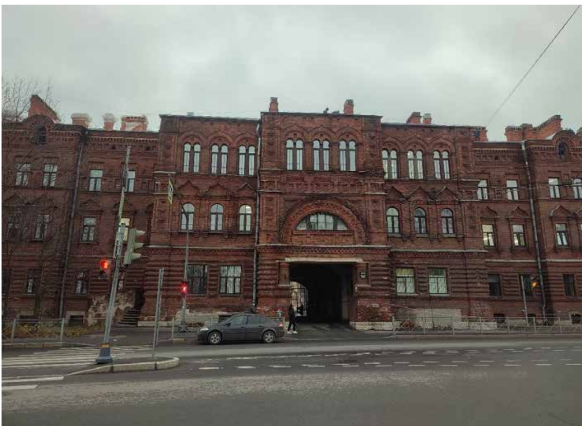
4. Объект культурного наследия регионального значения «Главный корпус Волковской богадельни», расположенный по адресу: г. Санкт-Петербург, набережная реки Волковки, дом 3, литера А. Фрагмент западного лицевого фасада.
