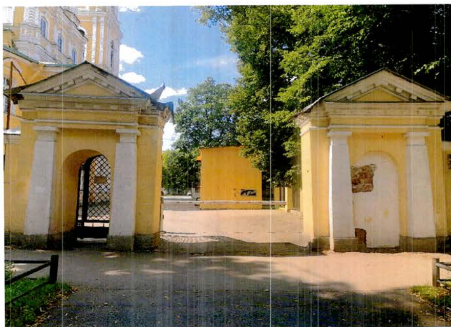
8. Вид на объект культурного наследия с восточной стороны
