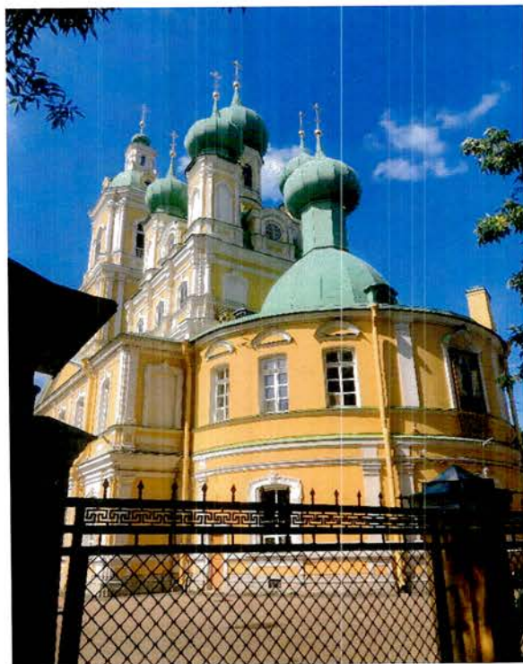
2. Вид на объект культурного наследия с восточной стороны
