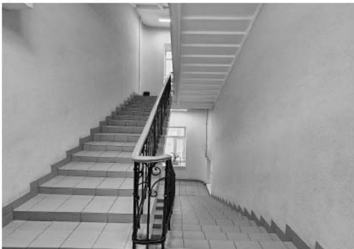
63. Объект культурного наследия регионального значения «Высшие женские естественные курсы и гимназия Лохвицкой-Скалон М.А. Здесь проходила VII (Апрельская) конференция РСДРП (б)», по адресу: г. Санкт-Петербург, Кузнечный переулок, дом 9/27, литера А. Общий вид пом. 1-Н (174) в уровне 4-го этажа – двухмаршевая лестница в центральной части здания.
