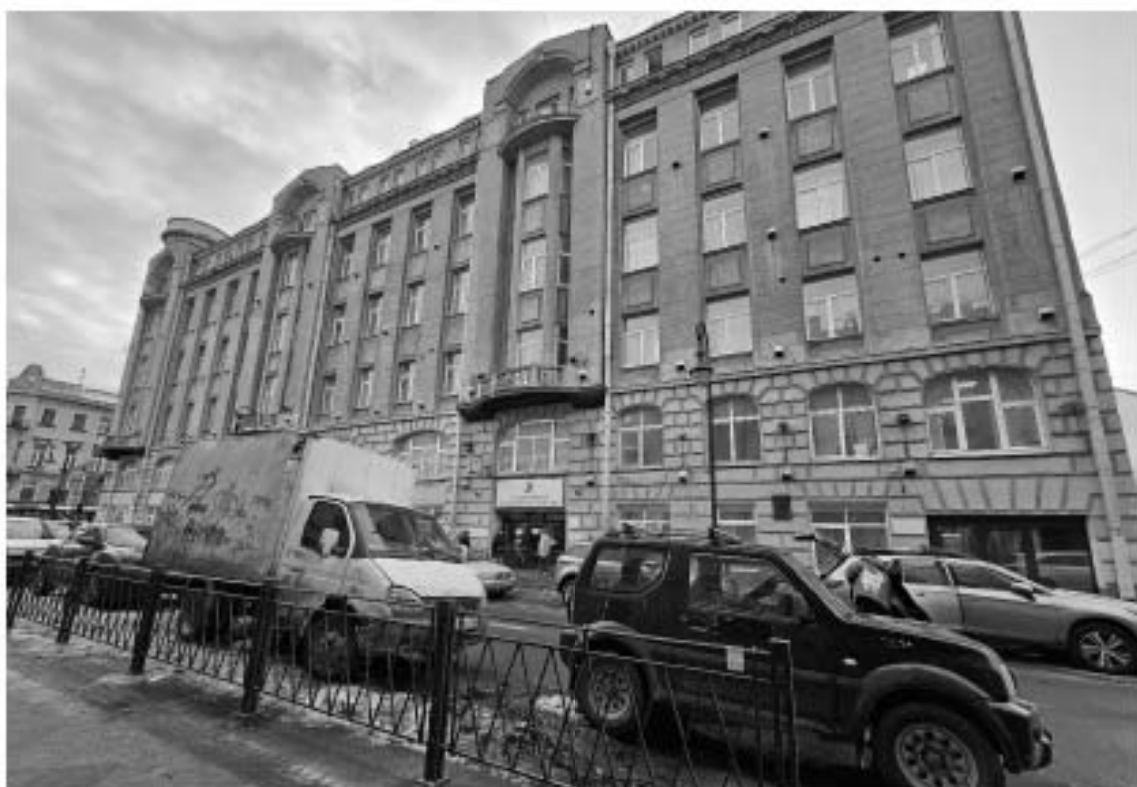
5. Объект культурного наследия регионального значения «Высшие женские естественные курсы и гимназия Лохвицкой-Скалон М.А. Здесь проходила VII (Апрельская) конференция РСДРП (б)», по адресу: г. Санкт-Петербург, Кузнечный переулок, дом 9/27, литера А. Общий вид северного лицевого фасада по Кузнечному переулку.
