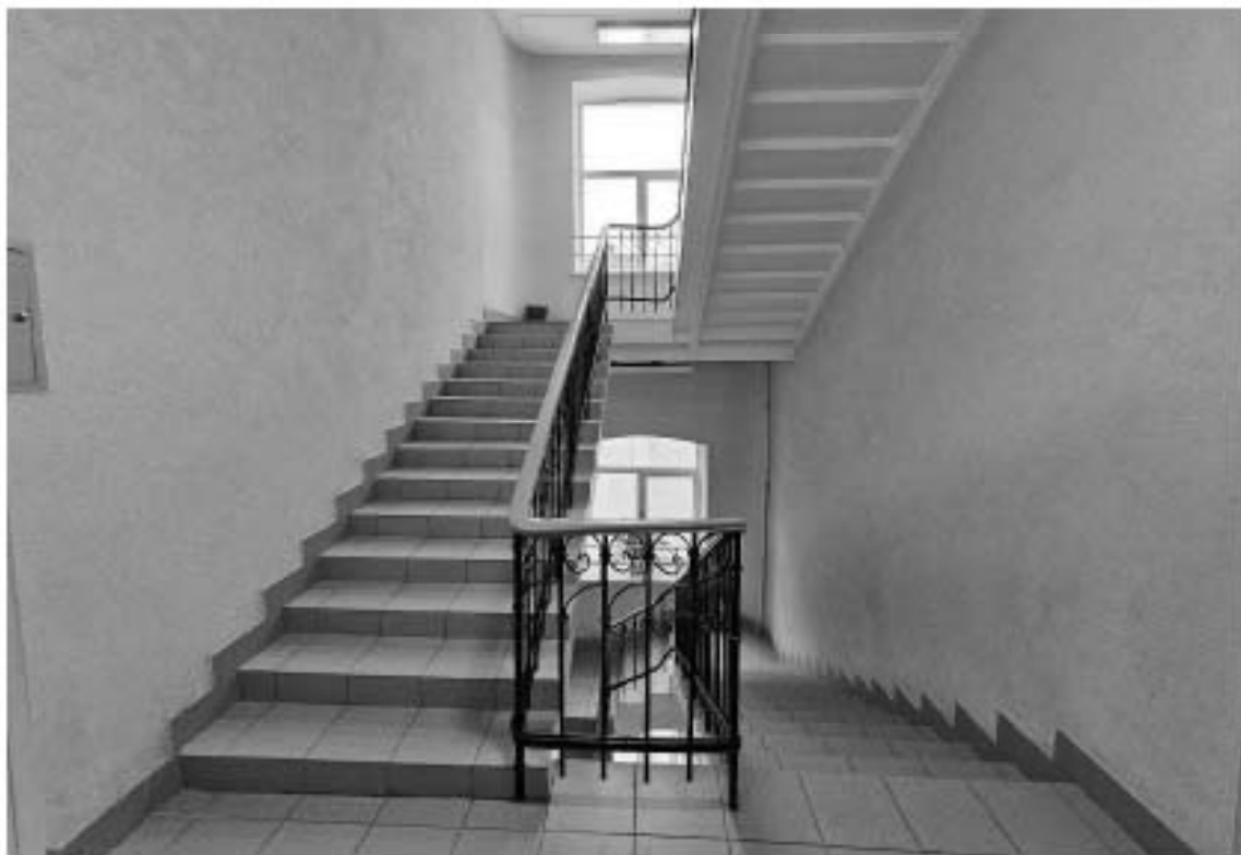
99. Объект культурного наследия регионального значения «Высшие женские естественные курсы и гимназия Лохвицкой-Скалон М.А. Здесь проходила VII (Апрельская) конференция РСДРП (б)», по адресу: г. Санкт-Петербург, Кузнечный переулок, дом 9/27, литера А. Общий вид пом. 1-Н (243) в уровне 6-го этажа – двухмаршевая лестница в центральной части здания.
