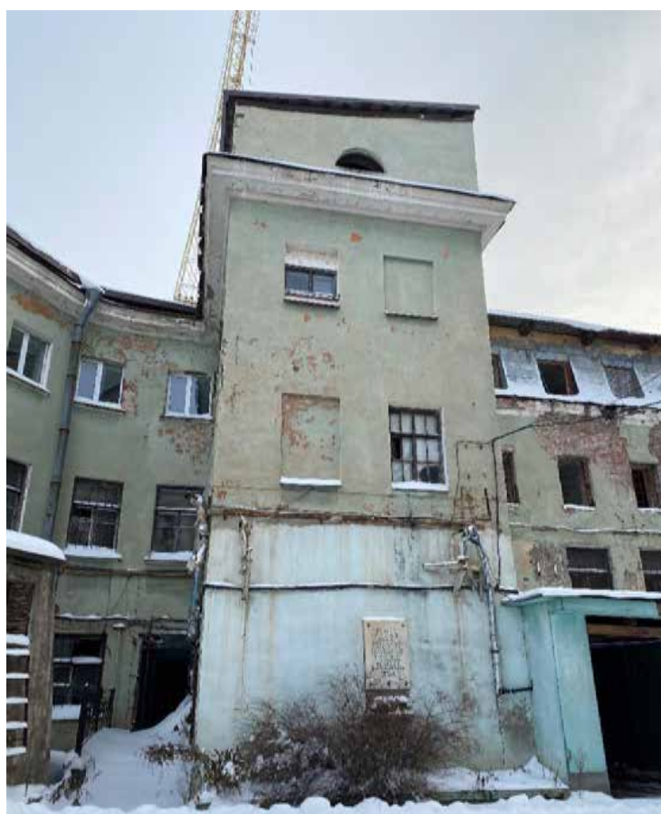
Фото 10. Общий вид фасадов со двора в осях «2'-4'».
