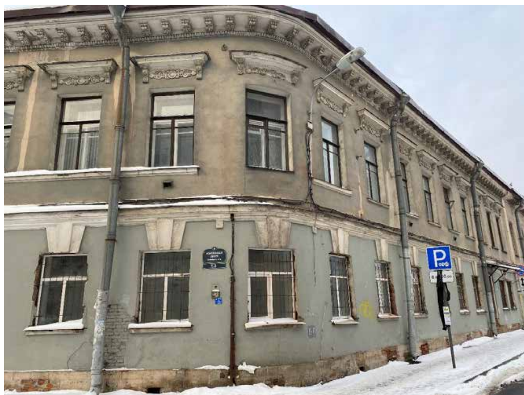
Фото 2. Лицевой фасад «7-1» по Масляному каналу. Общий вид.
