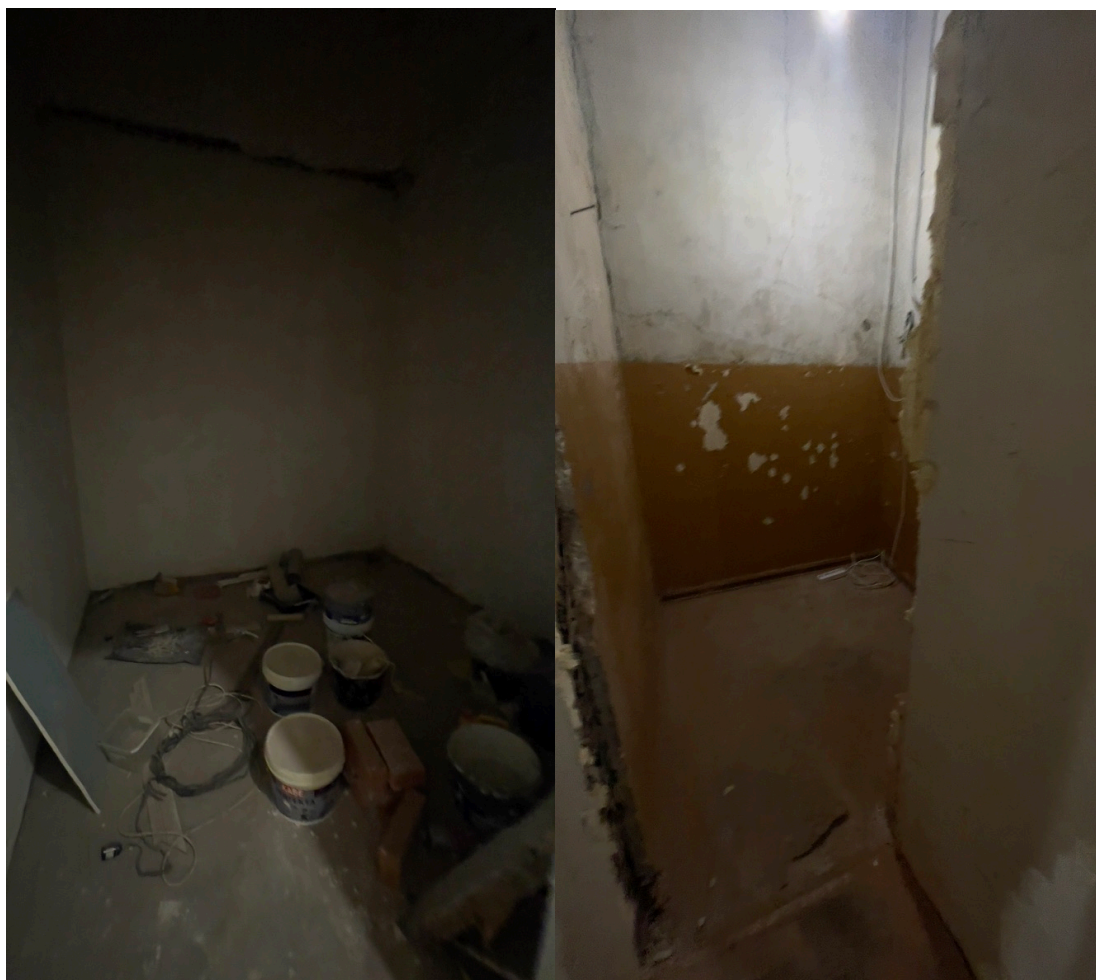
42. Фрагмент интерьера умывальной (помещение 38/7.9);
