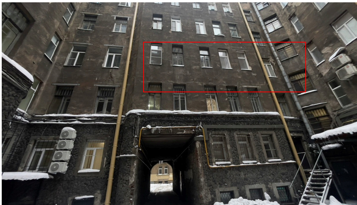
6. Вид на дворовой фасад объекта культурного наследия регионального значения «Доходный дом А.Н.Перцова», расположенного по адресу: г. Санкт-Петербург, Лиговский проспект, дом 44, литера Б (Лиговский пр., 44) и окна квартиры;
