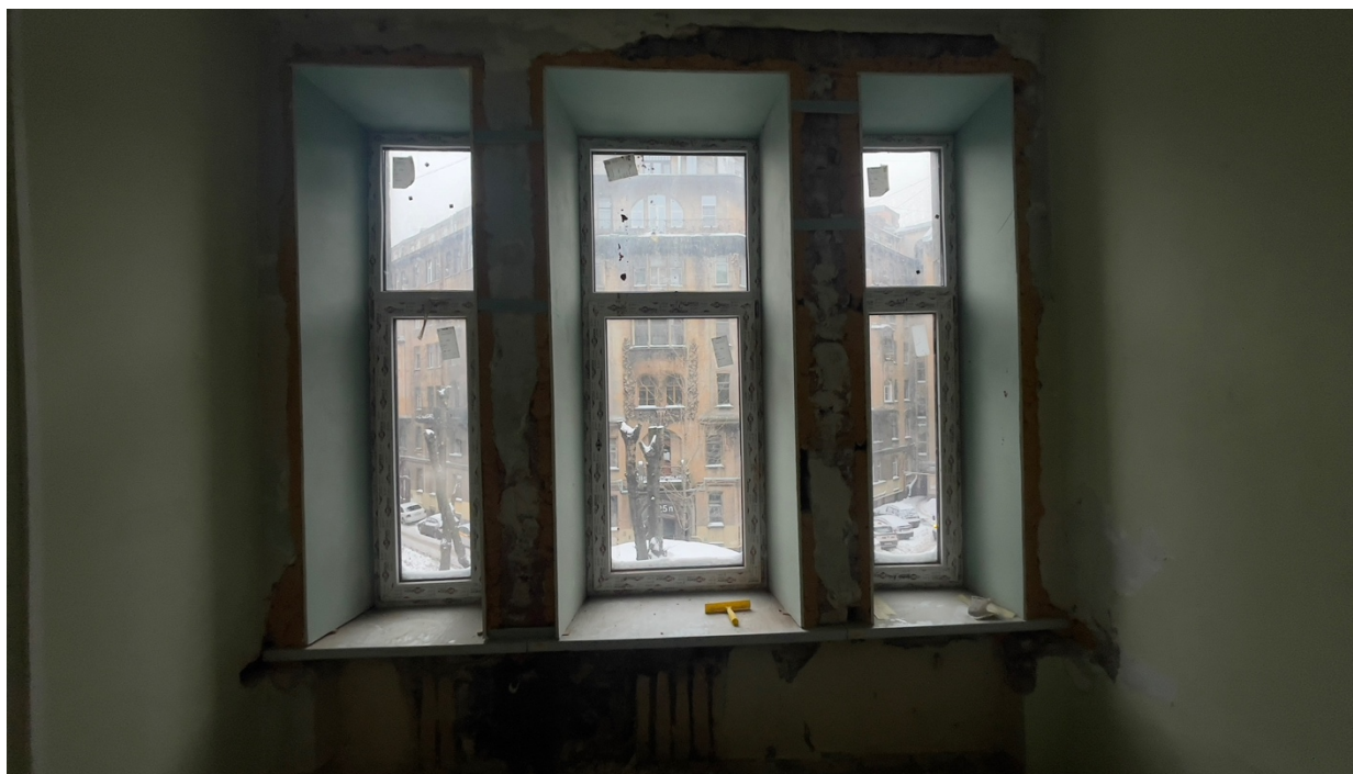
26. Фрагмент оконного заполнения (помещение 21/22.6);
