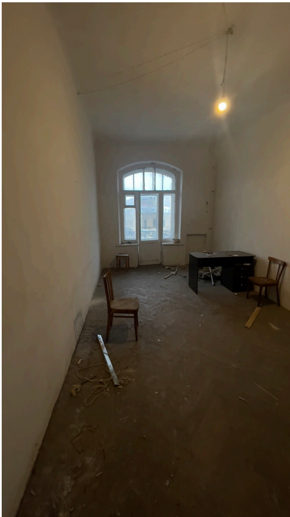
46. Фрагмент интерьера комнаты (помещение 33/22.9);
