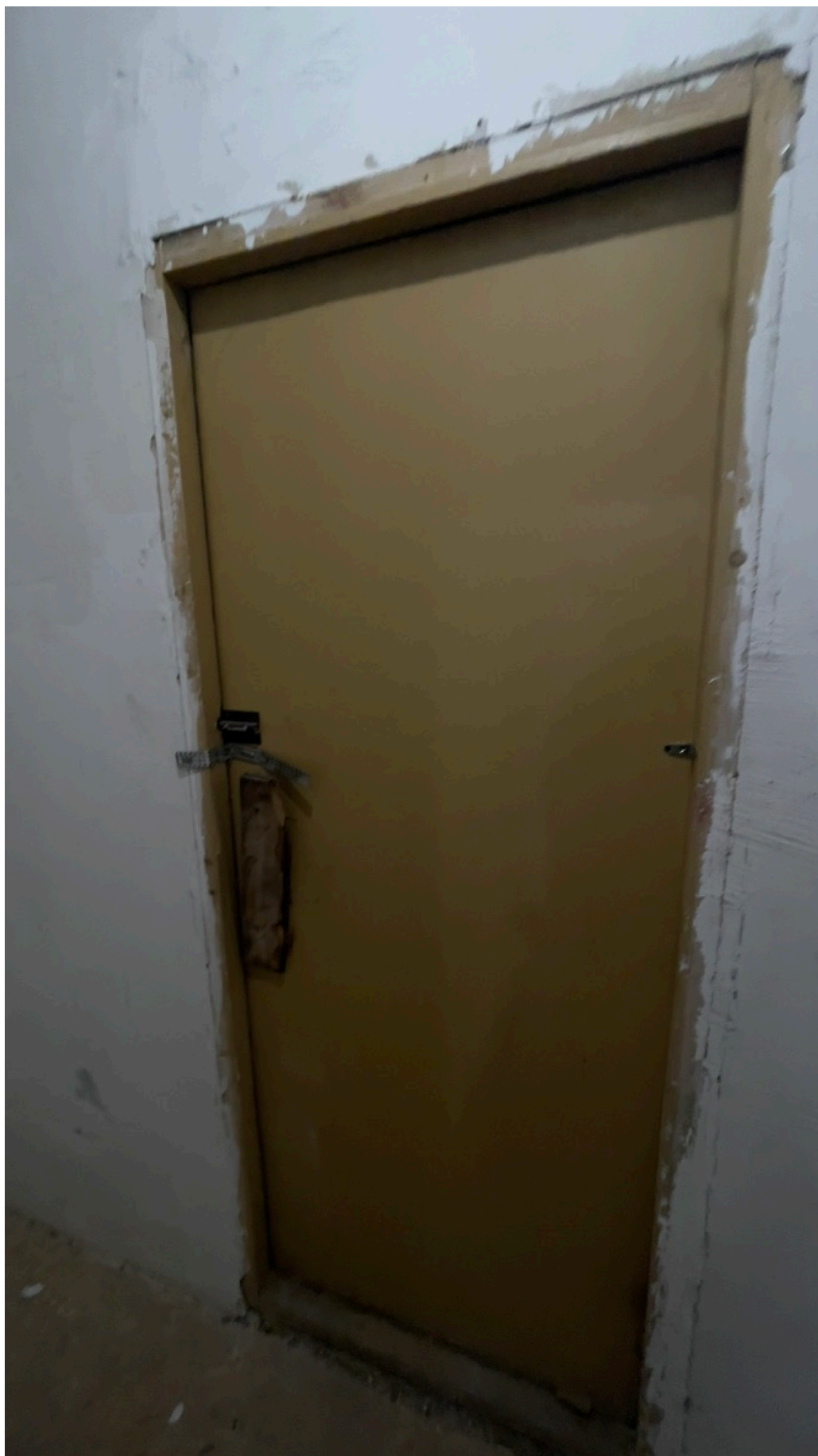
36. Вид на входную дверь в квартире;
