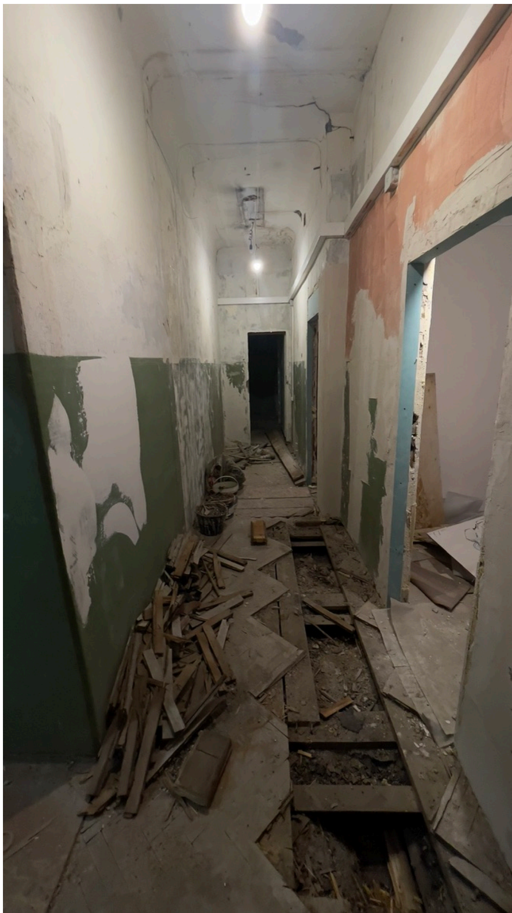
18. Фрагмент интеръера коридора (помещение 5/5.6; 5/5);
