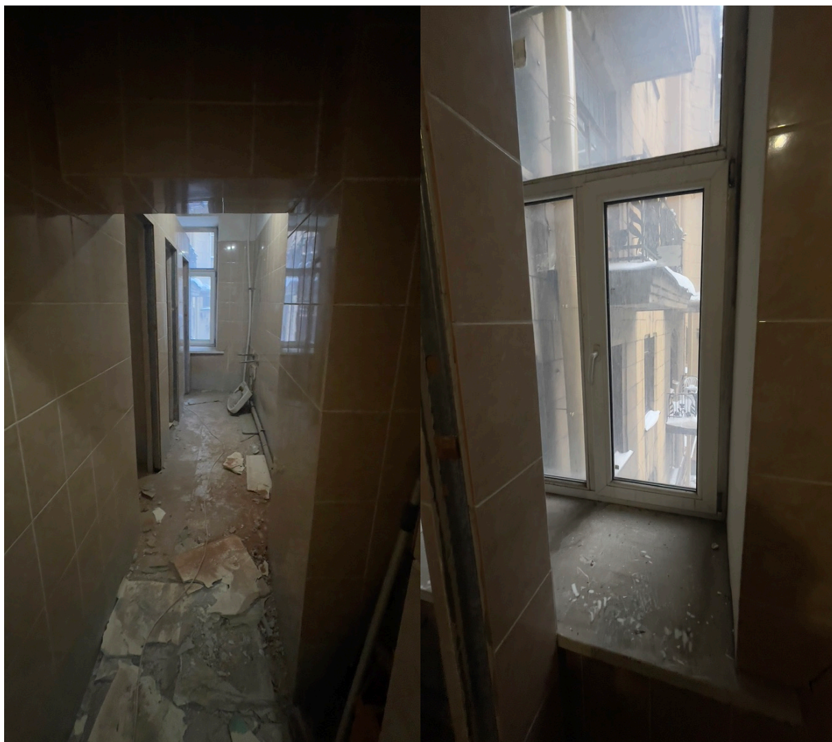
16. Фрагмент интерьера туалета (помещение 9/9.6);
