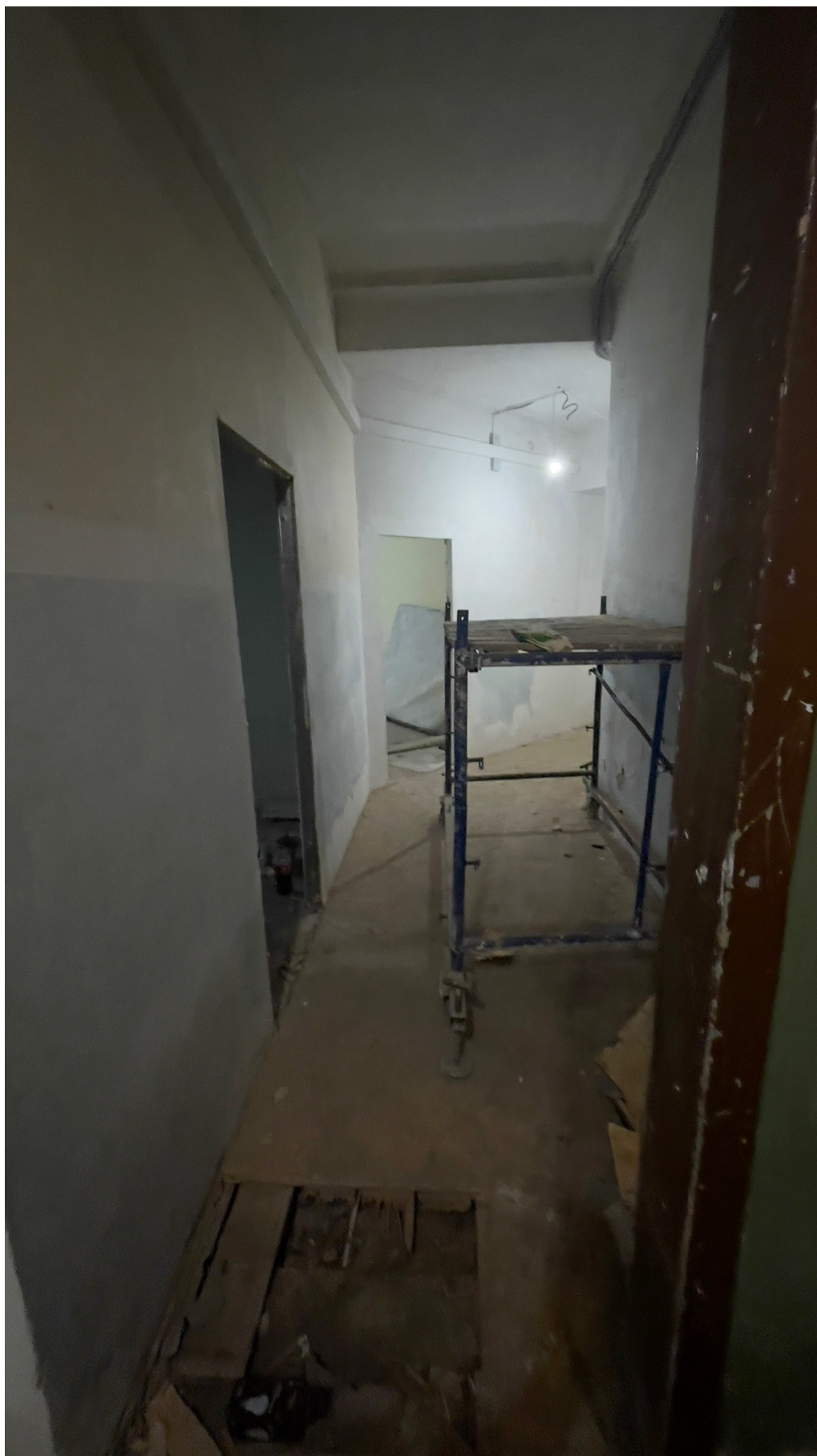
27. Фрагмент интерьера коридора (помещение 1/88.6);
