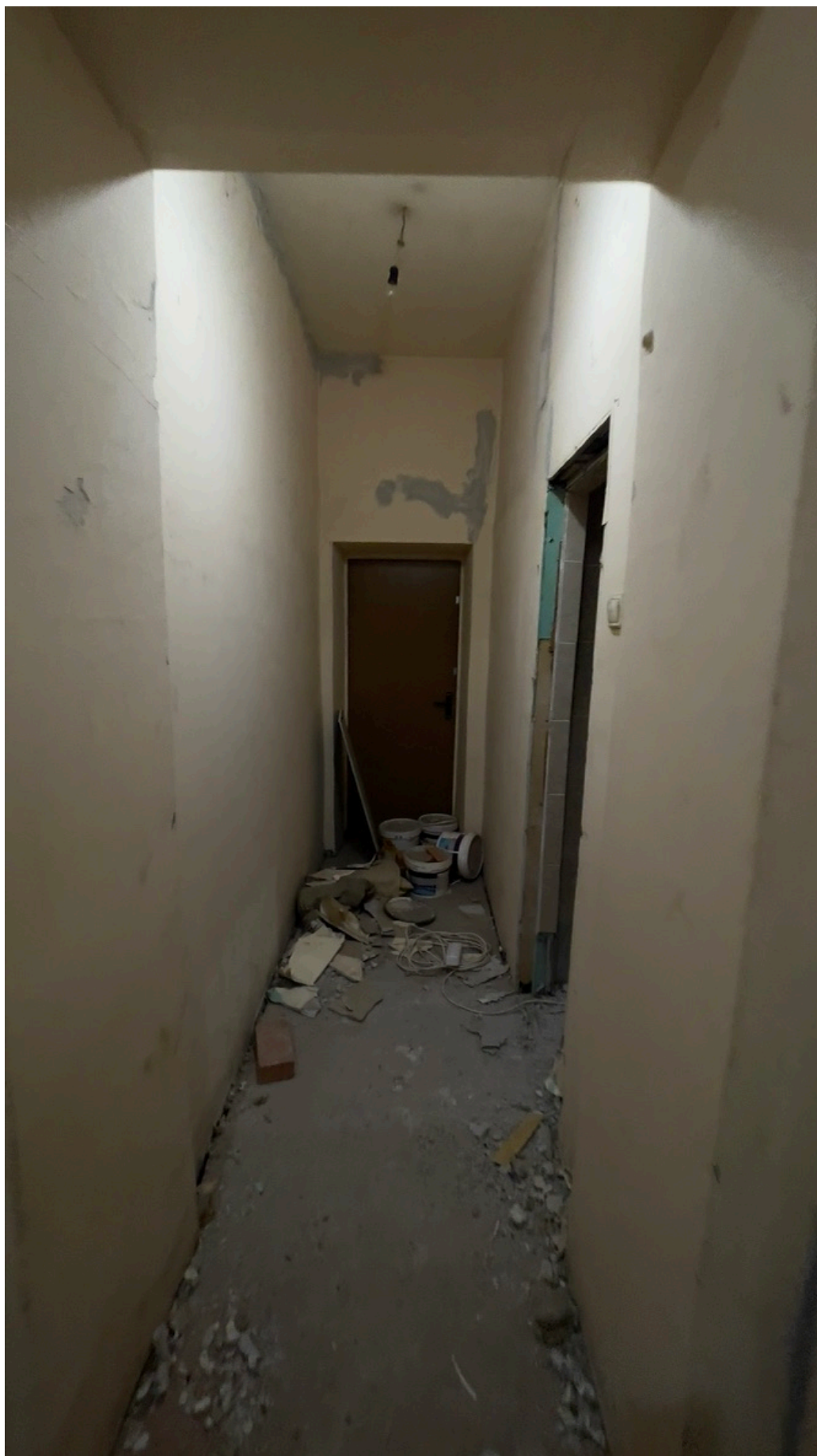
17. Фрагмент интерьера коридора (помещение 8/2.9);
