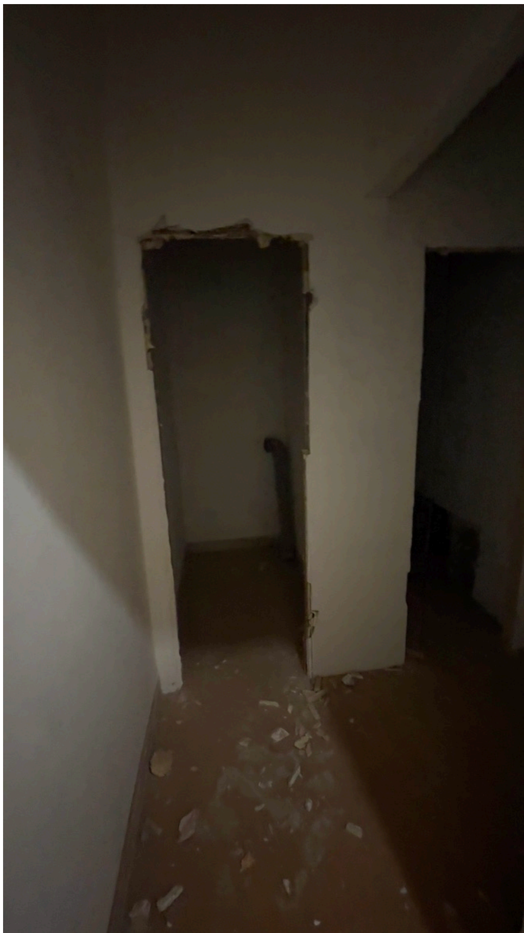
41. Фрагмент интерьера туалета (помещение 39;40;41);
