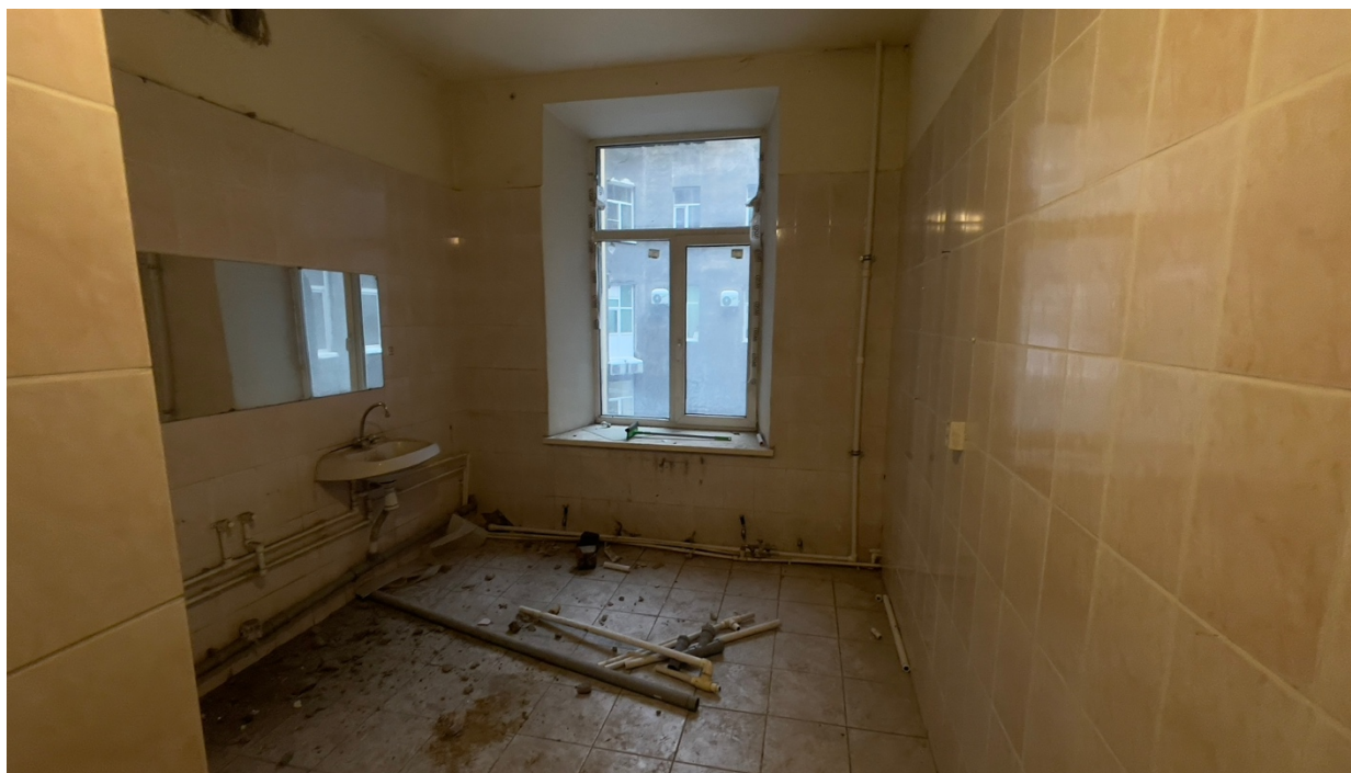
33. Фрагмент интерьера туалета (помещение 12/15.5);
