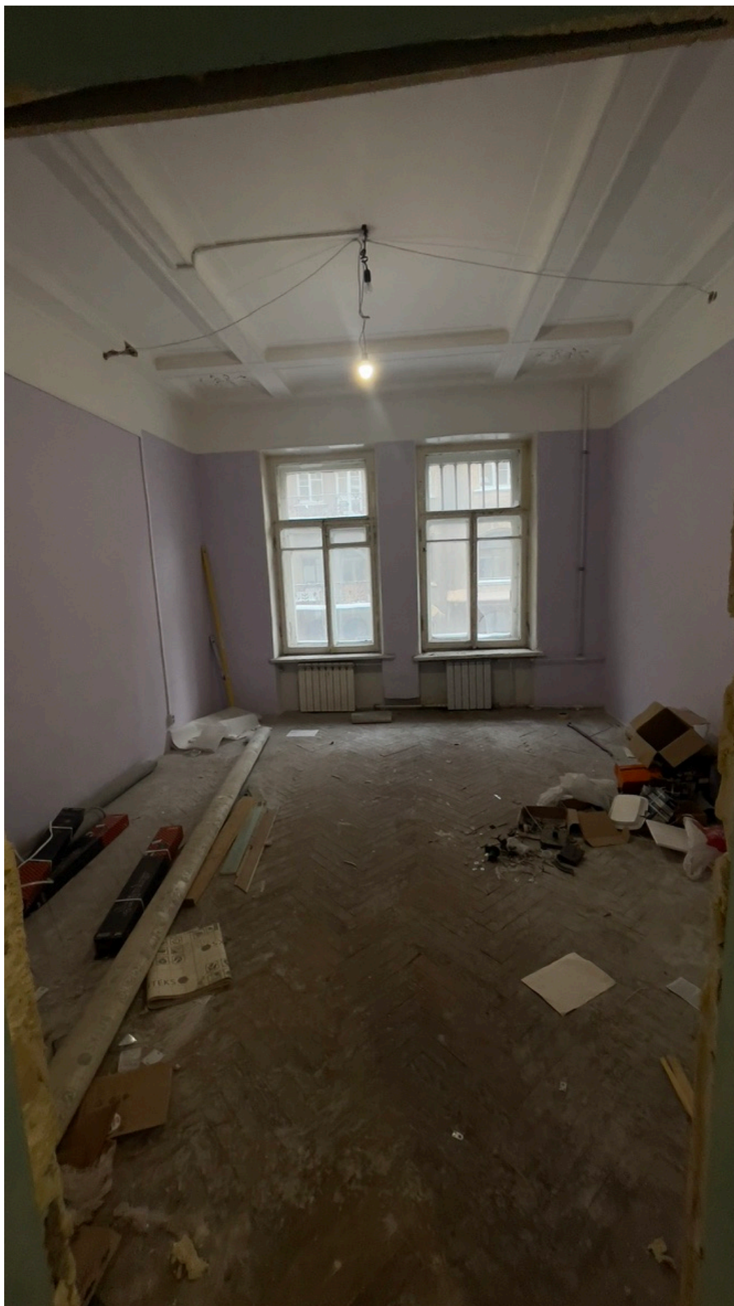
11. Фрагмент интерьера комнаты (помещение 18/23.4);
