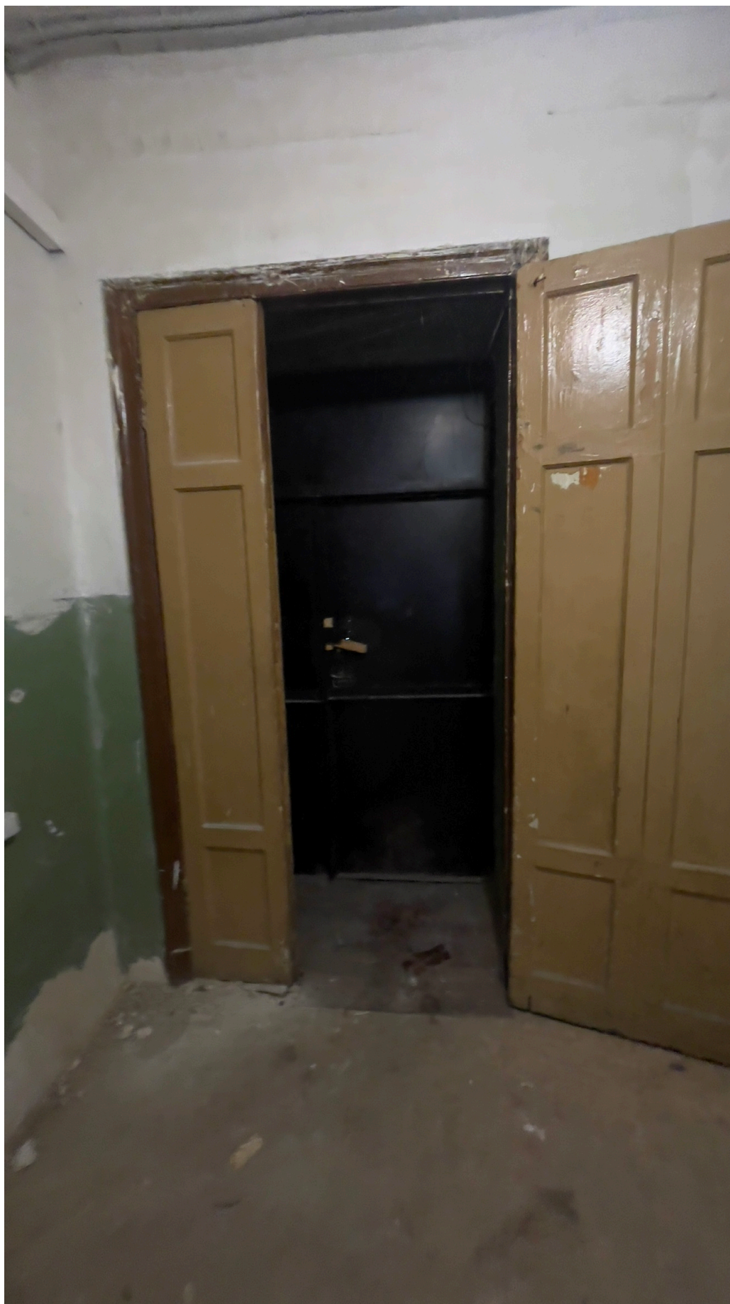
25. Вид на входную дверь в квартире;
