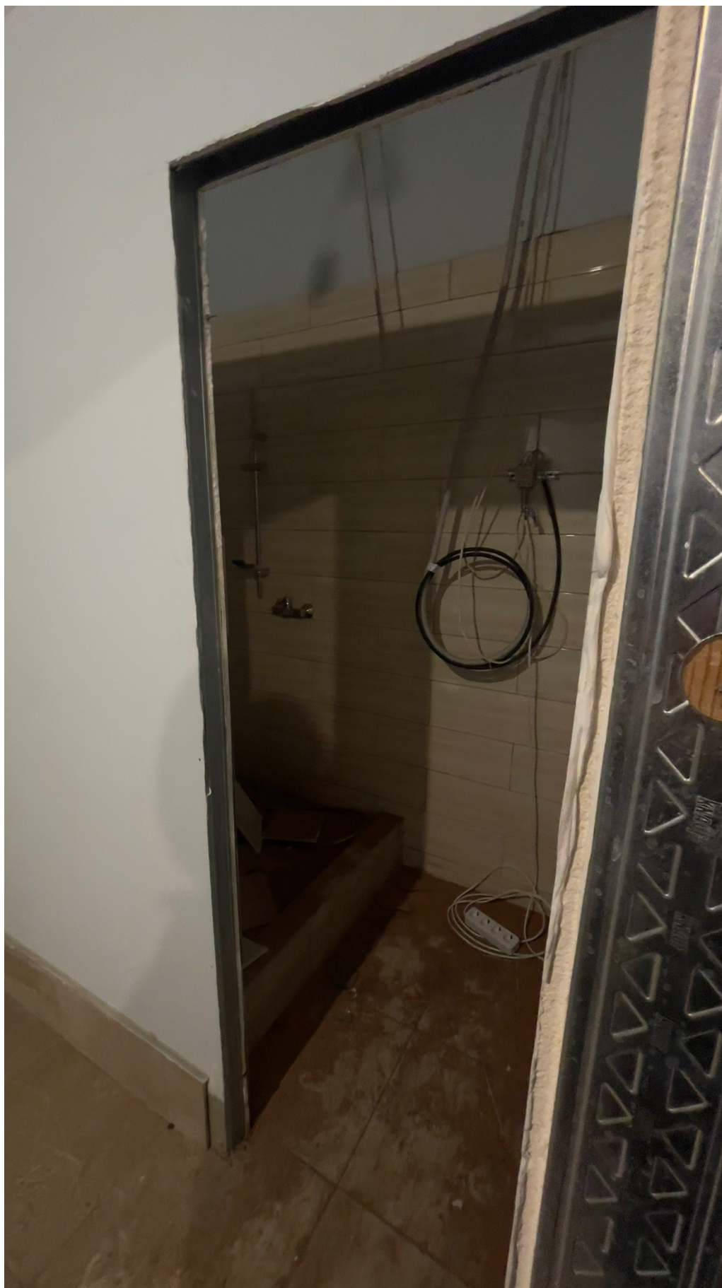
34. Фрагмент интерьера душевой (помещение 15/7.9);
