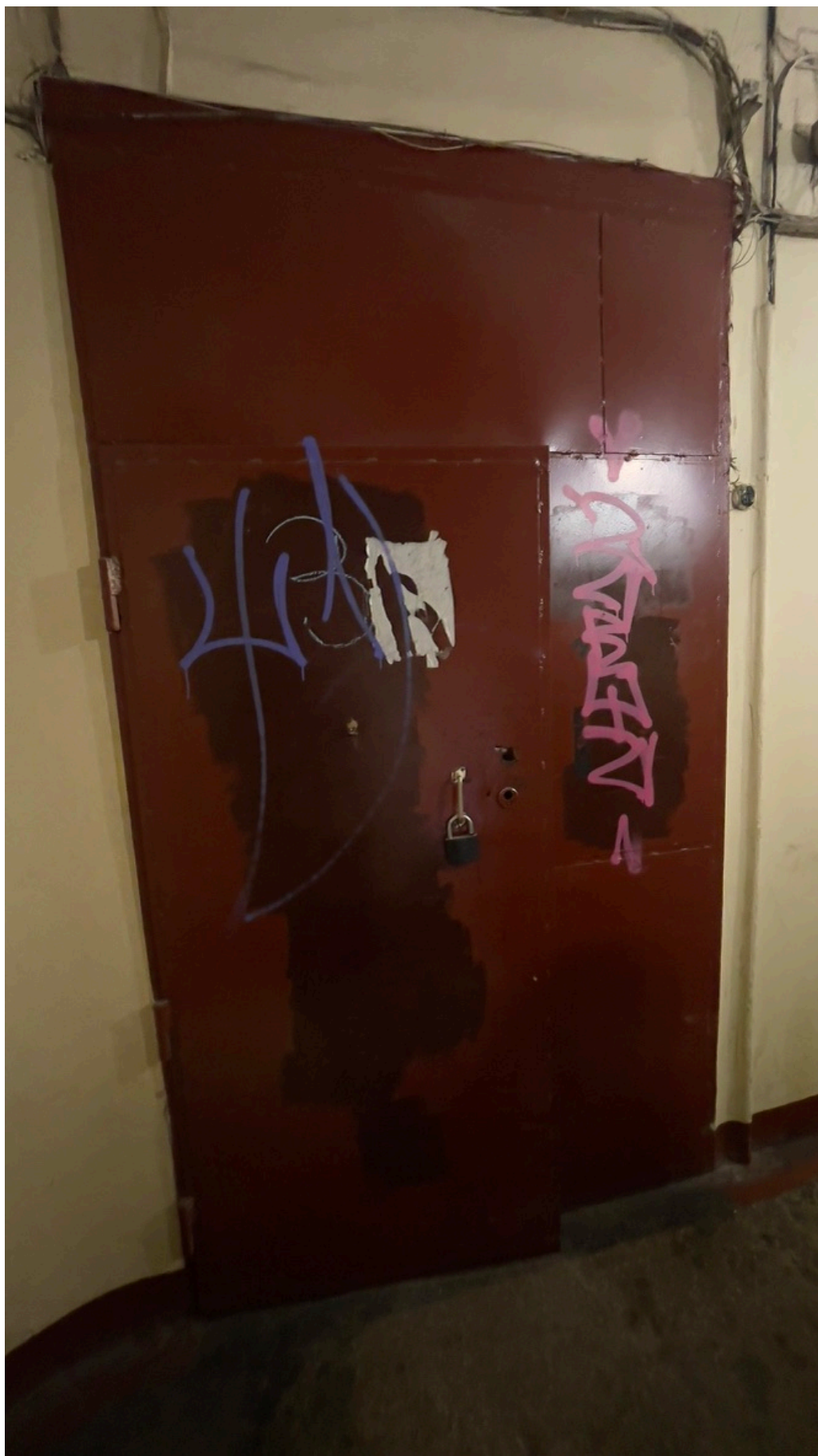
9. Вид на входную дверь в квартиру;
