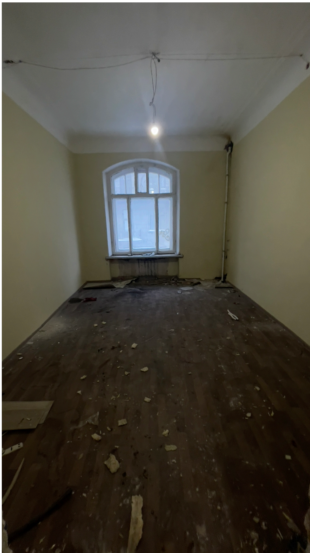
35. Фрагмент интерьера комнаты (помещение 26/19.7);
