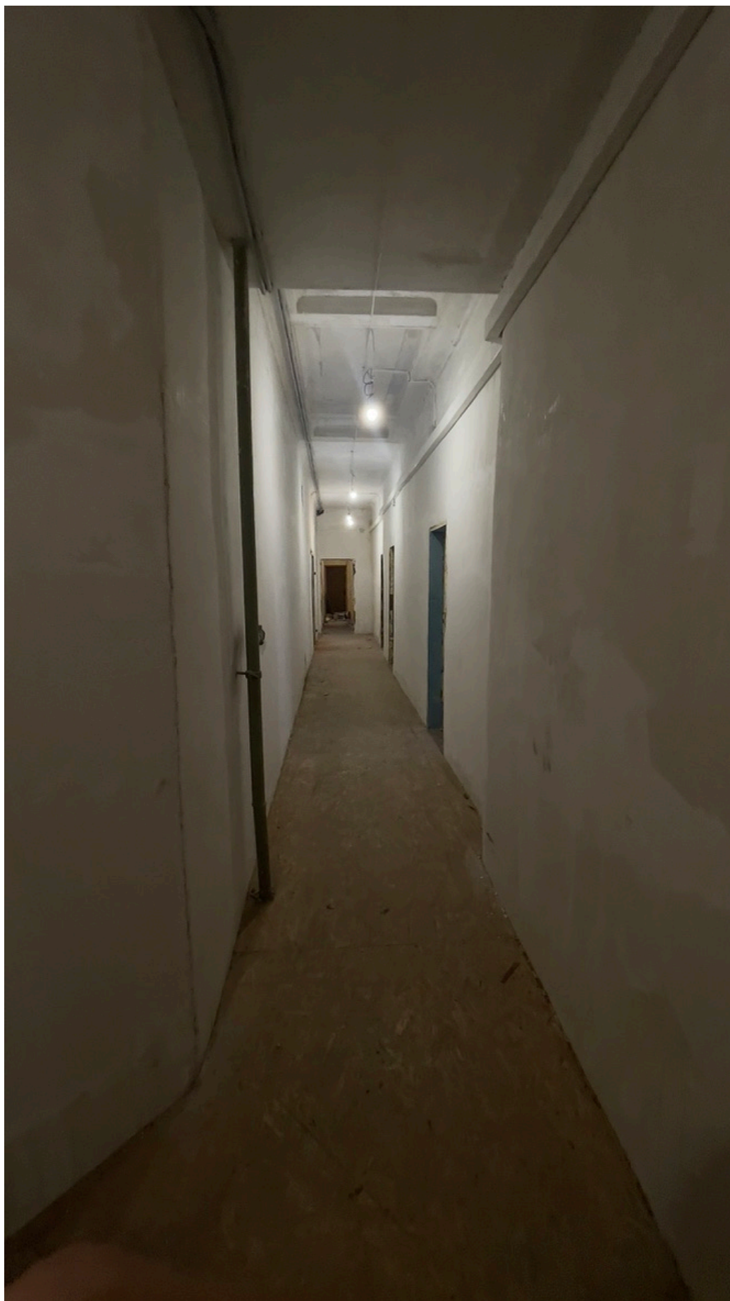
10. Фрагмент интеръера коридора (помещение 1/88.6);
