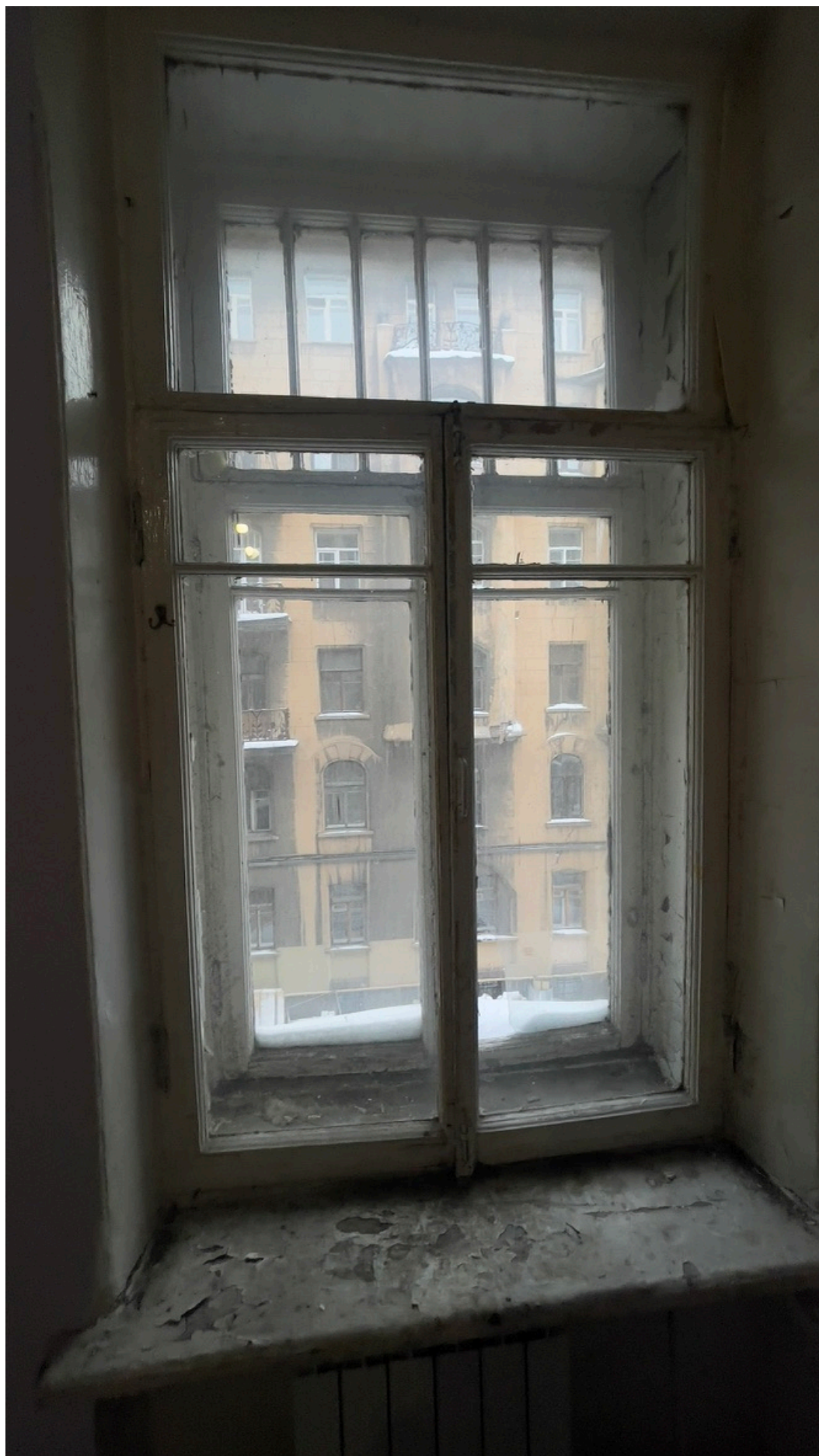
12. Вид на оконное заполнение (помещение 18/23.4);
