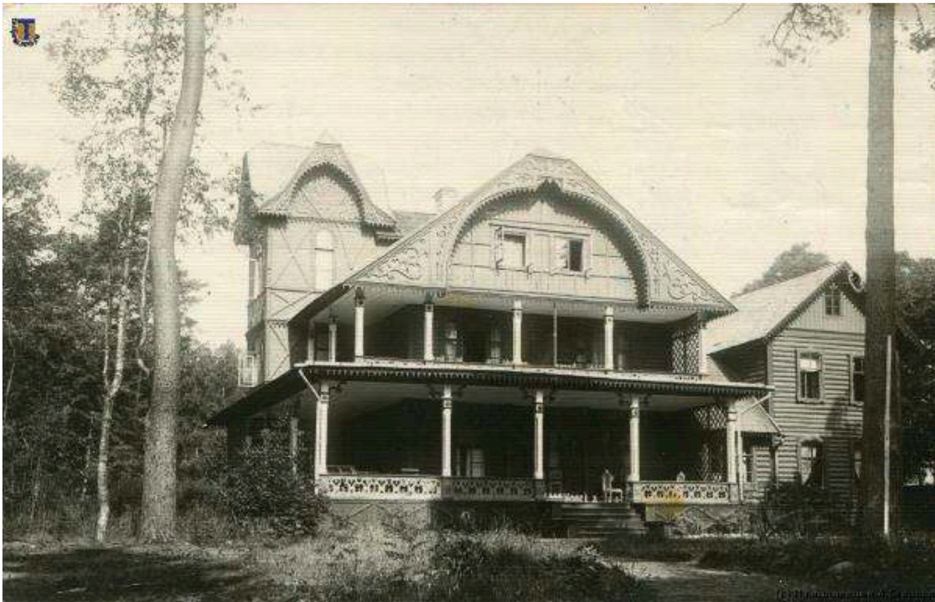
11. Вилла Мюзера на его участке в Терийоках на Микконкату (Театральная ул., 7). Не сохранилась. // Источник: Из коллекции А. Старкова. Электронный ресурс: Зеленогорск СПб: История и современность. URL: https://terijoki.spb.ru/photos/picture.php?/105710/category/3448 . Дата обращения: 13.02.2024.
