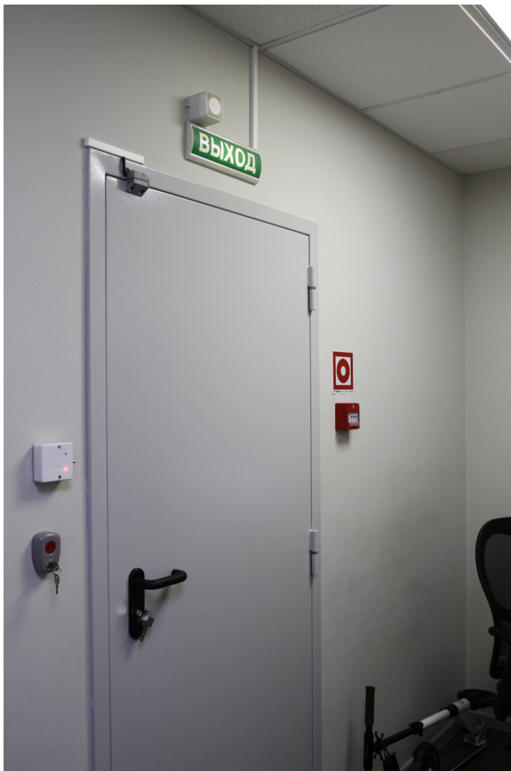
24. “Дом И.Л.Логина ”. СПб, Невский пр., д.61, литера А (Невский пр., д.61). Фрагмент интерьера пом. 1-Н. Фото: 26.01.2024 г.
