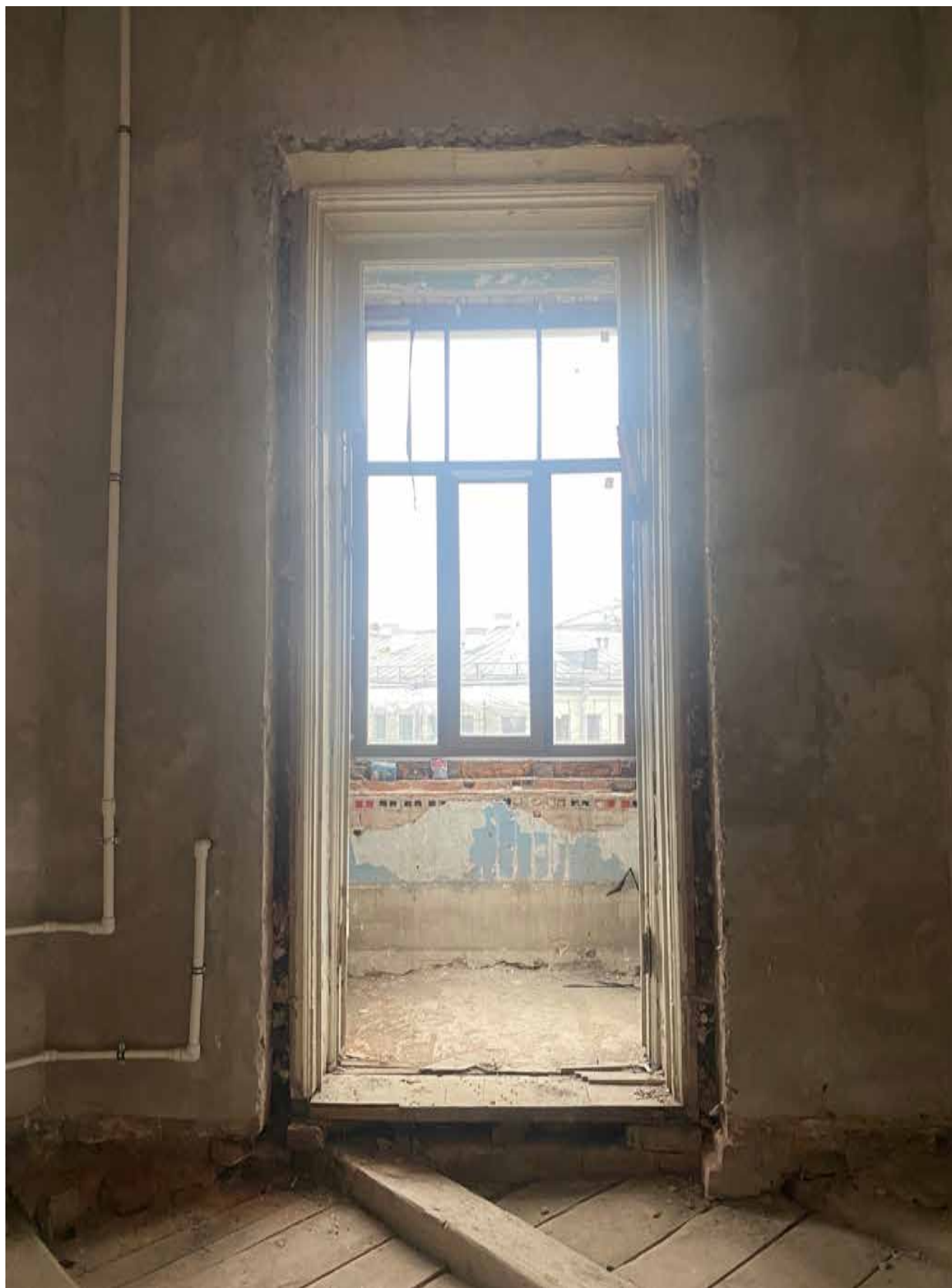
9. Фрагмент интерьера комнаты (помещение 3/16.7; 21/11.1; 22; 4/20);
