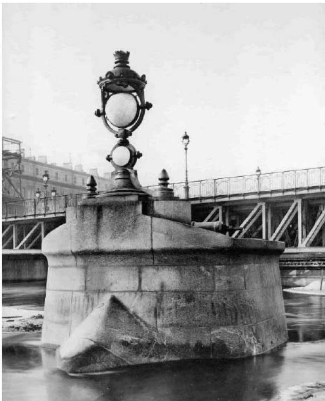
Илл. 30. Аванпостная опора (бык-ледорез) перед опорой разводного пролета. До 1903 г. (источник: Троицкий мост. 115 лет. СПб., 2018. С. 71).
