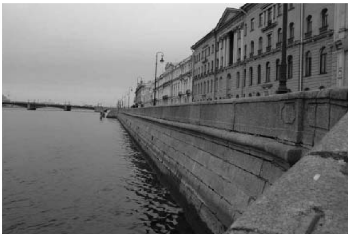
Фото 33. Вид на объект культурного наследия федерального значения «Набережная» на участке набережной реки Невы «Троицкий мост – Эрмитажный мост», литера Б (подпорная стенка от спуска № 3 в сторону спуска № 4).
