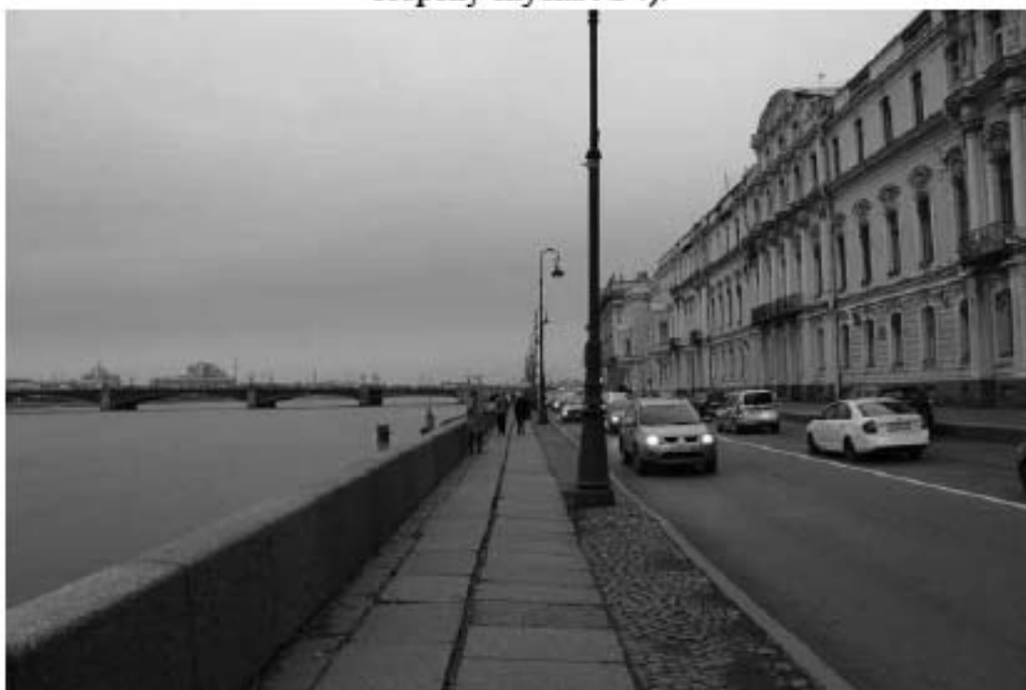
Фото 36. Вид на объект культурного наследия федерального значения «Набережная» на участке набережной реки Невы «Троицкий мост – Эрмитажный мост», литера Б (пешеходная часть набережной от спуска № 3 в сторону спуска № 4).
