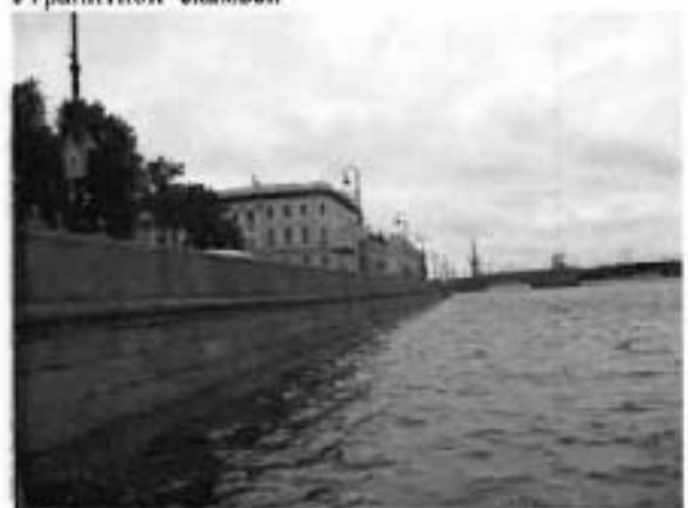
5. Вид стенки набережной от спуска у Летнего сада в сторону Троицкого (Кировского) моста
