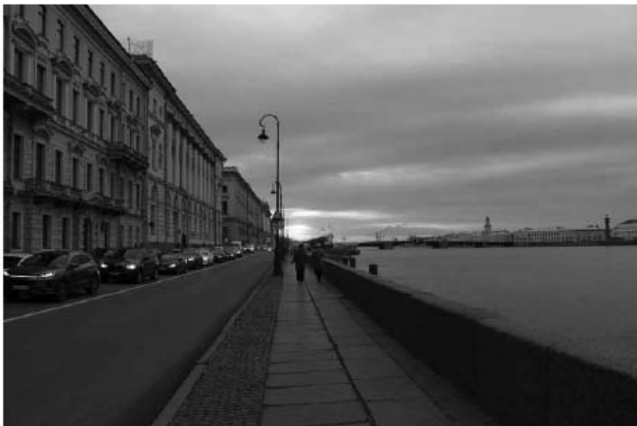
Фото 15. Вид на объект культурного наследия федерального значения «Набережная» на участке набережной реки Невы «Троицкий мост – Эрмитажный мост», литера Б (пешеходная часть набережной от спуска № 2 в сторону спуска № 1).
