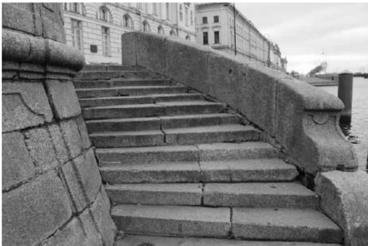
Фото 7. Вид на объект культурного наследия федерального значения «Спуски лестничные» на участке набережной реки Невы «Троицкий мост – Эрмитажный мост», литера Б (1-й спуск с запада).
