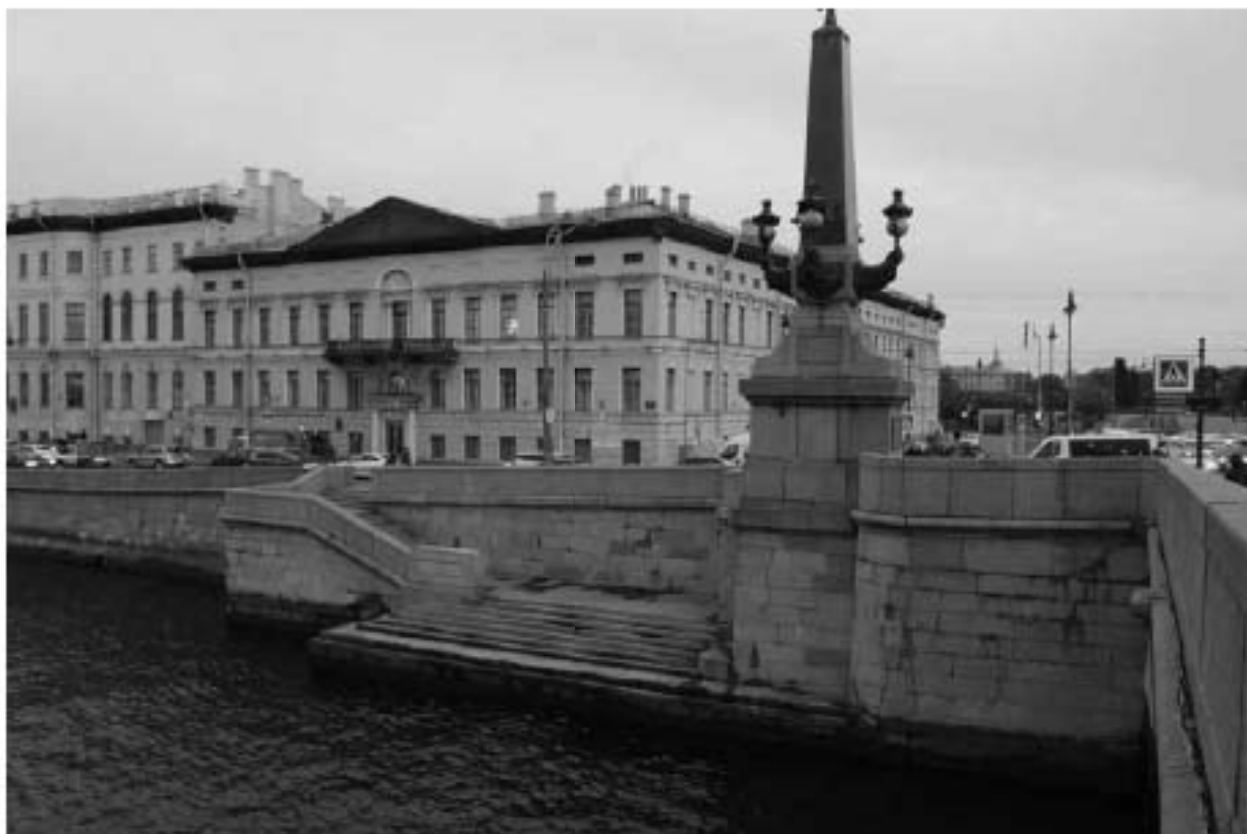
Фото 67. Вид на восточный спуск на южном берегу объекта культурного наследия регионального значения «Кировский мост».
