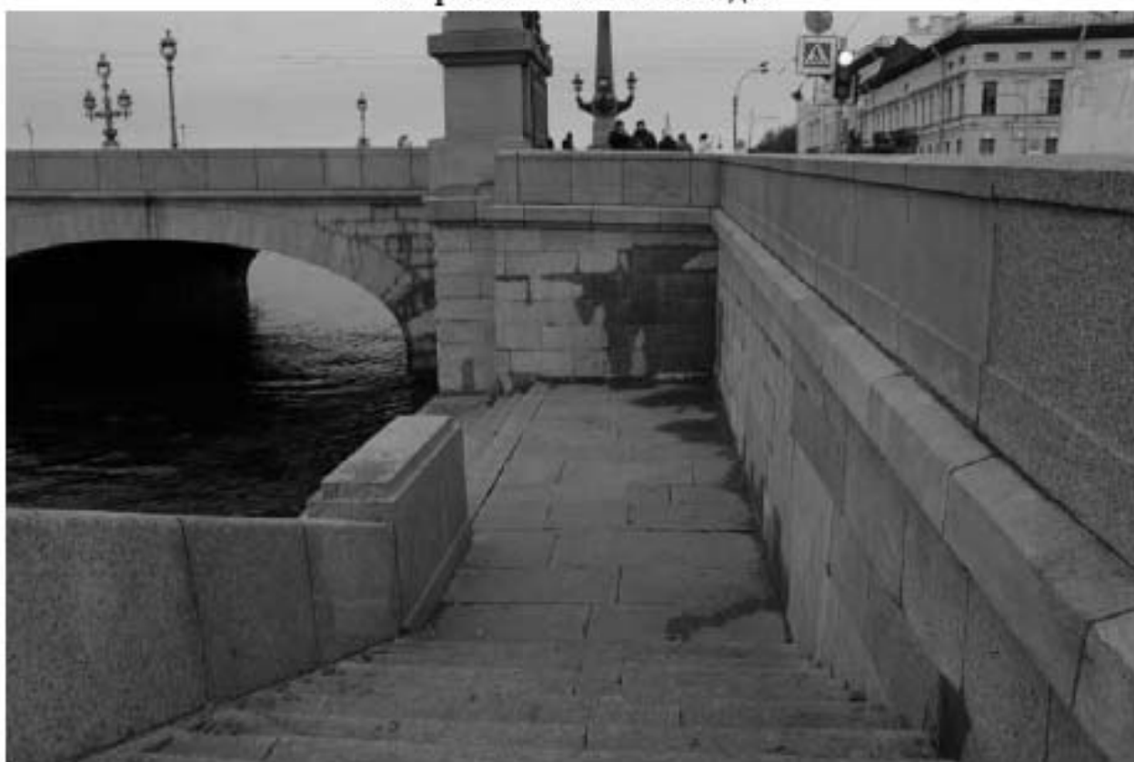
Фото 58. Вид на западный спуск на южном берегу объекта культурного наследия регионального значения «Кировский мост».
