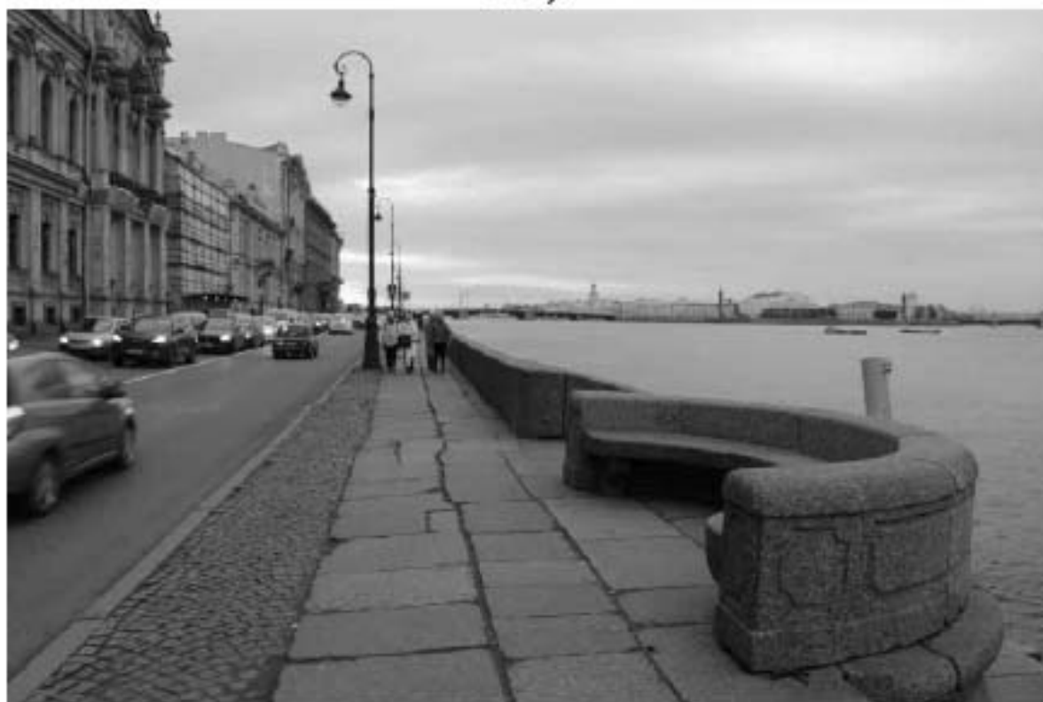
Фото 34. Вид на объект культурного наследия федерального значения «Набережная» на участке набережной реки Невы «Троицкий мост – Эрмитажный мост», литера Б (пешеходная часть набережной от спуска № 3 в сторону спуска № 2).
