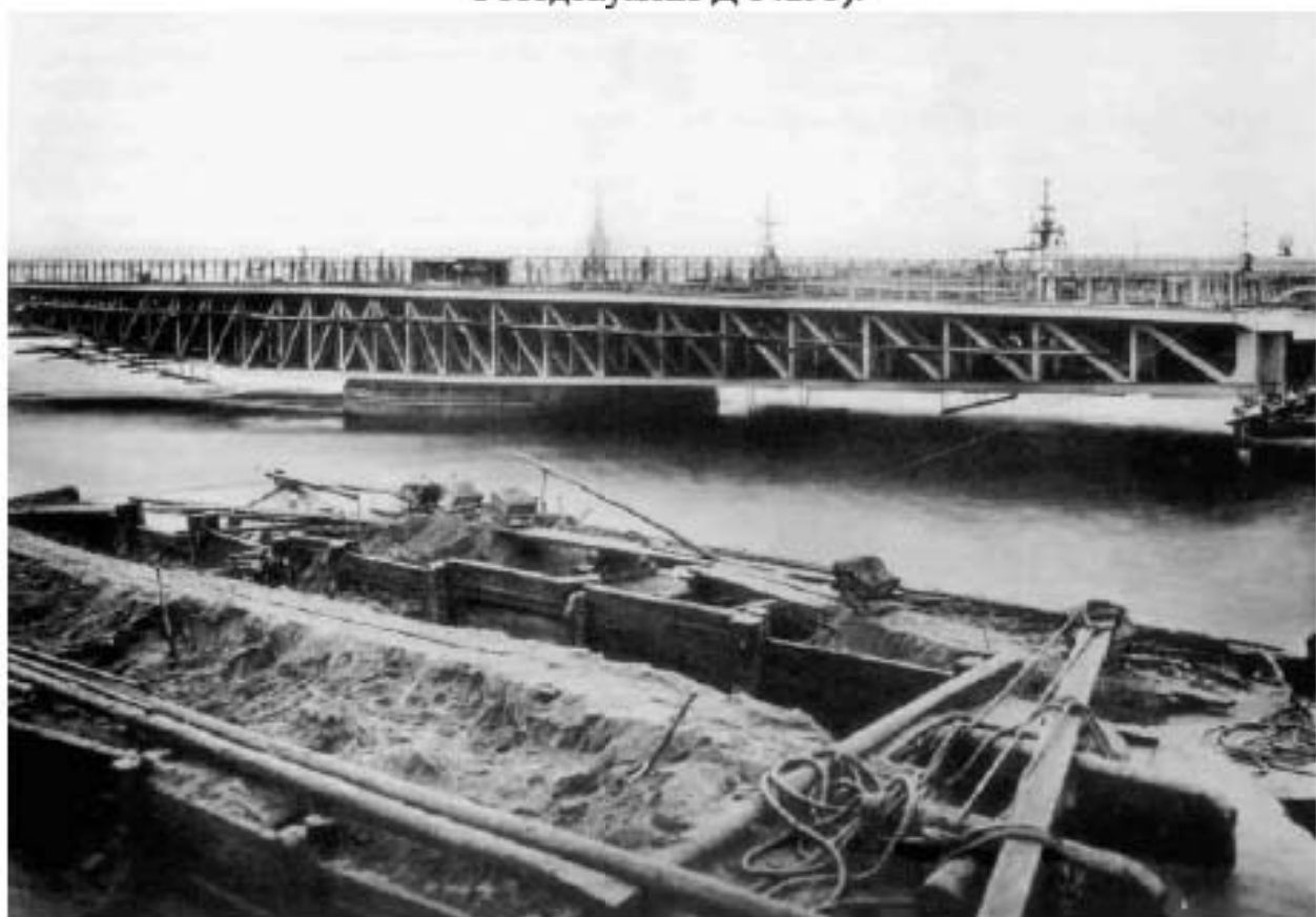
Илл. 28. Разводное пролетное строение Троицкого моста. До 1903 г. (источник: Троицкий мост. 115 лет. СПб., 2018. С. 68).
