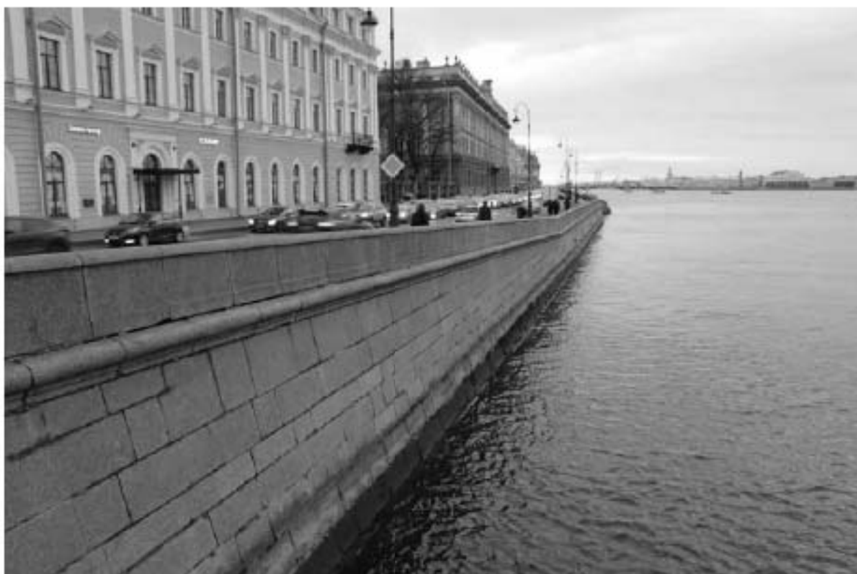
Фото 59. Вид на объект культурного наследия федерального значения «Набережная» на участке набережной реки Невы «Троицкий мост – Эрмитажный мост», литера Б (подпорная стенка от объекта культурного наследия регионального значения «Кировский мост» в сторону спуска № 5).
