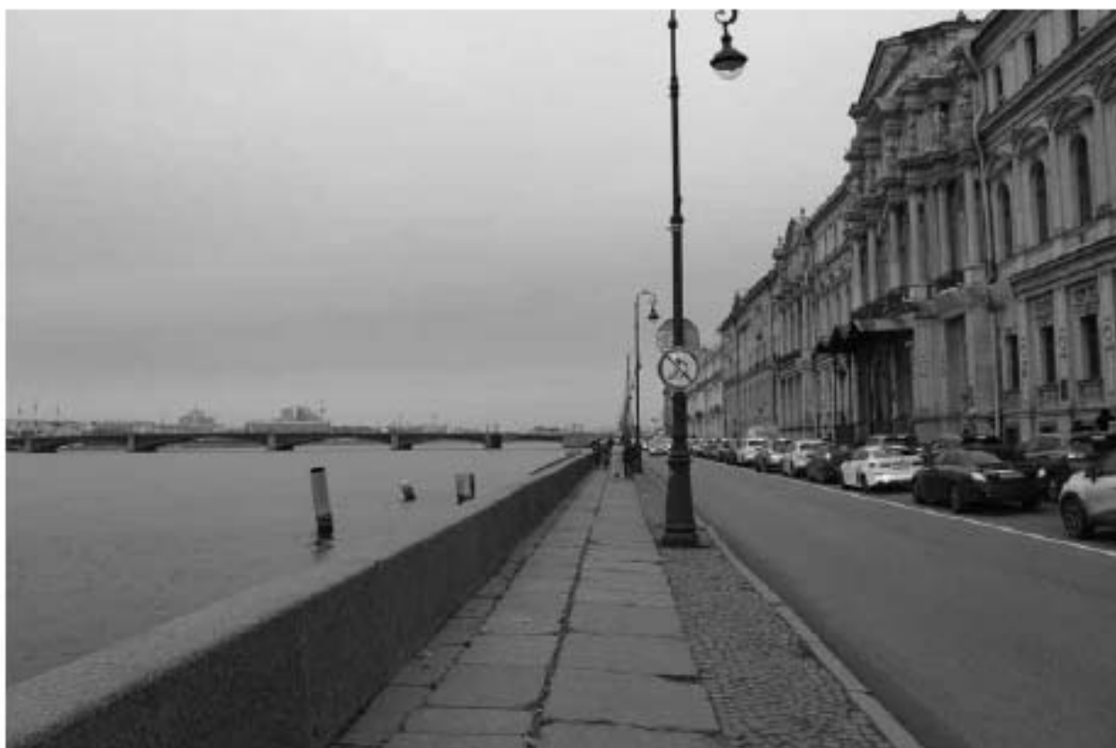
Фото 25. Вид на объект культурного наследия федерального значения «Набережная» на участке набережной реки Невы «Троицкий мост – Эрмитажный мост», литера Б (пешеходная часть набережной от спуска № 2 в сторону спуска № 3).
