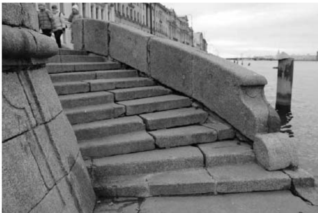
Фото 41. Вид на объект культурного наследия федерального значения «Спуски лестничные» на участке набережной реки Невы «Троицкий мост – Эрмитажный мост», литера Б (4-й спуск с запада).
