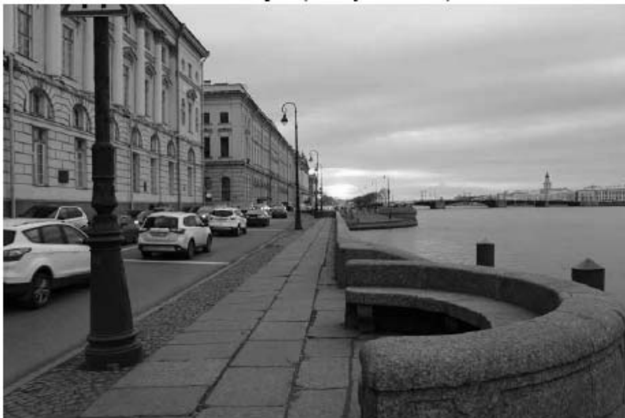
Фото 6. Вид на объект культурного наследия федерального значения «Набережная» на участке набережной реки Невы «Троицкий мост – Эрмитажный мост», литера Б, западная часть (1-й спуск с запада).
