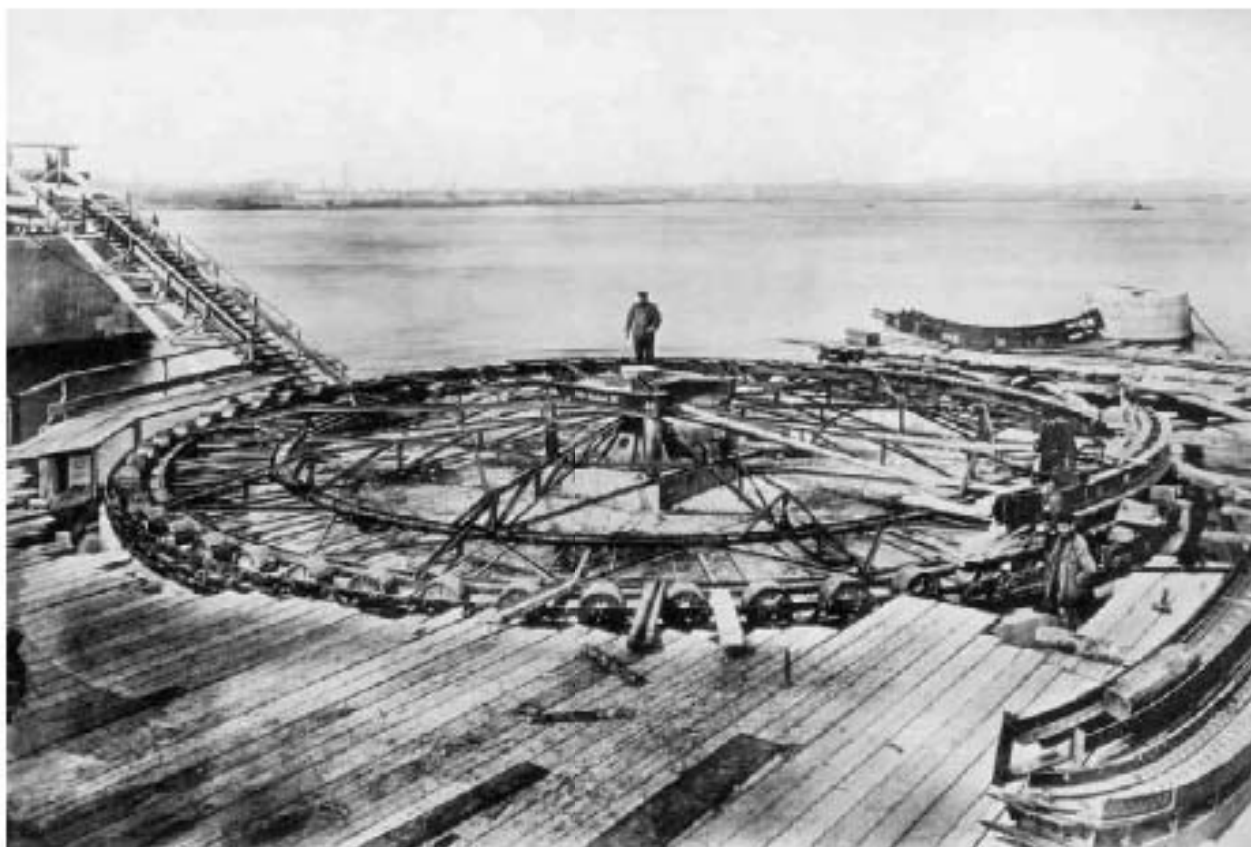
Илл. 29. Центральный барабан разводного пролетного строения. До 1903 г. (источник: Троицкий мост. 115 лет. СПб., 2018. С. 69).
