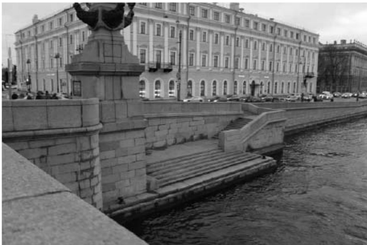
Фото 65. Вид на западный спуск на южном берегу объекта культурного наследия регионального значения «Кировский мост».
