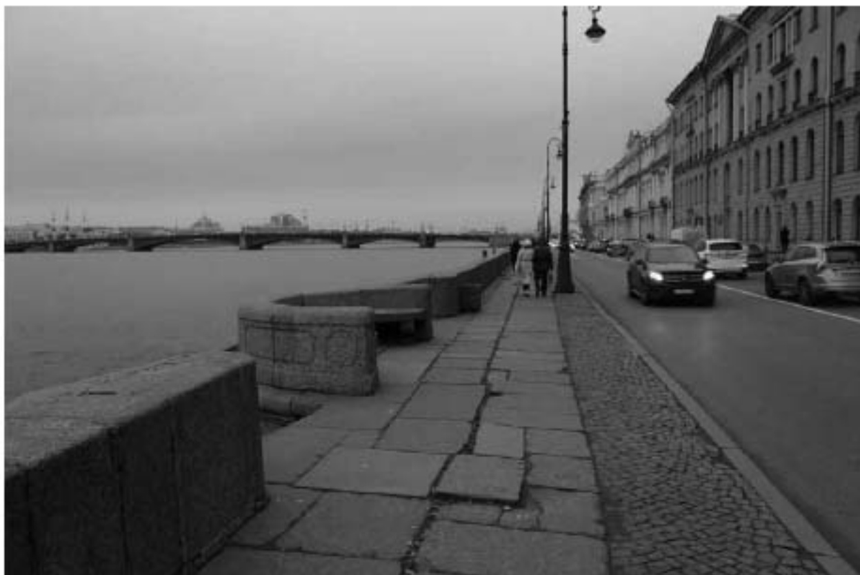
Фото 27. Вид на объект культурного наследия федерального значения «Спуски лестничные» на участке набережной реки Невы «Троицкий мост – Эрмитажный мост», литера Б (3-й спуск с запада).
