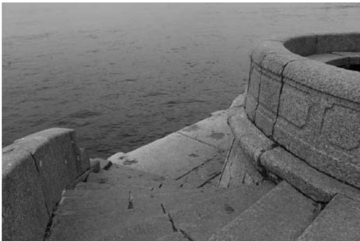
Фото 49. Вид на объект культурного наследия федерального значения «Спуски лестничные» на участке набережной реки Невы «Троицкий мост – Эрмитажный мост», литера Б (5-й спуск с запада).
