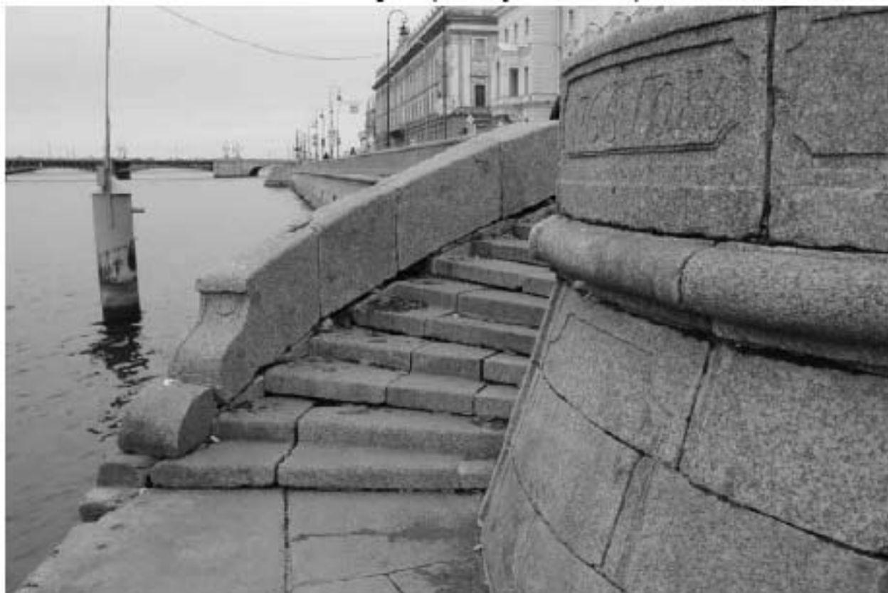
Фото 42. Вид на объект культурного наследия федерального значения «Спуски лестничные» на участке набережной реки Невы «Троицкий мост – Эрмитажный мост», литера Б (4-й спуск с запада).
