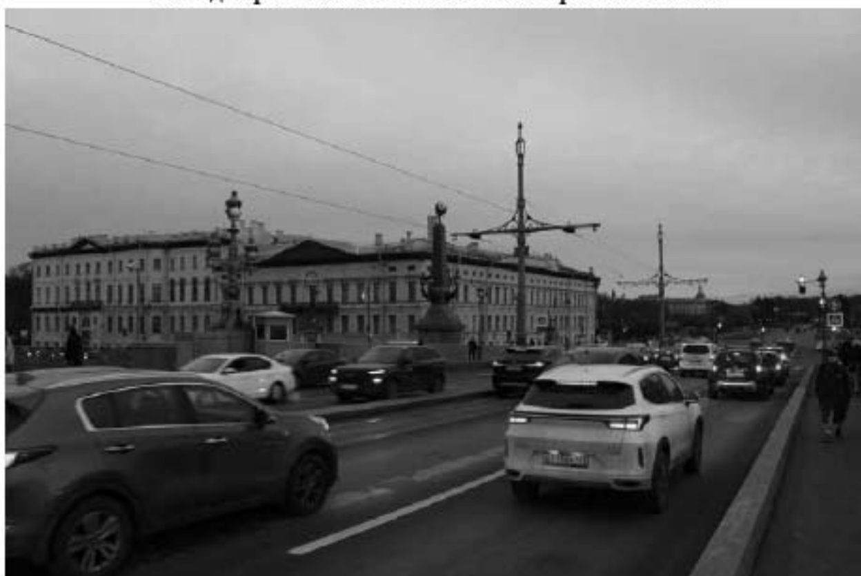
Фото 64. Вид на проезжую часть в южной части моста объекта культурного наследия регионального значения «Кировский мост».
