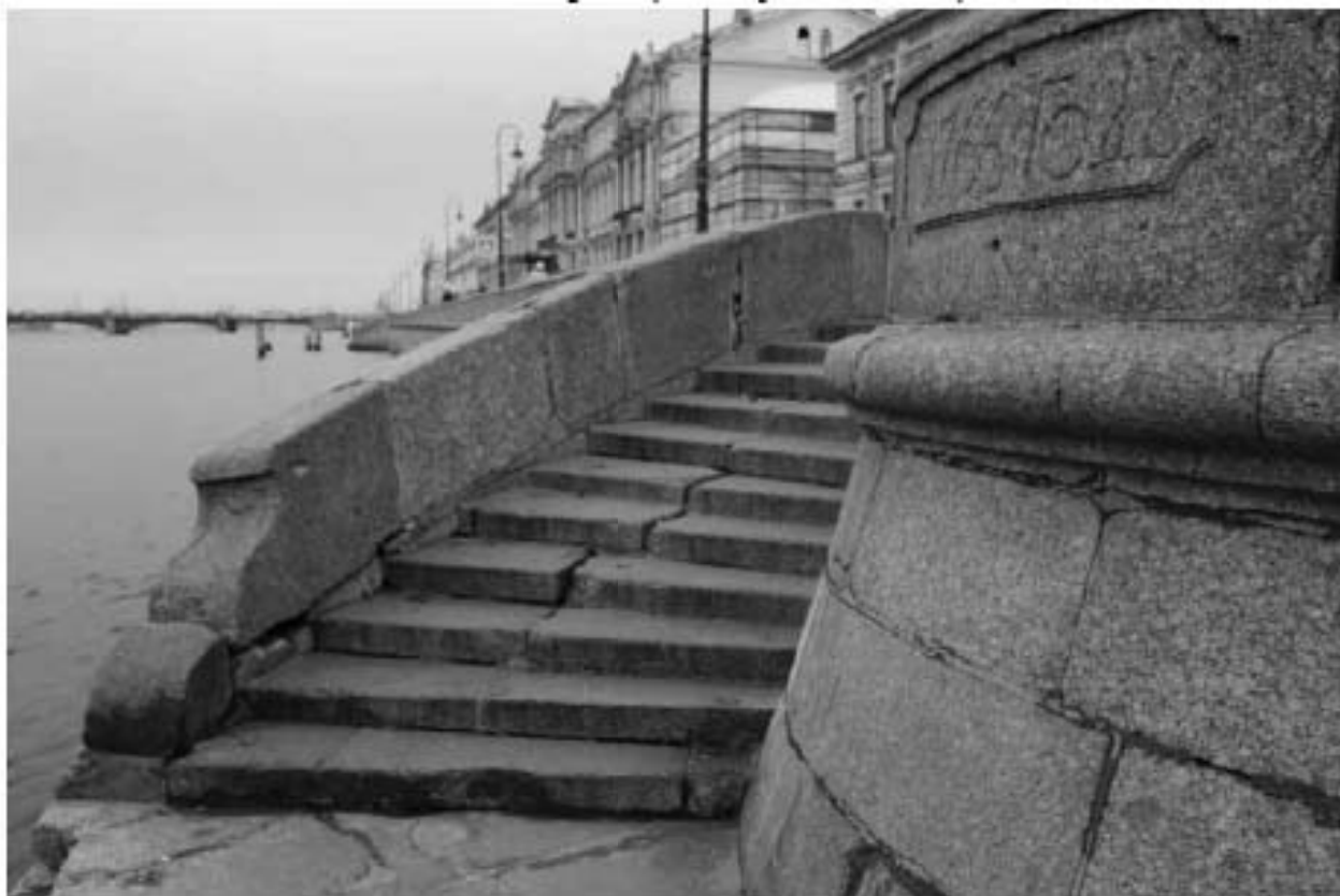
Фото 20. Вид на объект культурного наследия федерального значения «Спуски лестничные» на участке набережной реки Невы «Троицкий мост – Эрмитажный мост», литера Б (2-й спуск с запада).
