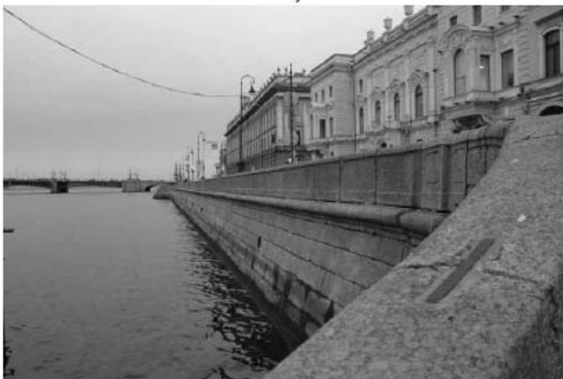
Фото 44. Вид на объект культурного наследия федерального значения «Набережная» на участке набережной реки Невы «Троицкий мост – Эрмитажный мост», литера Б (подпорная стенка от спуска № 4 в сторону спуска № 5).
