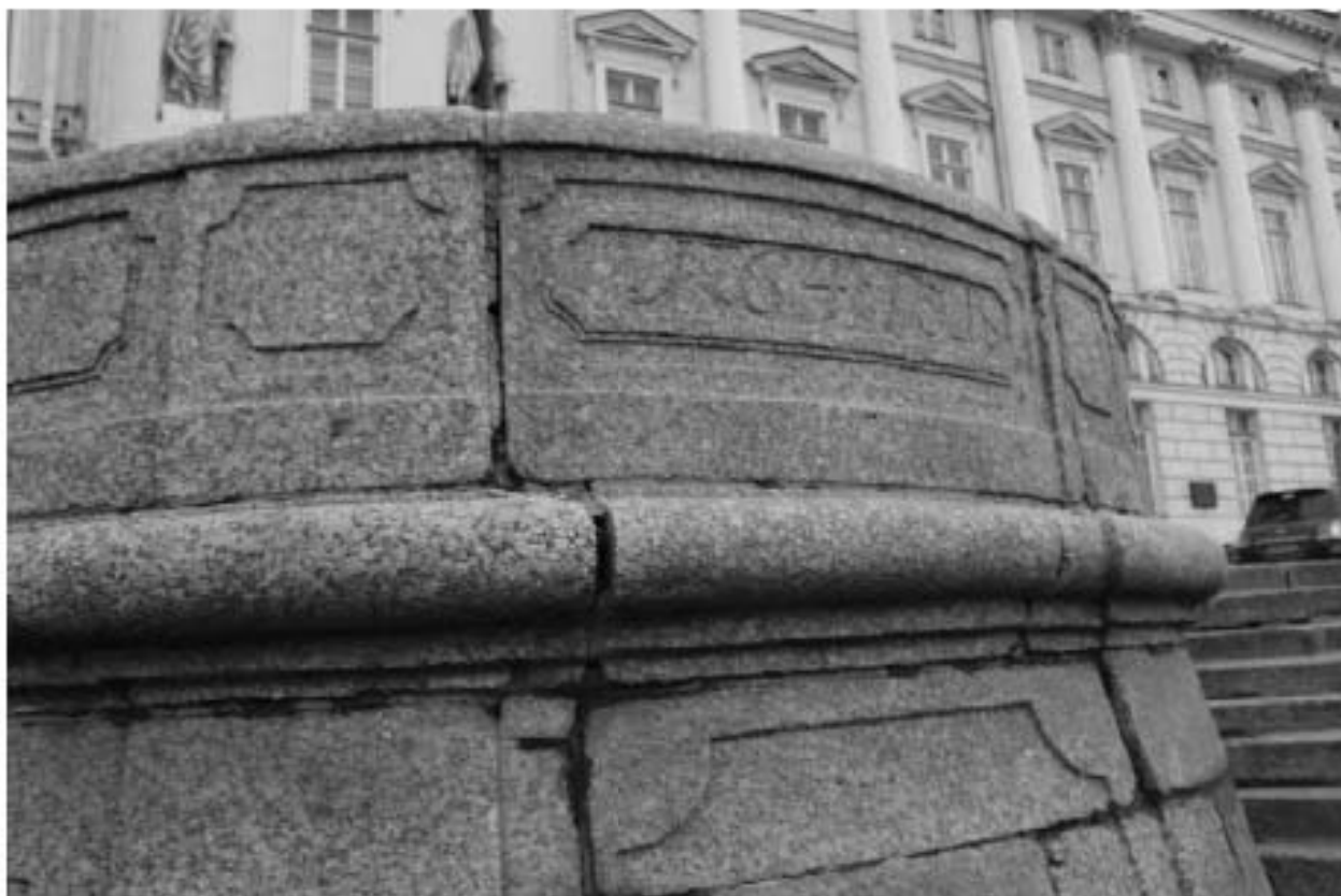
Фото 9. Вид на объект культурного наследия федерального значения «Спуски лестничные» на участке набережной реки Невы «Троицкий мост – Эрмитажный мост», литера Б (1-й спуск с запада).
