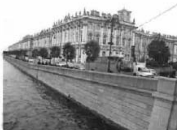
16. Вид стенки набережной с Дворцового моста
