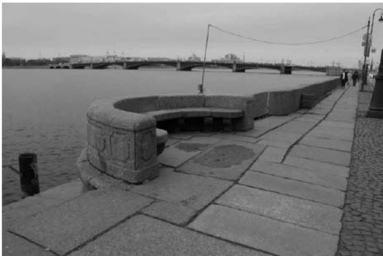
Фото 39. Вид на объект культурного наследия федерального значения «Спуски лестничные» на участке набережной реки Невы «Троицкий мост – Эрмитажный мост», литера Б (4-й спуск с запада)
