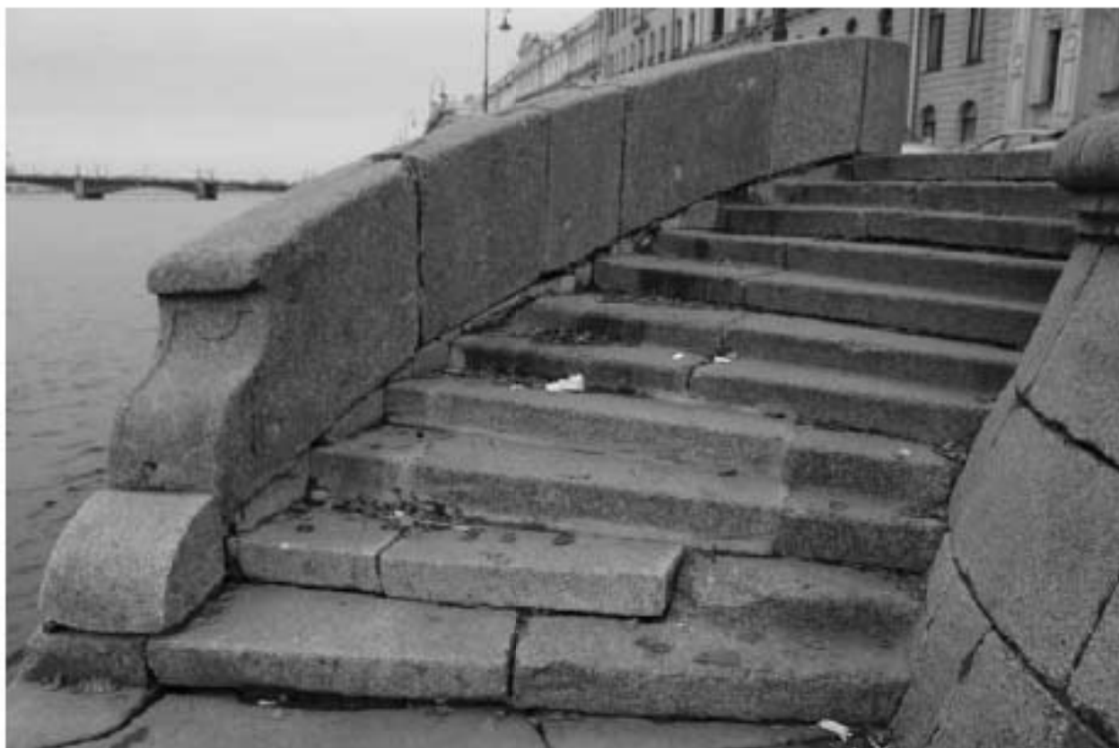
Фото 31. Вид на объект культурного наследия федерального значения «Спуски лестничные» на участке набережной реки Невы «Троицкий мост – Эрмитажный мост», литера Б (3-й спуск с запада).
