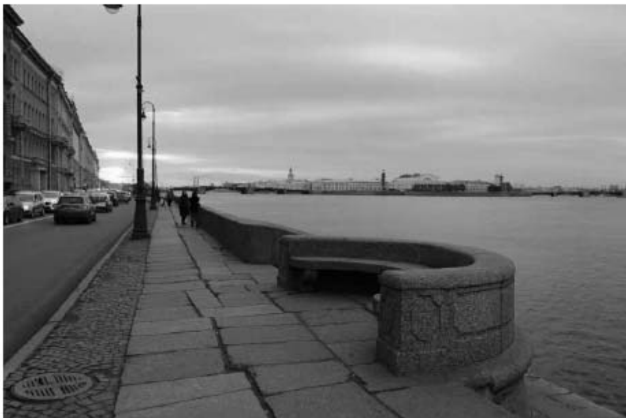
Фото 23. Вид на объект культурного наследия федерального значения «Набережная» на участке набережной реки Невы «Троицкий мост – Эрмитажный мост», литера Б (пешеходная часть набережной от спуска № 2 в сторону спуска № 1).
