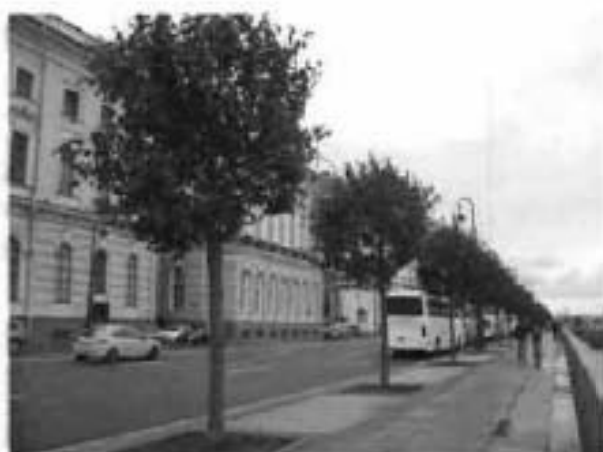
15. Участок набережной между Эрмитажным и Дворцовым мостами. Ряловая посадка деревьев
