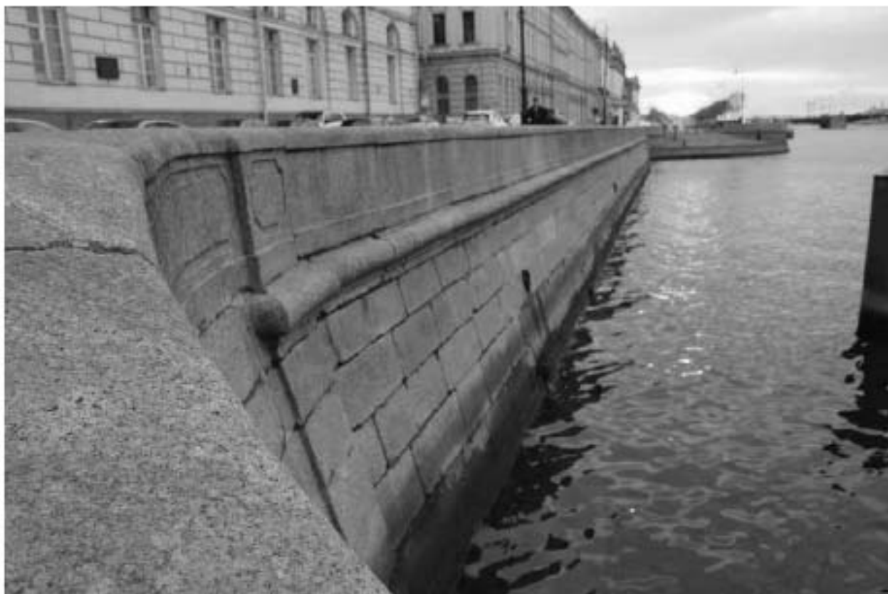
Фото 11. Вид на объект культурного наследия федерального значения «Набережная» на участке набережной реки Невы «Троицкий мост – Эрмитажный мост», литера Б (подпорная стенка до спуска № 1).
