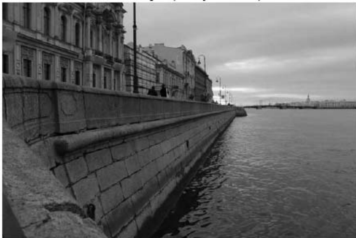
Фото 32. Вид на объект культурного наследия федерального значения «Набережная» на участке набережной реки Невы «Троицкий мост – Эрмитажный мост», литера Б (подпорная стенка от спуска № 3 в сторону спуска № 2).
