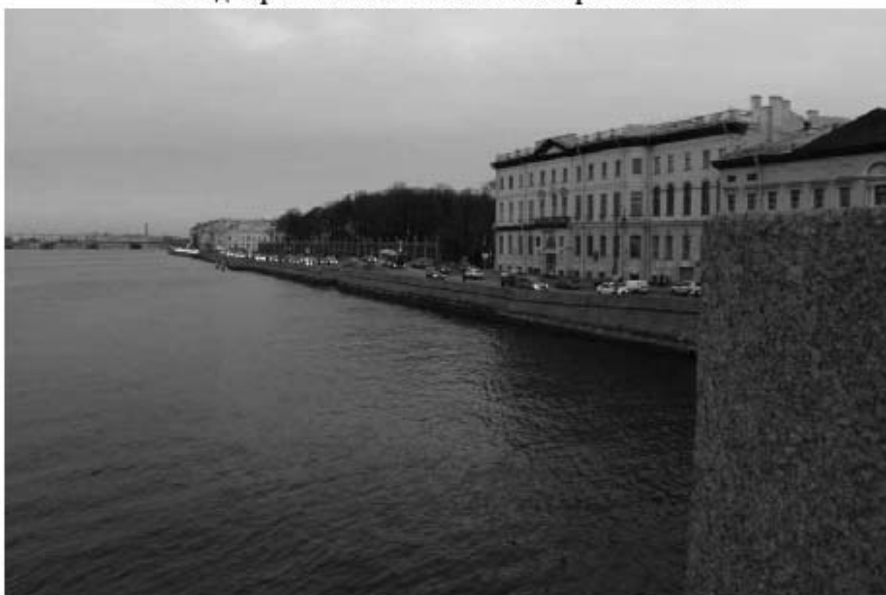
Фото 66. Вид на объект культурного наследия федерального значения «Набережная» на участке набережной реки Невы «Верх. Лебяжий мост – Троицкий мост», литера Б (подпорная стенка к востоку от объекта культурного наследия регионального значения «Кировский мост»).
