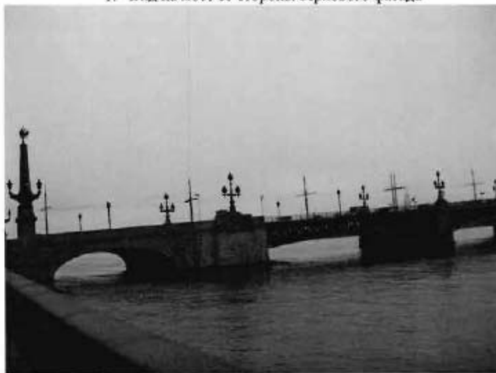
2. Крайние пролеты моста. Вид со стороны верхового фасада
