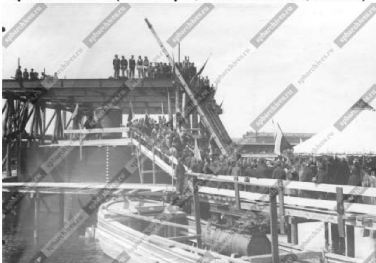
Илл. 26. Строительство моста. До 1903 г. (источник: ЦГАКФФД СПб. Фотодокумент Д 14298).
