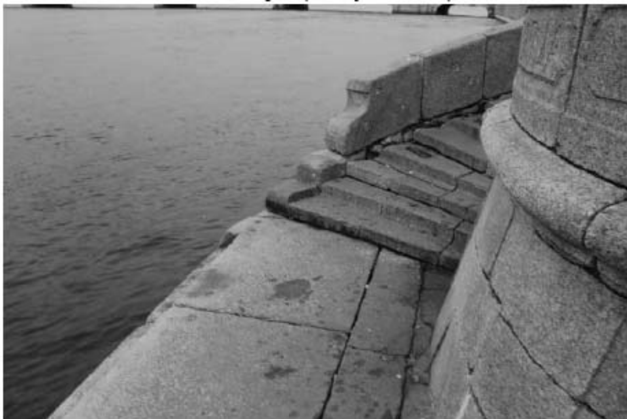
Фото 50. Вид на объект культурного наследия федерального значения «Спуски лестничные» на участке набережной реки Невы «Троицкий мост – Эрмитажный мост», литера Б (5-й спуск с запада).
