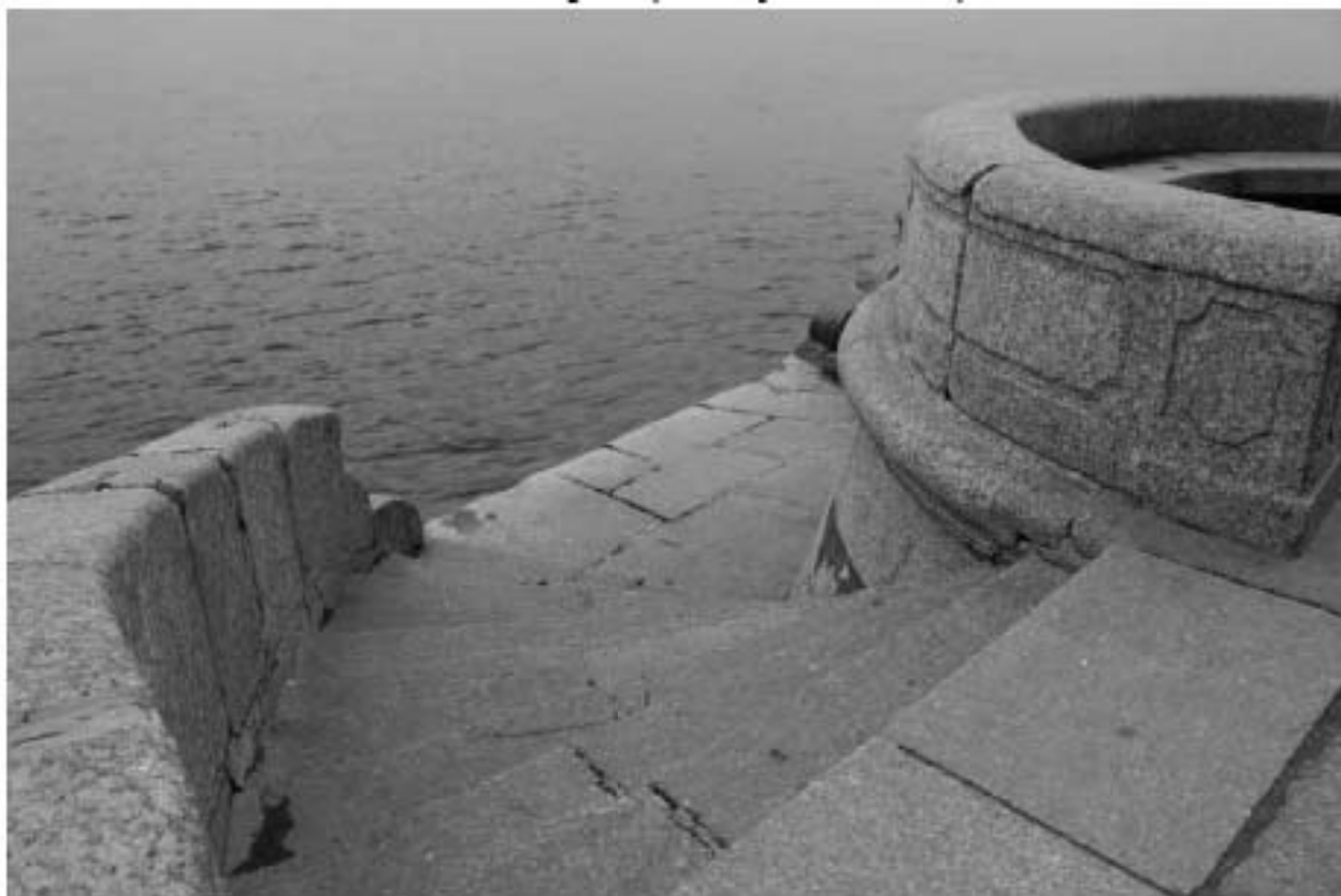
Фото 18. Вид на объект культурного наследия федерального значения «Спуски лестничные» на участке набережной реки Невы «Троицкий мост – Эрмитажный мост», литера Б (2-й спуск с запада).
