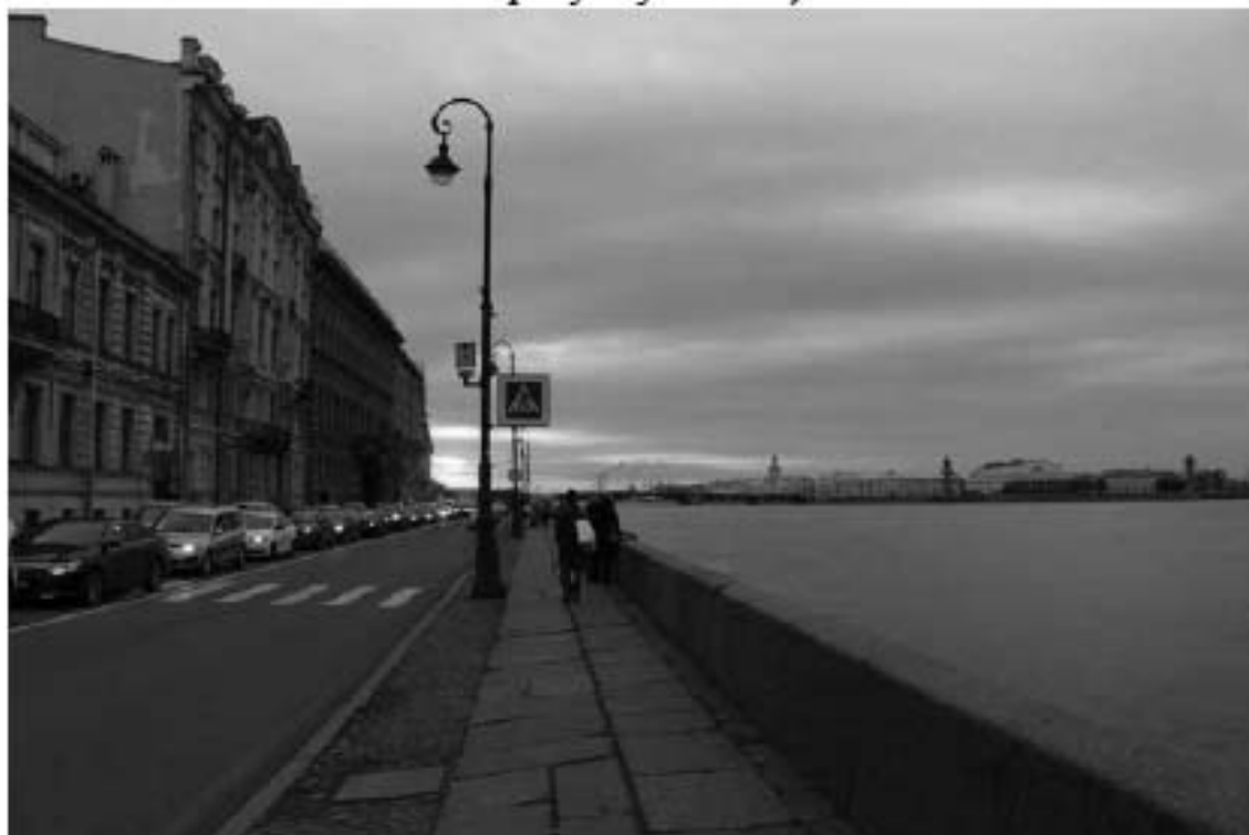
Фото 26. Вид на объект культурного наследия федерального значения «Набережная» на участке набережной реки Невы «Троицкий мост – Эрмитажный мост», литера Б (пешеходная часть набережной от спуска № 3 в сторону спуска № 2).
