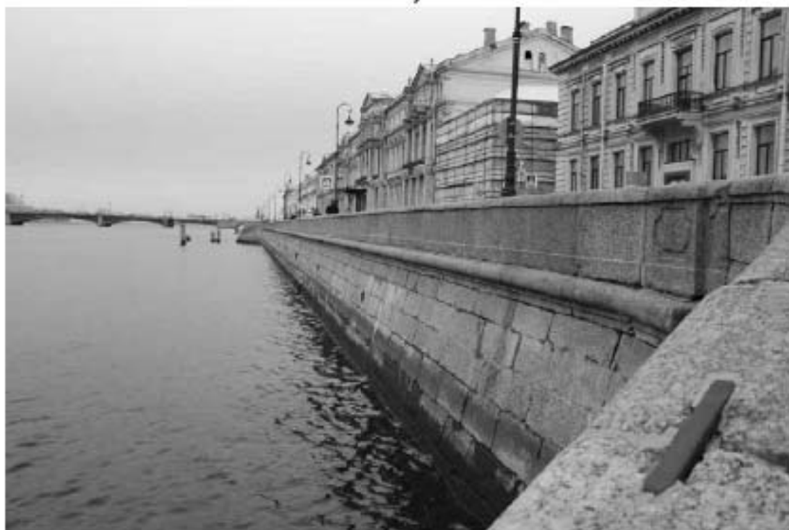
Фото 22. Вид на объект культурного наследия федерального значения «Набережная» на участке набережной реки Невы «Троицкий мост – Эрмитажный мост», литера Б (подпорная стенка от спуска № 2 в сторону спуска № 3).
