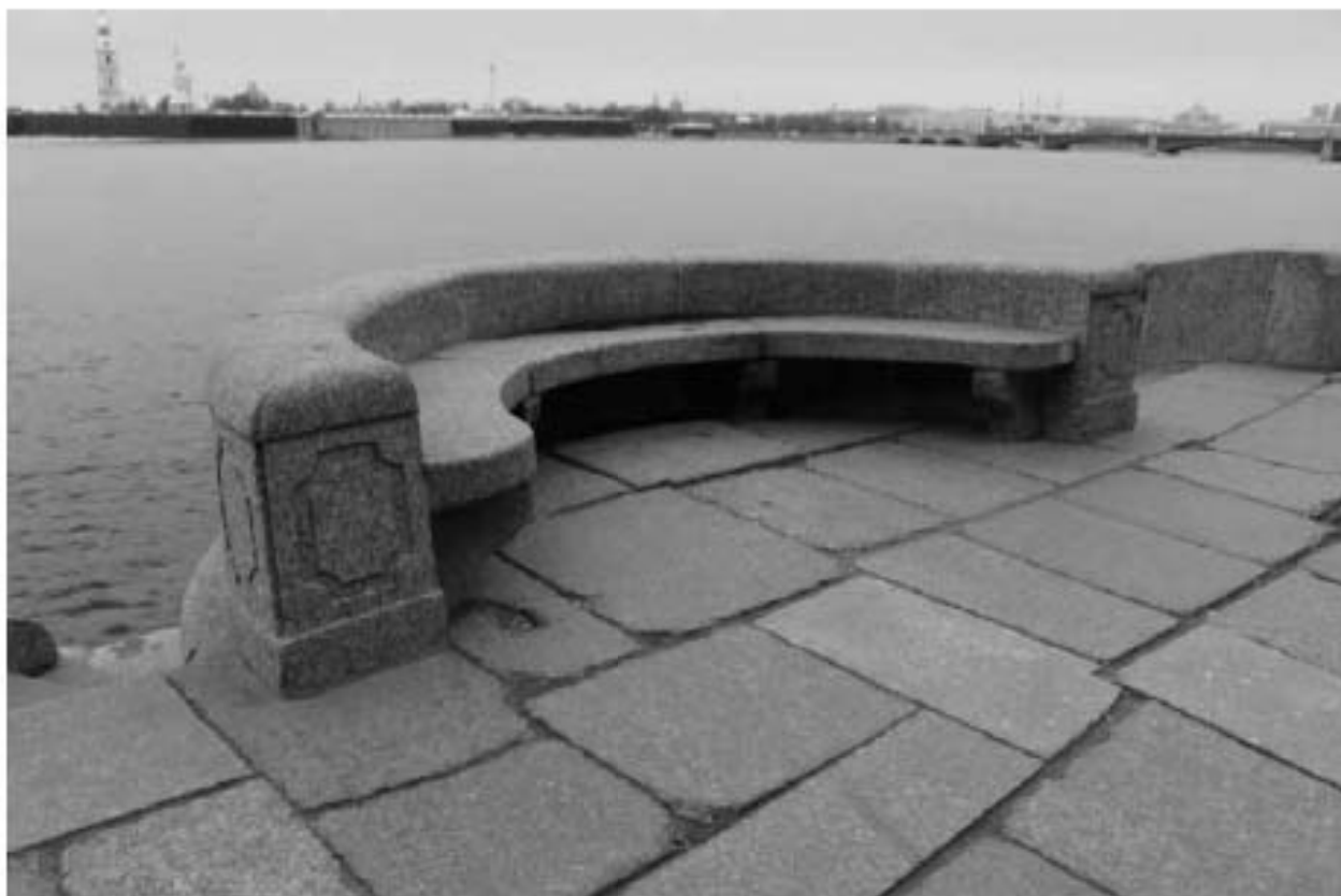
Фото 17. Вид на объект культурного наследия федерального значения «Спуски лестничные» на участке набережной реки Невы «Троицкий мост – Эрмитажный мост», литера Б (2-й спуск с запада).
