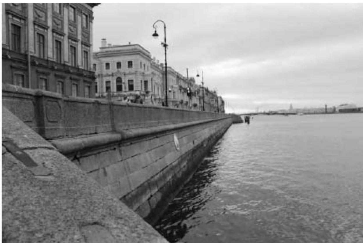
Фото 51. Вид на объект культурного наследия федерального значения «Набережная» на участке набережной реки Невы «Троицкий мост – Эрмитажный мост», литера Б (подпорная стенка от спуска № 5 в сторону спуска № 4).
