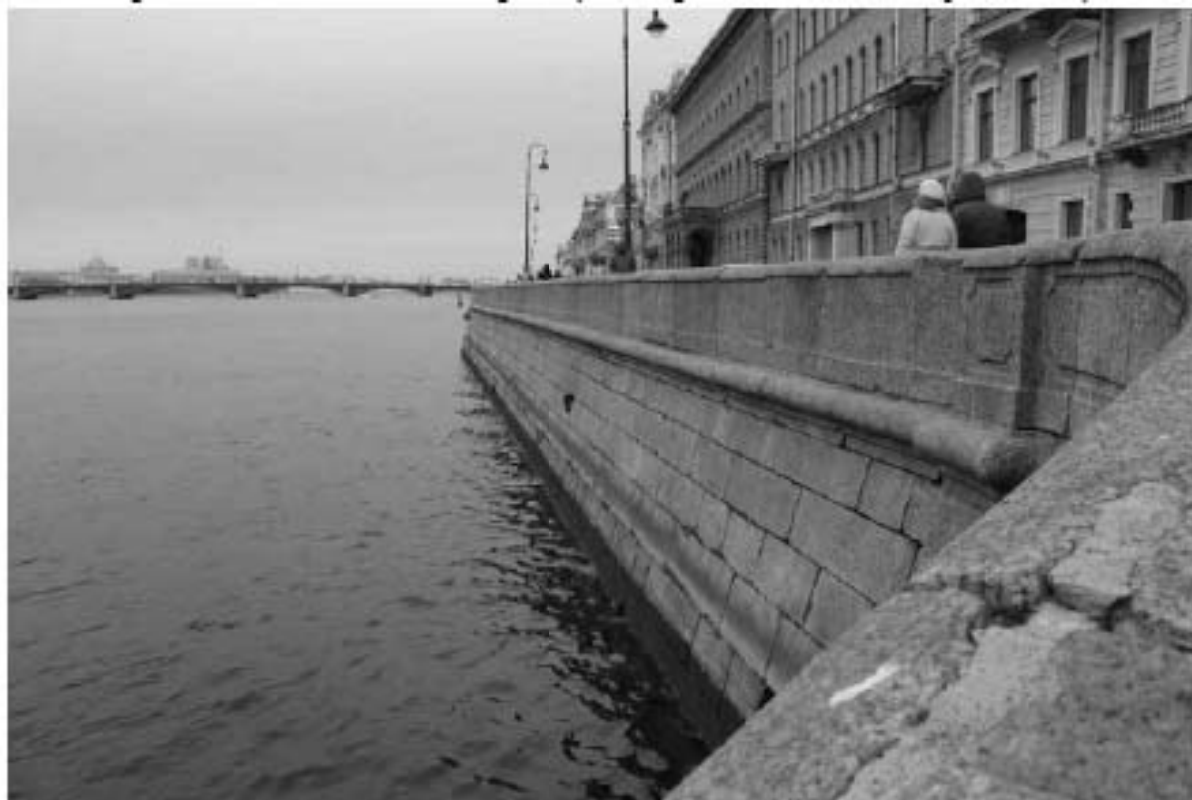
Фото 12. Вид на объект культурного наследия федерального значения «Набережная» на участке набережной реки Невы «Троицкий мост – Эрмитажный мост», литера Б (подпорная стенка от спуска № 1 в сторону спуска № 2).
