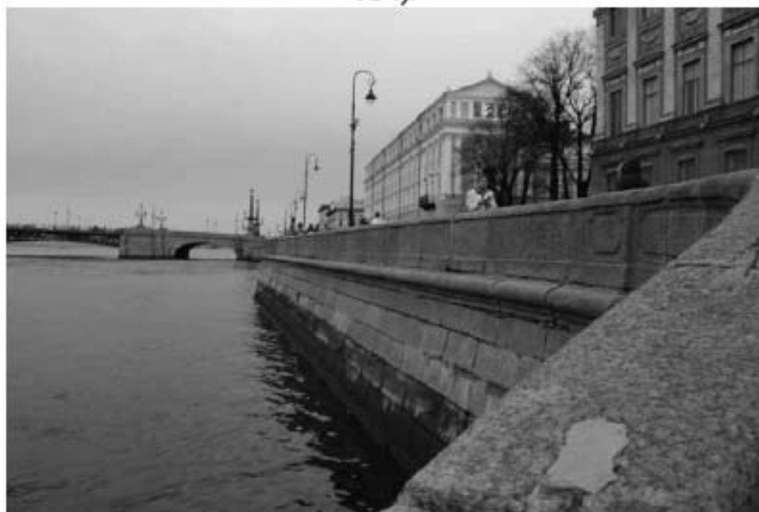
Фото 52. Вид на объект культурного наследия федерального значения «Набережная» на участке набережной реки Невы «Троицкий мост – Эрмитажный мост», литера Б (подпорная стенка от спуска № 5 в сторону объекта культурного наследия регионального значения «Кировский мост»).
