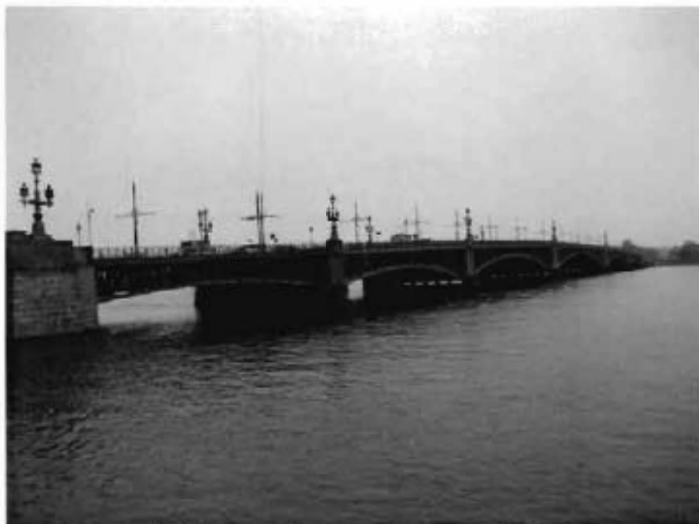
1. Вид на мост со стороны верхового фасада
