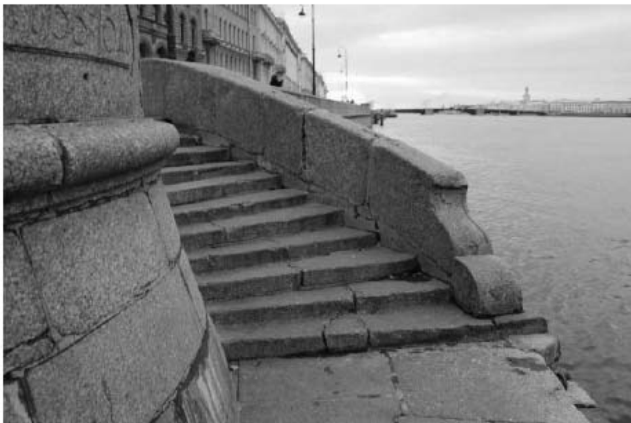
Фото 19. Вид на объект культурного наследия федерального значения «Спуски лестничные» на участке набережной реки Невы «Троицкий мост – Эрмитажный мост», литера Б (2-й спуск с запада).
