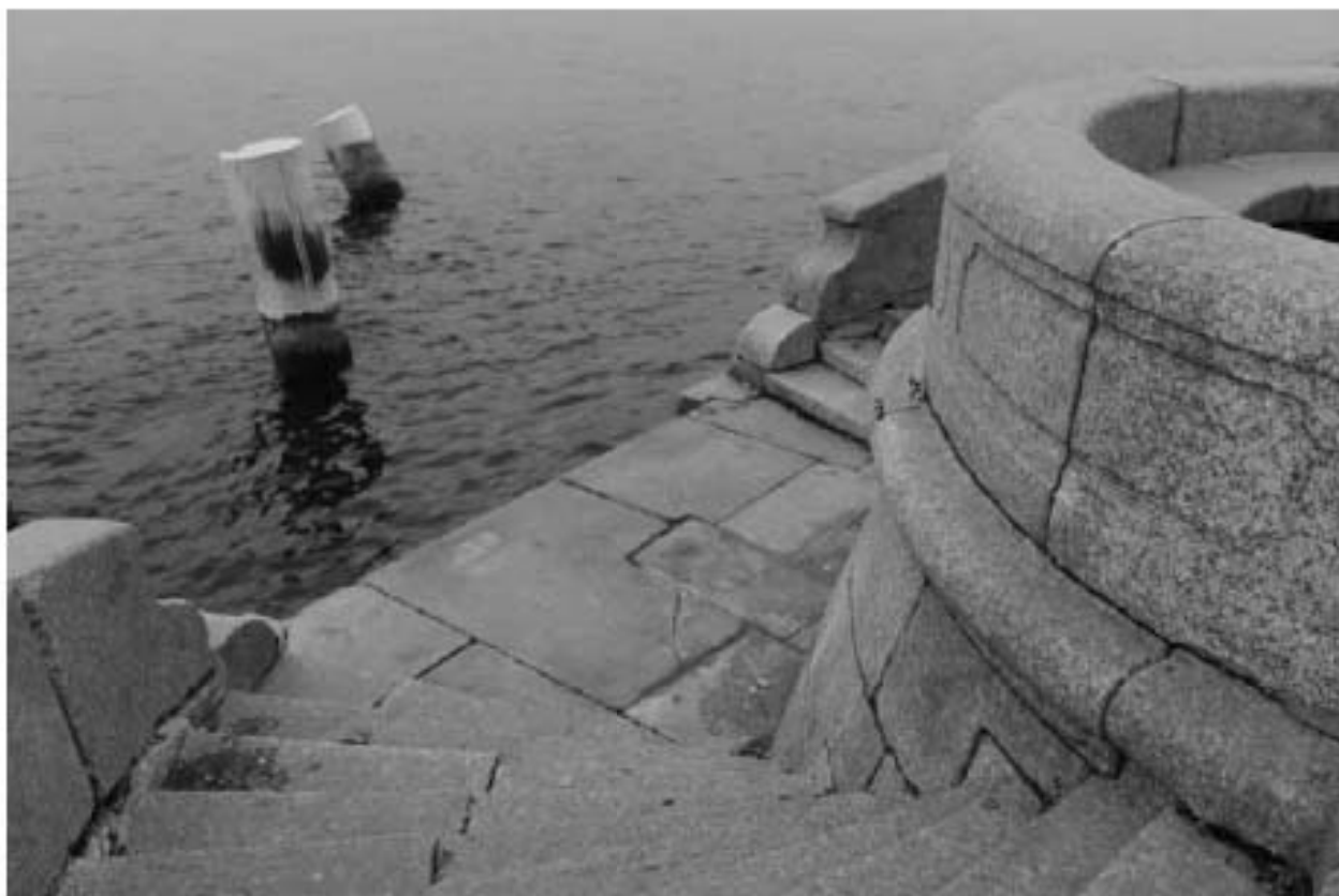
Фото 29. Вид на объект культурного наследия федерального значения «Спуски лестничные» на участке набережной реки Невы «Троицкий мост – Эрмитажный мост», литера Б (3-й спуск с запада).
