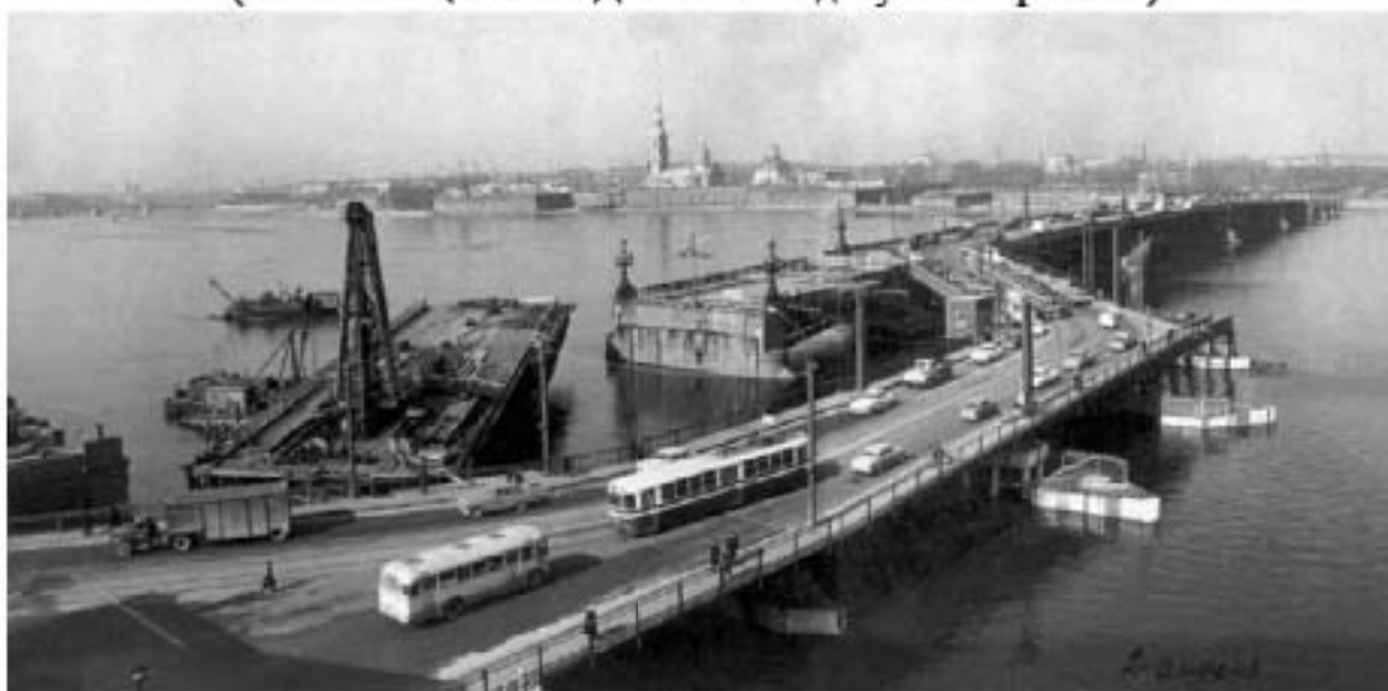
Илл. 50. Демонтаж старого разводного пролетного строения при наведенном положении временного моста и движении по нему городского транспорта. 1965 г. (источник: Троицкий мост. 115 лет. СПб., 2018. С. 158).
