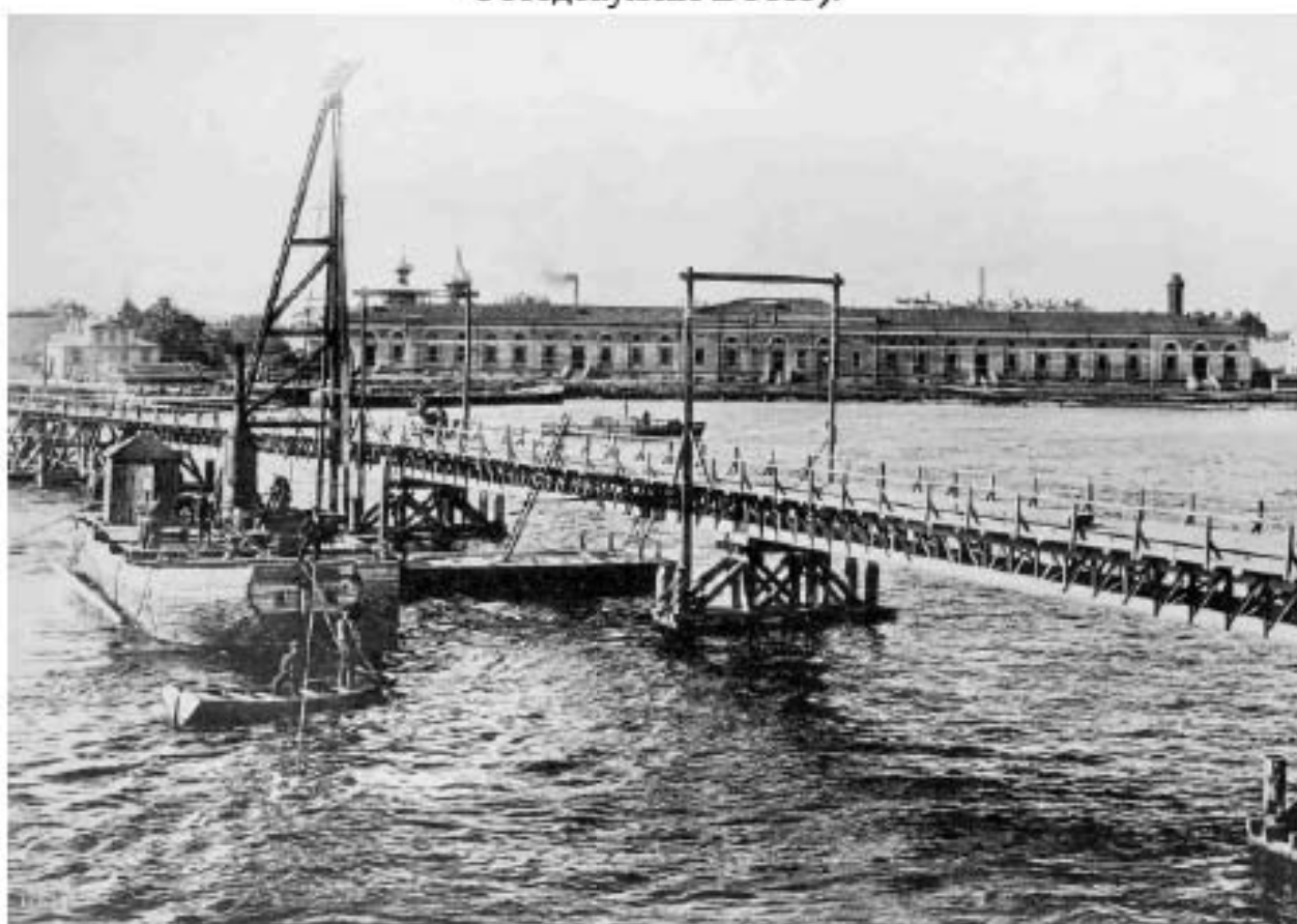
Илл. 23. Временный мост для подачи материалов. 1899 г. (источник: Троицкий мост. 115 лет. СПб., 2018. С. 87).
