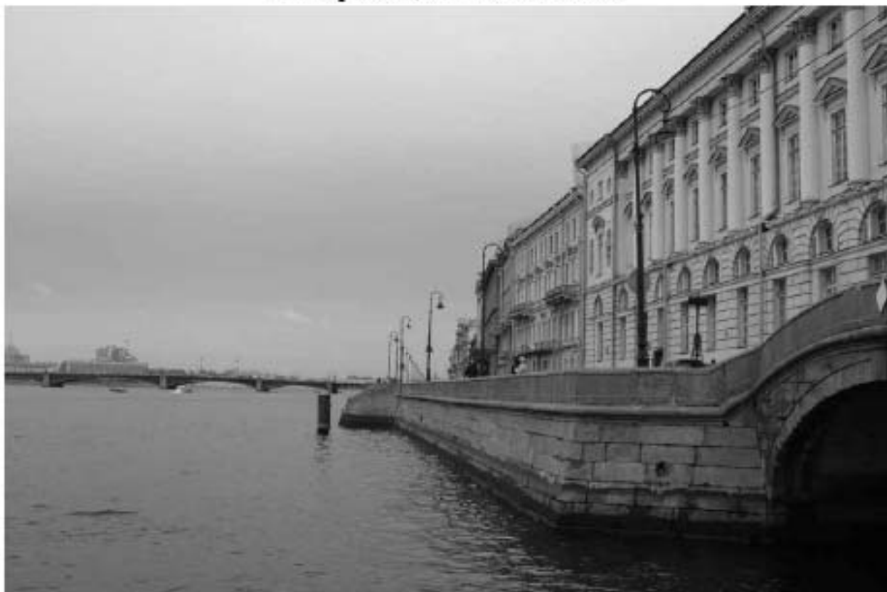
Фото 1. Вид на объект культурного наследия федерального значения «Набережная» на участке набережной реки Невы «Троицкий мост – Эрмитажный мост», литера Б, вид с запада.
