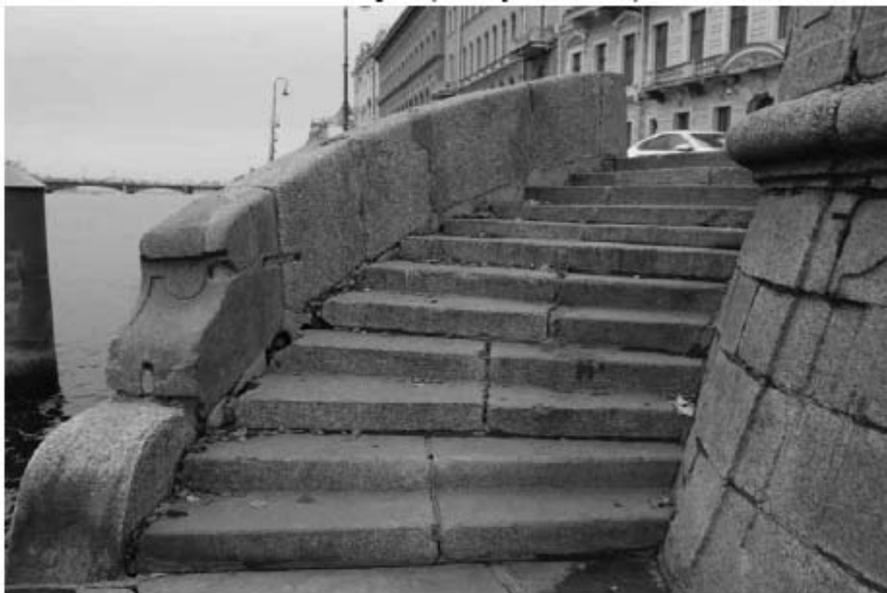
Фото 10. Вид на объект культурного наследия федерального значения «Спуски лестничные» на участке набережной реки Невы «Троицкий мост – Эрмитажный мост», литера Б (1-й спуск с запада).
