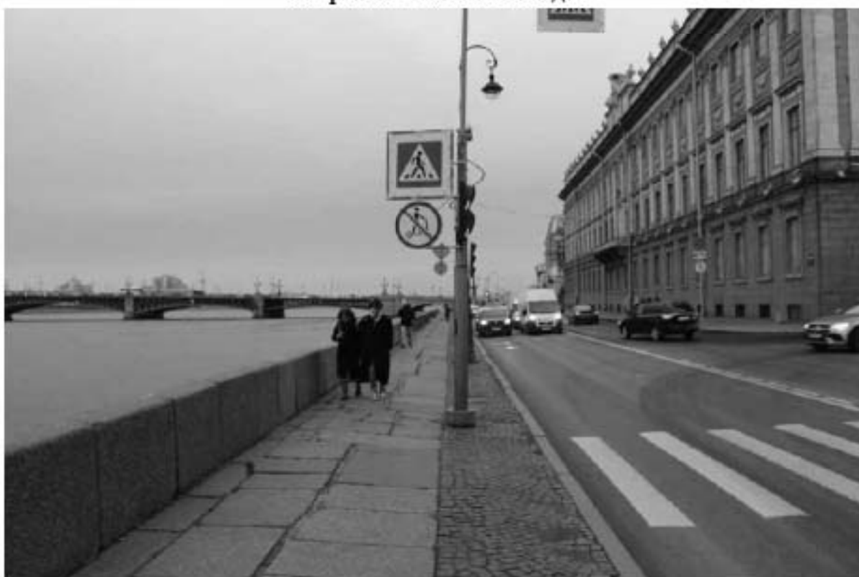
Фото 46. Вид на объект культурного наследия федерального значения «Набережная» на участке набережной реки Невы «Троицкий мост – Эрмитажный мост», литера Б (пешеходная часть набережной от спуска № 4 в сторону спуска № 5).
