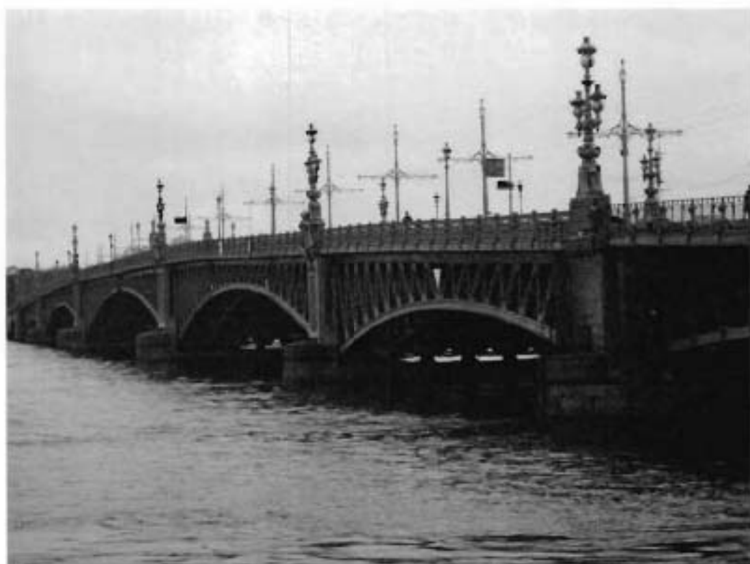
11. Средняя пятипролетная часть моста – металлическая ферма арочно-консольной системы с криволинейным нижним поясом. Вид со стороны низового фасада.
