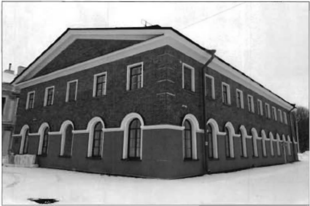
1. Вид на южный и восточный фасад.
