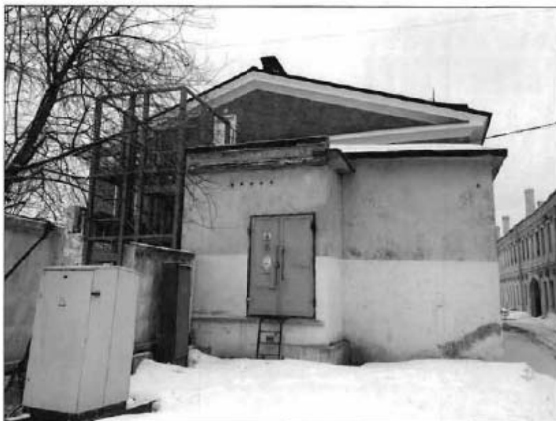
3. Вид на северный фасад.
