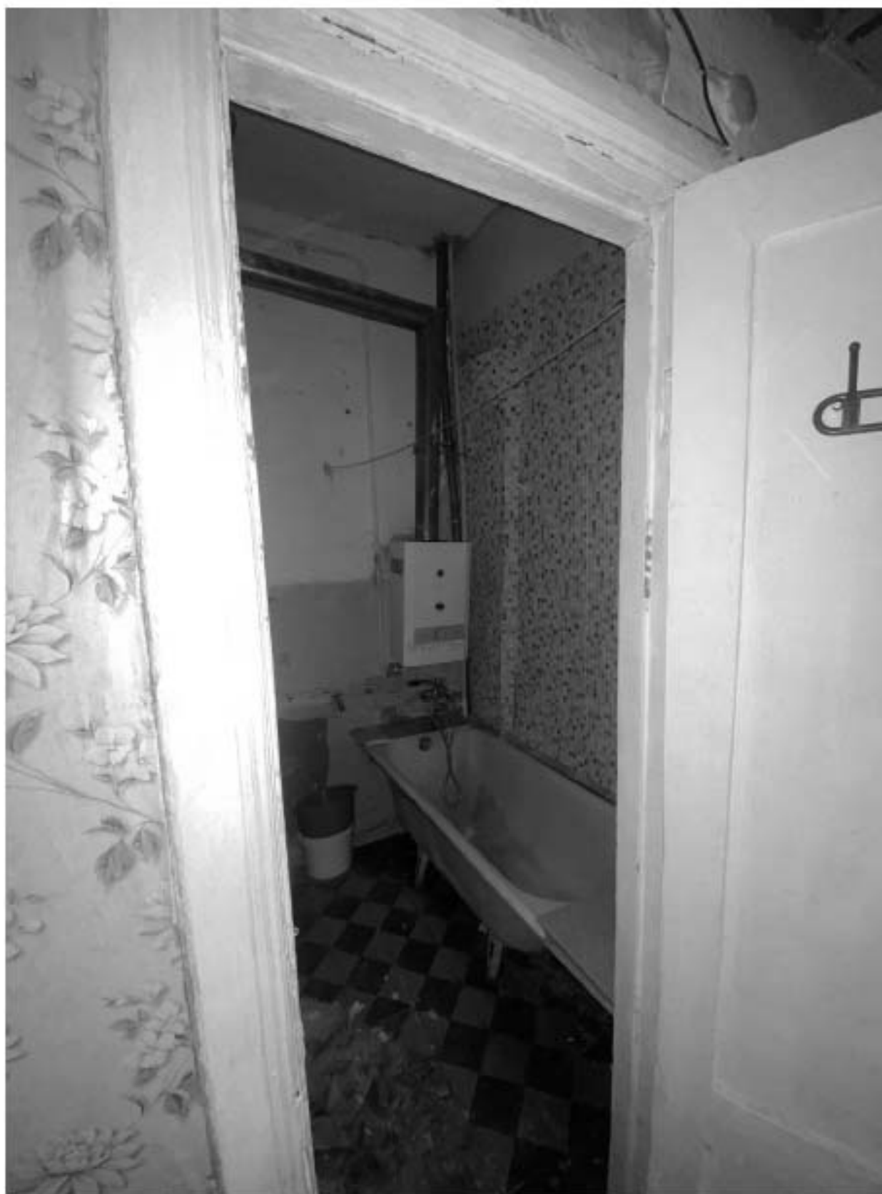
19. Фрагмент интерьера ванной (помещение 7/3);
