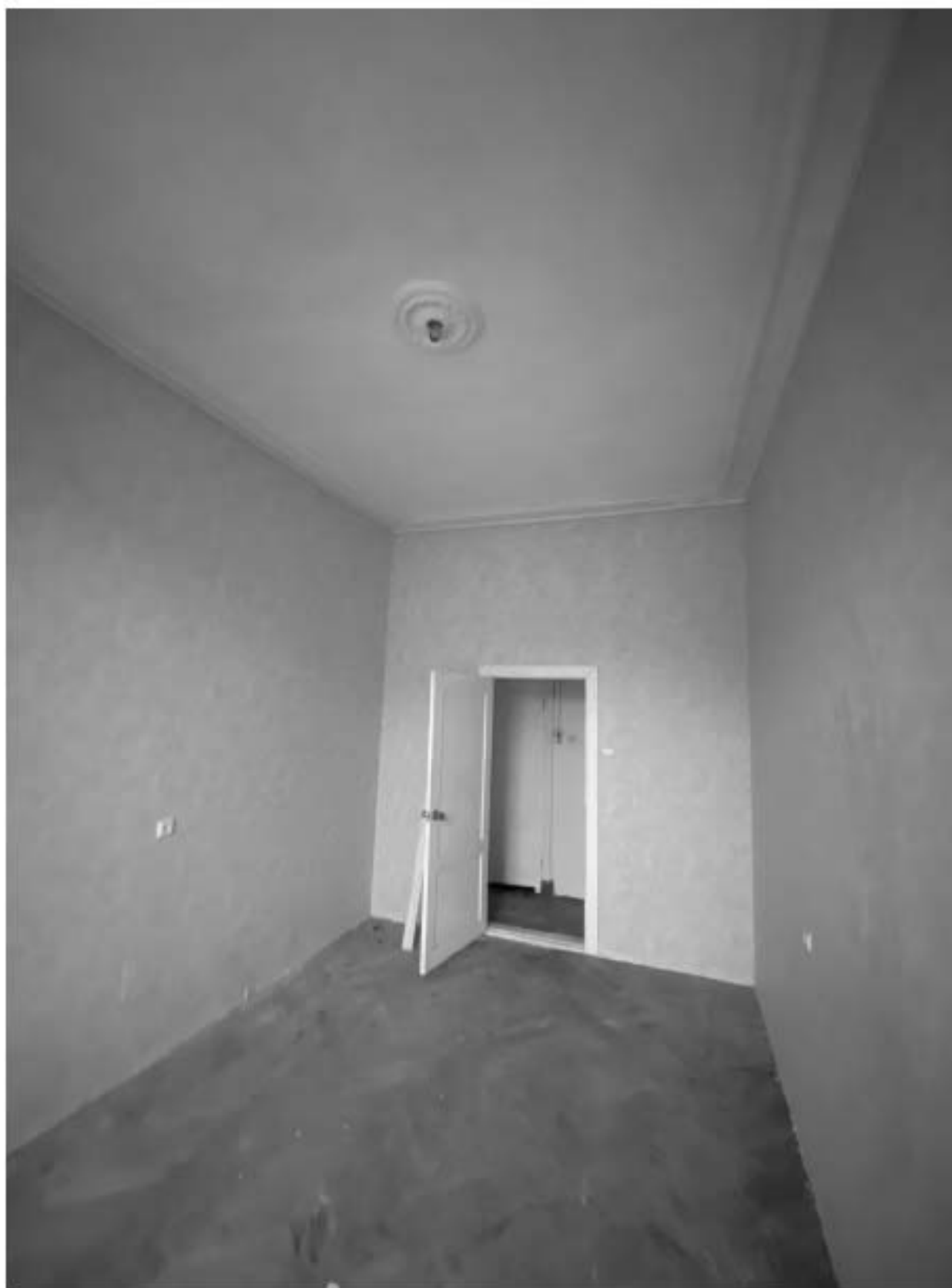
12. Фрагмент интерьера комнаты (помещение 4/13.9);
