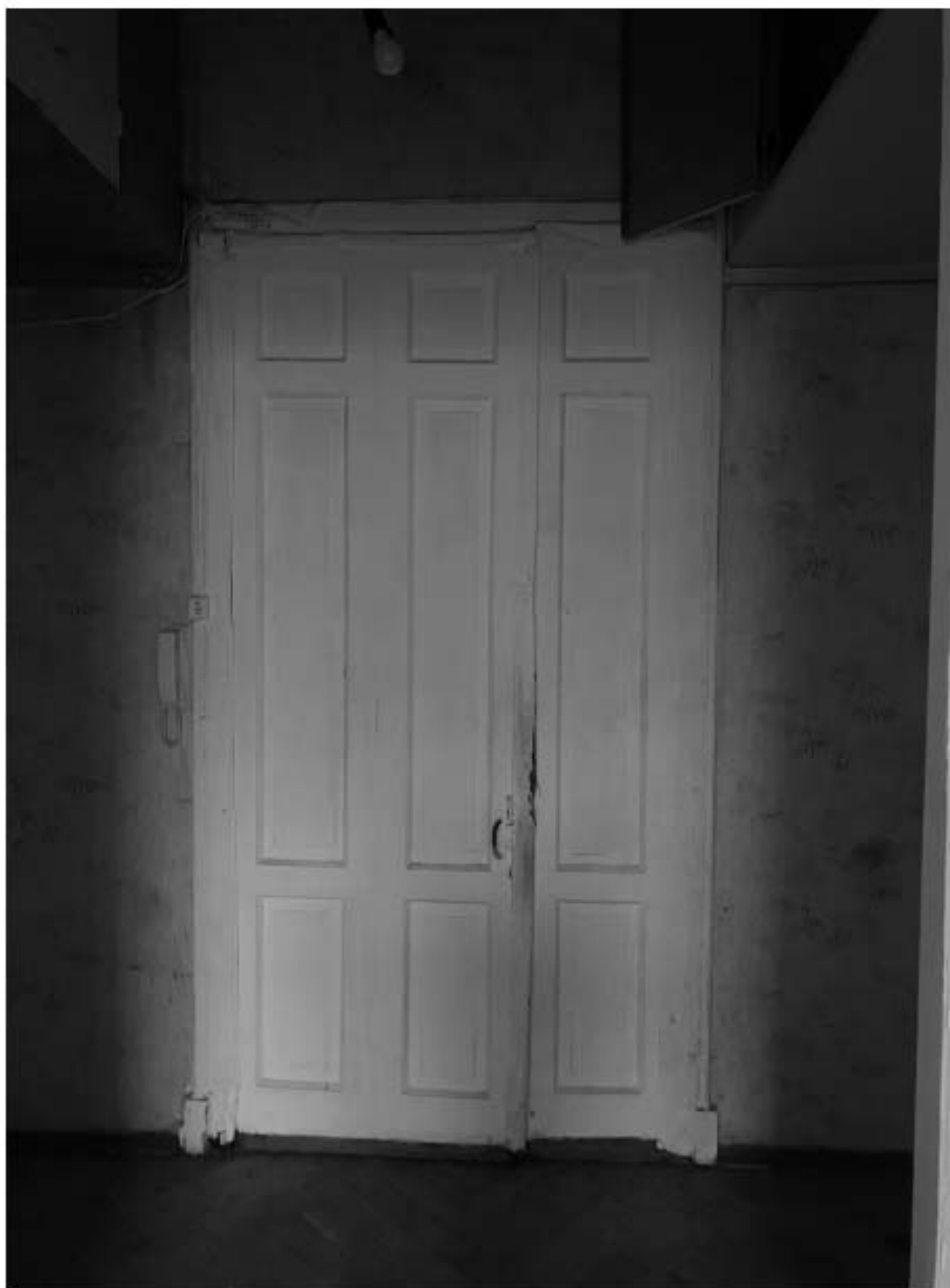
4. Вид на входную дверь в квартире;
