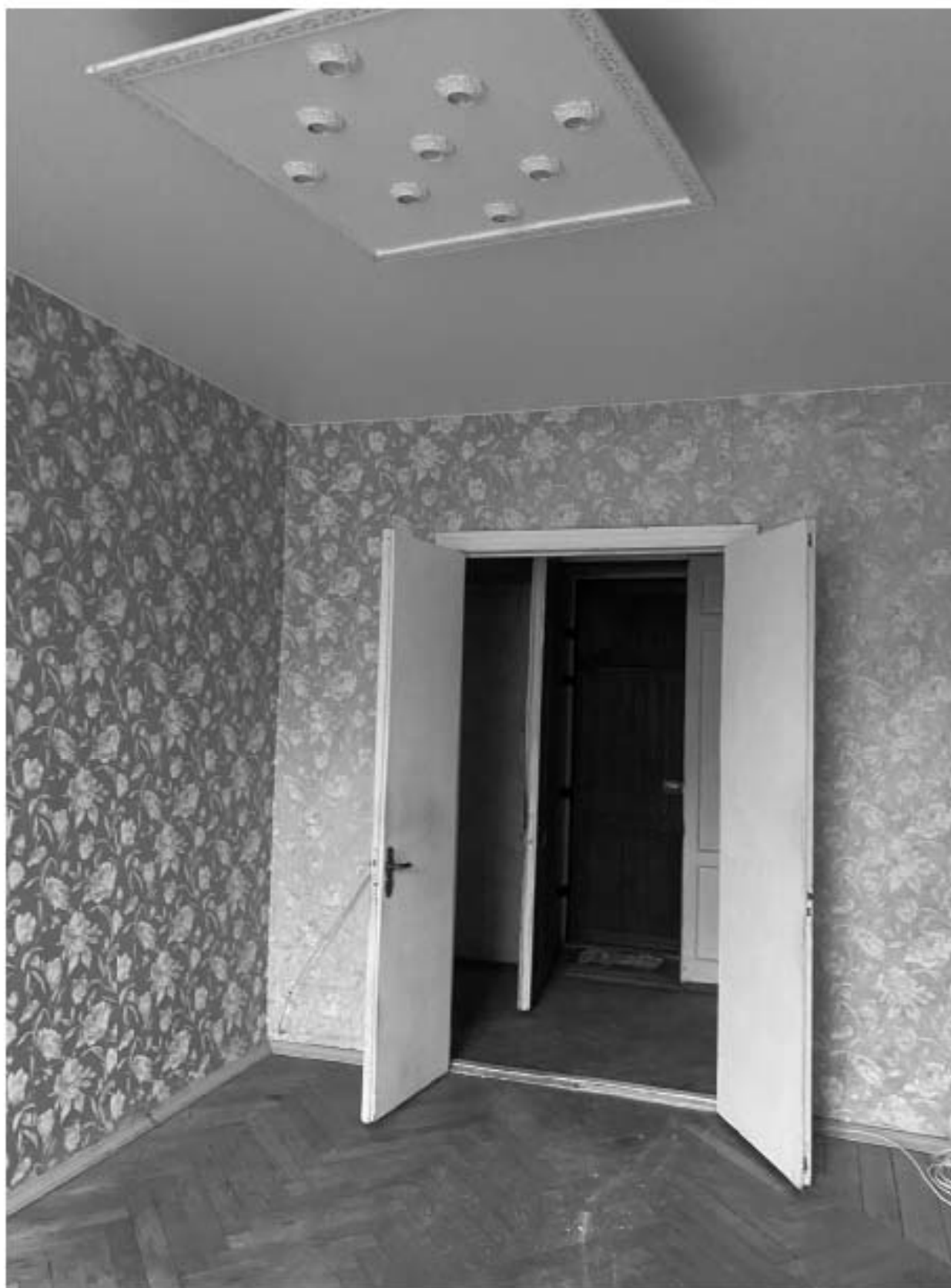
6. Фрагмент интерьера комнаты (помещение 2/19.5);
