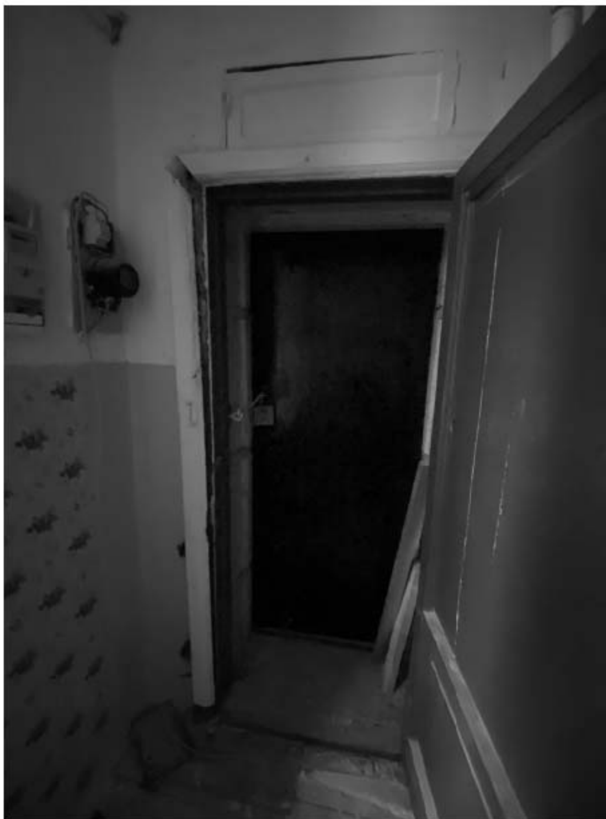
17. Вид на входную дверь в квартире;
