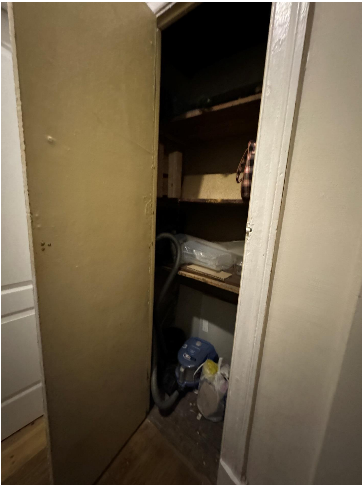
Фото 46. Вид на помещение квартиры № 14 объекта культурного наследия.
