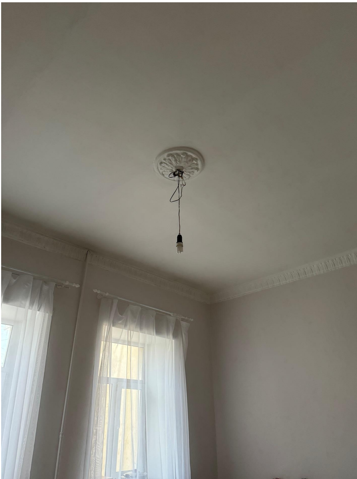
Фото 21. Вид на помещение квартиры № 14 объекта культурного наследия.
