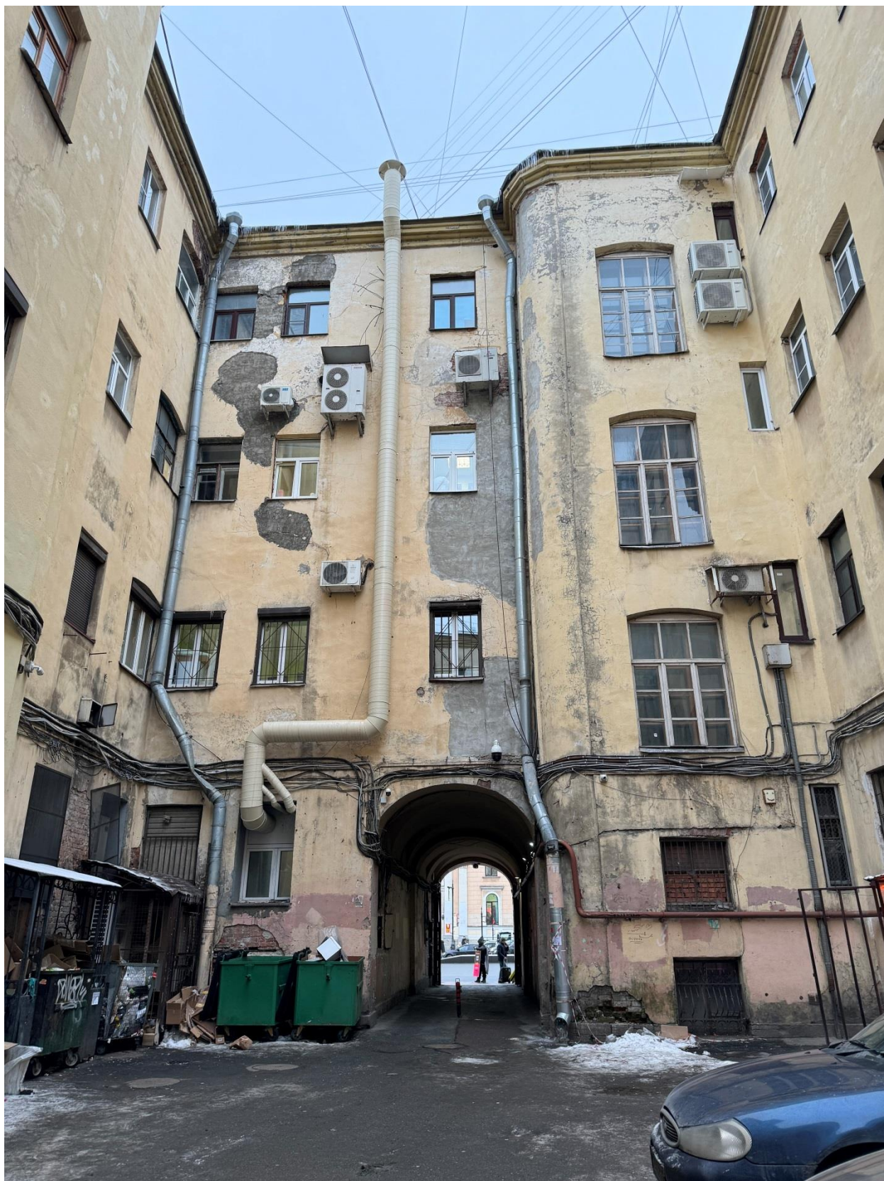
Фото 3. Общий вид восточного дворового фасада объекта культурного наследия.
