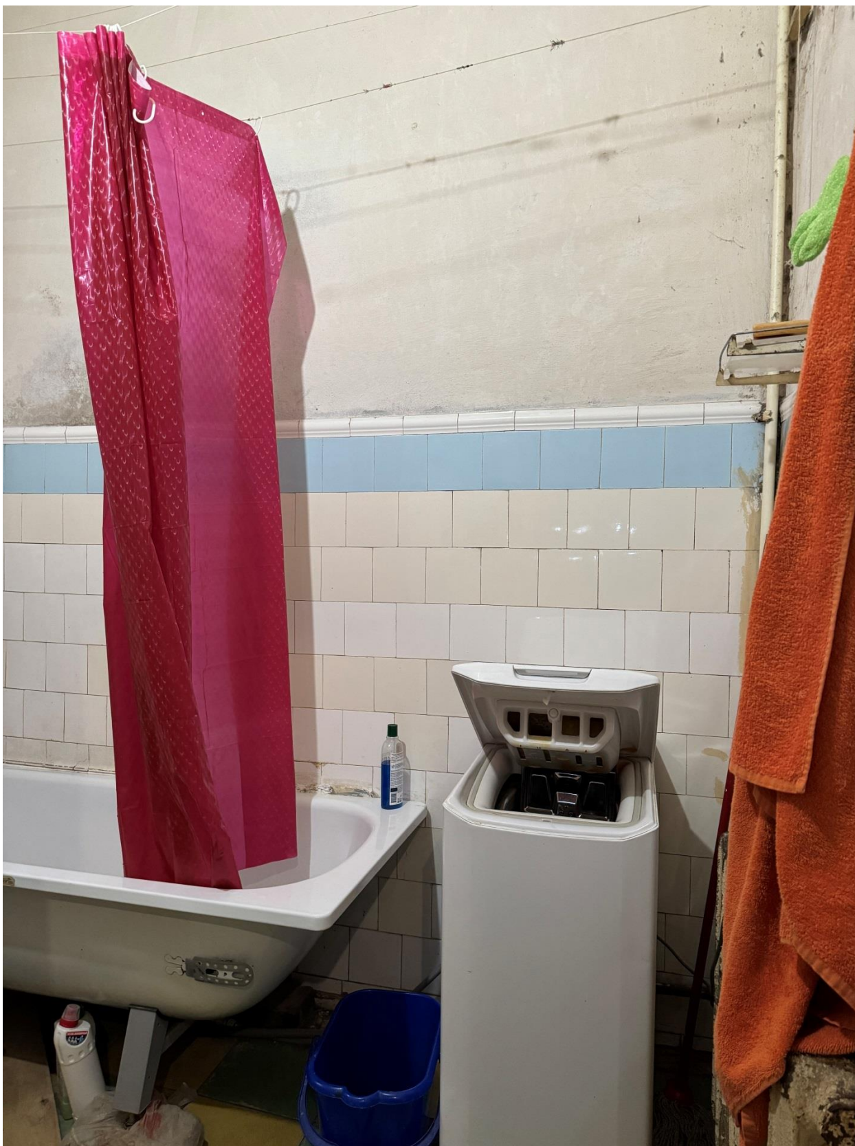
Фото 29. Вид на помещение квартиры № 14 объекта культурного наследия.
