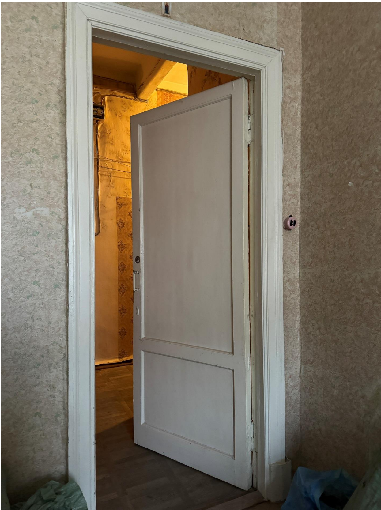
Фото 17. Вид на помещение квартиры № 14 объекта культурного наследия.
