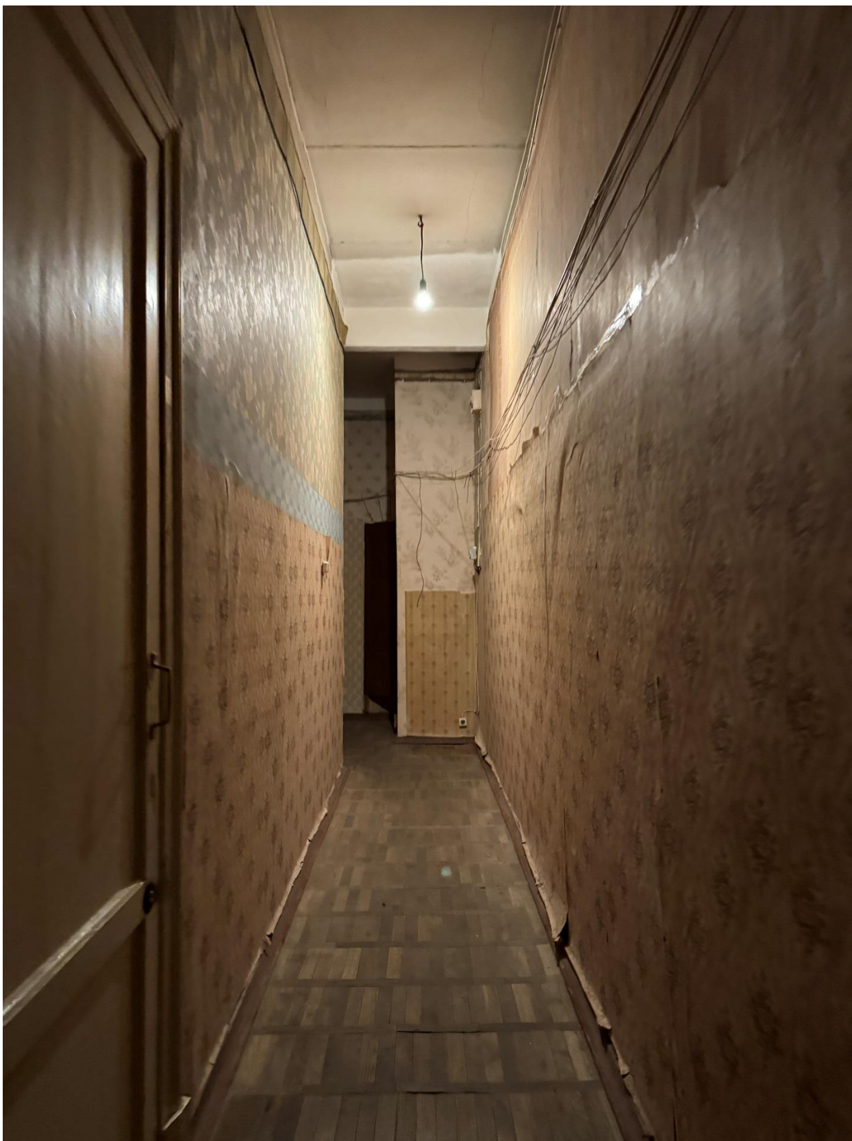
Фото 47. Вид на помещение квартиры № 14 объекта культурного наследия.
