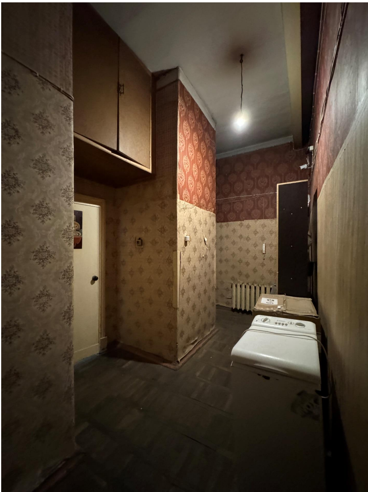
Фото 38. Вид на помещение квартиры № 14 объекта культурного наследия.
