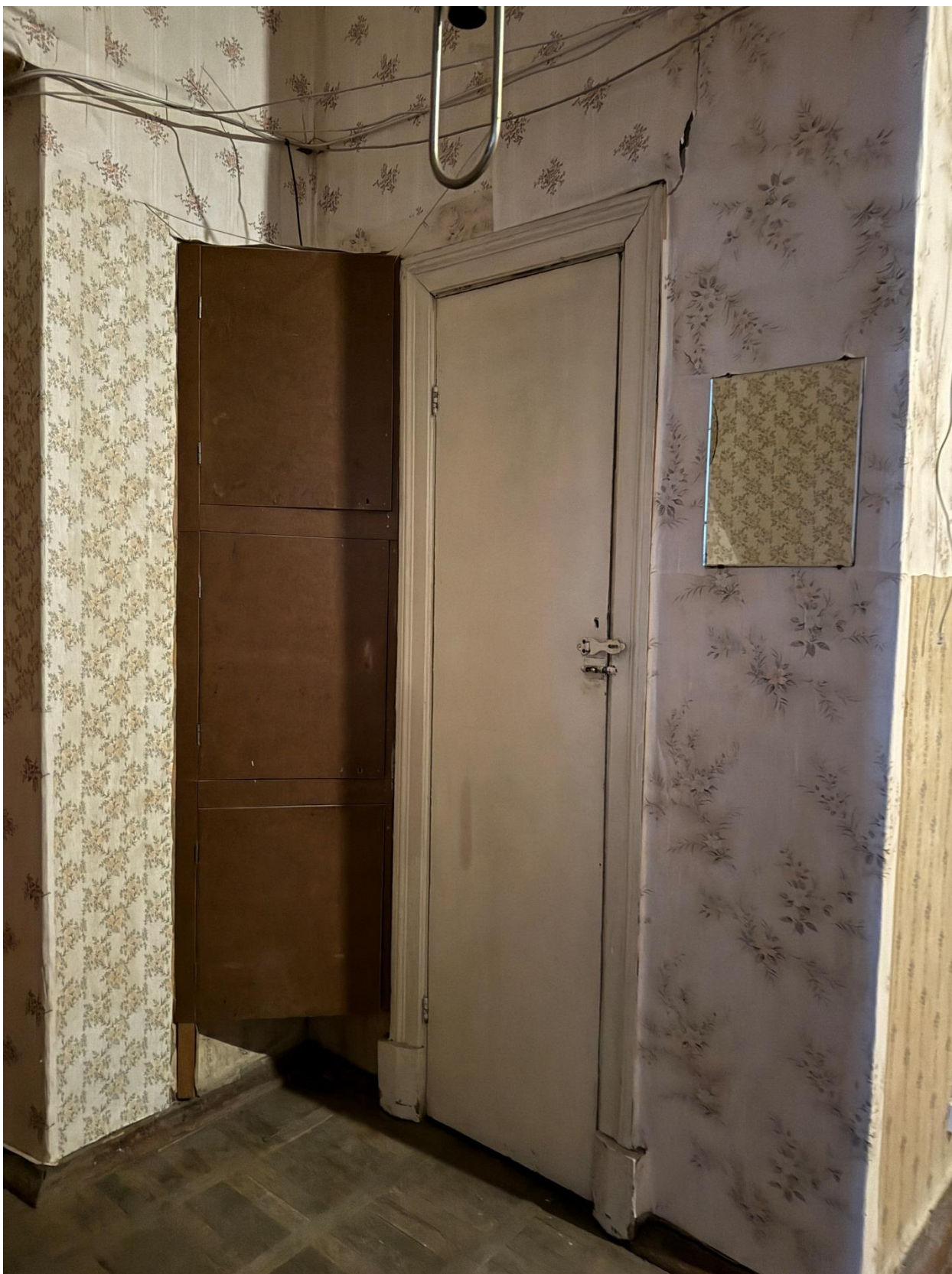
Фото 18. Вид на помещение квартиры № 14 объекта культурного наследия.
