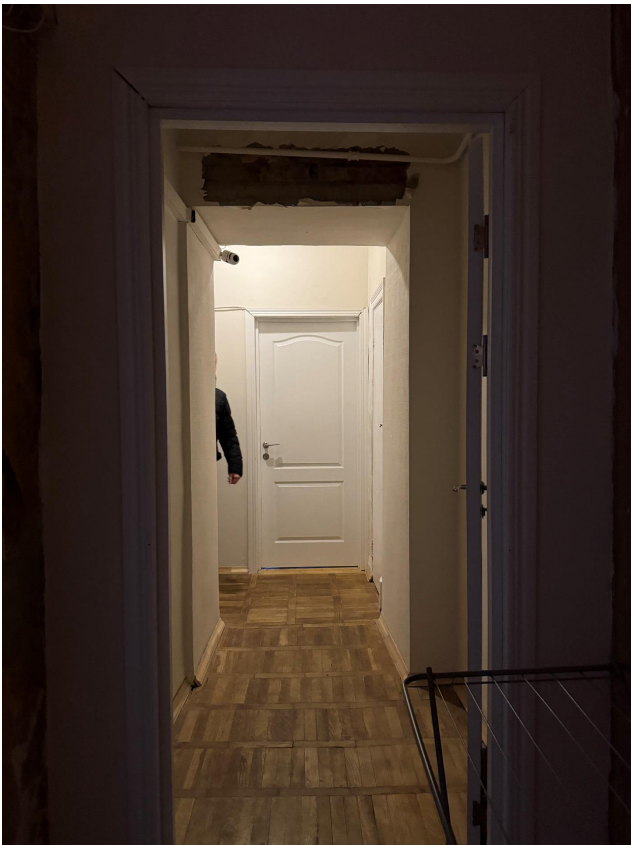
Фото 39. Вид на помещение квартиры № 14 объекта культурного наследия.
