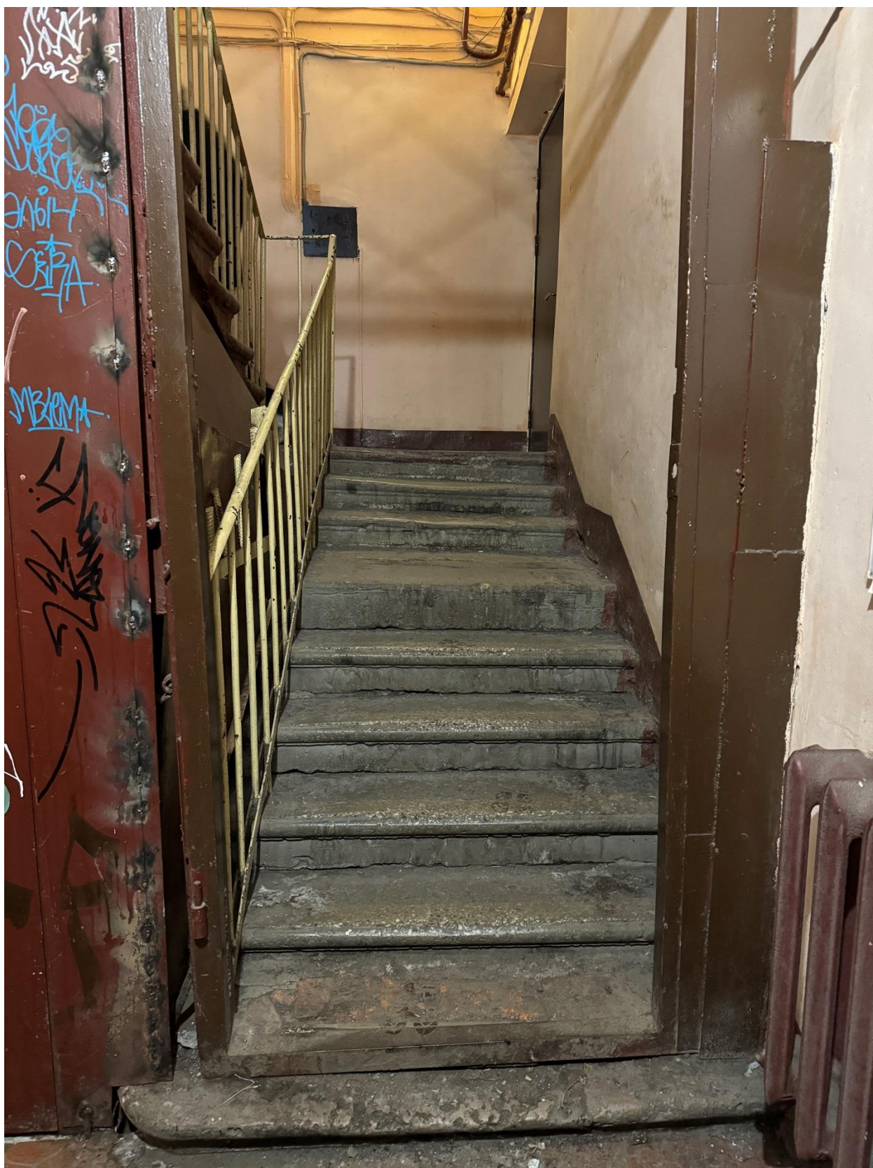
Фото 7. Общий вид лестницы, ведущей в квартиру № 14, объекта культурного наследия.
