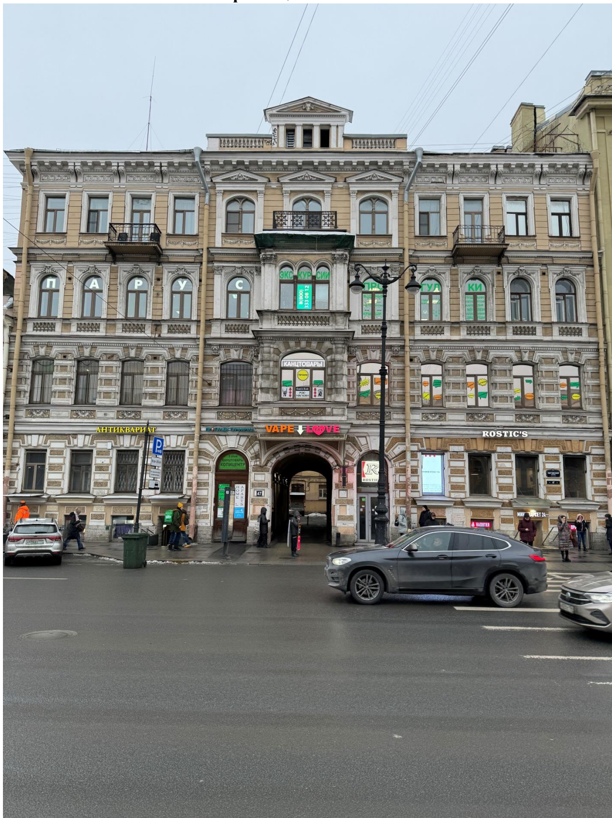
Фото 1. Общий вид фасада объекта культурного наследия по Лиговскому проспекту.
