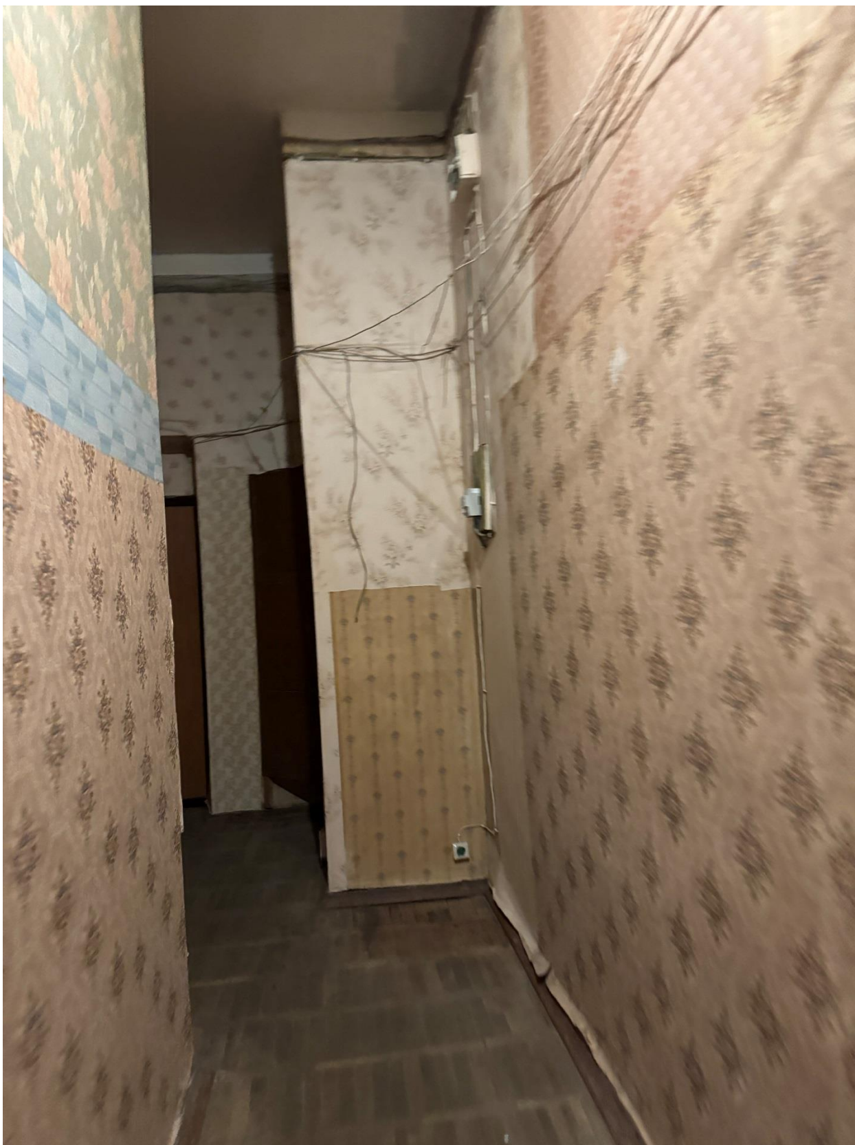
Фото 13. Вид на помещение квартиры № 14 объекта культурного наследия.
