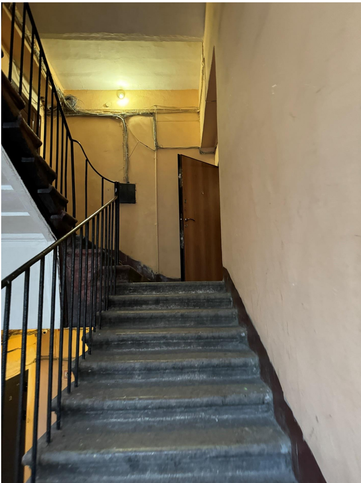
Фото 9. Общий вид лестницы, ведущей в квартиру № 14, объекта культурного наследия.
