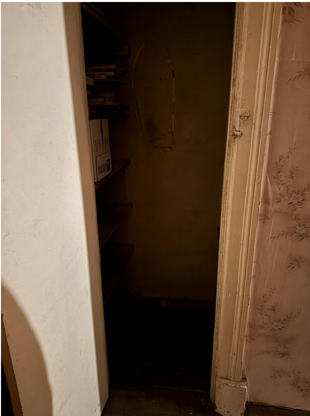
Фото 48. Вид на помещение квартиры № 14 объекта культурного наследия.
