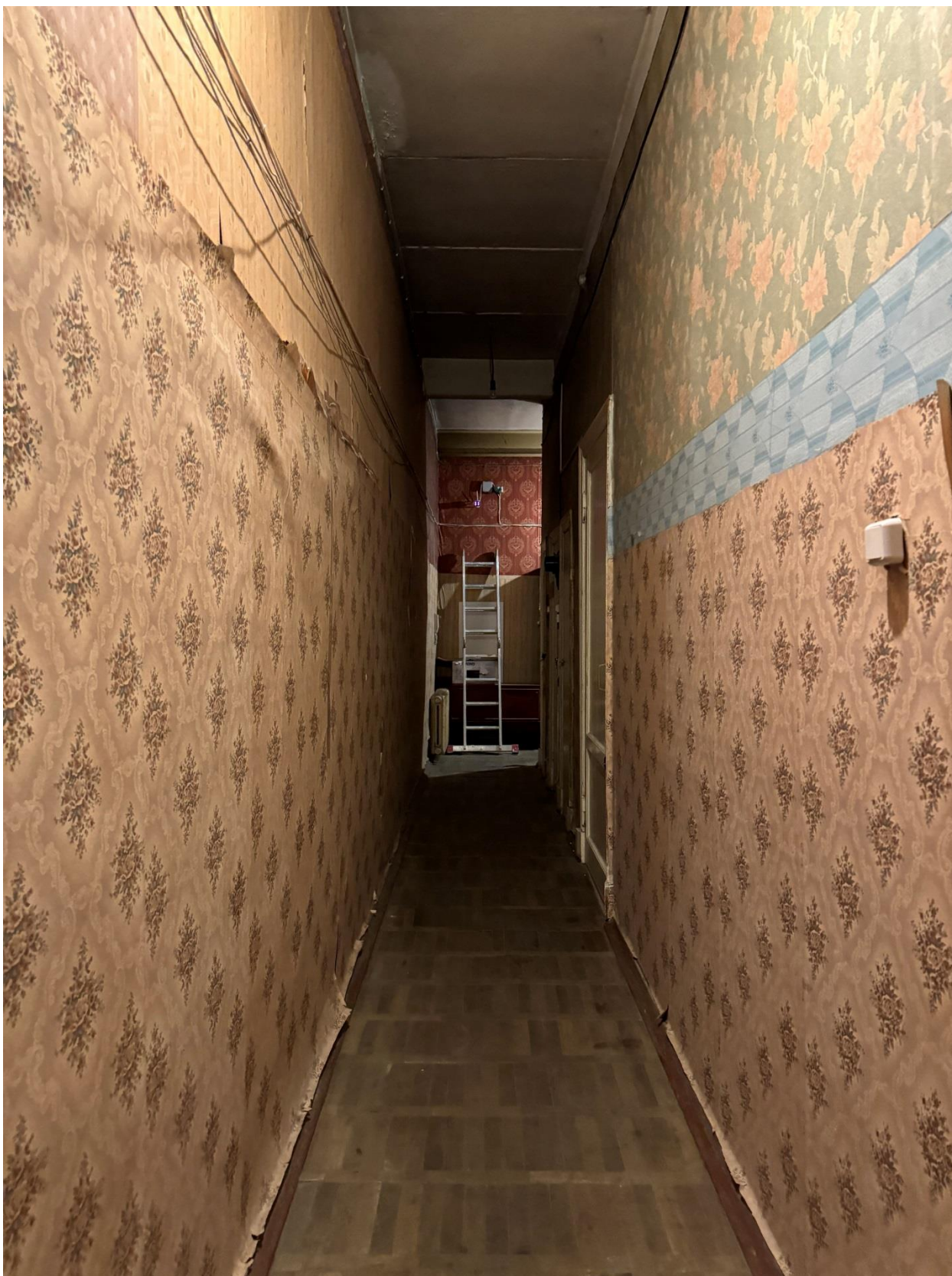
Фото 12. Вид на помещение квартиры № 14 объекта культурного наследия.
