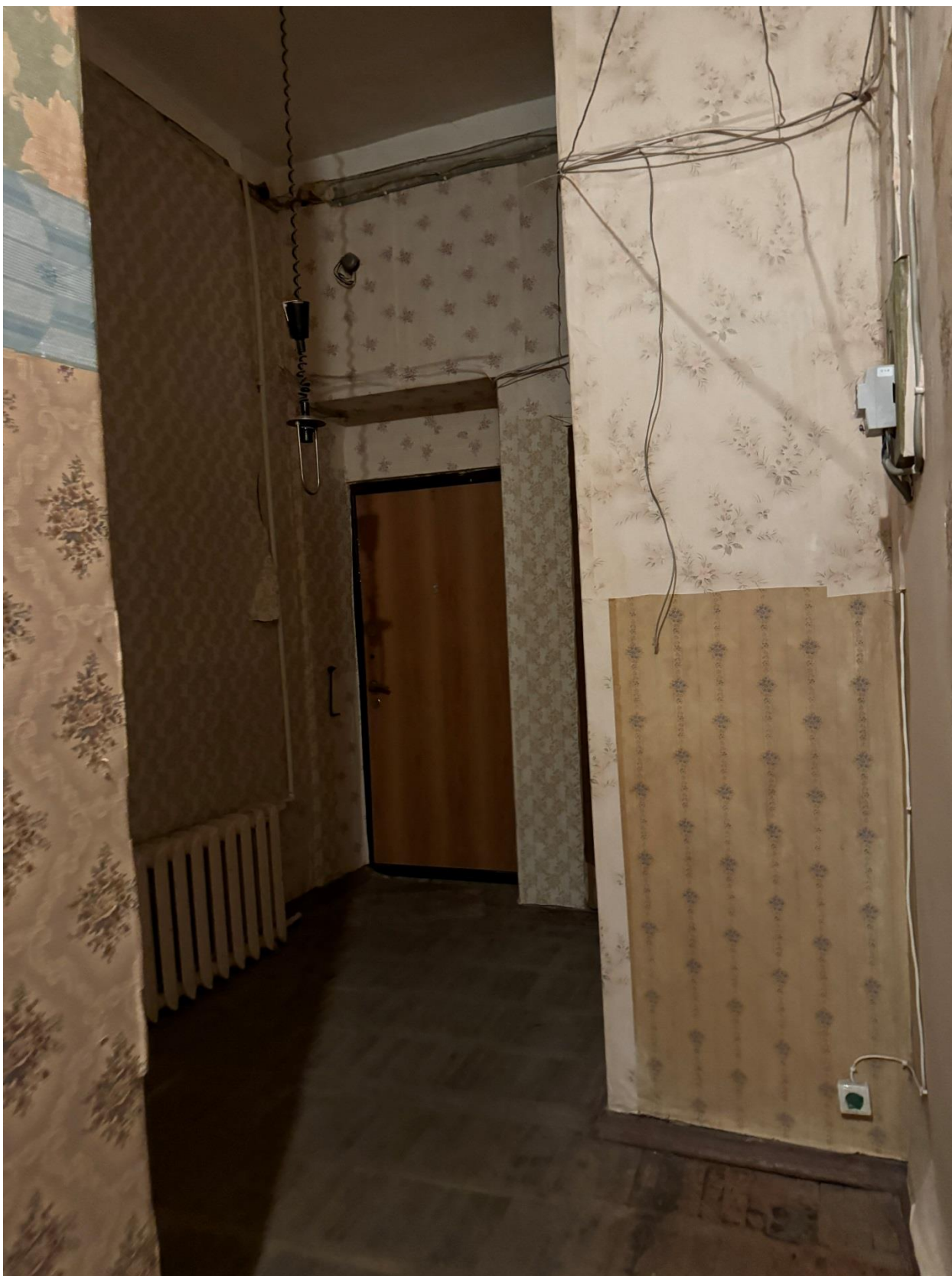
Фото 14. Вид на помещение квартиры № 14 объекта культурного наследия.
