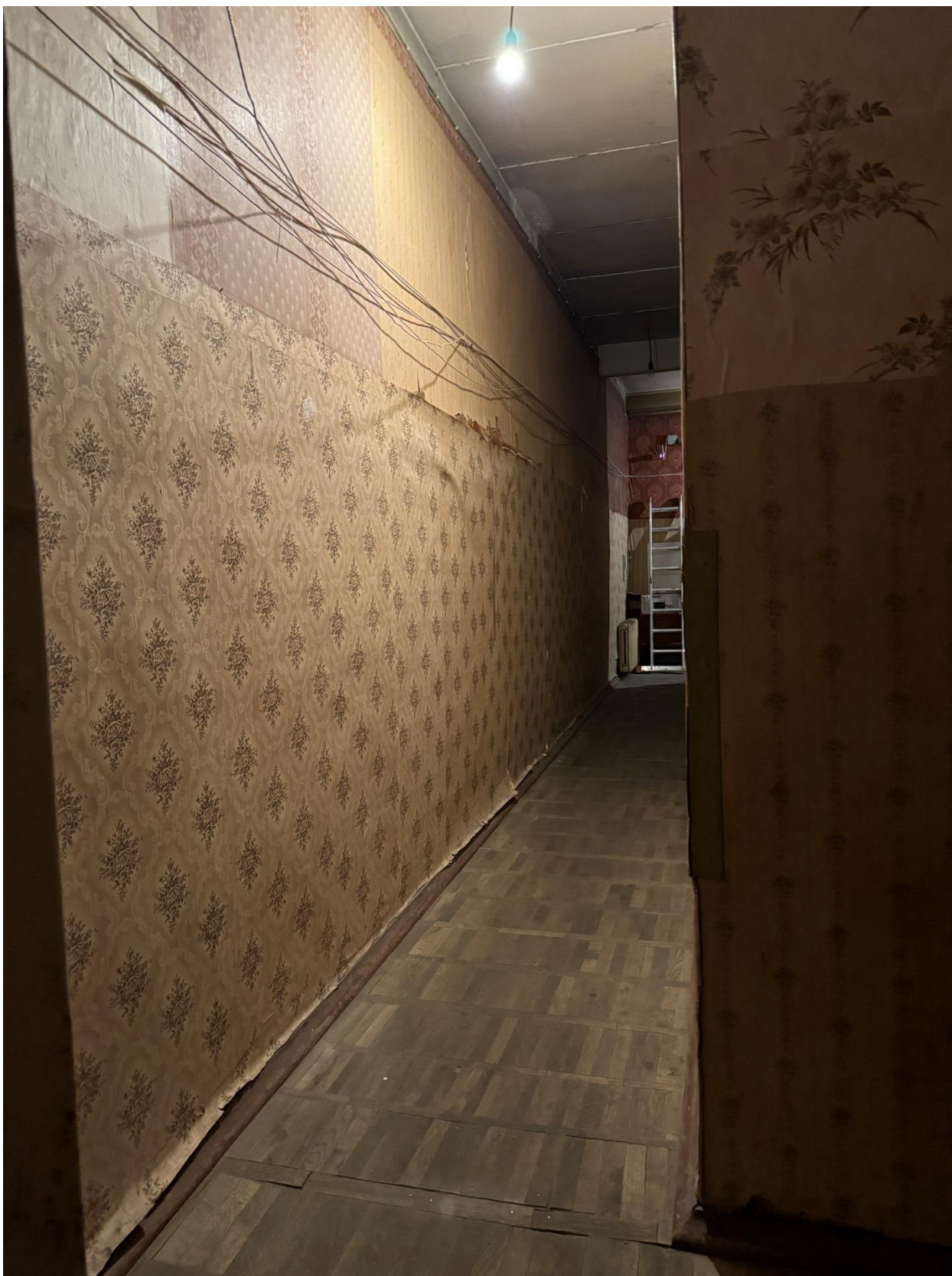
Фото 11. Вид на помещение квартиры № 14 объекта культурного наследия.
