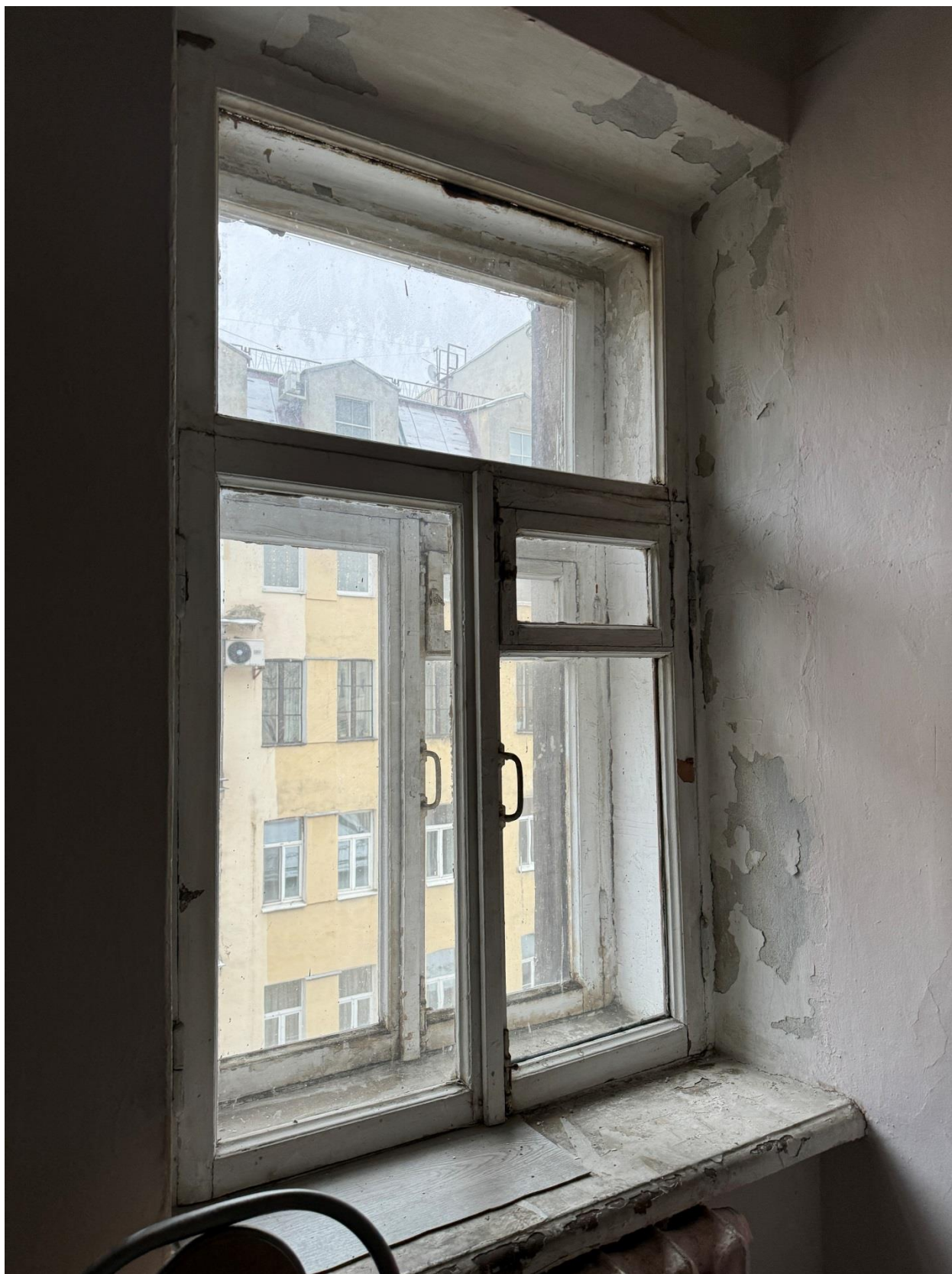
Фото 36. Вид на оконное заполнение квартиры № 14 объекта культурного наследия.
