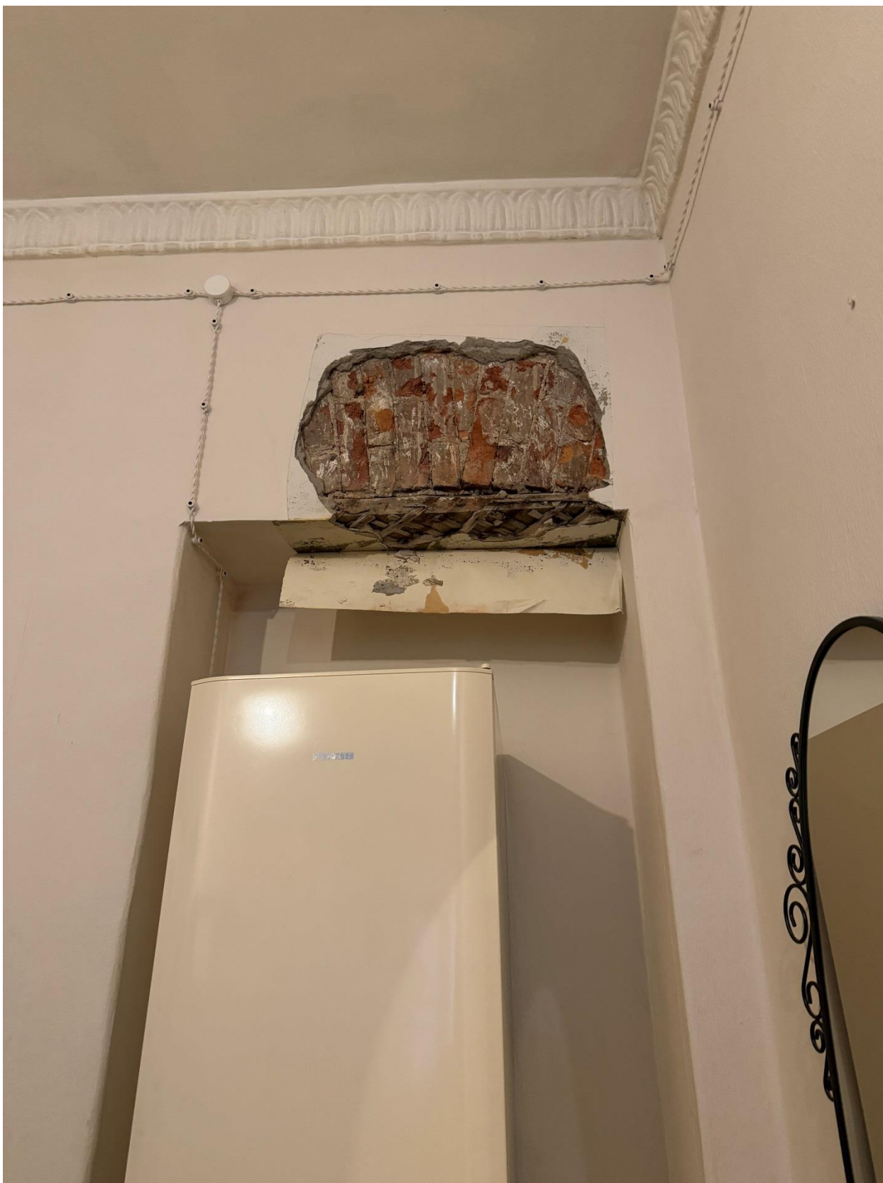
Фото 42. Вид на помещение квартиры № 14 объекта культурного наследия.
