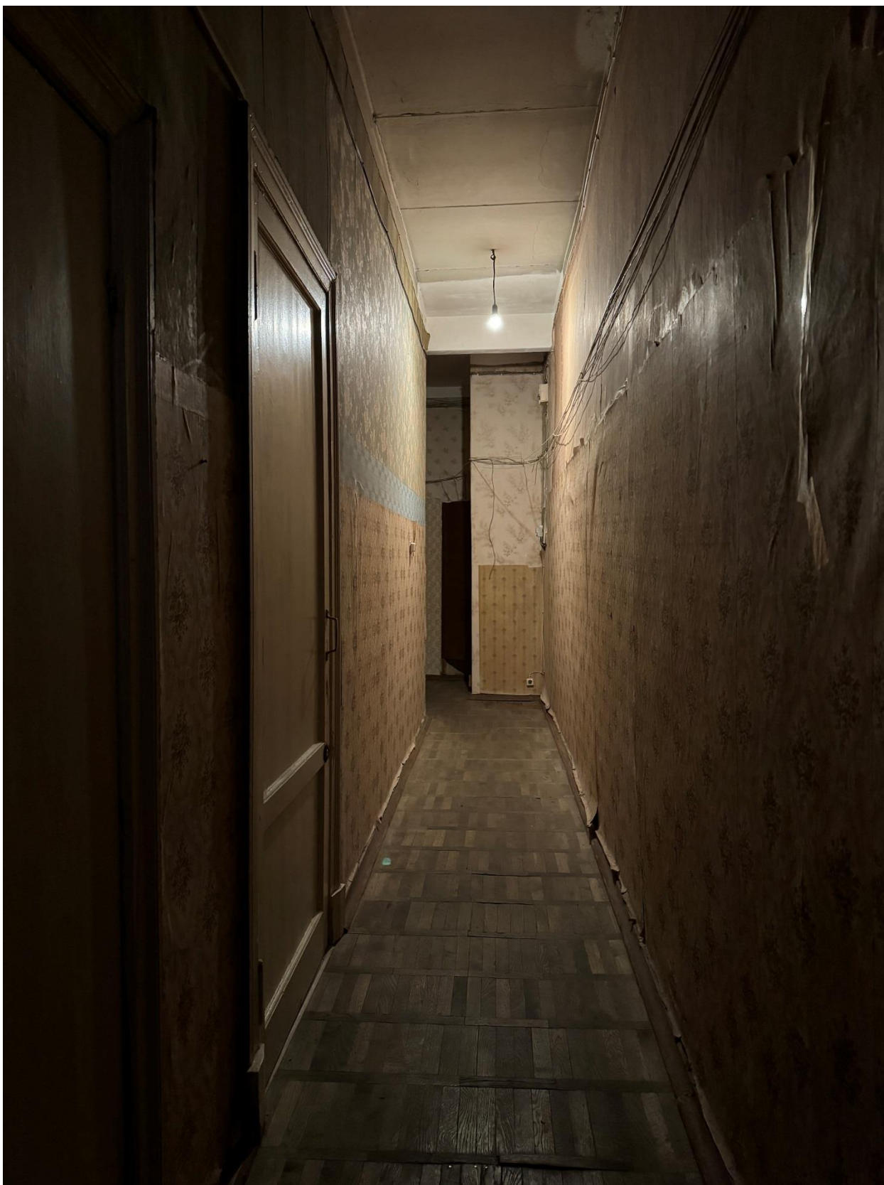
Фото 28. Вид на помещение квартиры № 14 объекта культурного наследия.
