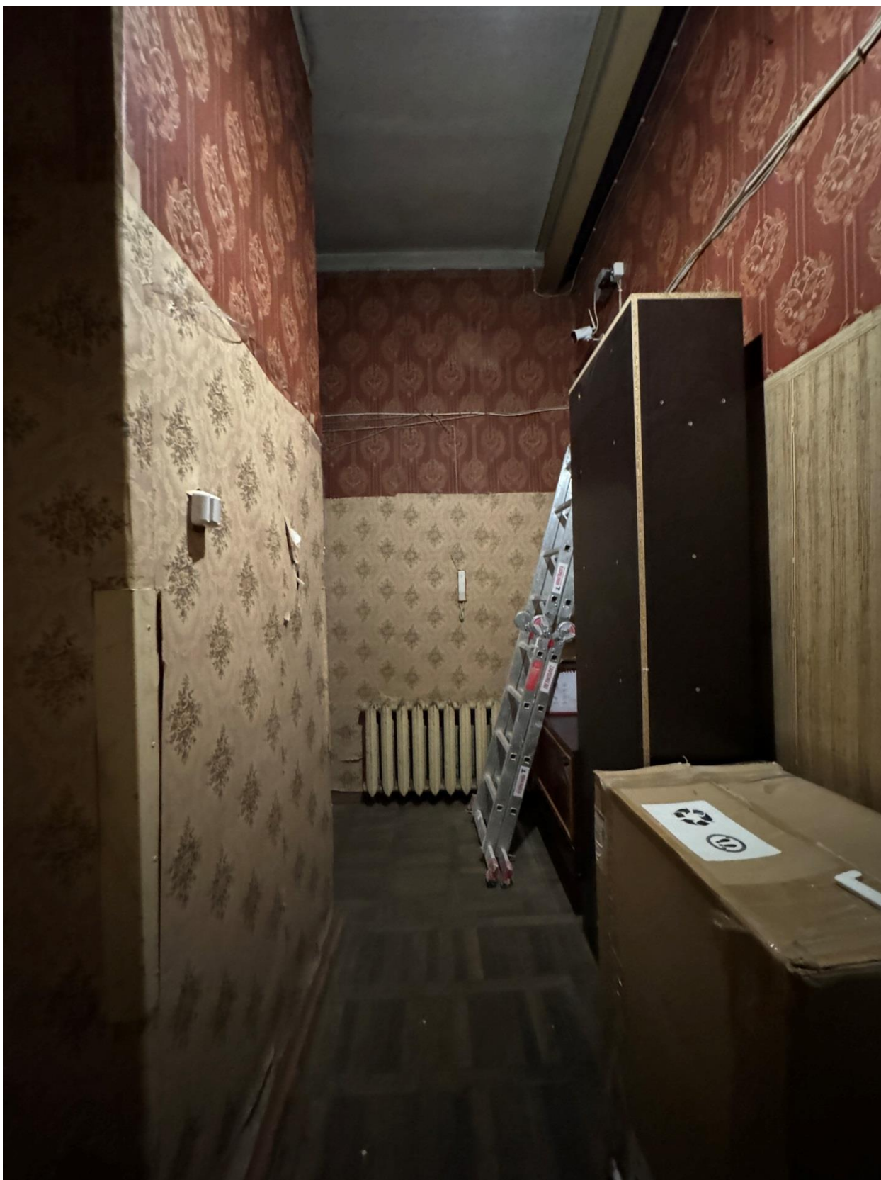
Фото 33. Вид на помещение квартиры № 14 объекта культурного наследия.
