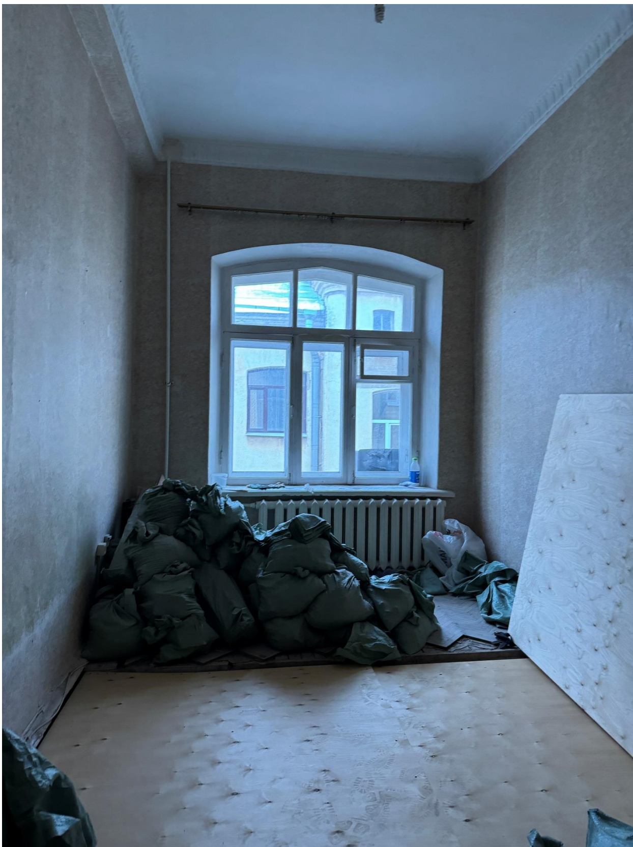
Фото 15. Вид на помещение квартиры № 14 объекта культурного наследия.
