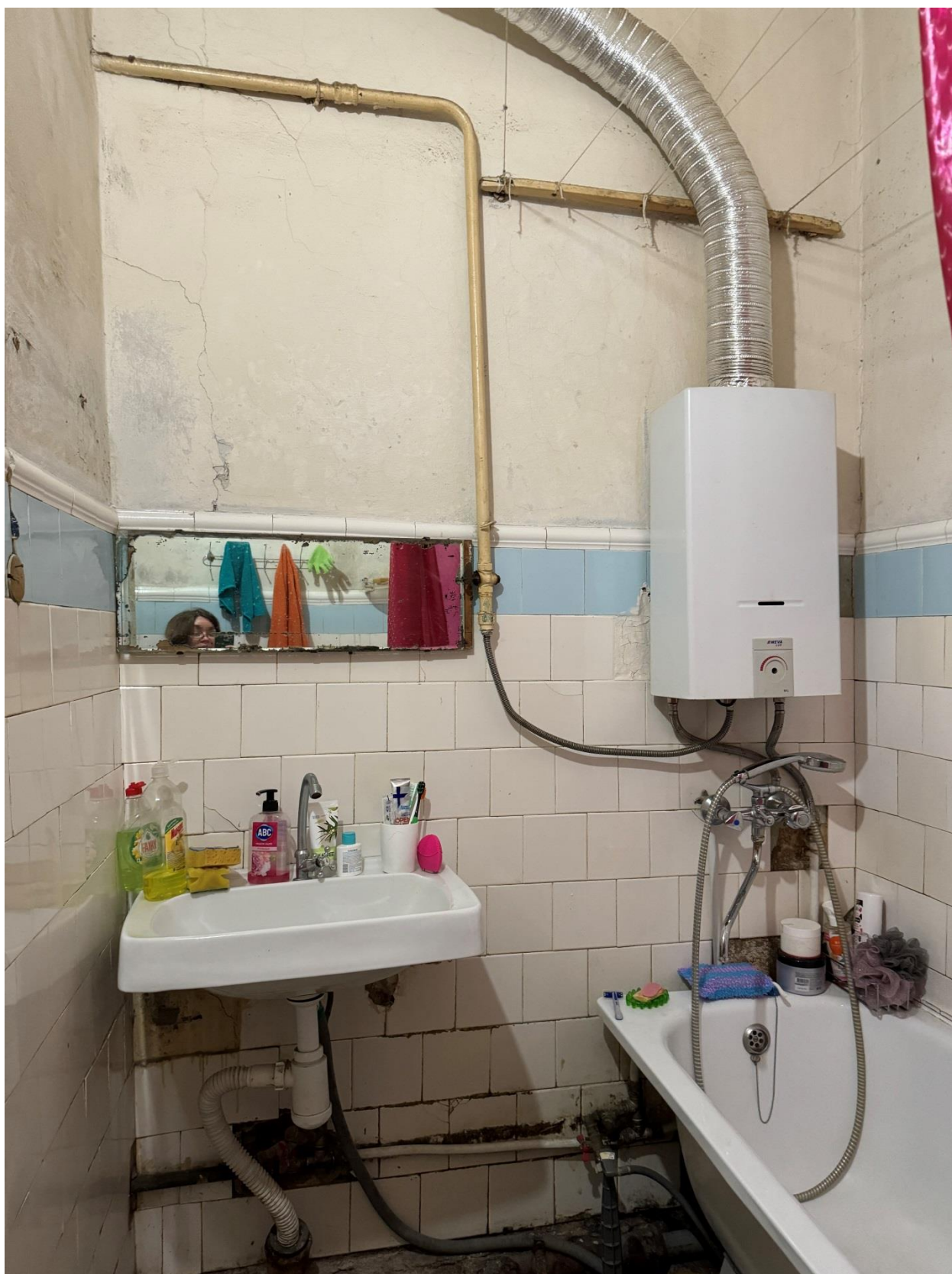
Фото 30. Вид на помещение квартиры № 14 объекта культурного наследия.
