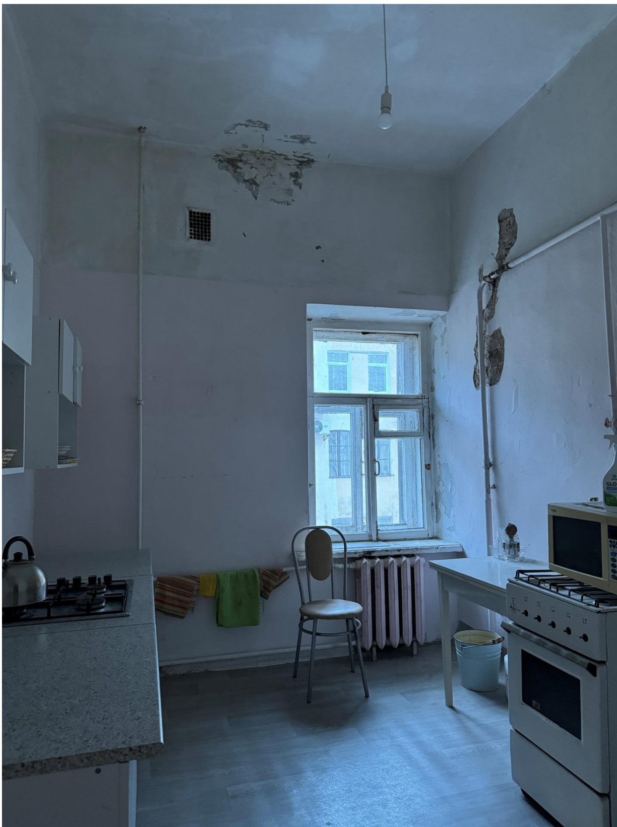
Фото 35. Вид на помещение квартиры № 14 объекта культурного наследия.
