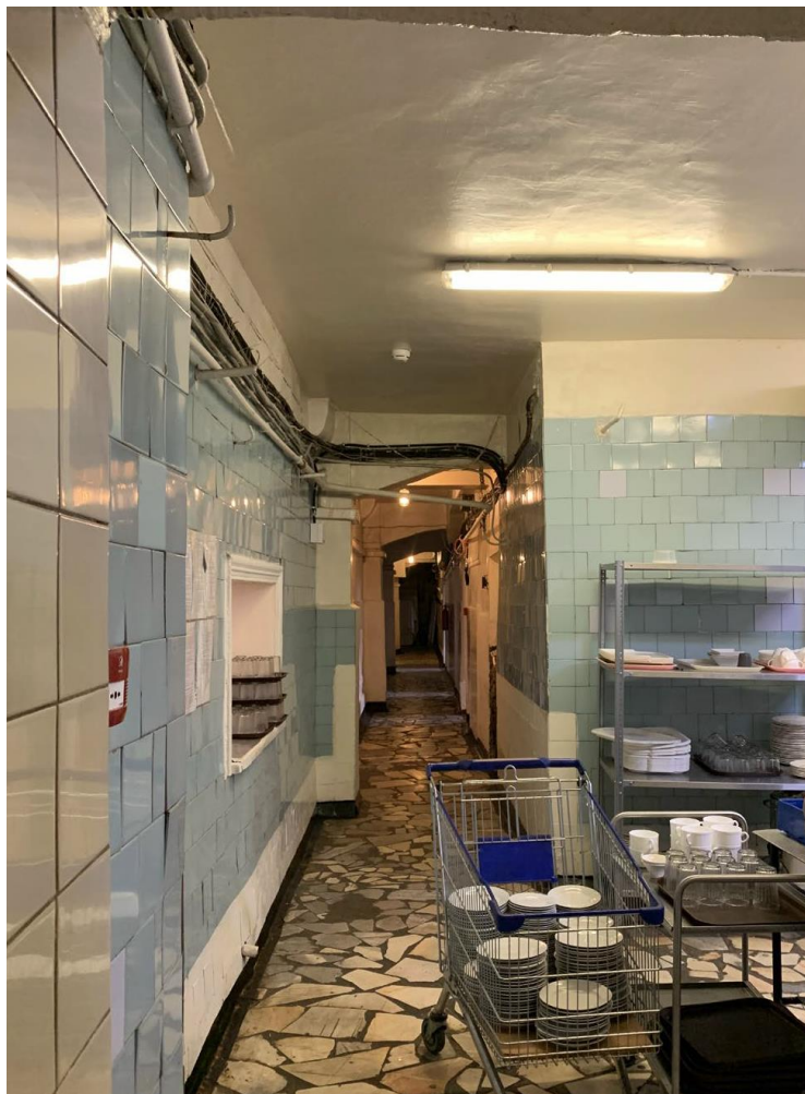
15. Выявленный объект культурного наследия «Здание школы» по адресу: Санкт-Петербург, Балтийская ул., д. 35, лит. А (Балтийская ул., 35). Столовая. Коридор в кухонной зоне (общий вид). Вид на арку с опорой на пилоны (помещение №53).
