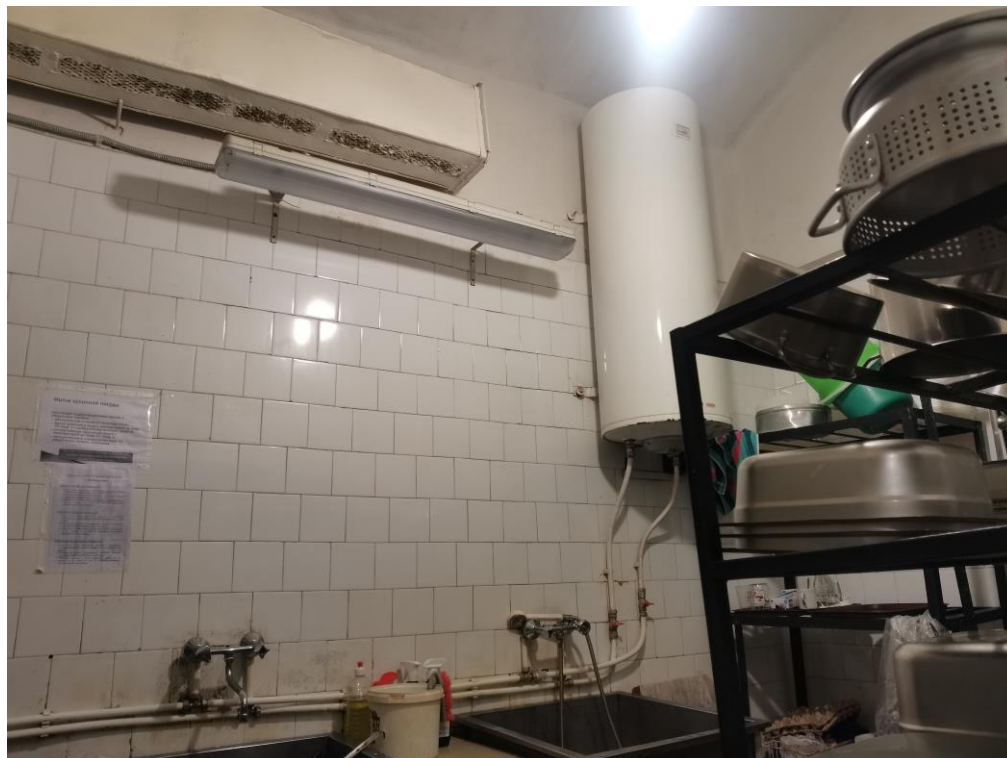
20. Выявленный объект культурного наследия «Здание школы» по адресу: Санкт-Петербург, Балтийская ул., д. 35, лит. А (Балтийская ул., 35). Столовая. Моечная (помещение №37).
