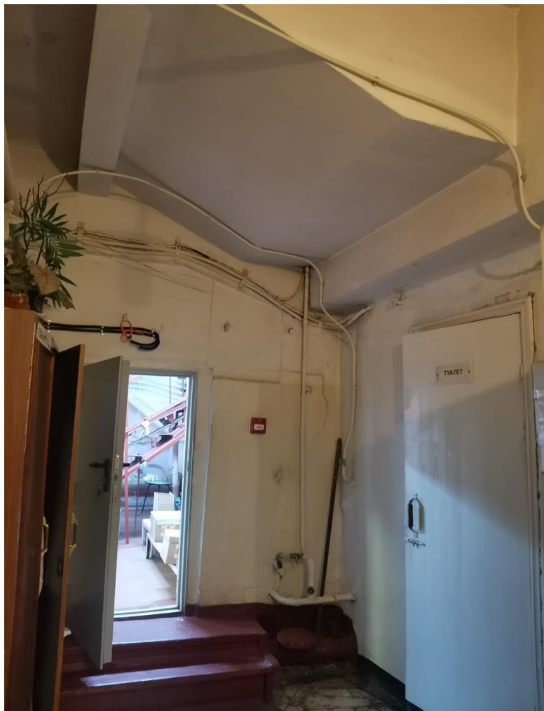
35. Выявленный объект культурного наследия «Здание школы» по адресу: Санкт-Петербург, Балтийская ул., д. 35, лит. А (Балтийская ул., 35). Столовая. Выход на склад (помещение №39). Вид на деревянную крашеную лестницу с двумя ступенями.
