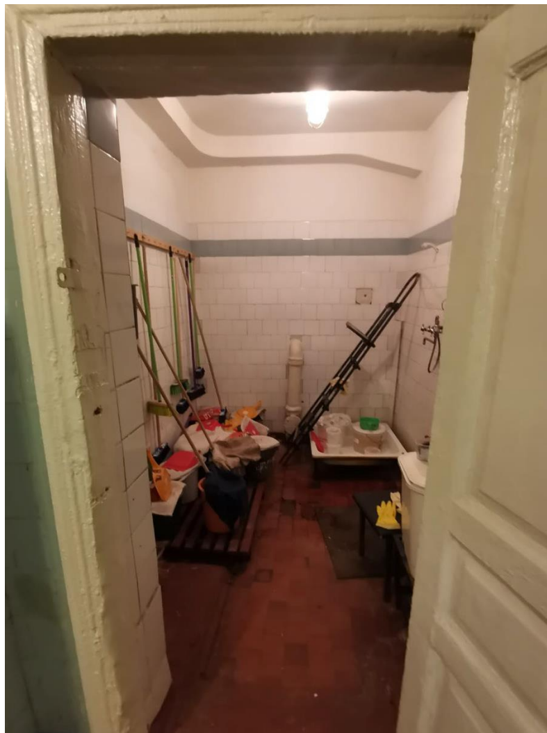
38. Выявленный объект культурного наследия «Здание школы» по адресу: Санкт-Петербург, Балтийская ул., д. 35, лит. А (Балтийская ул., 35). Столовая. Помещение душевой и инвентарной (помещение №46). Общий вид.
