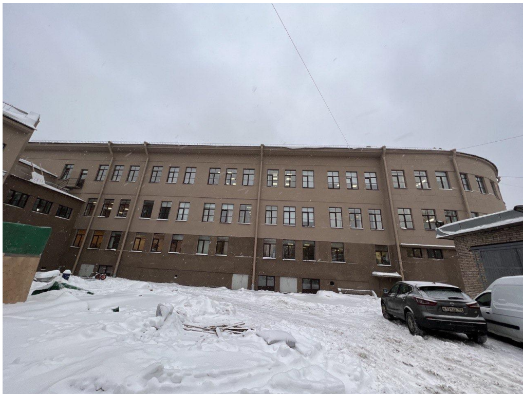
7. Выявленный объект культурного наследия «Здание школы» по адресу: Санкт-Петербург, Балтийская ул., д. 35, лит. А (Балтийская ул., 35). Вид на западный фасад.
