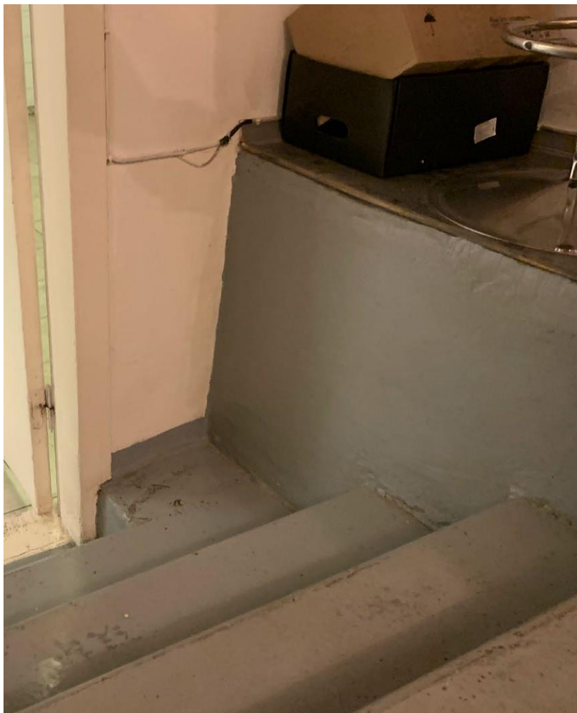
14. Выявленный объект культурного наследия «Здание школы» по адресу: Санкт-Петербург, Балтийская ул., д. 35, лит. А (Балтийская ул., 35). Помещение бухгалтерии (помещение №62). Фрагмент интерьера.
