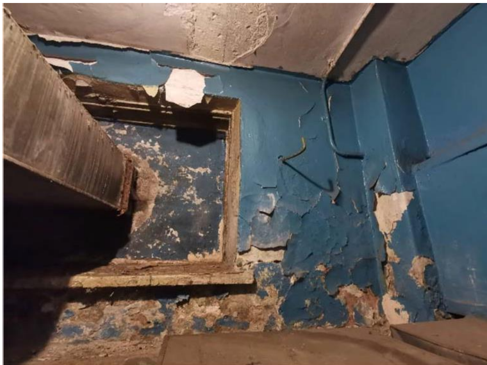
42. Выявленный объект культурного наследия «Здание школы» по адресу: Санкт-Петербург, Балтийская ул., д. 35, лит. А (Балтийская ул., 35). Столовая. Вентшахта (помещение №52). Фрагмент интерьера.
