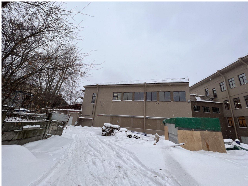
9. Выявленный объект культурного наследия «Здание школы» по адресу: Санкт-Петербург, Балтийская ул., д. 35, лит. А (Балтийская ул., 35). Общий вид на западный объем.
