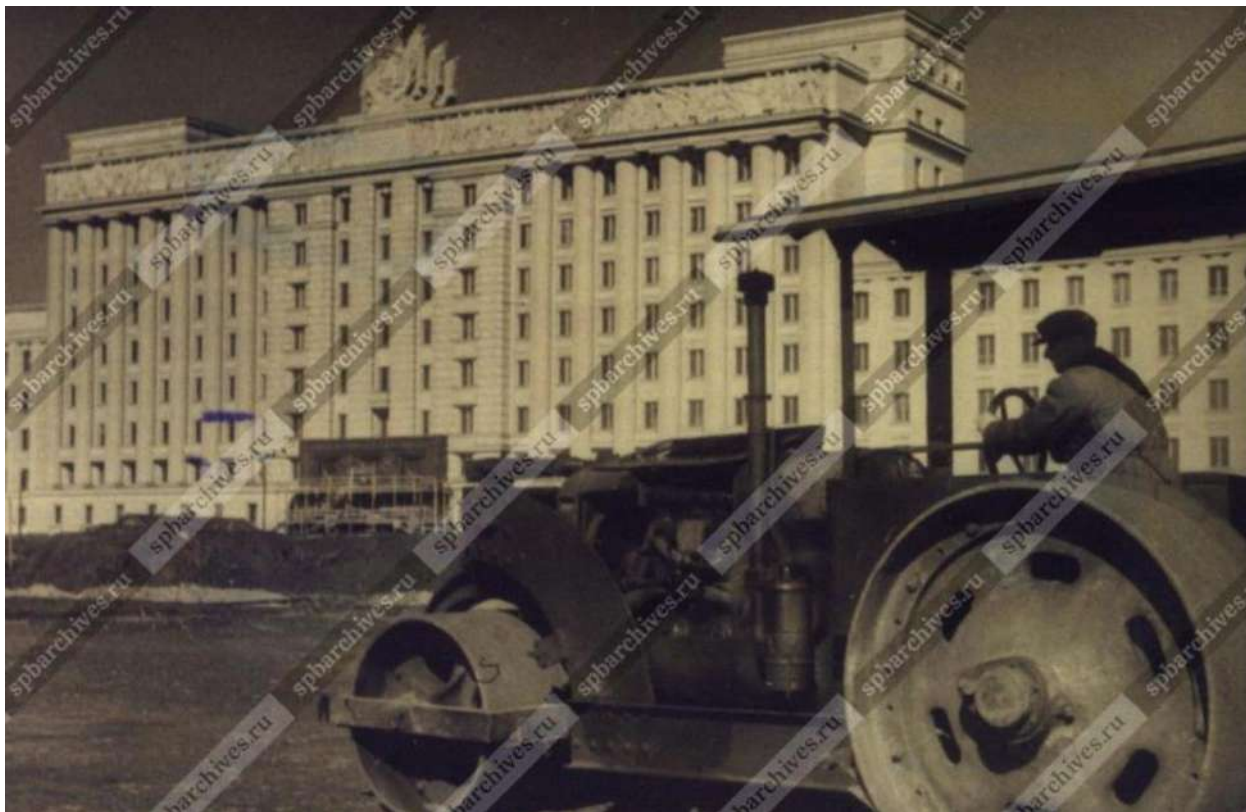
Илл. 60. Работы по устройству площади перед Домом Советов на Международном проспекте. Дата съёмки: 15 мая 1941 г. // ЦГАКФФД СПб. Архивный шифр: Ар 34170
