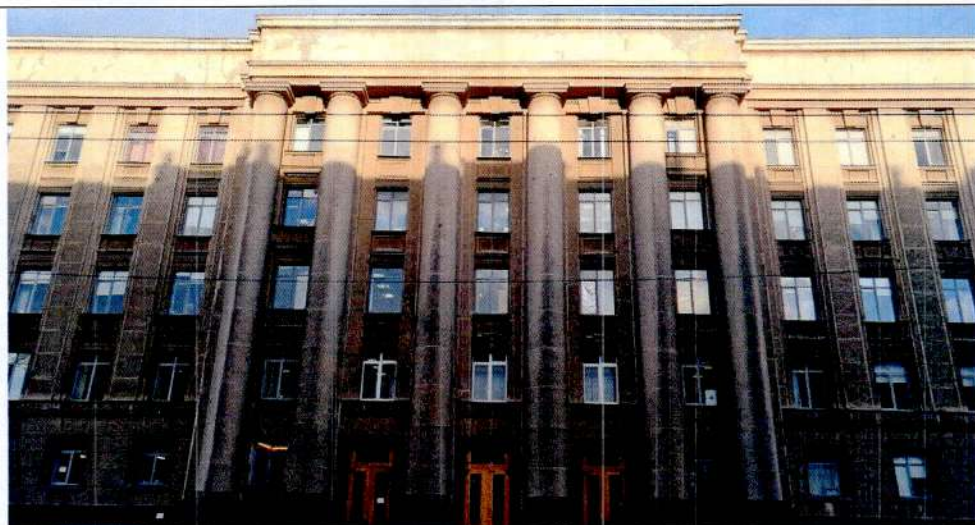
4. Фрагмент южного фасада
