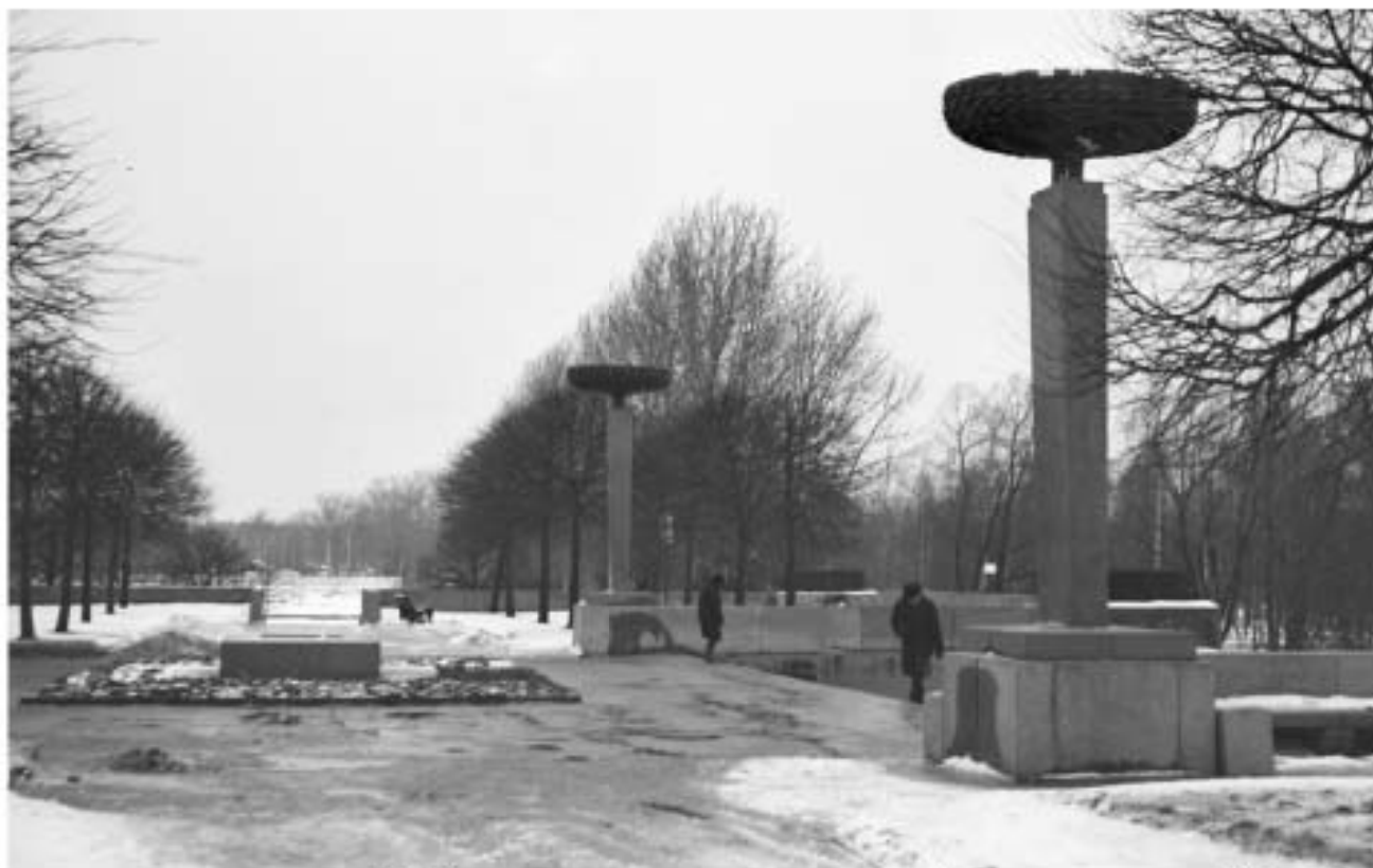
54. Завершения подпорных стенок – обелиски с чашами. 1974г. // Архив ОАО «ЛенНИИПроект».
