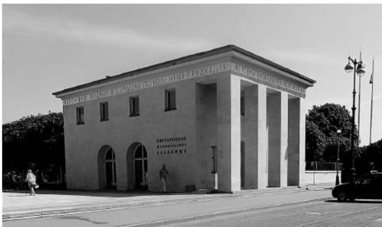
34. Объект культурного наследия федерального значения «Кладбище Пискаревское», расположенный по адресу: Санкт-Петербург, проспект Непокорённых, дом 72. Боковой фасад правого здания павильонов-пропилеев в южной (входной) части мемориала. Вид с запада. Дата дополнительной съемки: 21.06.2023.
