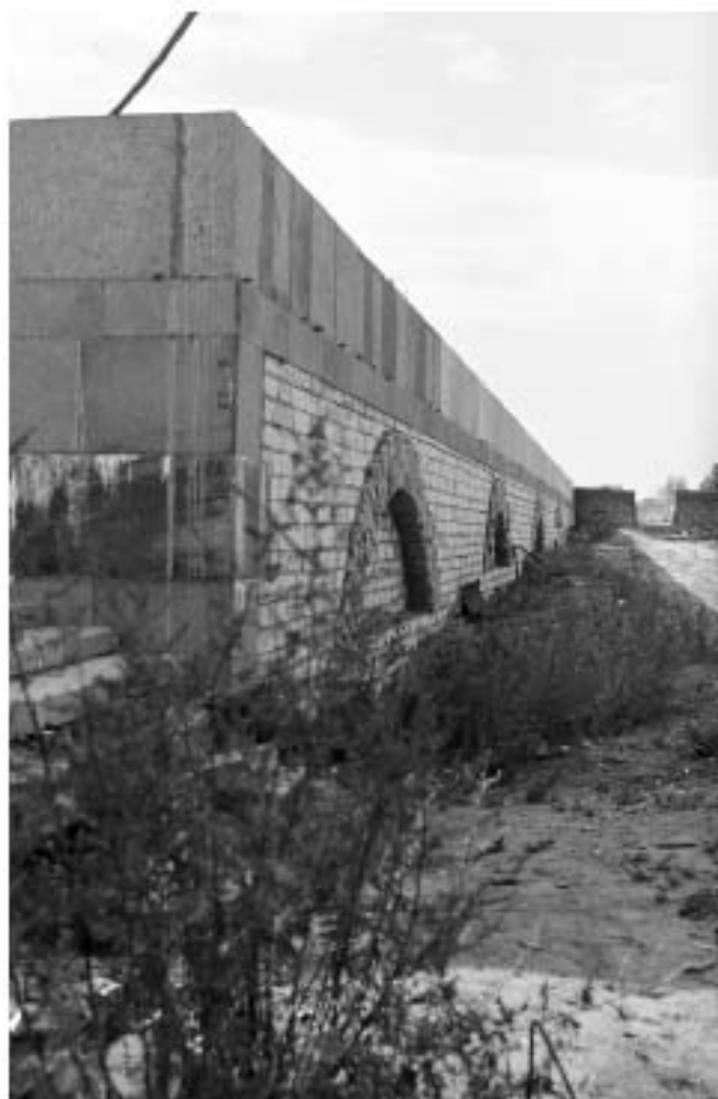
21. Оформление фасада подпорной стенки в сторону Большого пруда. 1959г. // Архив ОАО «ЛенНИИПроект».
