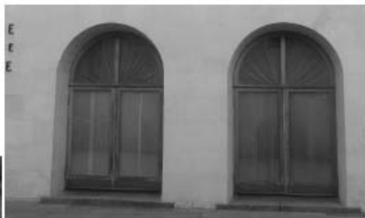
Оконные проемы первого этажа боковых фасадов павильонов. Съёмка 20.08.2012, К.С. Евтеев.
