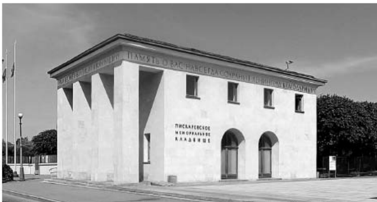
33. Объект культурного наследия федерального значения «Кладбище Пискаревское», расположенный по адресу: Санкт-Петербург, проспект Непокорённых, дом 72. Боковой фасад левого здания павильонов-пропилеев в южной (входной) части мемориала. Вид с востока. Дата дополнительной съемки: 21.06.2023.
