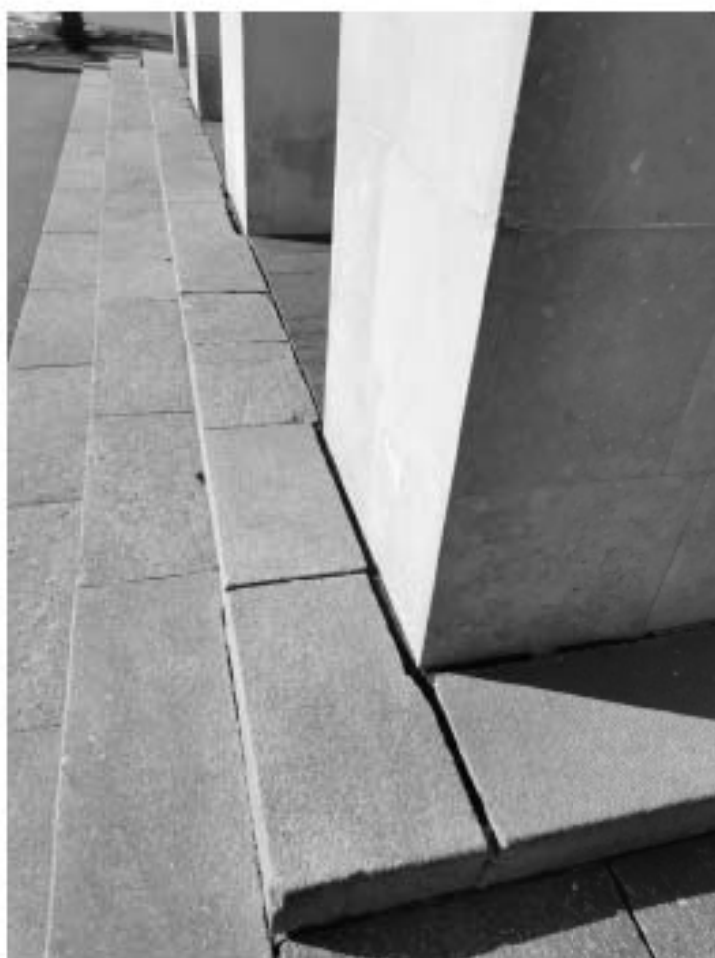
2. Объект культурного наследия федерального значения «Кладбище Пискаревское», расположенный по адресу: Санкт-Петербург, проспект Непокорённых, дом 72. Боковой фасад правого здания павильонов-пропилеев в южной (входной) части мемориала. Цоколь. Дата съемки: 05.04.2023.
