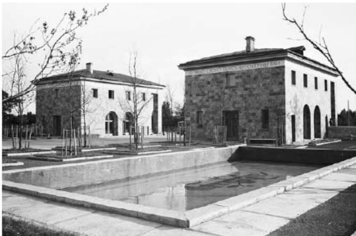
26. Вид на бассейн и павильоны-пропилеи у входа в некрополь Пискаревского мемориального кладбища (арх. Е.А. Левинсон, А.В. Васильев, ск. В.В. Исаева, Р.К. Таурит, Б.Е. Каплинский, А.Л. Малахген, М.А. Вайман, М.М. Харламова). 1960г. ЦГАКФФД СПб. Бр 67275.
