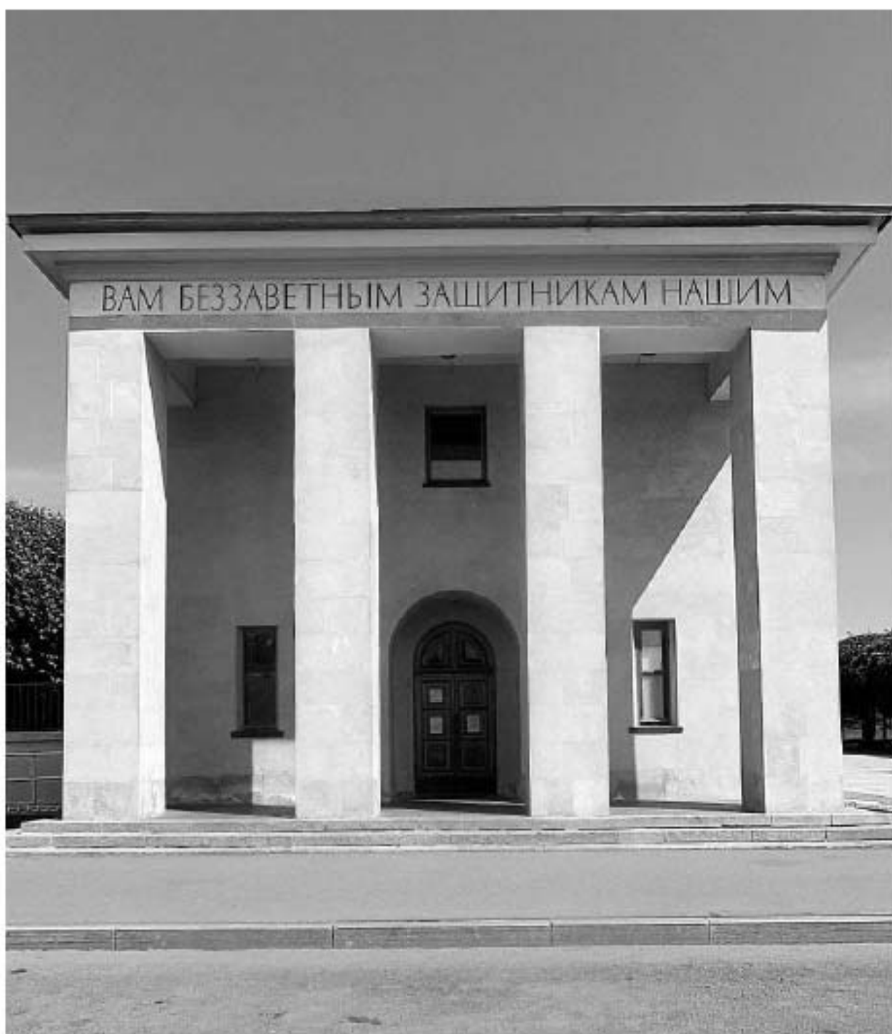
35. Объект культурного наследия федерального значения «Кладбище Пискаревское», расположенный по адресу: Санкт-Петербург, проспект Непокорённых, дом 72. Главный фасад левого здания павильонов-пропильев в южной (входной) части мемориала. Вид с юга.
