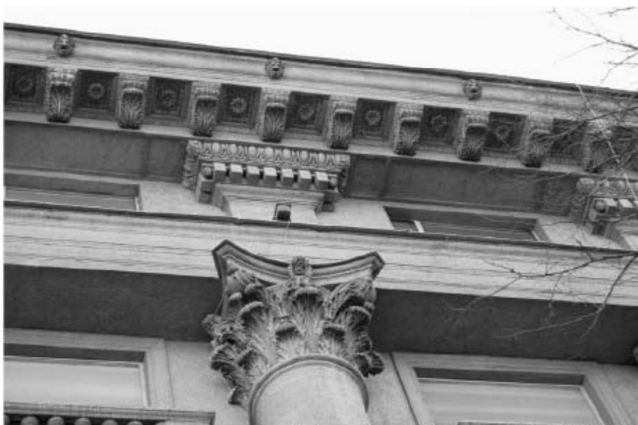
92. Лицевой фасад. Фрагмент. 2010г. ООО «БРК».
