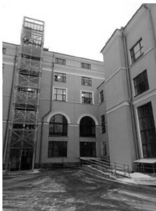
32. ОКНРЗ «Дворец пушкинью». Центральный полуциркульный ризалит восточного фасада. Вид на север. 15.01.2024г.
