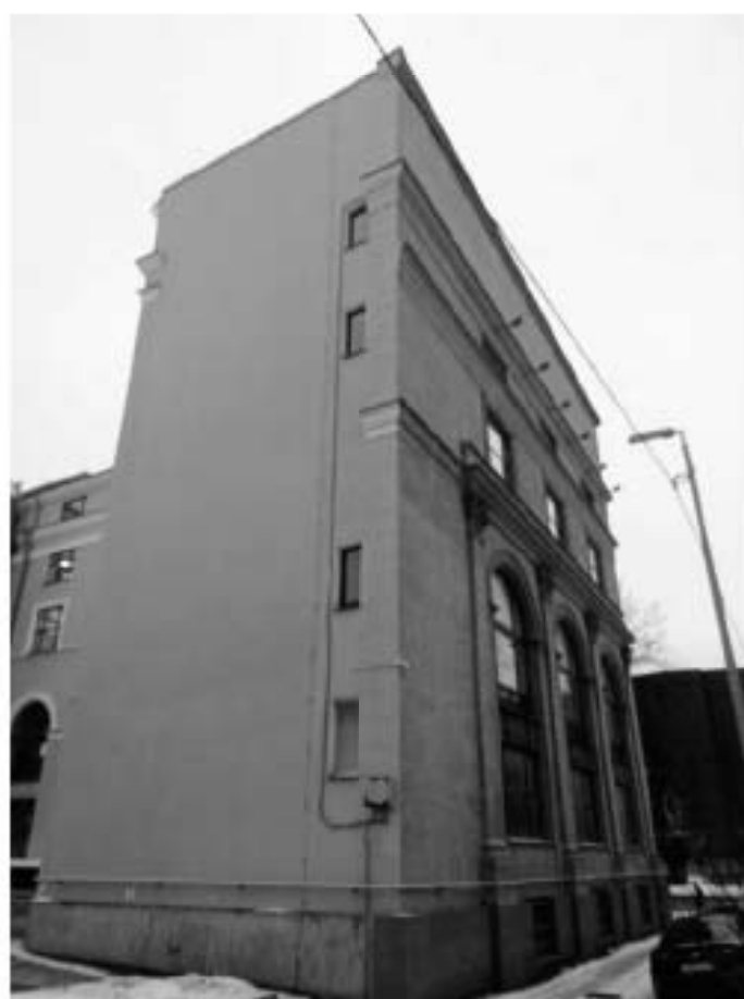
25. ОКНРЗ «Дворец пушкинны». Северный фасад. Вид на юго-запад. 15.01.2024г.
