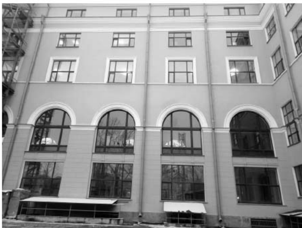
38. ОКНРЗ «Дворец пушкинь». Фрагмент северной части восточного фасада. 15.01.2024г.
