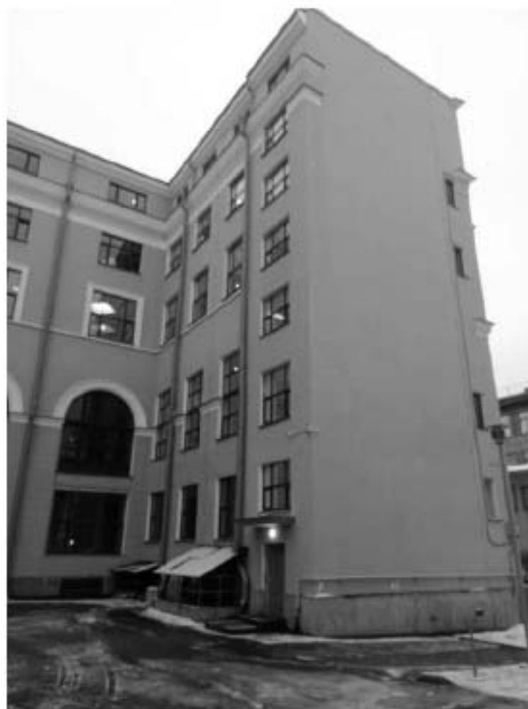
41. ОКНРЗ «Дворец пушкинъ». Торец северного ризалита восточного фасада. Вид на северо-запад. 15.01.2024г.
