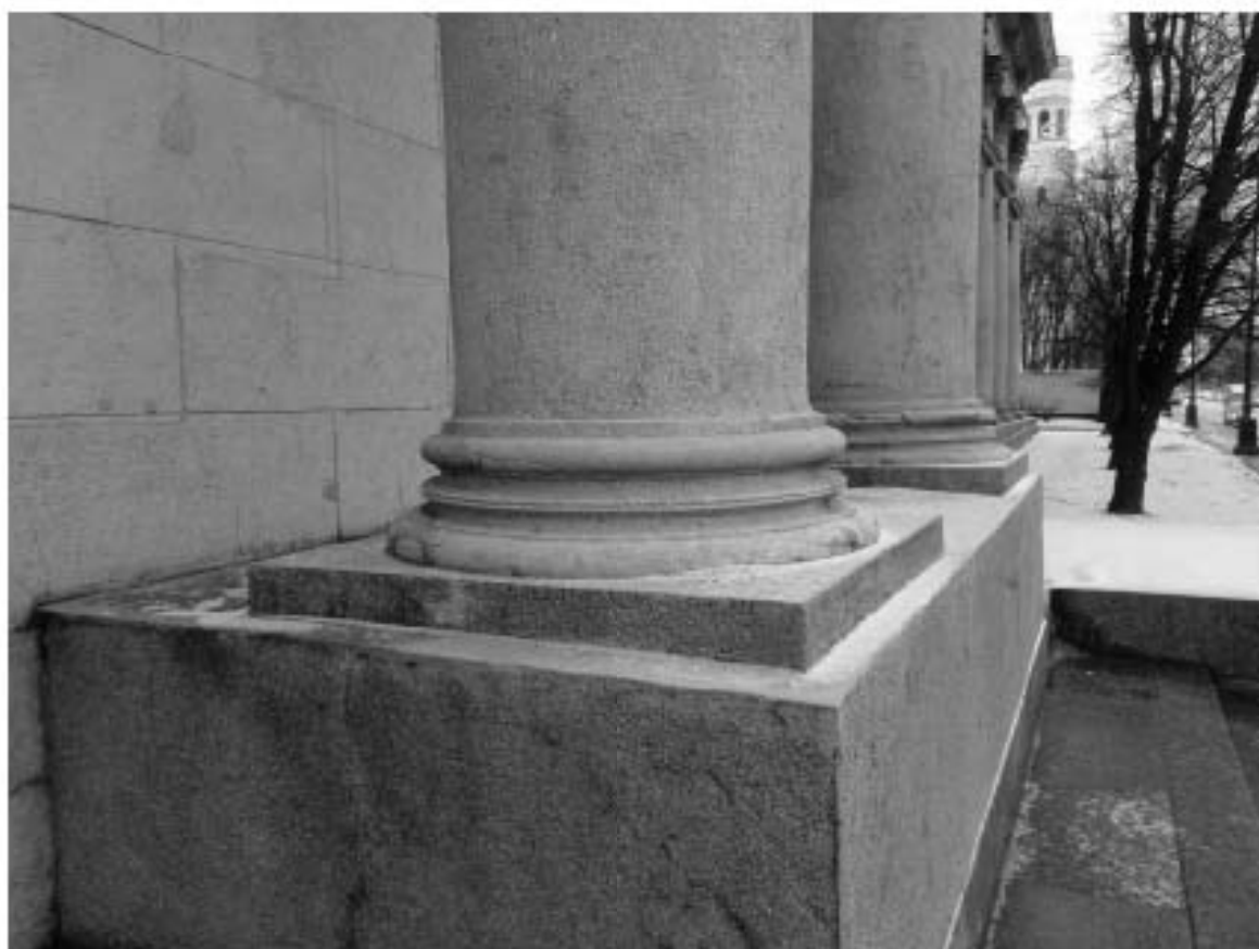
7. ОКНРЗ «Дворец пушкинъ». Южная часть западного фасада. Вид на юго-восток 15.01.2024г.
