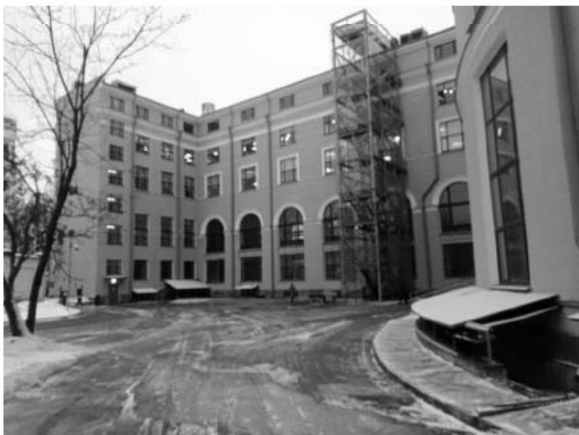
31. ОКНРЗ «Дворец пушкинъ». Южная часть восточного фасада. Вид на запад. 15.01.2024г.
