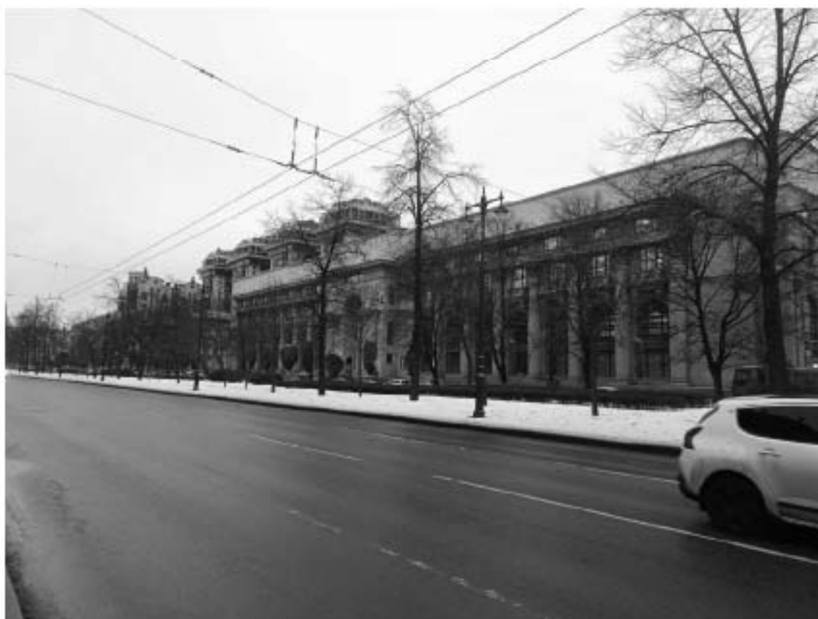
3. ОКНРЗ «Дворец пушкинъ». Южная часть западного фасада. Вид на северо-восток с Московского проспекта. 15.01.2024г.
