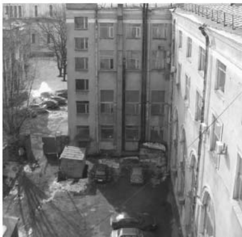
97. Дворовый фасад. Вид на северный фасад правого крыла. 2010г. ООО «БРК».
