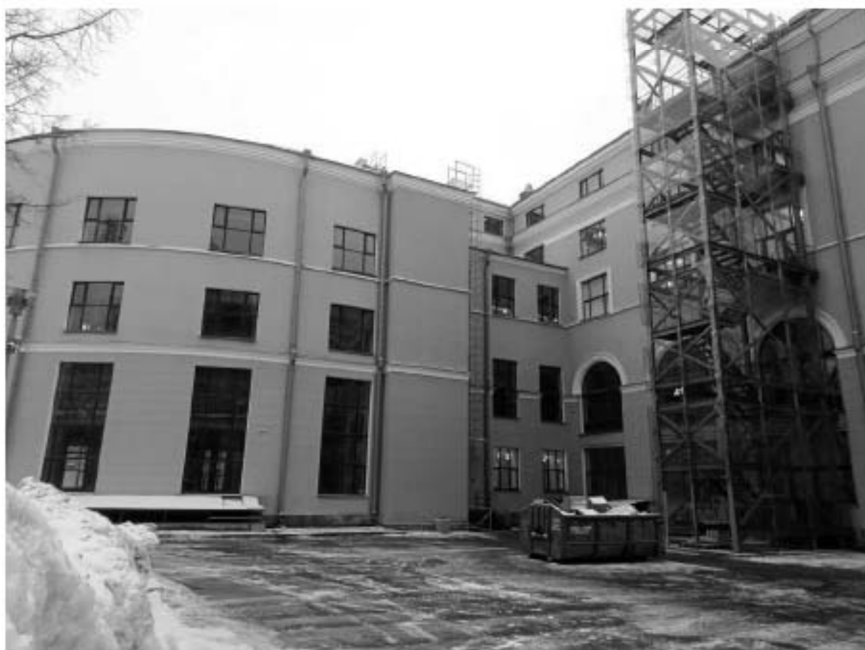
39. ОКНРЗ «Дворец пушкинъ». Фрагмент северной части восточного фасада. Вид на юго-запад. 15.01.2024г.
