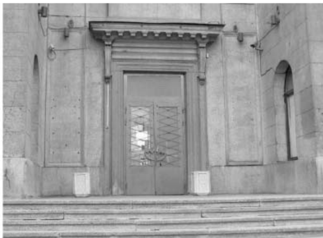
93. Лицевой фасад. Портал главного входа. 2010г. ООО «БРК».
