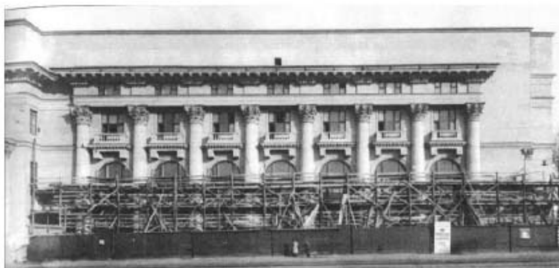
48. Вид здания Дома Пушкины на Международном проспекте в строительных лесах. 1938г. ЦГАКФФД СПб. Гр 78077.
