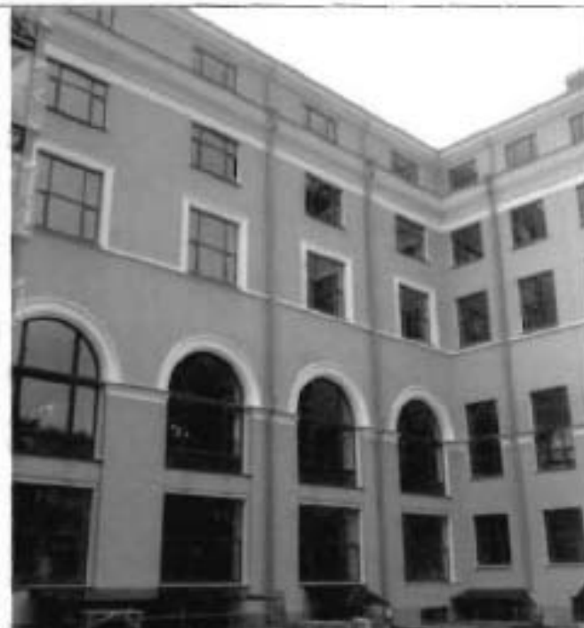
3. Фрагмент восточного фасада
