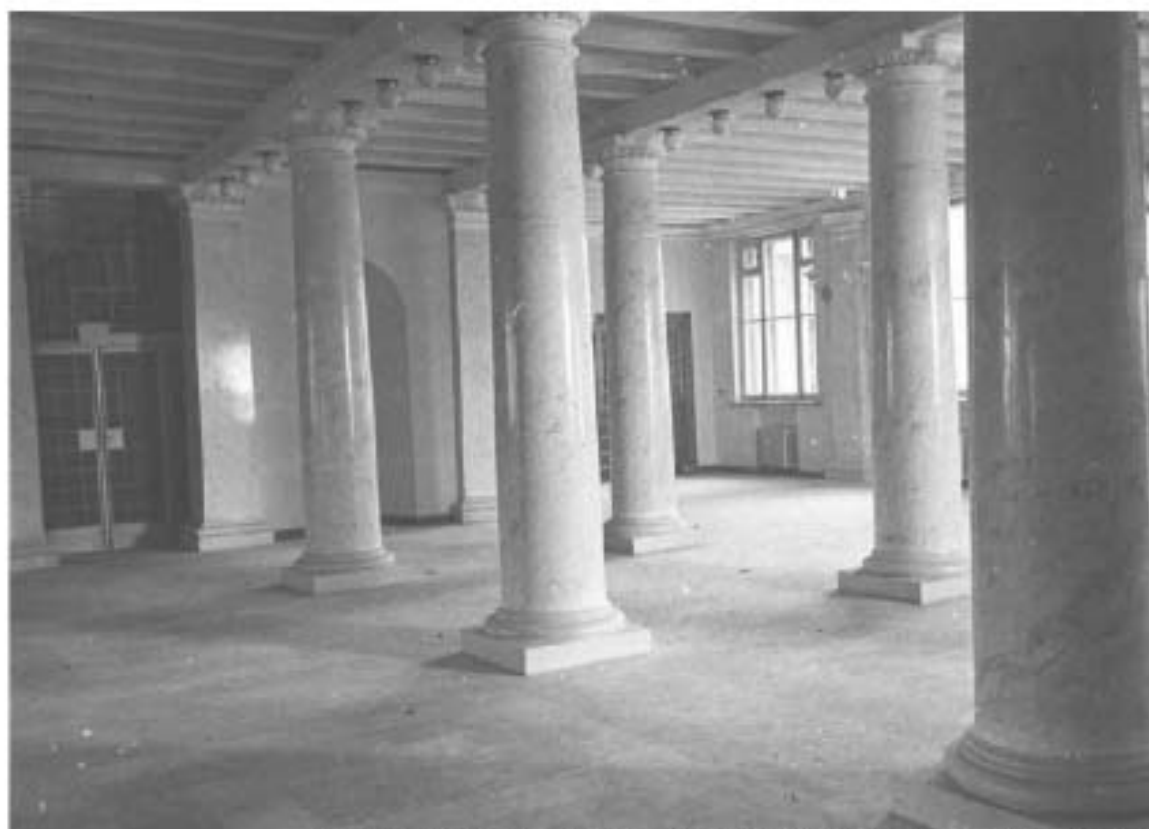
56. 1-й этаж. Вестибюль. 1938г. ЦГАКФФД СПб. Ар 129352.
