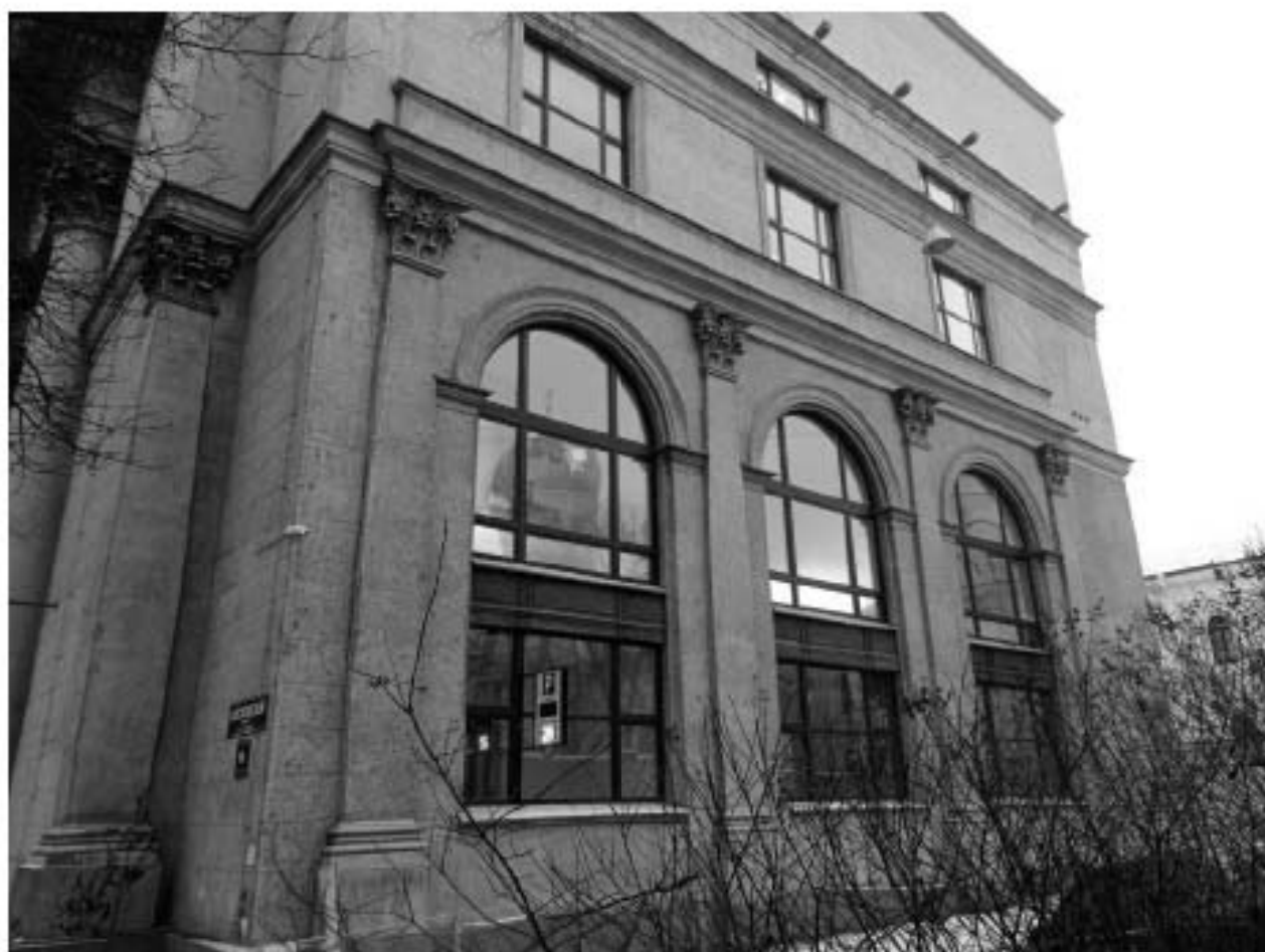
27. ОКНРЗ «Дворец пушнина». Южный фасад. Вид на северо-восток. 15.01.2024г.
