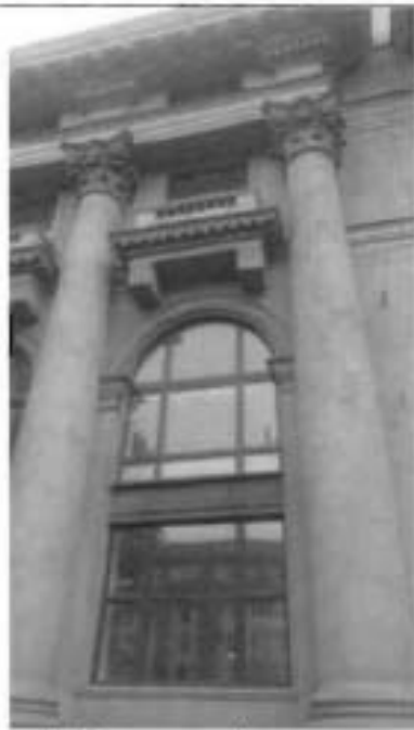
4. Фрагмент оформления западного фасада
