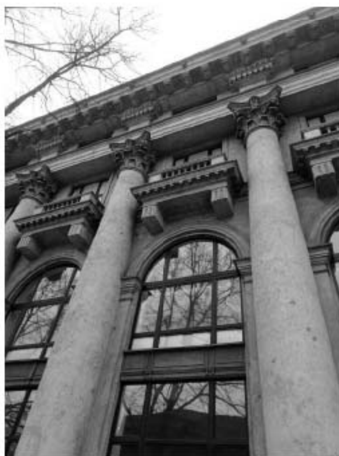
13. ОКНРЗ «Дворец пушкинь». Фрагмент северной части западного фасада. 15.01.2024г.
