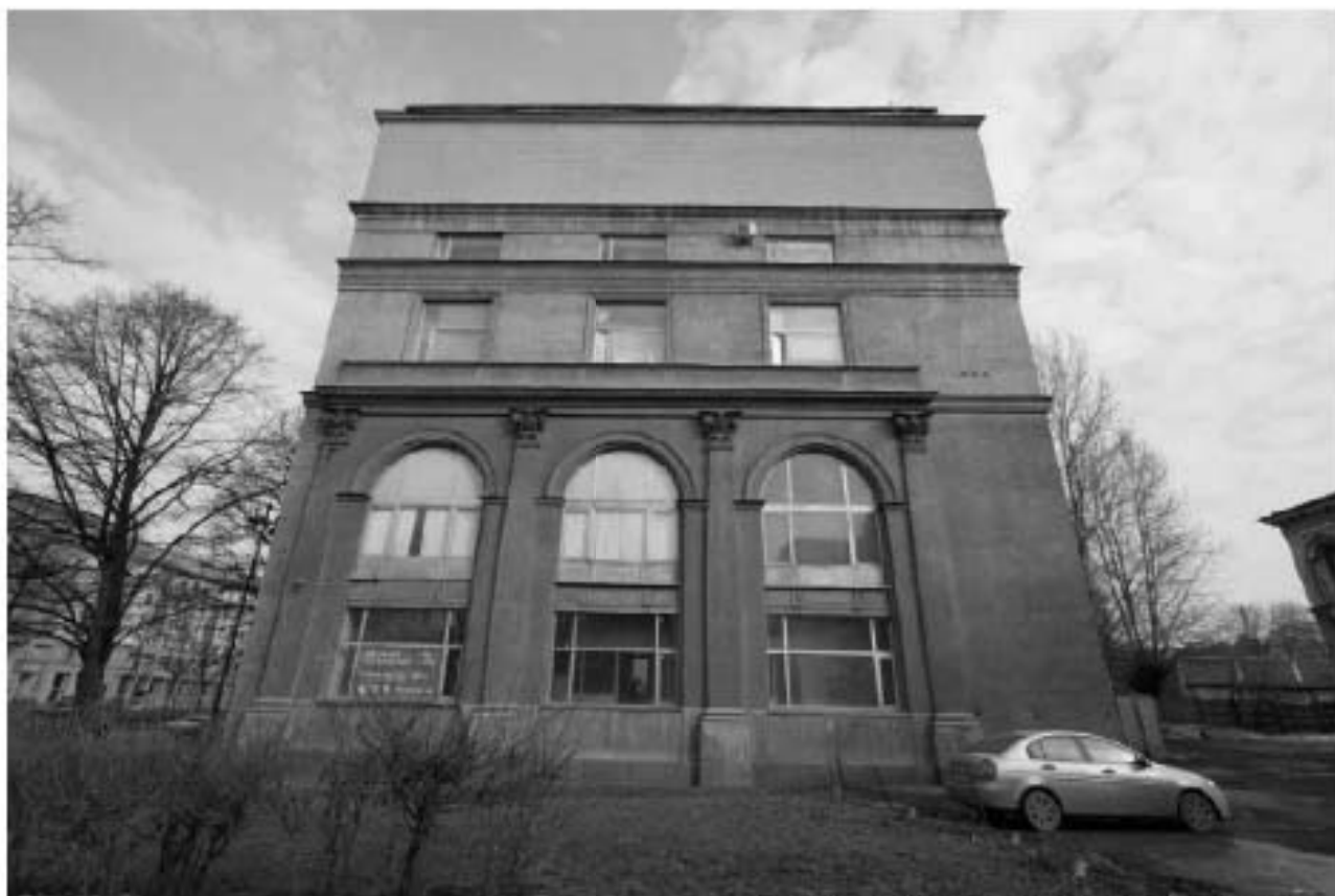
95. Южный фасад. 2010г. ООО «БРК».
