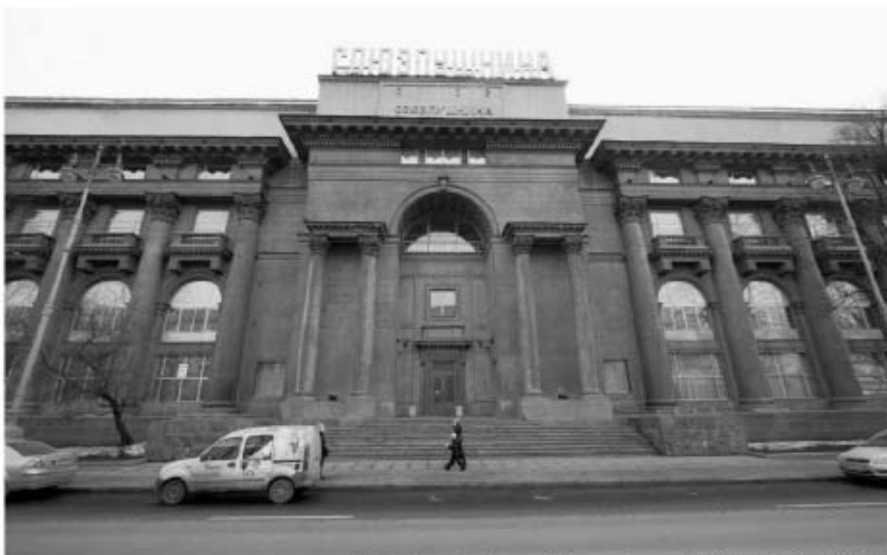
91. Лицевой фасад. Главный вход. 2010г. ООО «БРК».
