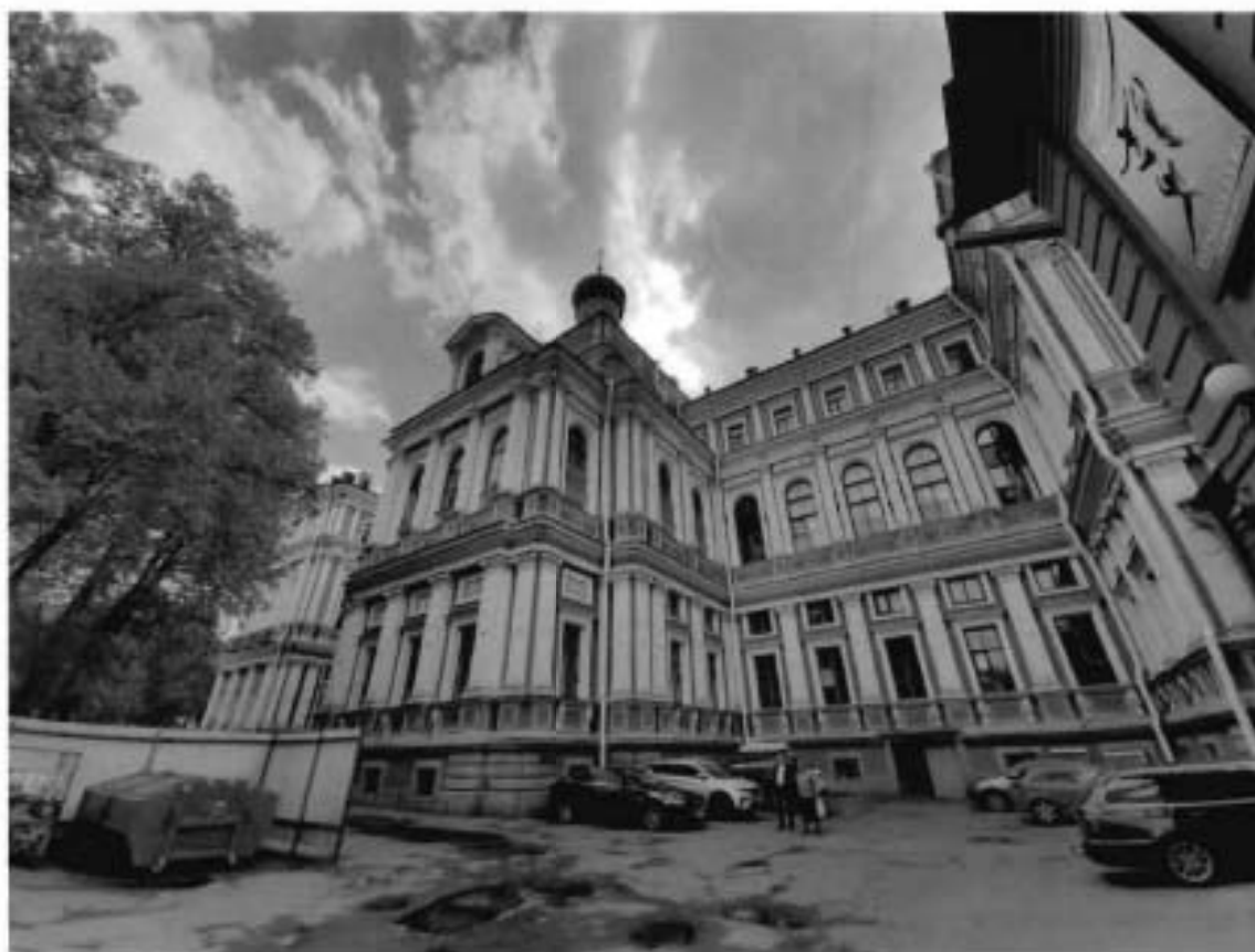
3. Общий вид на северо-восточный фасад объекта культурного наследия (02.06.2022)
