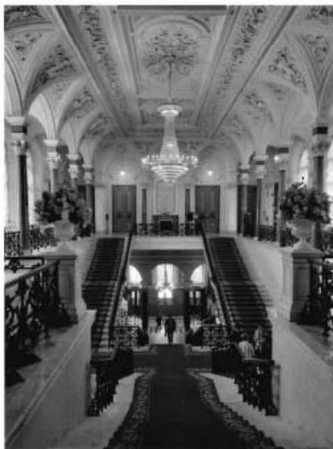
7. Интерьеры объекта культурного наследия, пом. 4-Н (362-363) (27.05.2022)
