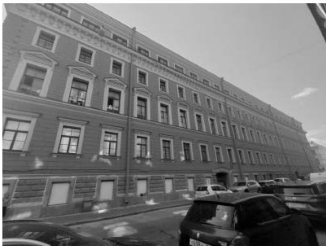
Фото 7. Фрагмент лицевого фасада объекта культурного наследия федерального значения «Дворец», входящего в состав объекта культурного наследия федерального значения «Дворец Великого князя Николая Николаевича (Ксенинский институт)» (по Галерной ул.)
