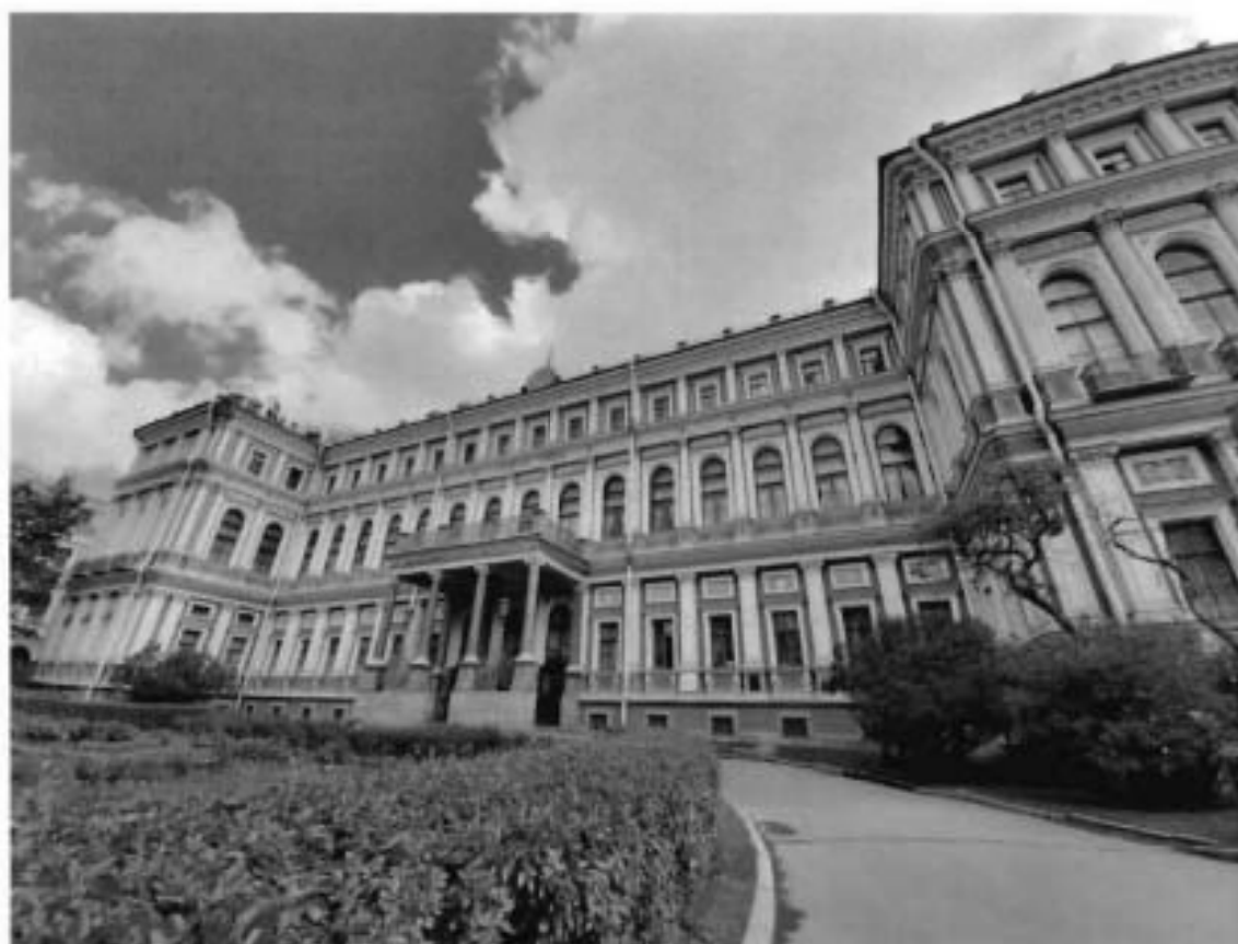
1. Общий вид на юго-западный фасад объекта культурного наследия (02.06.2022)
