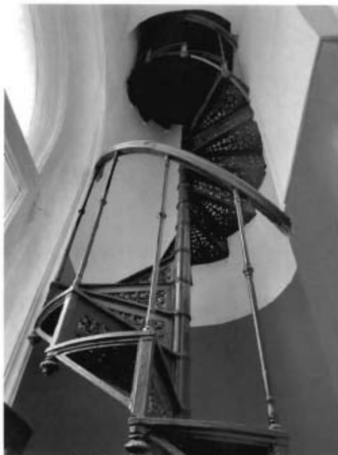
24. Лестница (пом. 4-Н (357; 423) объекта культурного наследия (27.05.2022)
