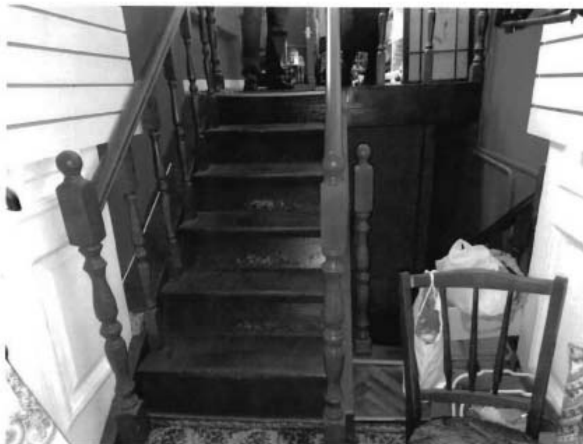
22. Лестница (пом. 4-Н (355–356) объекта культурного наследия (27.05.2022)
