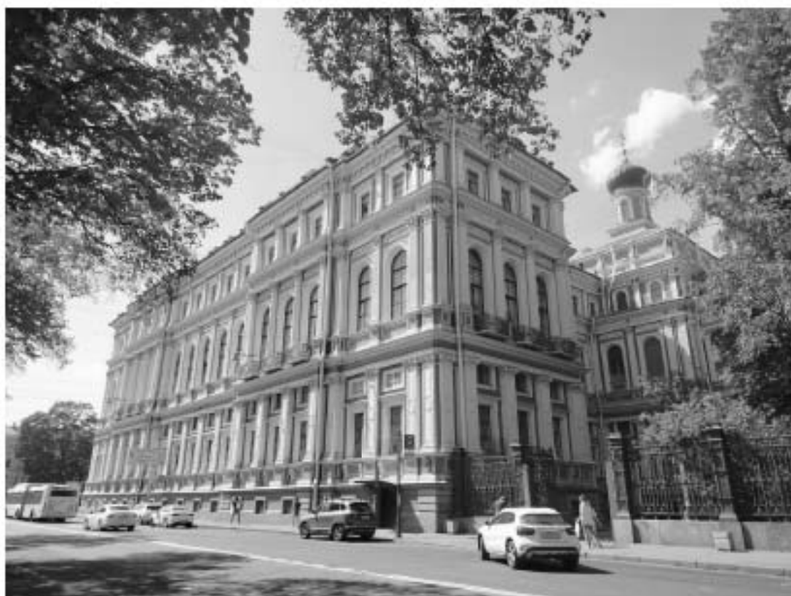
Фото 1. Фрагмент лицевого фасада объекта культурного наследия федерального значения «Дворец», входящего в состав объекта культурного наследия федерального значения «Дворец Великого князя Николая Николаевича (Ксенинский институт)» (по Конногвардейскому бул.)
