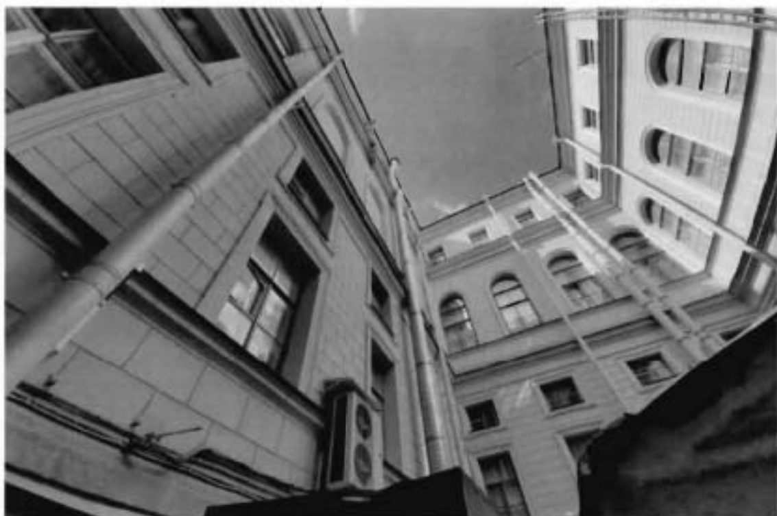
6. Общий вид на дворовые фасады объекта культурного наследия, северный двор (02.06.2022)
