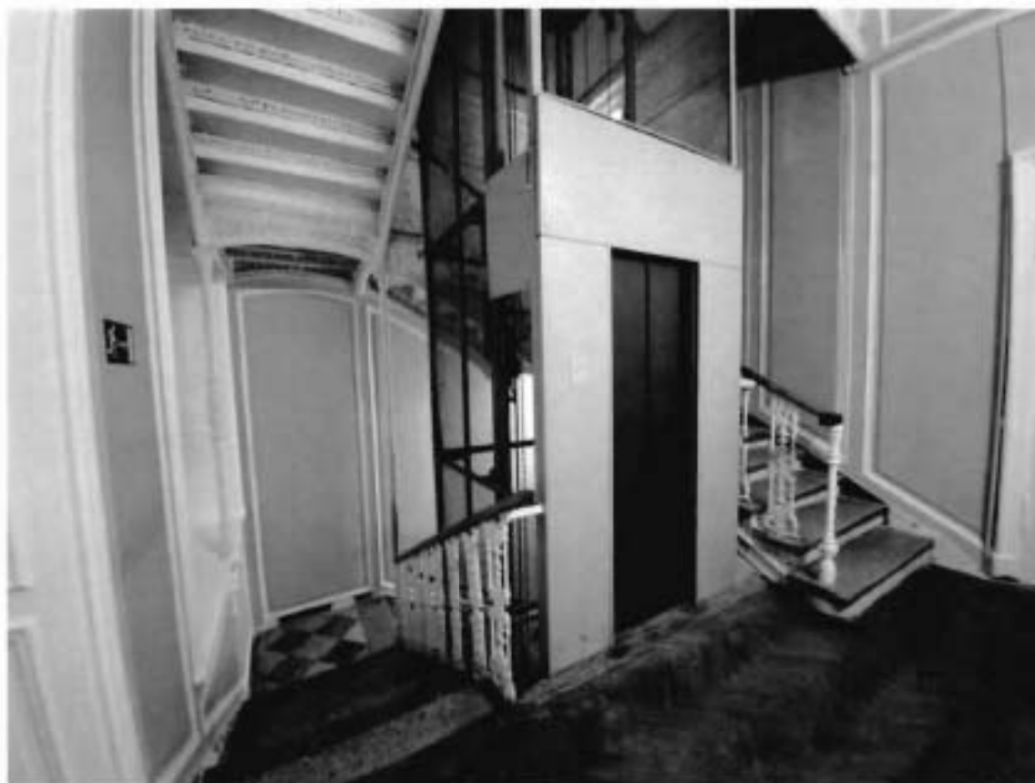
25. Лестница (пом. 4-Н (218; 301; 367; 403; 458) объекта культурного наследия (27.05.2022)
