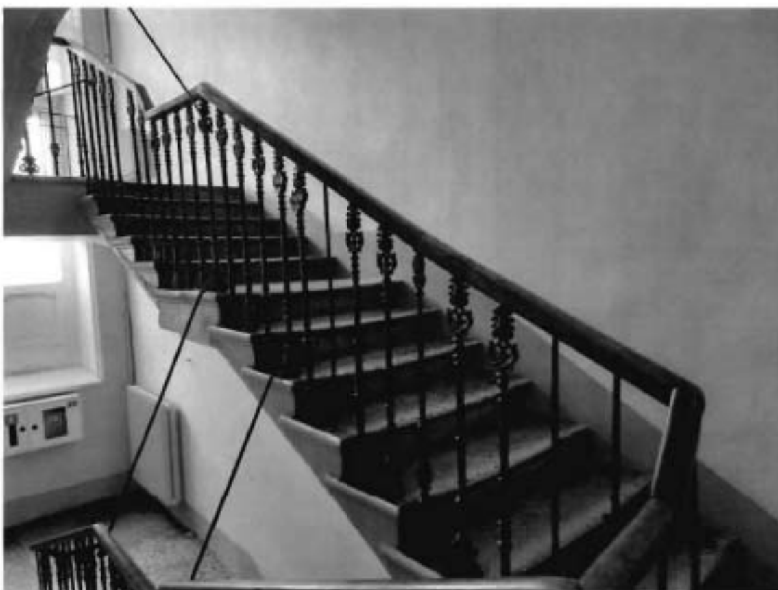
27. Лестница 1ЛК объекта культурного наследия (02.06.2022)
