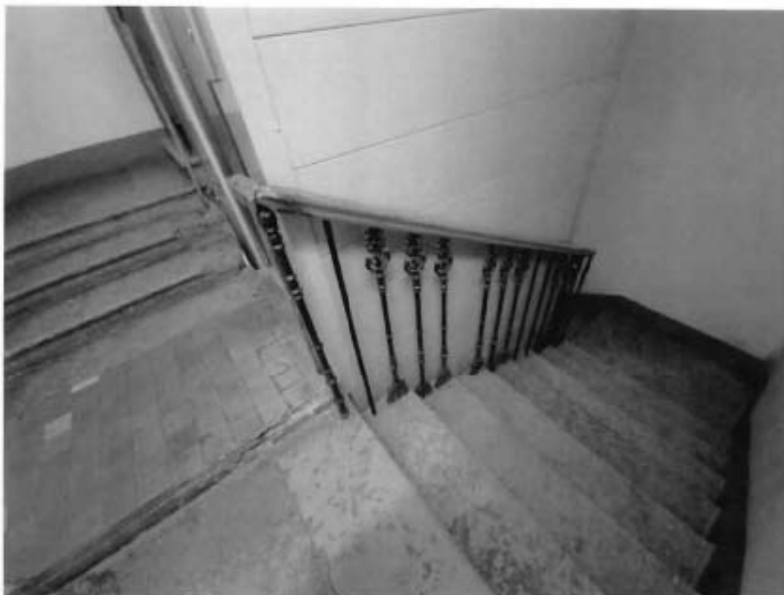
26. Лестница (пом. 4-Н (126; 233; 316; 374; 406; 466) объекта культурного наследия (27.05.2022)
