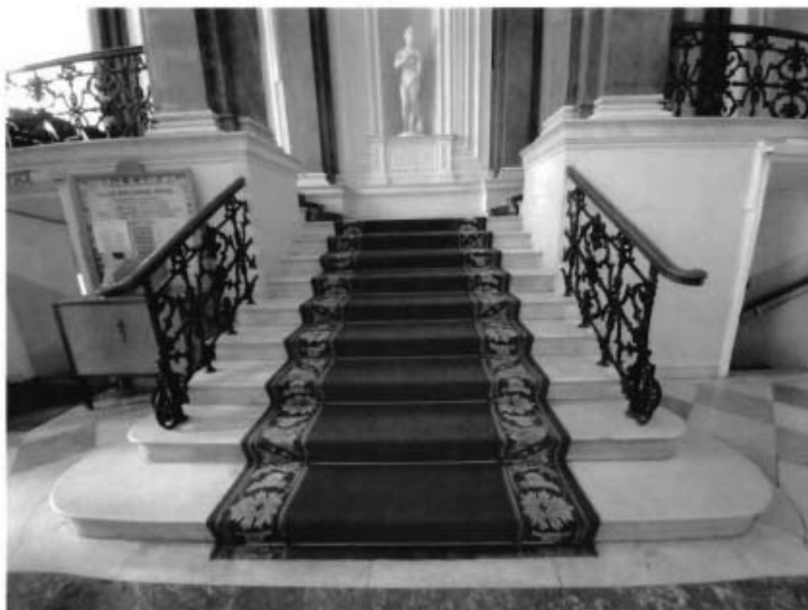
19. Лестницы вестибюля (пом. 4-Н (150; 152) объекта культурного наследия (02.06.2022)
