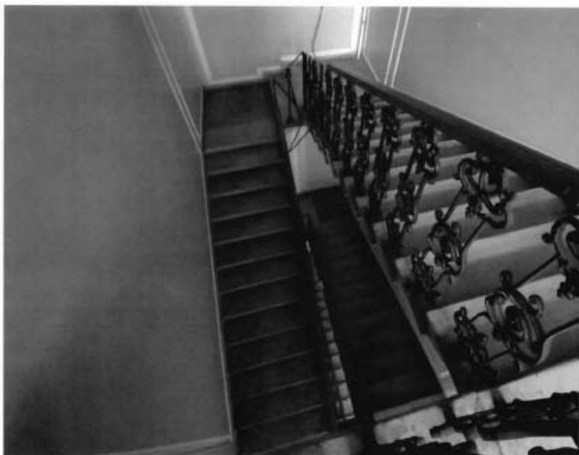
28. Лестница (пом. 4-Н (85; 262; 331; 394; 491) объекта культурного наследия (27.05.2022)
