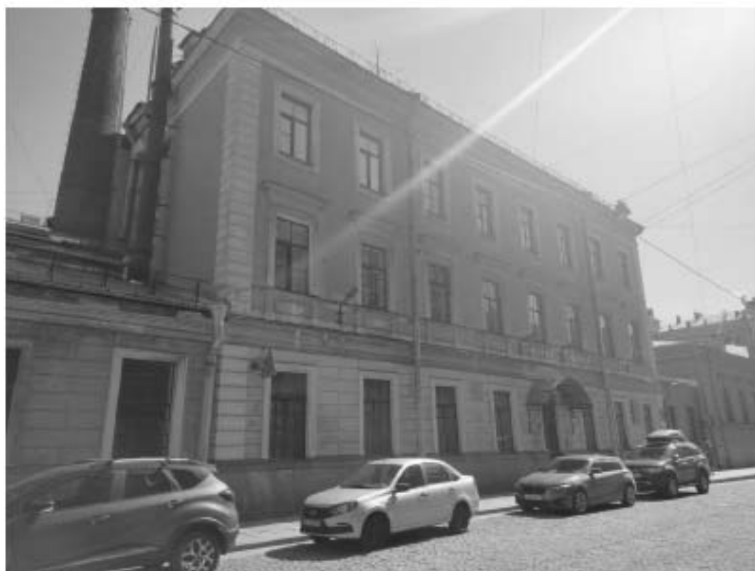
Фото 9. Фрагмент лицевого фасада объекта культурного наследия федерального значения «Дворец», входящего в состав объекта культурного наследия федерального значения «Дворец Великого князя Николая Николаевича (Ксенинский институт)» (по Галерной ул.)
