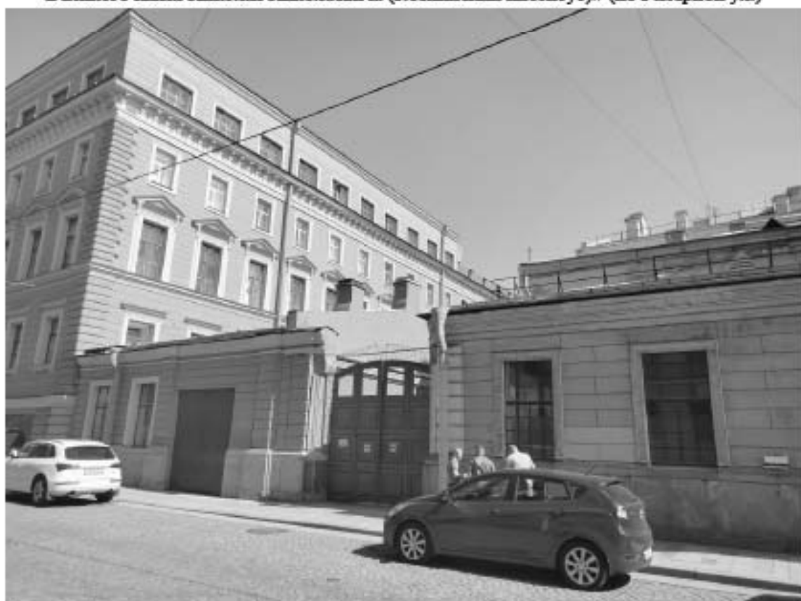
Фото 8. Фрагмент лицевого фасада объекта культурного наследия федерального значения «Дворец», входящего в состав объекта культурного наследия федерального значения «Дворец Великого князя Николая Николаевича (Ксенинский институт)» (по Галерной ул.)
