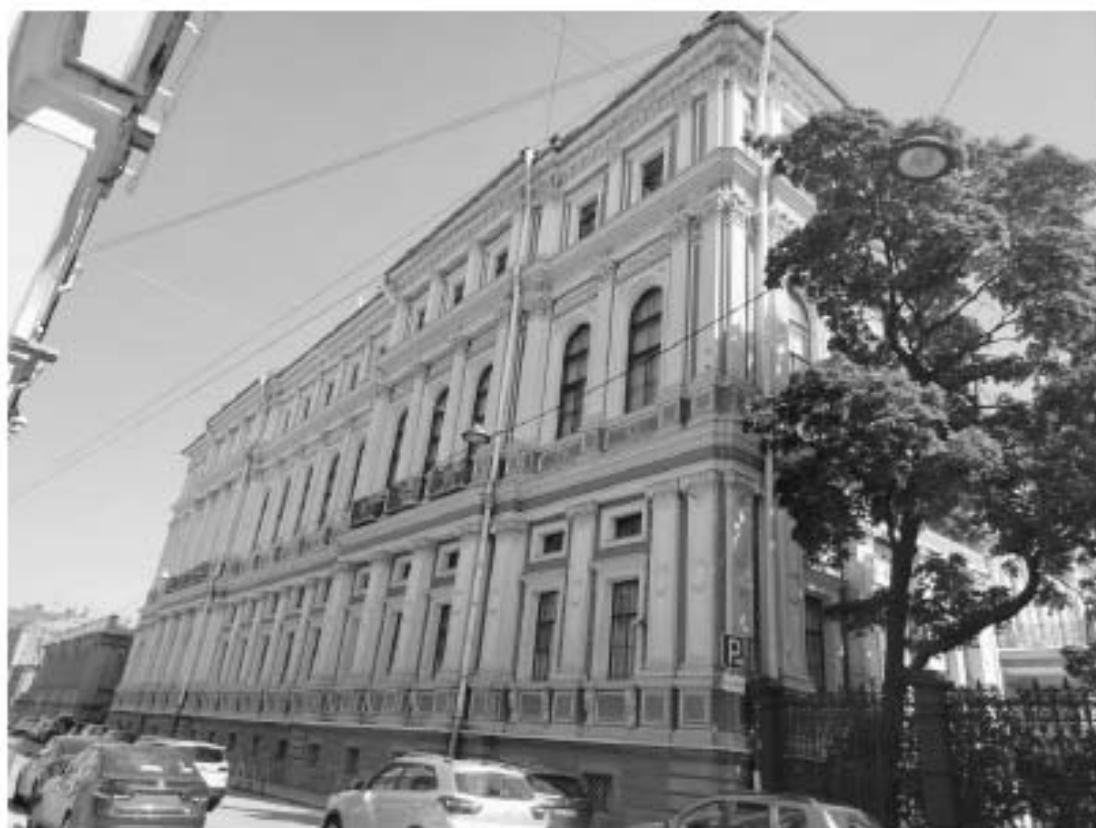
Фото 5. Фрагмент лицевого фасада объекта культурного наследия федерального значения «Дворец», входящего в состав объекта культурного наследия федерального значения «Дворец Великого князя Николая Николаевича (Ксенинский институт)» (по Галерной ул.)
