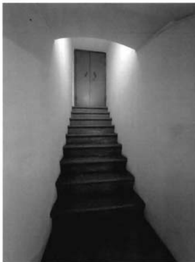
23. Лестница (пом. 4-Н (423) объекта культурного наследия (27.05.2022)
