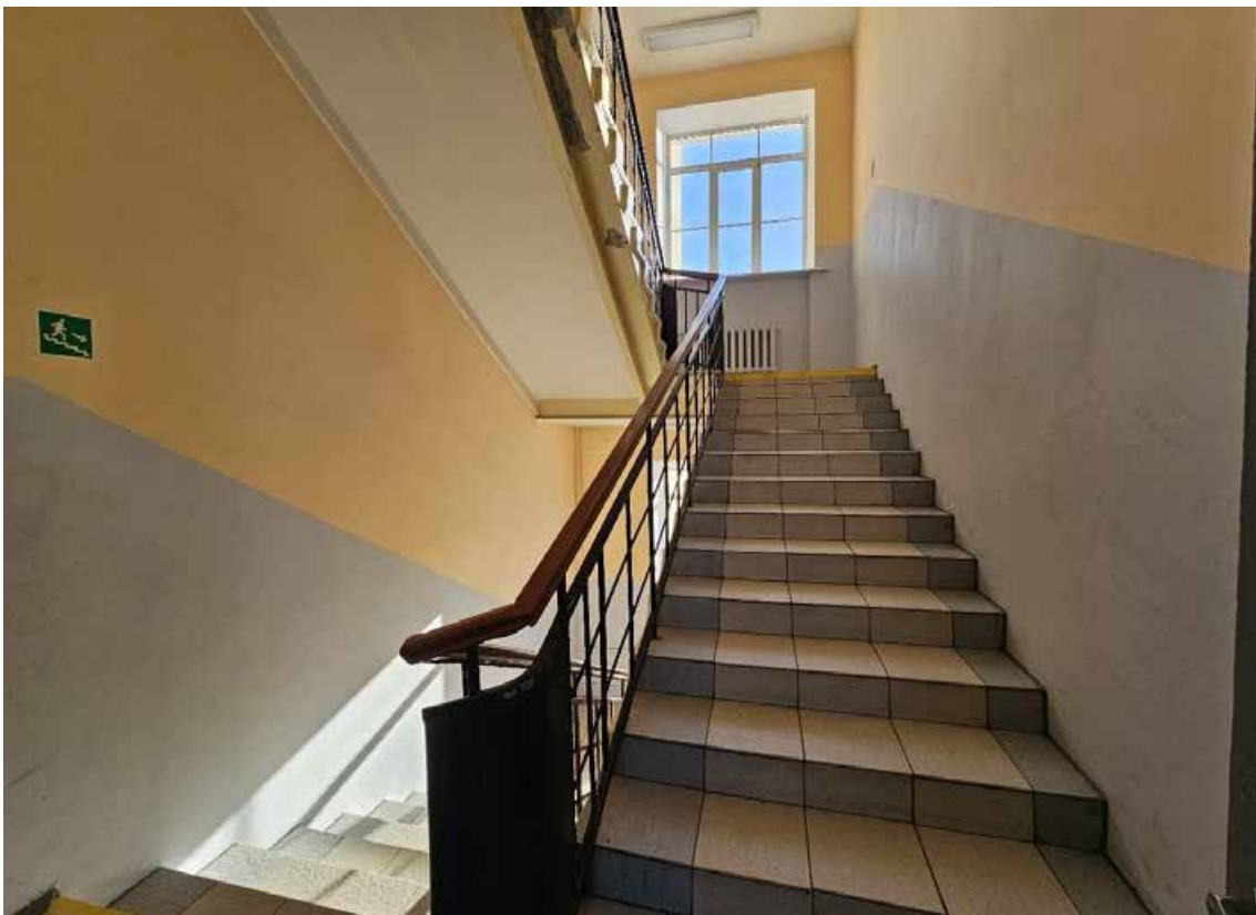
101. Объект культурного наследия федерального значения «Школа имени 10-летия Октября», по адресу: г. Санкт-Петербург, проспект Стачек, дом 5, литера А. Общий вид пом. 1-Н (170) в уровне 3-го этажа, двухмаршевая лестница полуциркульного четырехэтажного корпуса.
