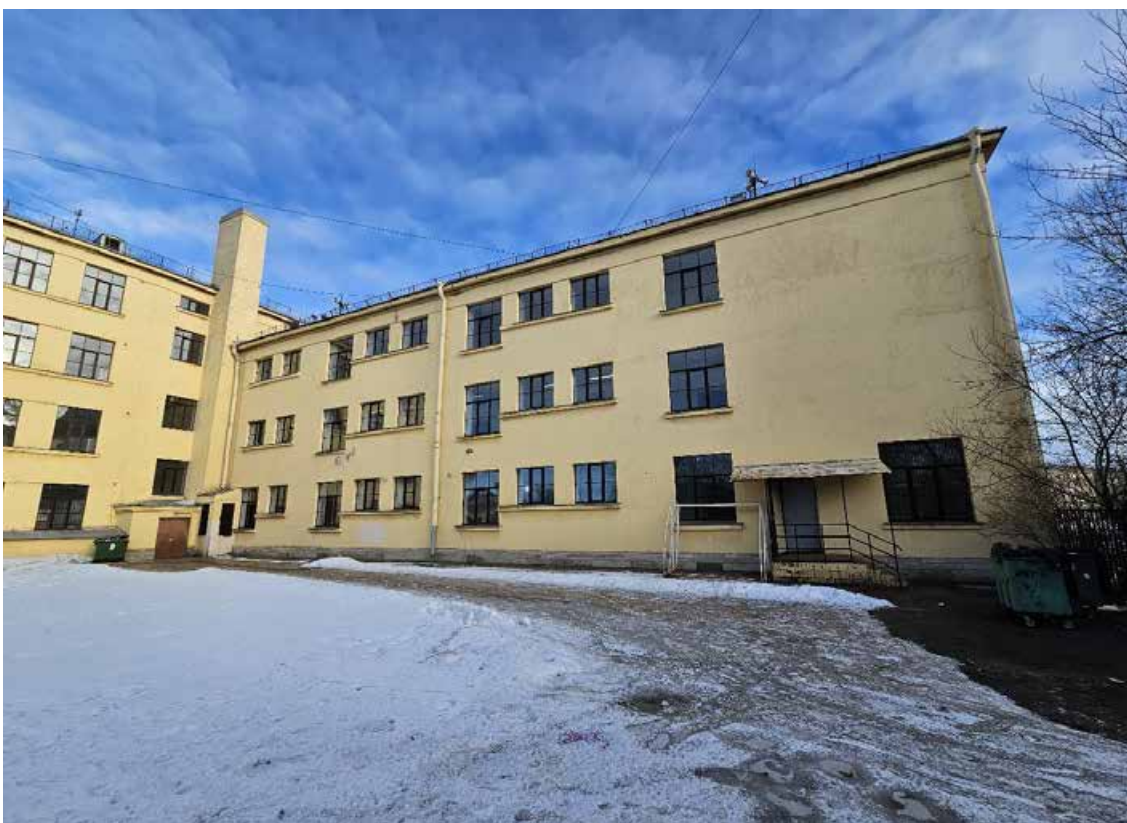
8. Объект культурного наследия федерального значения «Школа имени 10-летия Октября», по адресу: г. Санкт-Петербург, проспект Стачек, дом 5, литера А. Фрагмент Общий вид дворового фасада восточного трехэтажного корпуса.
