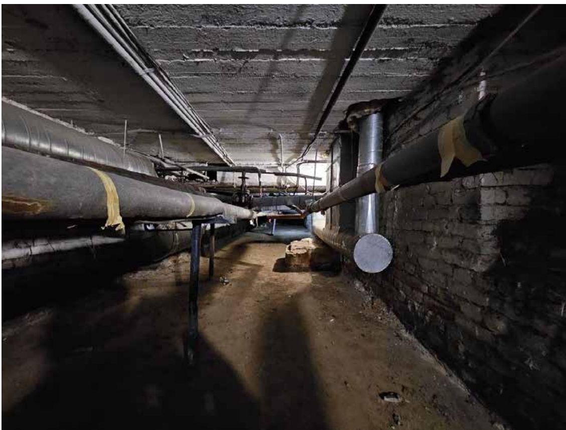
22. Объект культурного наследия федерального значения «Школа имени 10-летия Октября», по адресу: г. Санкт-Петербург, проспект Стачек, дом 5, литера А. Фрагмент пом. 1-Н (13) в уровне подвала.
