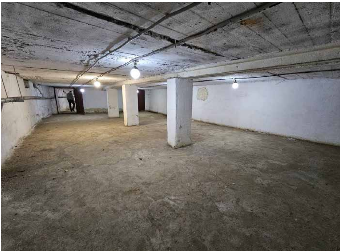
26. Объект культурного наследия федерального значения «Школа имени 10-летия Октября», по адресу: г. Санкт-Петербург, проспект Стачек, дом 5, литера А. Общий вид пом. 1-Н (19) в уровне подвала.
