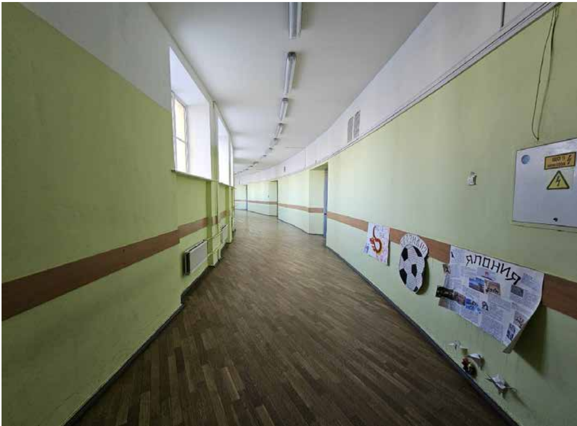
79. Объект культурного наследия федерального значения «Школа имени 10-летия Октября», по адресу: г. Санкт-Петербург, проспект Стачек, дом 5, литера А. Фрагмент пом. 1-Н (107) в уровне 2-го этажа.
