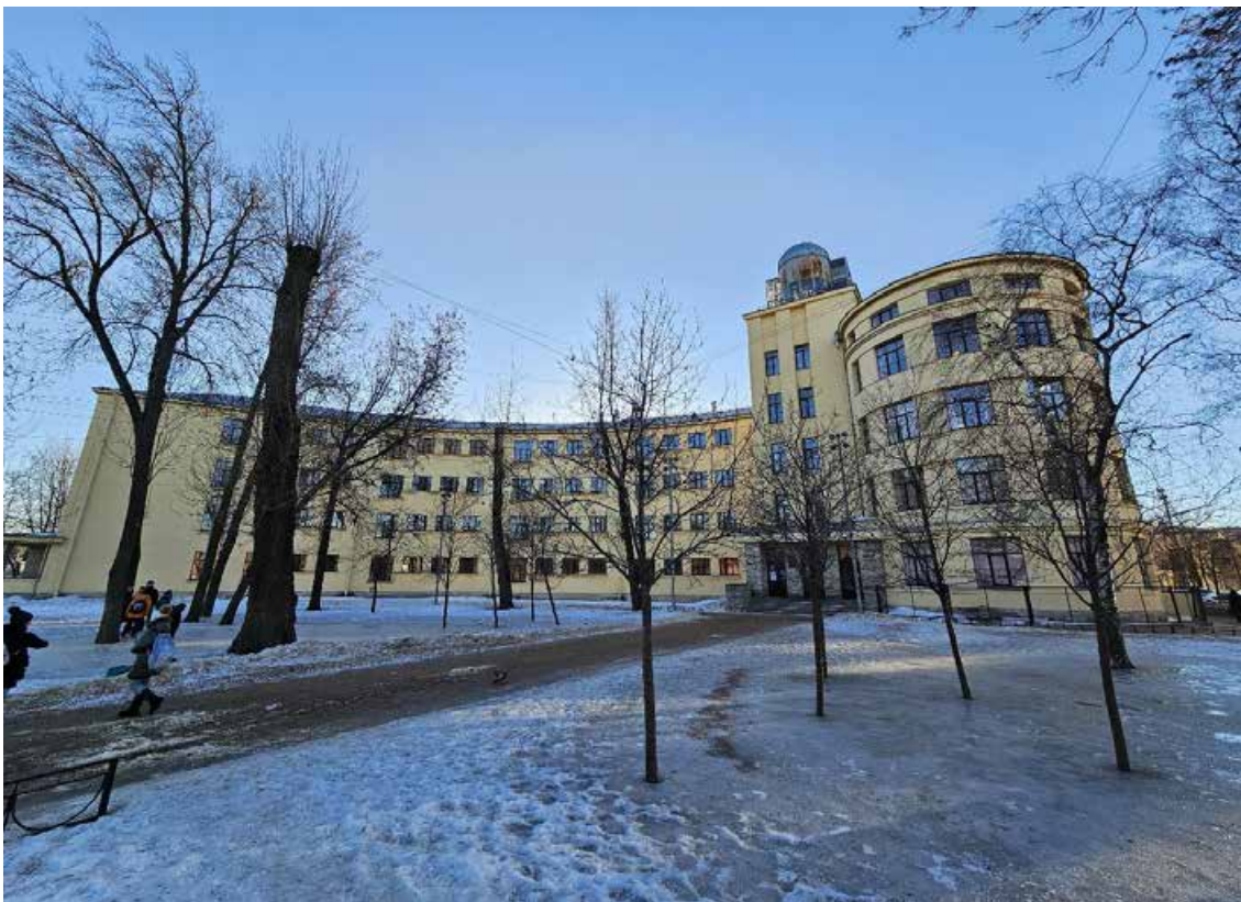
13. Объект культурного наследия федерального значения «Школа имени 10-летия Октября», по адресу: г. Санкт-Петербург, проспект Стачек, дом 5, литера А. Общий вид лицевого фасада дугообразного четырехэтажного корпуса.
