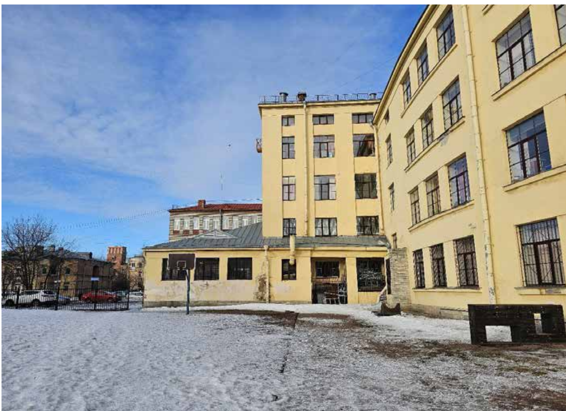
4. Объект культурного наследия федерального значения «Школа имени 10-летия Октября», по адресу: г. Санкт-Петербург, проспект Стачек, дом 5, литера А. Фрагмент южного дворового фасада северного повышенного корпуса.
