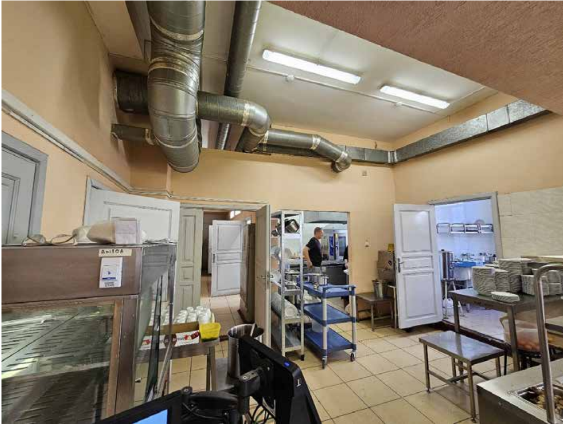
83. Объект культурного наследия федерального значения «Школа имени 10-летия Октября», по адресу: г. Санкт-Петербург, проспект Стачек, дом 5, литера А. Фрагмент пом. 1-Н (136) в уровне 2-го этажа.
