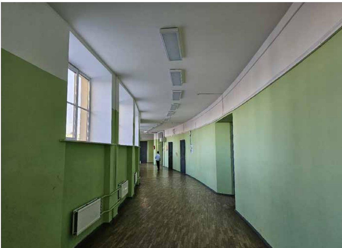
97. Объект культурного наследия федерального значения «Школа имени 10-летия Октября», по адресу: г. Санкт-Петербург, проспект Стачек, дом 5, литера А. Фрагмент пом. 1-Н (161) в уровне 3-го этажа.
