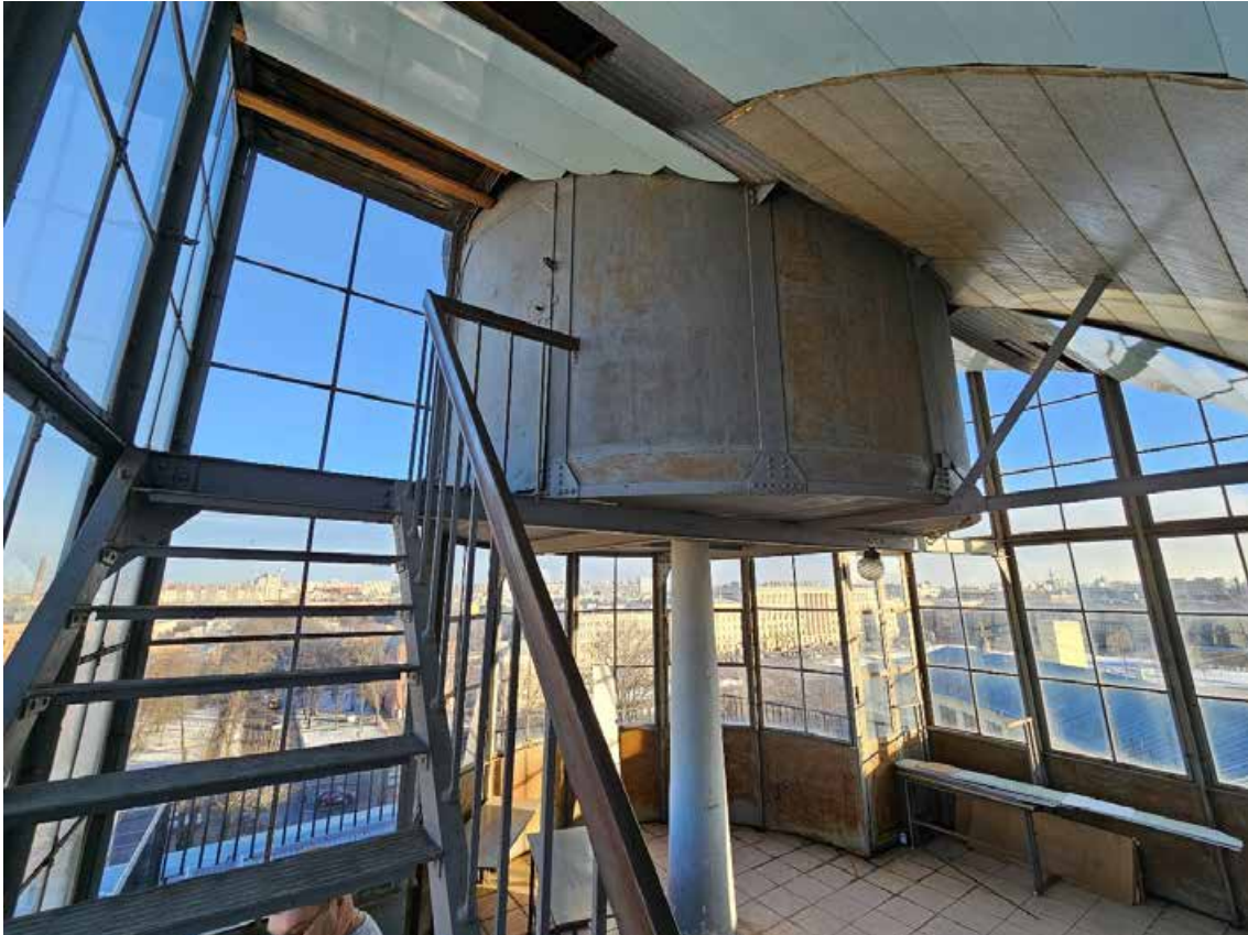
133. Объект культурного наследия федерального значения «Школа имени 10-летия Октября», по адресу: г. Санкт-Петербург, проспект Стачек, дом 5, литера А. Помещение 1-Н (225) - вид на металлический купол телескопа.
