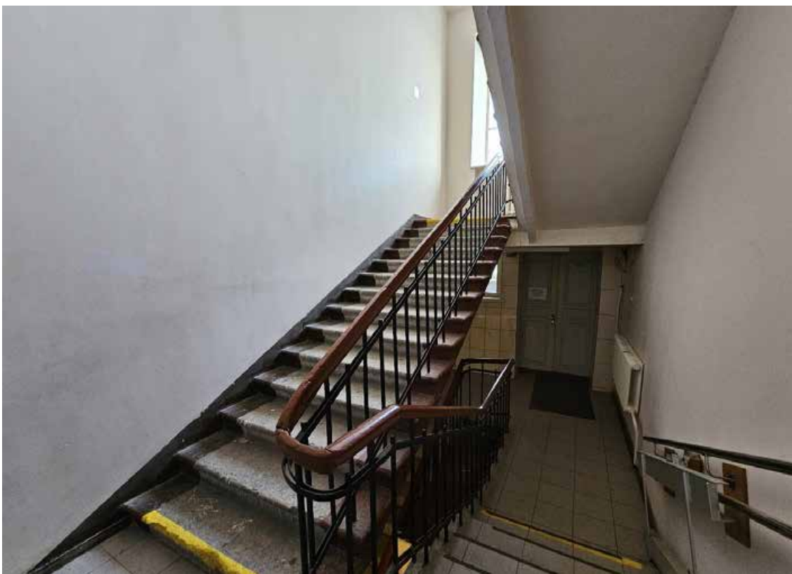
28. Объект культурного наследия федерального значения «Школа имени 10-летия Октября», по адресу: г. Санкт-Петербург, проспект Стачек, дом 5, литера А. Общий вид пом. 1-Н (55) в уровне 1-го этажа, двухмаршевая лестница восточного трехэтажного корпуса.
