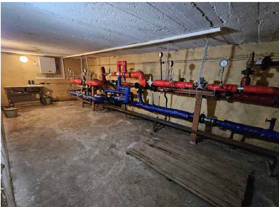
24. Объект культурного наследия федерального значения «Школа имени 10-летия Октября», по адресу: г. Санкт-Петербург, проспект Стачек, дом 5, литера А. Общий вид пом. 1-Н (18) в уровне подвала.
