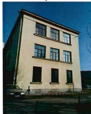
6. Южный фасад здания
