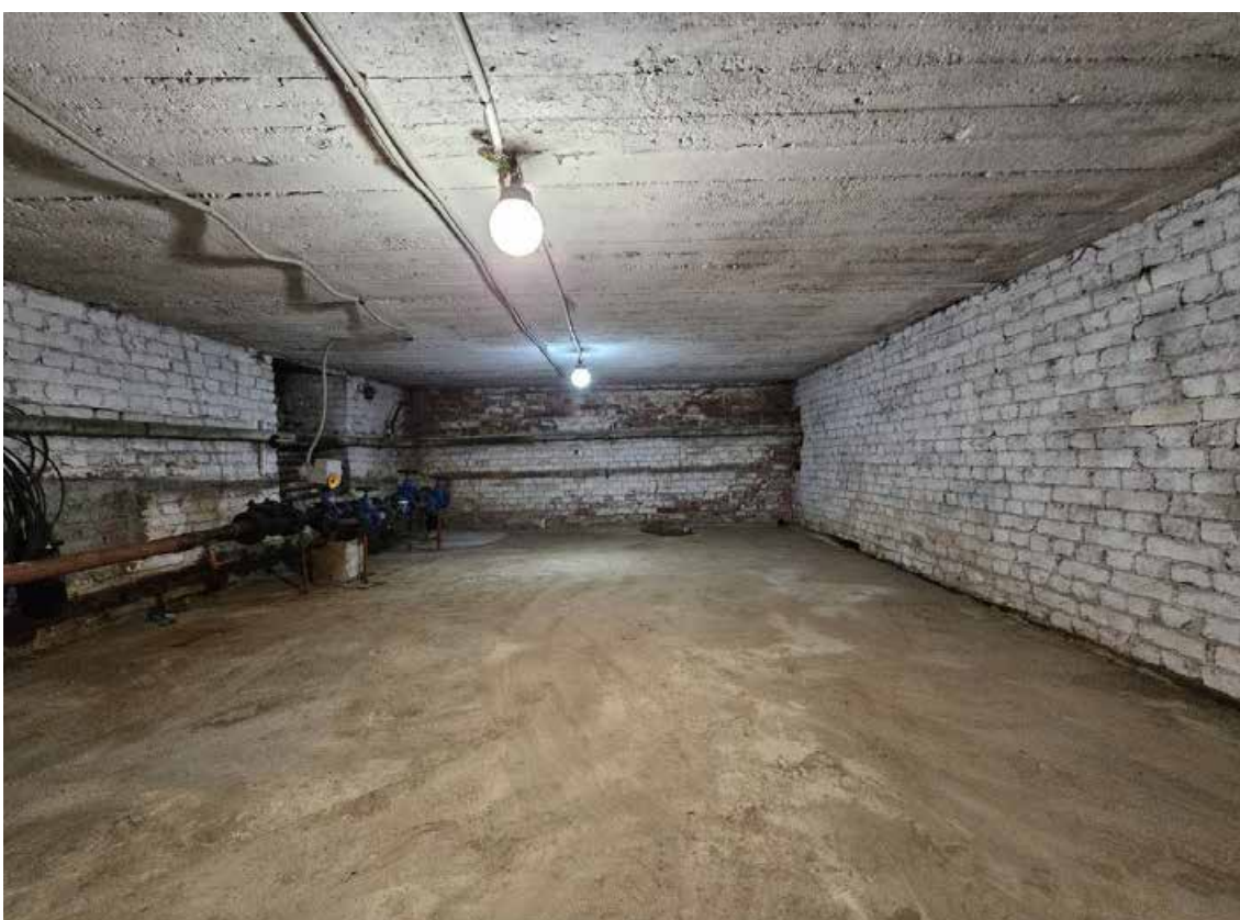
18. Объект культурного наследия федерального значения «Школа имени 10-летия Октября», по адресу: г. Санкт-Петербург, проспект Стачек, дом 5, литера А. Общий вид пом. 1-Н (11) в уровне подвала.
