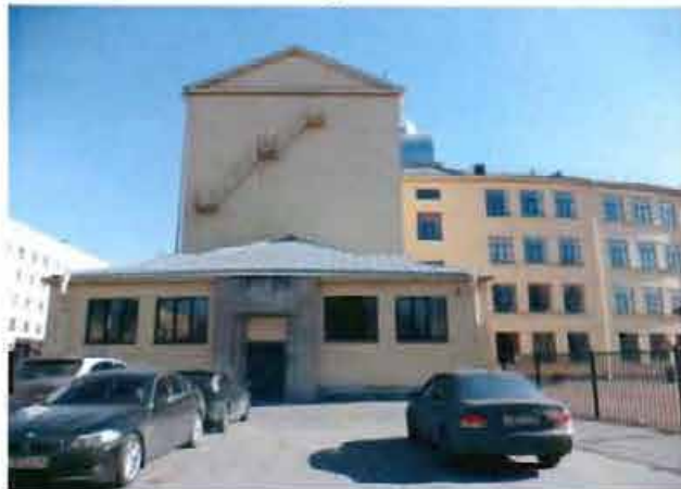
7. Западный фасад здания
