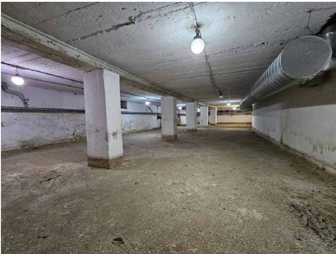
27. Объект культурного наследия федерального значения «Школа имени 10-летия Октября», по адресу: г. Санкт-Петербург, проспект Стачек, дом 5, литера А. Общий вид пом. 1-Н (20) в уровне подвала.
