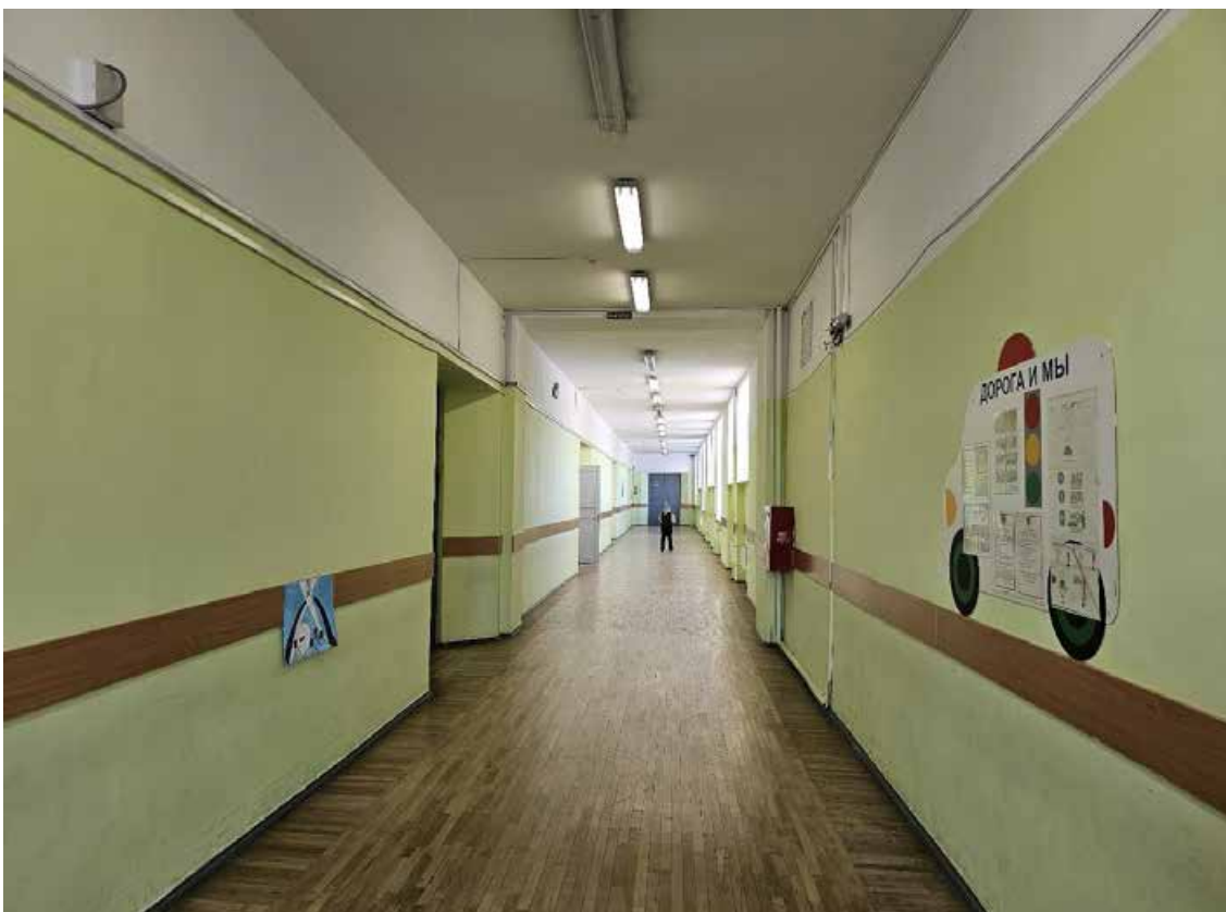
69. Объект культурного наследия федерального значения «Школа имени 10-летия Октября», по адресу: г. Санкт-Петербург, проспект Стачек, дом 5, литера А. Фрагмент пом. 1-Н (107) в уровне 2-го этажа.
