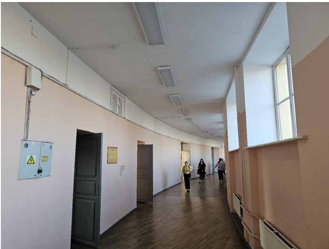
111. Объект культурного наследия федерального значения «Школа имени 10-летия Октября», по адресу: г. Санкт-Петербург, проспект Стачек, дом 5, литера А. Фрагмент пом. 1-Н (194) в уровне 4-го этажа.
