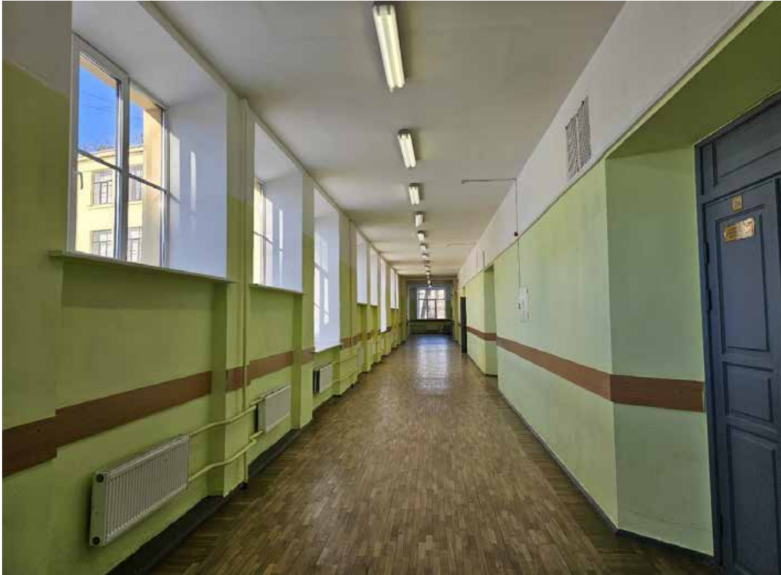
63. Объект культурного наследия федерального значения «Школа имени 10-летия Октября», по адресу: г. Санкт-Петербург, проспект Стачек, дом 5, литера А. Фрагмент пом. 1-Н (107) в уровне 2-го этажа.
