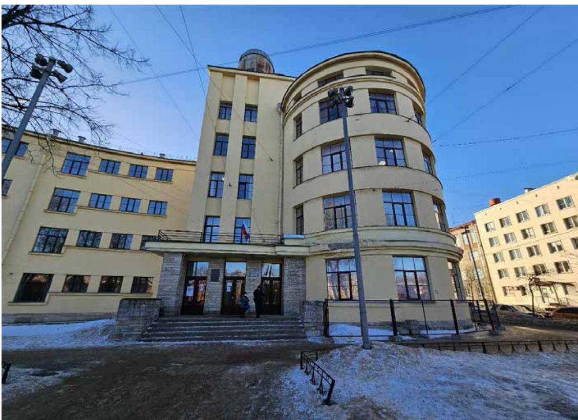
14. Объект культурного наследия федерального значения «Школа имени 10-летия Октября», по адресу: г. Санкт-Петербург, проспект Стачек, дом 5, литера А. Общий вид торцевого фасада северного корпуса.
