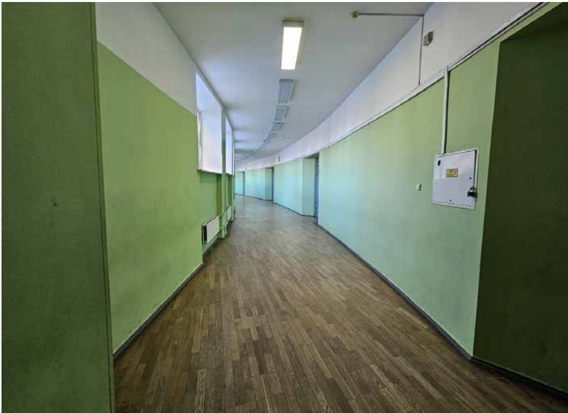
93. Объект культурного наследия федерального значения «Школа имени 10-летия Октября», по адресу: г. Санкт-Петербург, проспект Стачек, дом 5, литера А. Фрагмент пом. 1-Н (161) в уровне 3-го этажа.
