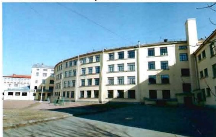
5. Юго-западный фасад. Вид с юга
