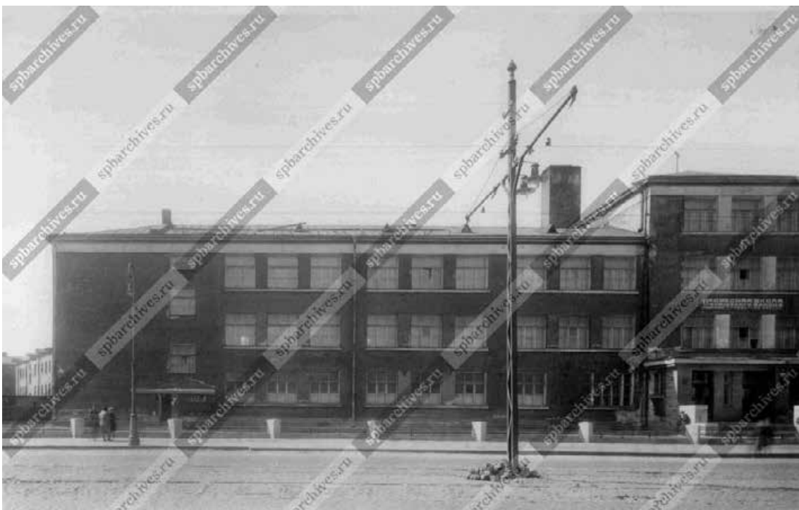
25. Фрагмент фасада 6-й средней школы Кировского района имени 10-летия Октября на улице Стачек дом №5/2. 1939 г. ЦГАКФФД СПб. Фотодокумент Гр 78510.
