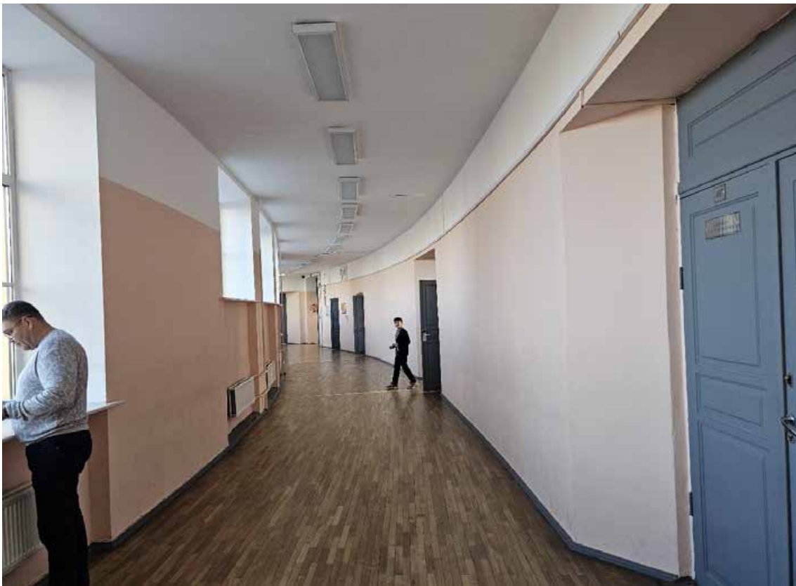
113. Объект культурного наследия федерального значения «Школа имени 10-летия Октября», по адресу: г. Санкт-Петербург, проспект Стачек, дом 5, литера А. Фрагмент пом. 1-Н (194) в уровне 4-го этажа.
