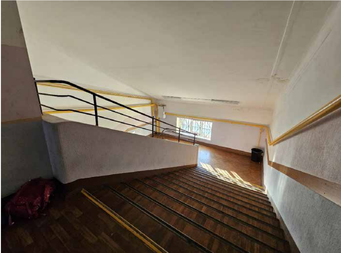
125. Объект культурного наследия федерального значения «Школа имени 10-летия Октября», по адресу: г. Санкт-Петербург, проспект Стачек, дом 5, литера А. Общий вид пом. 1-Н (214) в уровне 5-го этажа, вид на главную лестницу.
