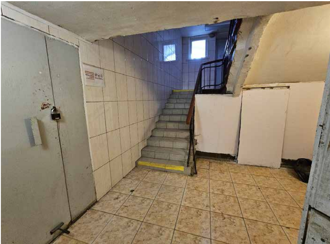
15. Объект культурного наследия федерального значения «Школа имени 10-летия Октября», по адресу: г. Санкт-Петербург, проспект Стачек, дом 5, литера А. Общий вид пом. 1-Н (1) в уровне подвала, двухмаршевая лестница восточного трехэтажного корпуса.
