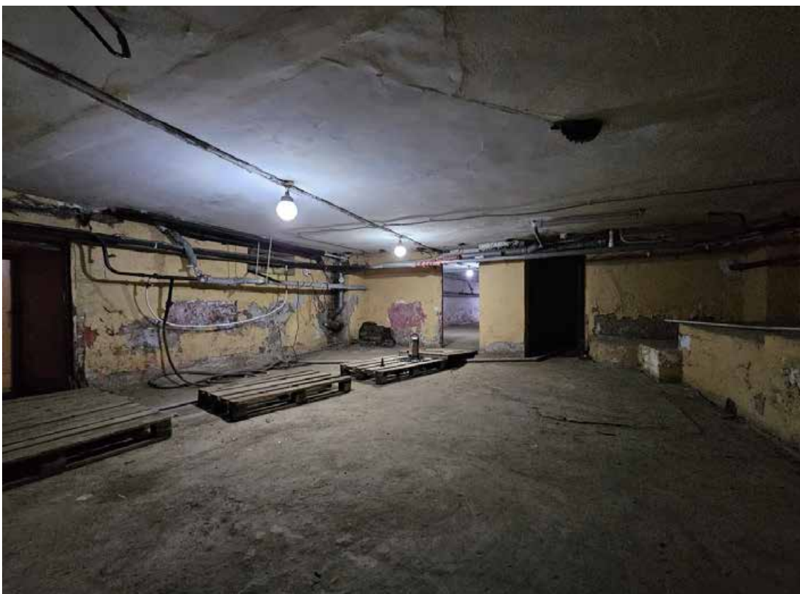
25. Объект культурного наследия федерального значения «Школа имени 10-летия Октября», по адресу: г. Санкт-Петербург, проспект Стачек, дом 5, литера А. Общий вид пом. 1-Н (15) в уровне подвала.
