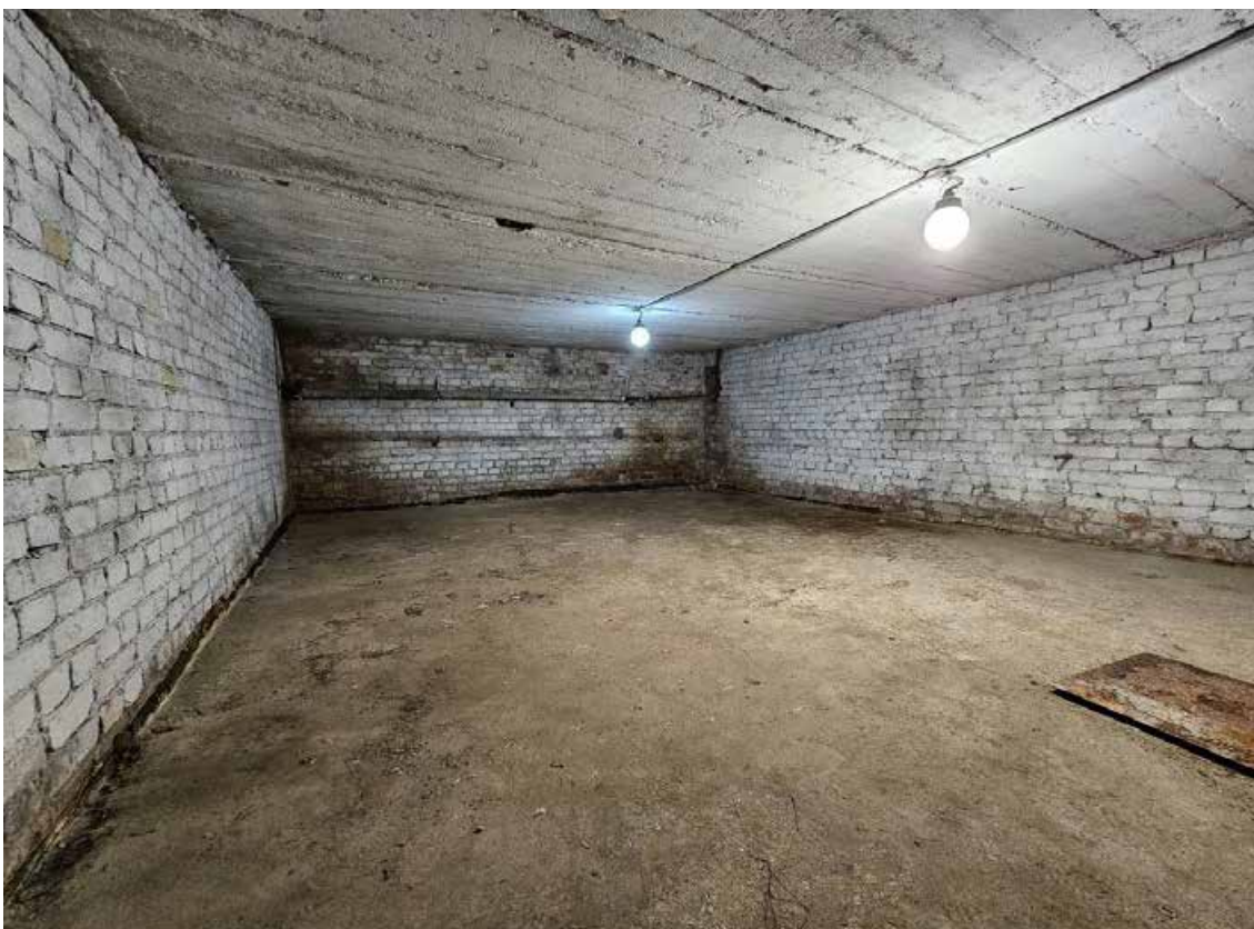
19. Объект культурного наследия федерального значения «Школа имени 10-летия Октября», по адресу: г. Санкт-Петербург, проспект Стачек, дом 5, литера А. Общий вид пом. 1-Н (10) в уровне подвала.
