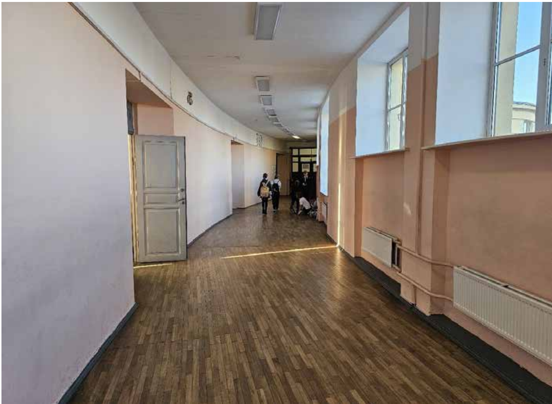
114. Объект культурного наследия федерального значения «Школа имени 10-летия Октября», по адресу: г. Санкт-Петербург, проспект Стачек, дом 5, литера А. Фрагмент пом. 1-Н (194) в уровне 4-го этажа.
