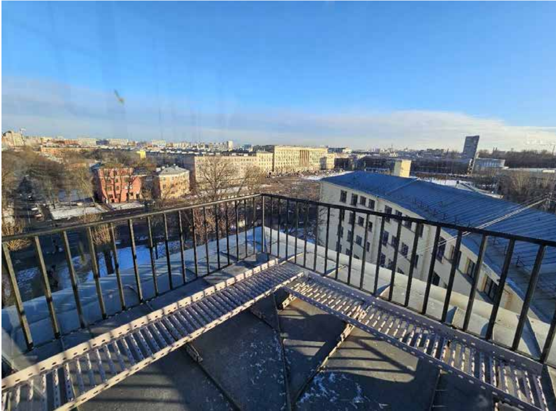
132. Объект культурного наследия федерального значения «Школа имени 10-летия Октября», по адресу: г. Санкт-Петербург, проспект Стачек, дом 5, литера А. Вид из пом. 1-Н (224) на пр. Стачек в юго-восточном направлении.
