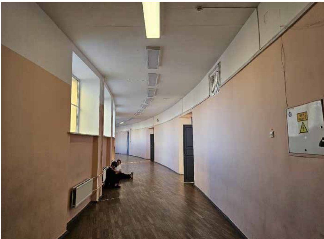
118. Объект культурного наследия федерального значения «Школа имени 10-летия Октября», по адресу: г. Санкт-Петербург, проспект Стачек, дом 5, литера А. Фрагмент пом. 1-Н (194) в уровне 4-го этажа.
