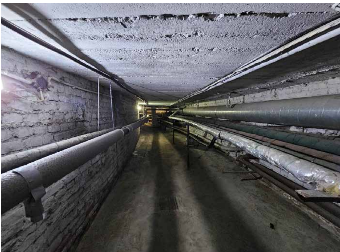
20. Объект культурного наследия федерального значения «Школа имени 10-летия Октября», по адресу: г. Санкт-Петербург, проспект Стачек, дом 5, литера А. Общий вид пом. 1-Н (13) в уровне подвала.
