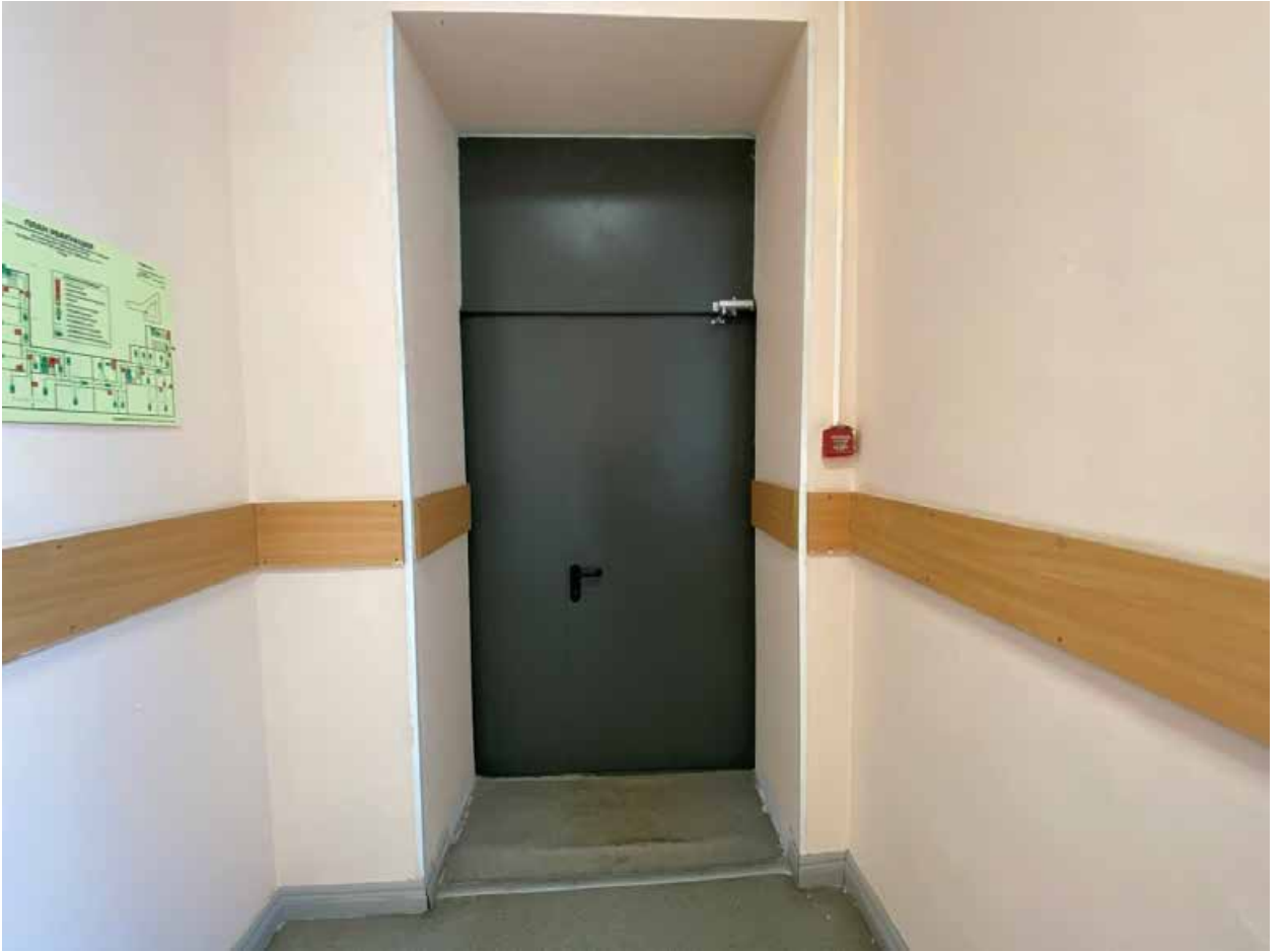
Фото 126. Выход на лестничную клетку 4ЛК.
