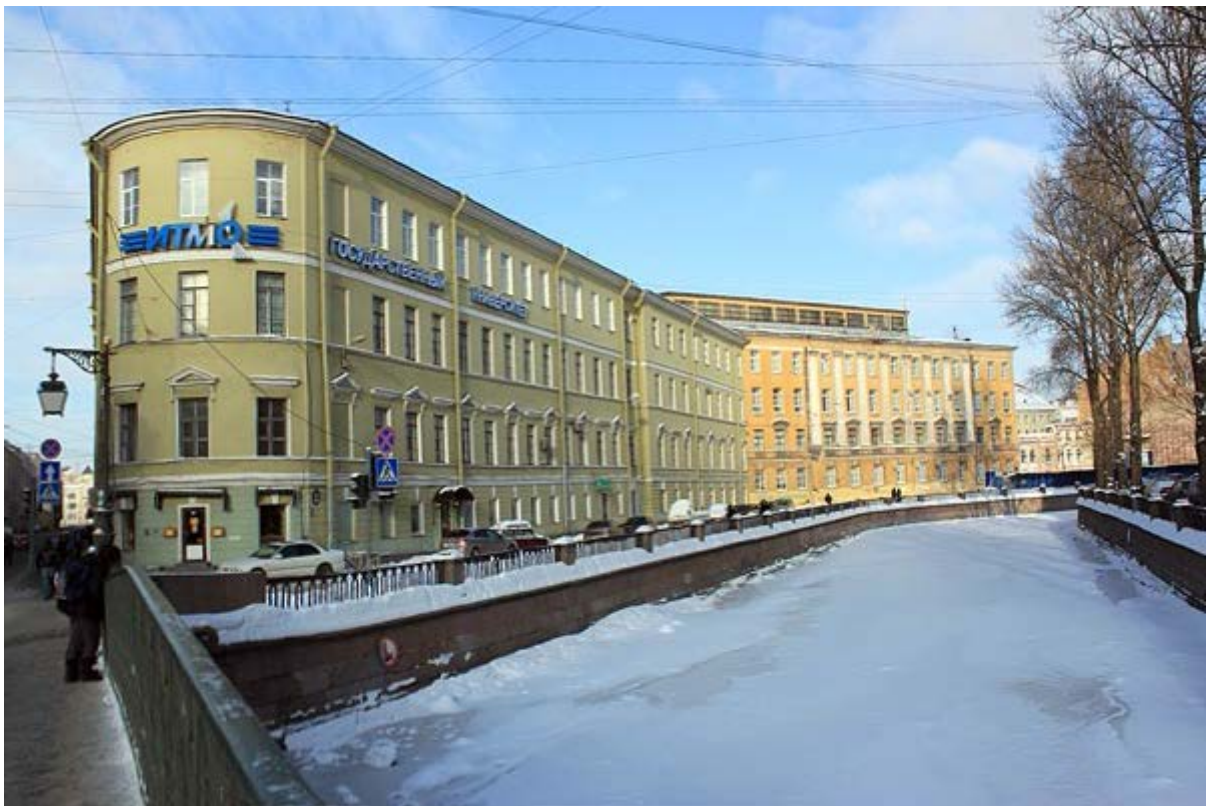
Илл. 23. Здание Гос. комиссии погашения долгов - Ленинградский техникум точной механики и оптики - Институт точной механики и оптики. 2011 г. Citywalls: Архитектурный сайт Санкт-Петербурга [Электронный ресурс] URL: https://www.citywalls.ru/photo77678.html?s=bdrauab2v02v5ju09p6n4i87ha
