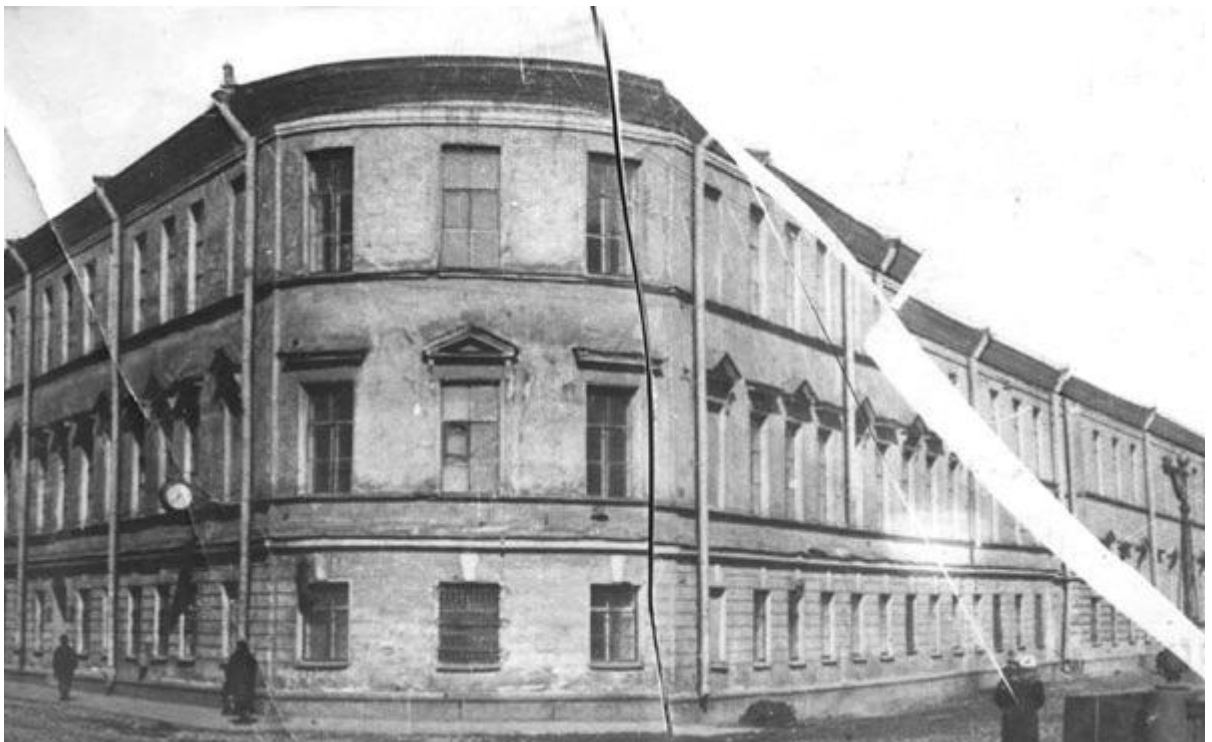
Илл. 11. Здание Гос. комиссии погашения долгов - Ленинградский техникум точной механики и оптики - Институт точной механики и оптики. 1920-е гг. Citywalls: Архитектурный сайт Санкт-Петербурга [Электронный ресурс] URL: https://www.citywalls.ru/photo8900.html?s=bdrauab2v02v5ju09p6n4i87ha
