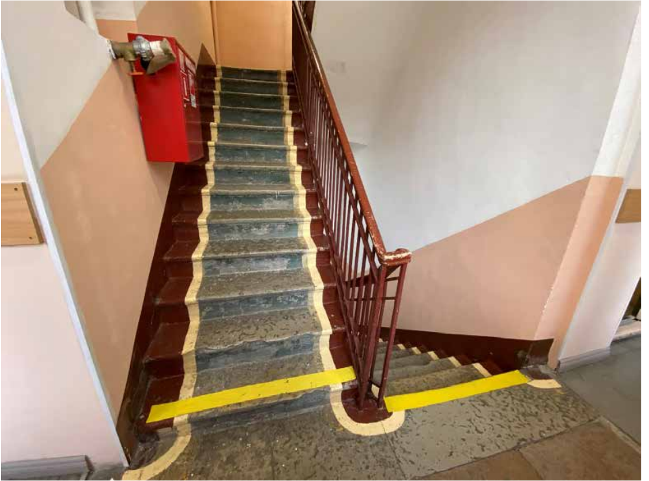
Фото 102. Третий этаж. Помещение лестницы ЗЛК.
