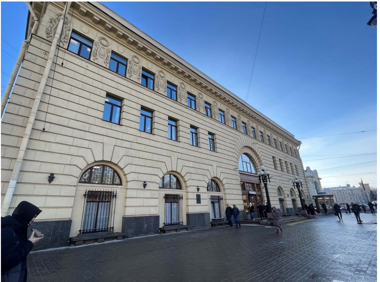
Фото №33. Северо-западный фасад.
