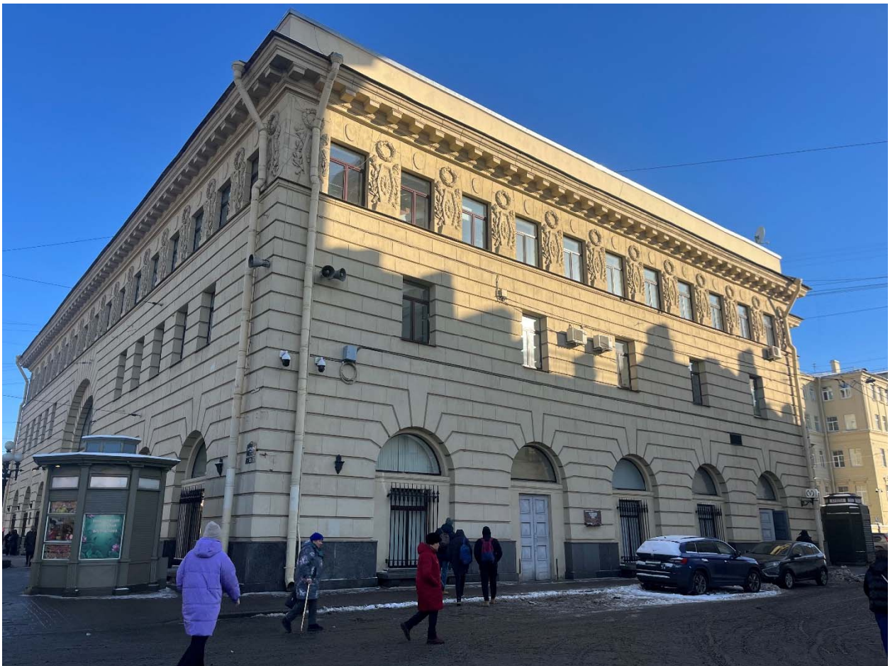
Фото №29. Юго-западный фасад.
