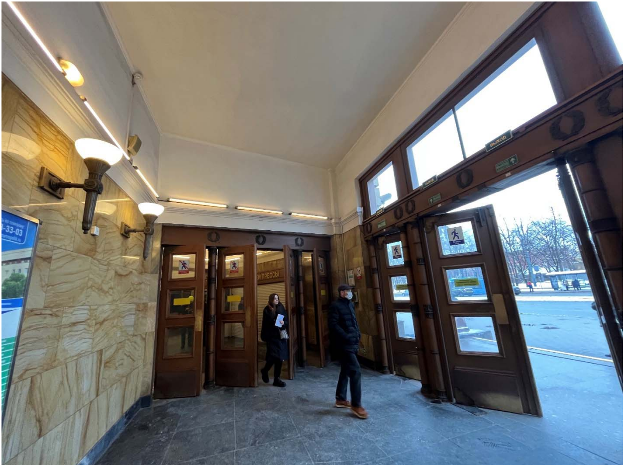
Фото №1. Тамбур выхода в вестибюль, пом. 2-Н(1).
