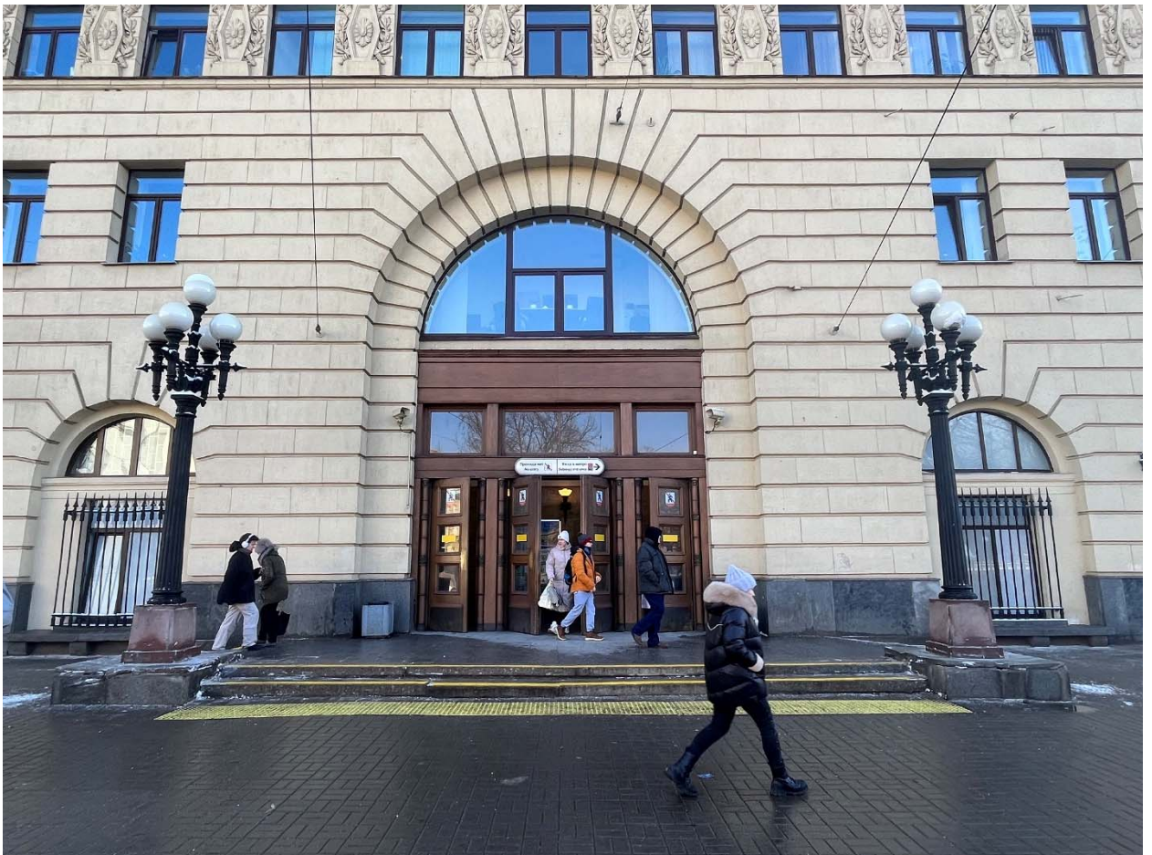
Фото №32. Северо-западный фасад, выход.
