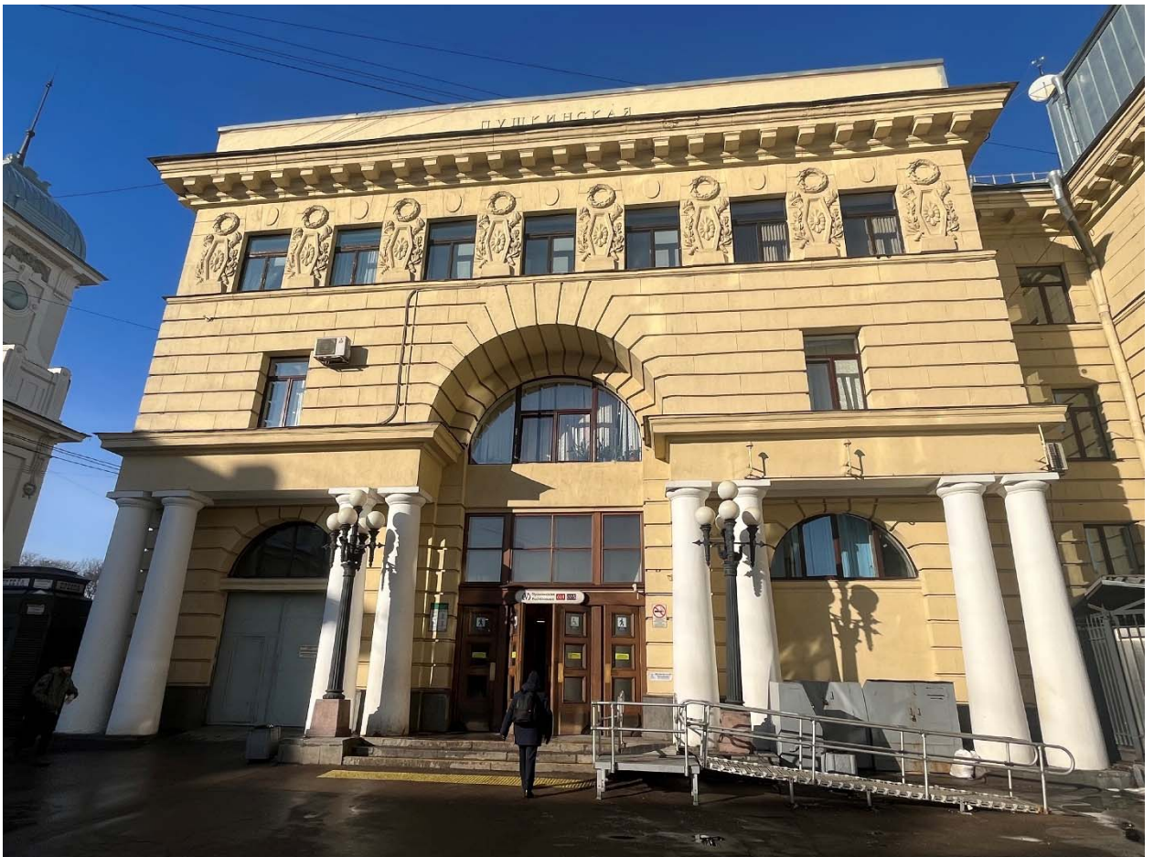
Фото №31. Юго-восточный фасад, вход.
