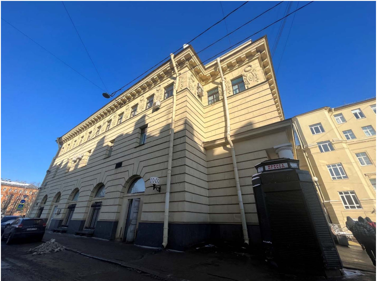
Фото №30. Юго-западный фасад.
