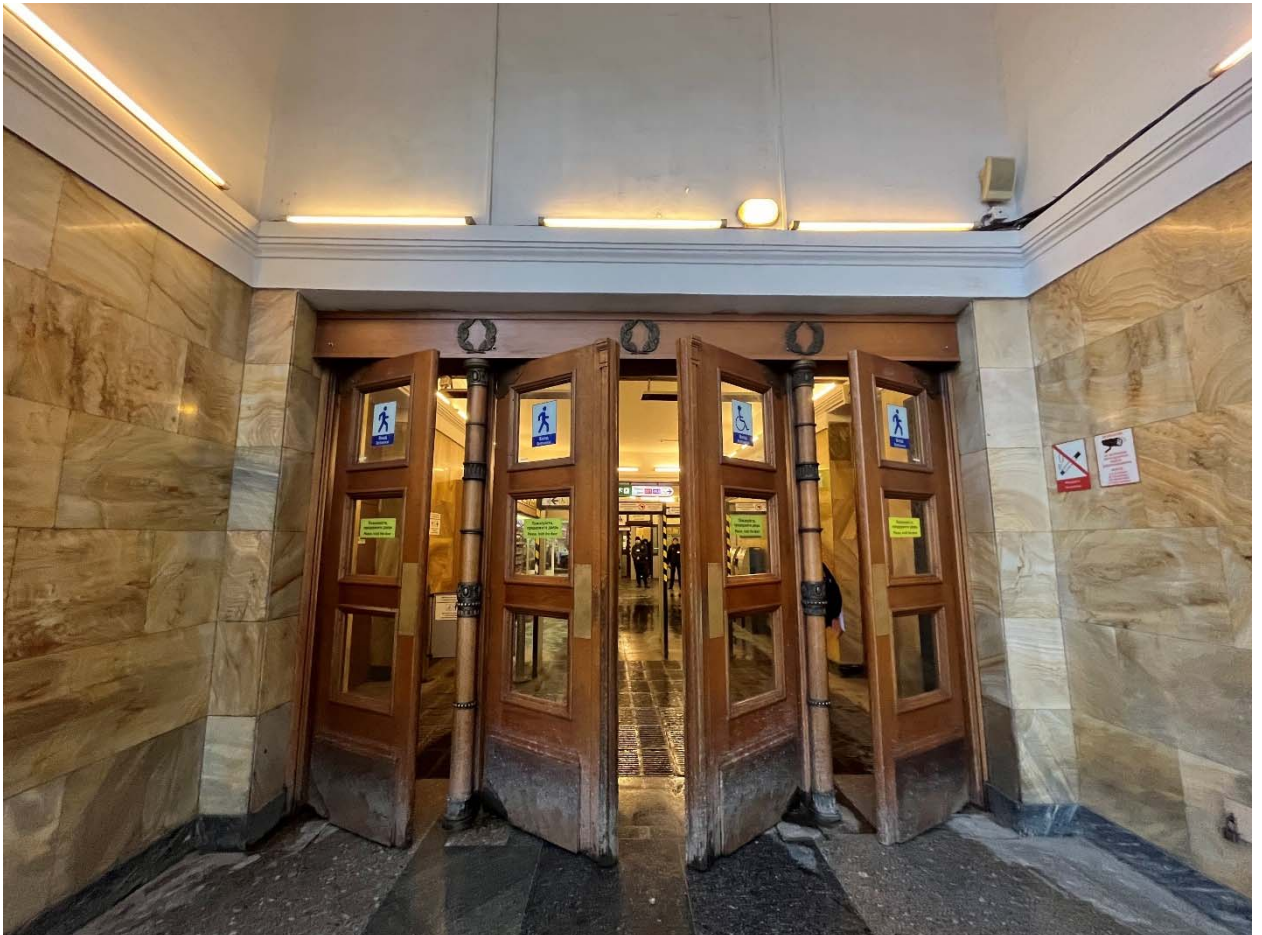
Фото №10. Тамбур входа в вестибюль, пом. 2-Н(12).
