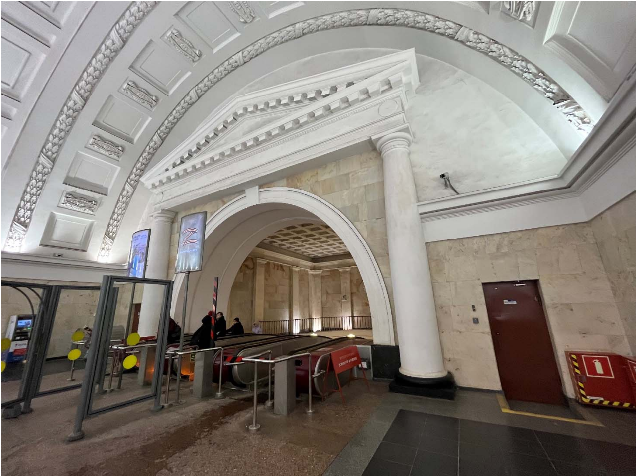
Фото №9. Вестибюль, пом. 2-Н(31).
