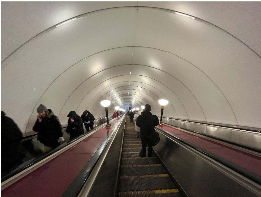
Фото №13. Наклонный ход (эскалаторы).
