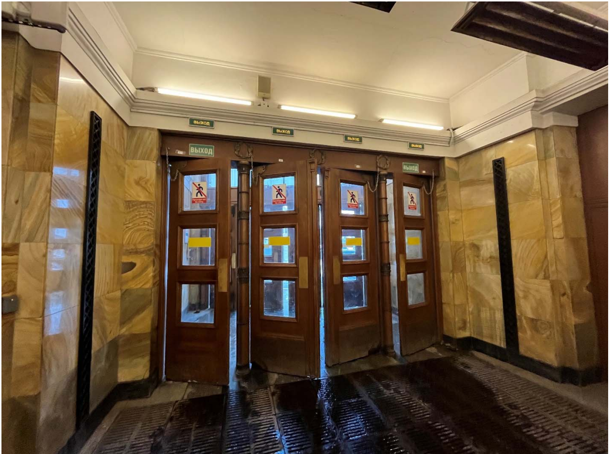
Фото №11. Двери входа, пом. 2-Н(11).
