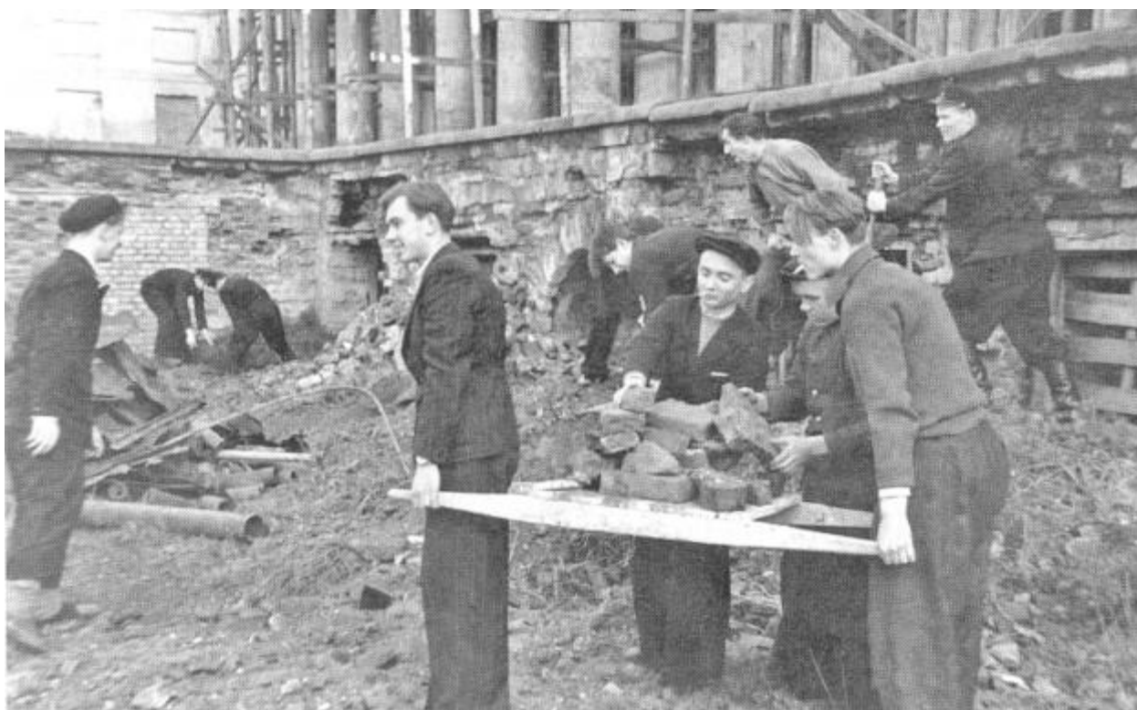
21. Студенты ЛИИЖТа на работах по восстановлению Дворца Юсуповых на Фонтанке. Фото 1945 г. Фрагмент северного фасада. https://pastvu.com/p/115848
