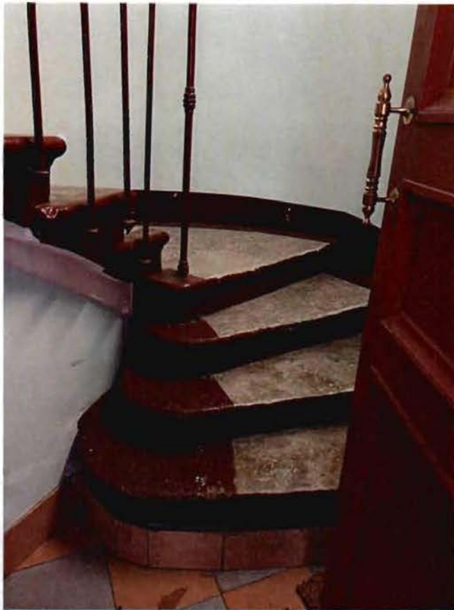
40, 41. Лестница западного флигеля.
