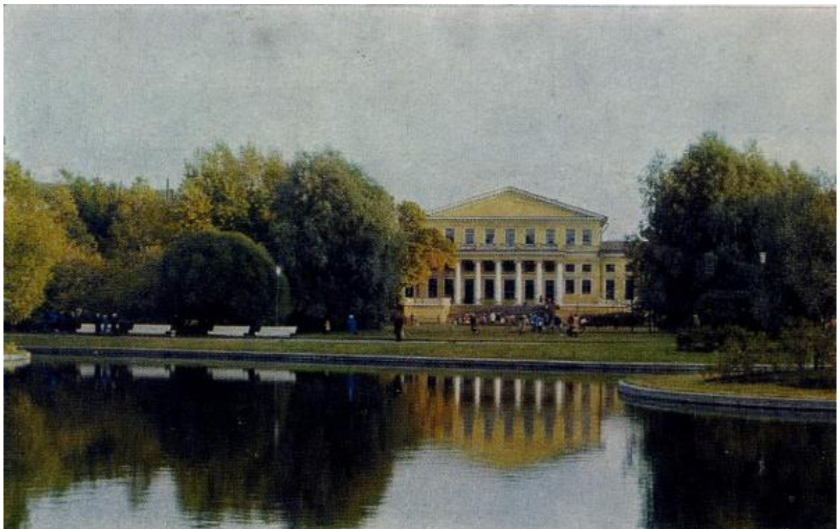
25. Центральная часть северного фасада здания Ленинградского института инженеров железнодорожного транспорта. Вид из сада. Фото 1978 г. Пилявский В.И. Джакомо Кваренги. Архитектор. Художник. Л., 1981. С.147.
