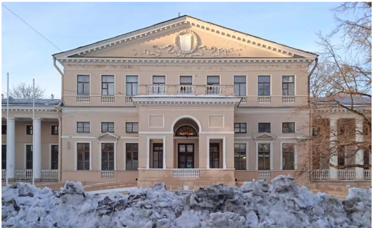
2. Вид на центральную часть лицевого фасада здания со стороны р. Фонтанка и главный вход.
