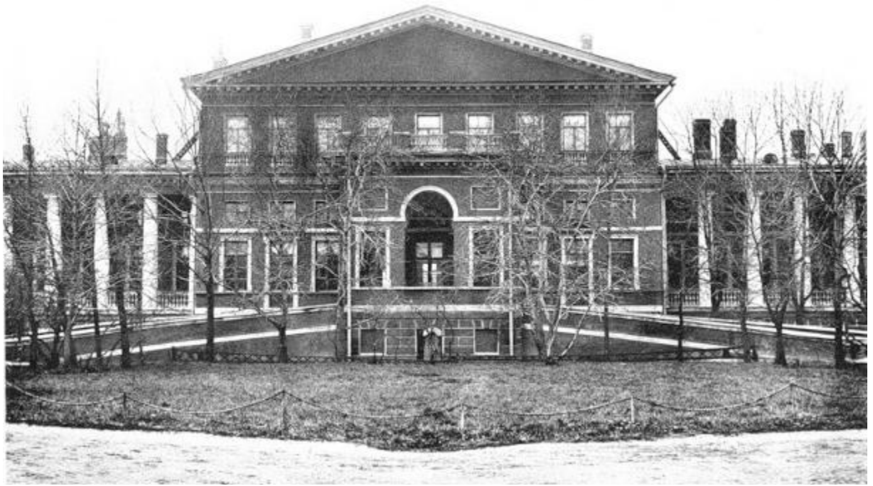
18. Центральная часть южного фасада. Фото 1910 г. https://pastvu.com/p/113558 (Фотоальбом к 100-летию Института инженеров путей сообщения императора Александра I).
