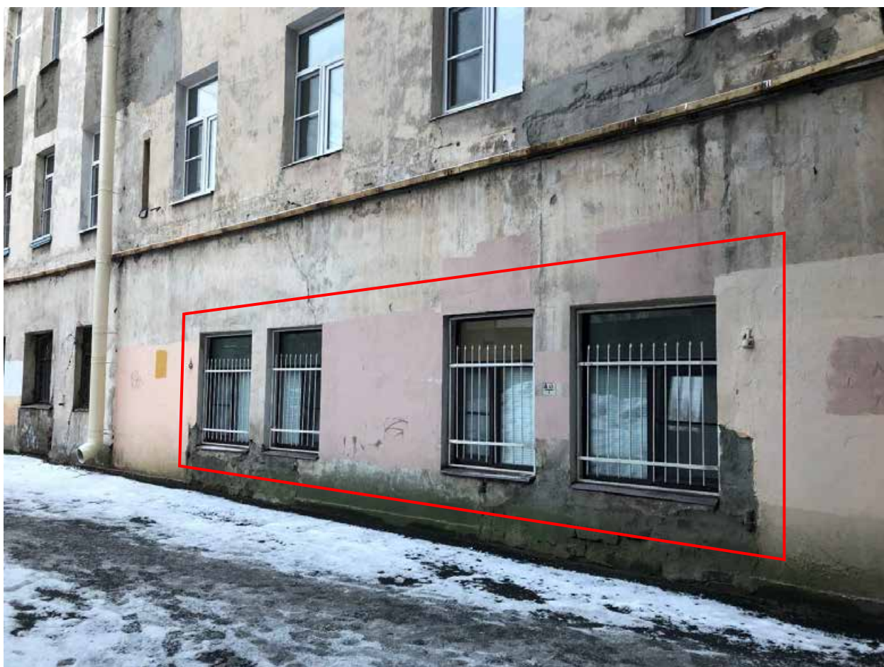
Фото 8. Вид на дворовый фасад.
