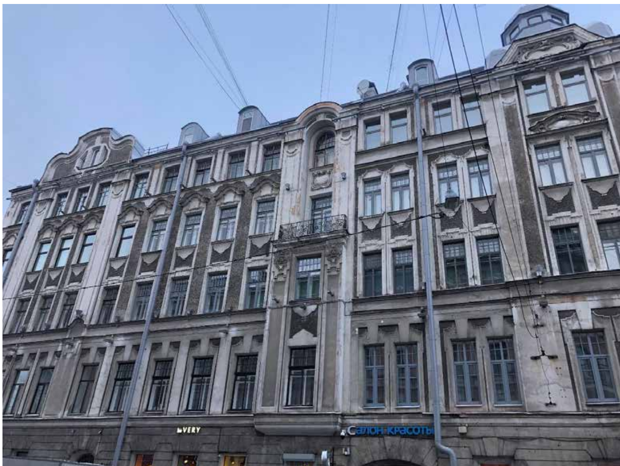
Фото 3. Вид на лицевой фасад, выходящий на улицу Мира.
