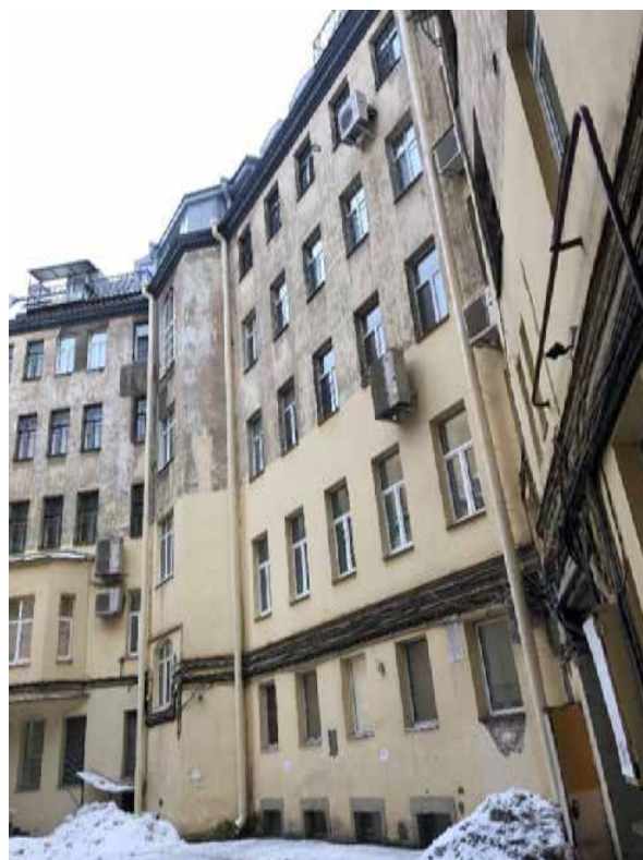
Фото 5. Вид на дворовый фасад.
