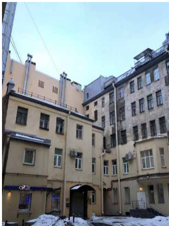
Фото 4. Вид на дворовый фасад.
