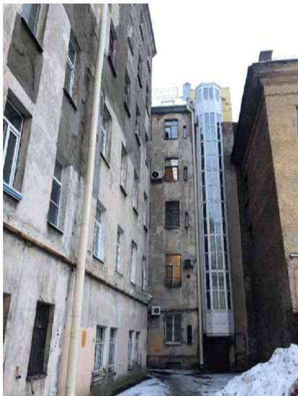
Фото 6. Вид на дворовый фасад.
