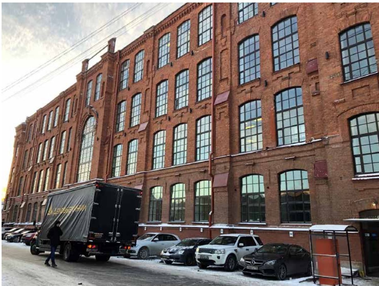
Фото 1. Вид на северо-восточный фасад.
