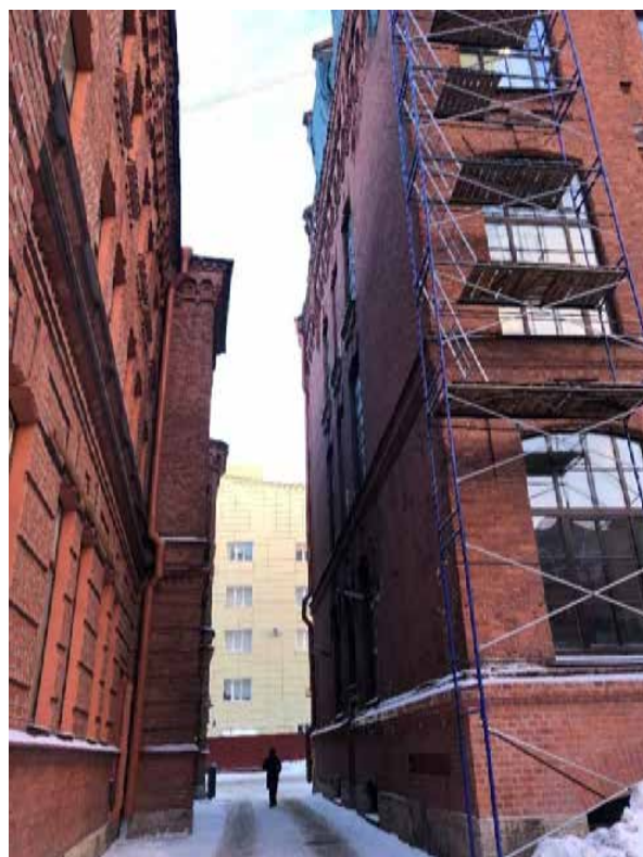
Фото 5. Вид на северо-западный торцевой фасад.
