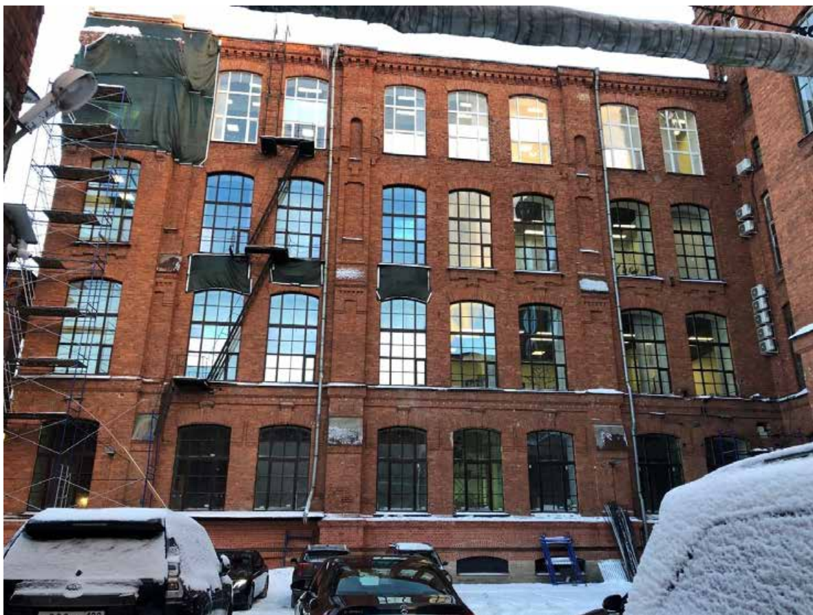
Фото 7. Вид на юго-западный фасад.
