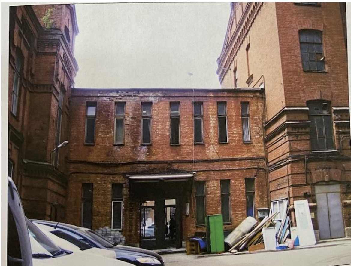
146. Здание проходной. 2009 г. Архив КГИОП Н-15400
