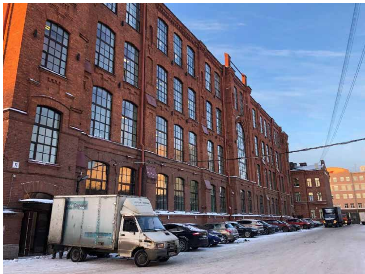
Фото 2. Вид на северо-восточный фасад.
