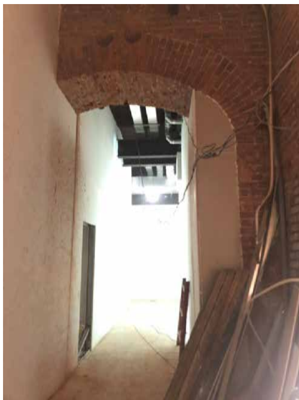
Фото 1. Коридор в помещении № 1.13.
