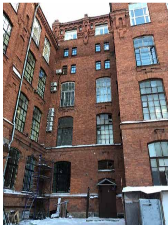
Фото 6. Вид на северо-западный фасад выступающей части.
