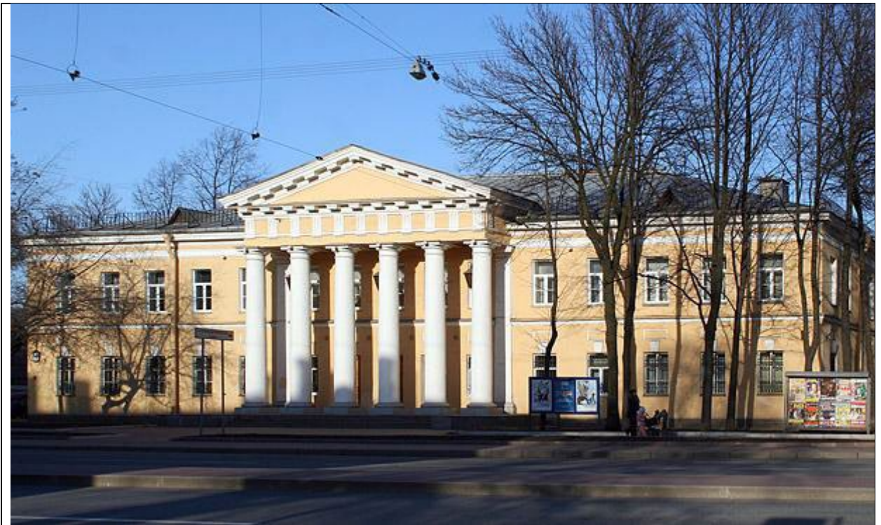
7. Общий вид на лицевой фасад Солдатской казармы, фото 2014 г.
