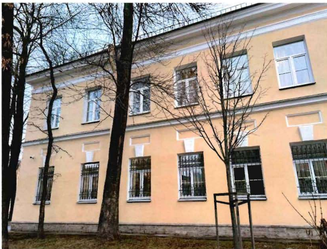
3. Южный фасад объекта культурного наследия.
