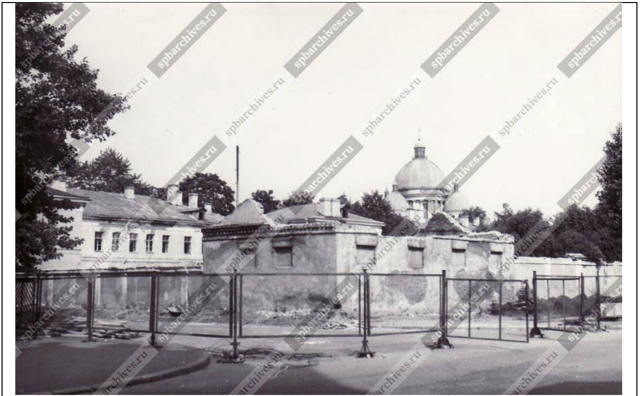
5. Снос старого здания для строительства Детского театра «На Неве»; вид на дворовый фасад Солдатской казармы. Фото 20 июля 1986 г. ЦГАКФФД СПб. Ар 217908
