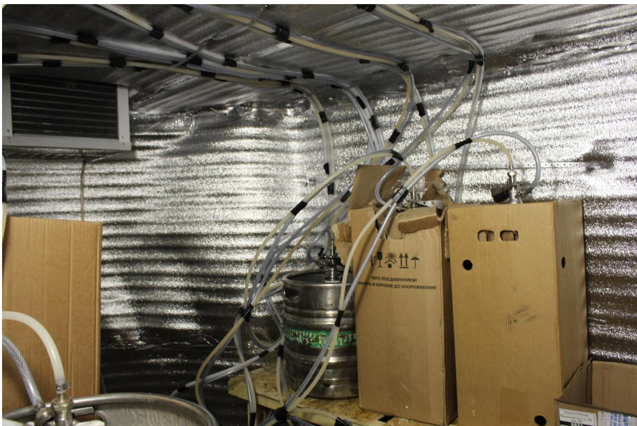
Фото 16. Интерьер помещения 10-Н выявленного объекта культурного наследия «Здание 2» по адресу: Санкт-Петербург, Московский пр., 159, входящего в состав выявленного объекта культурного наследия «Жилые дома (4 здания)».
