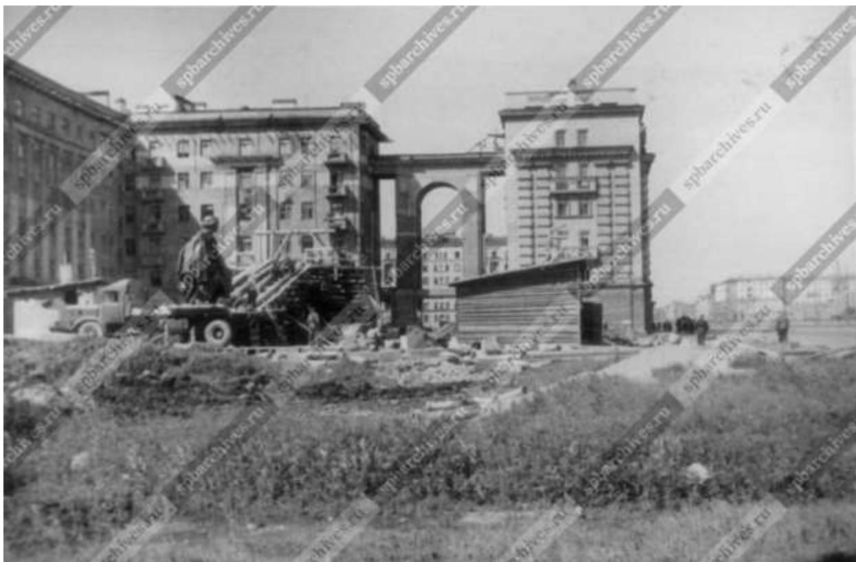
Илл. 22. Строительные работы во дворе одного из домов на Международном проспекте. 1947 г. (источник: ЦГАКФД СПб. Фотодокумент Бпр 612).
