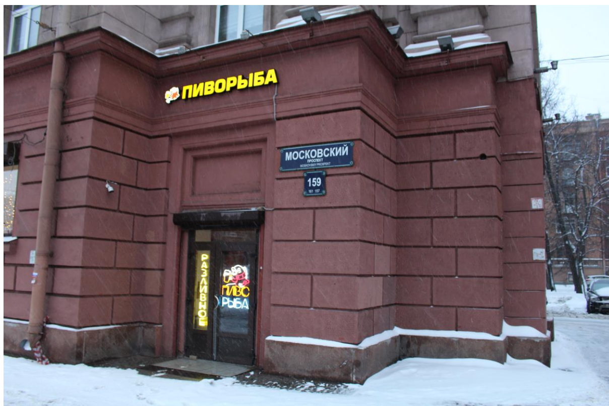
Фото 3. Вид на фрагмент восточного фасада выявленного объекта культурного наследия «Здание 2» по адресу: Санкт-Петербург, Московский пр., 159, входящего в состав выявленного объекта культурного наследия «Жилые дома (4 здания)», в границах помещения 10-Н.
