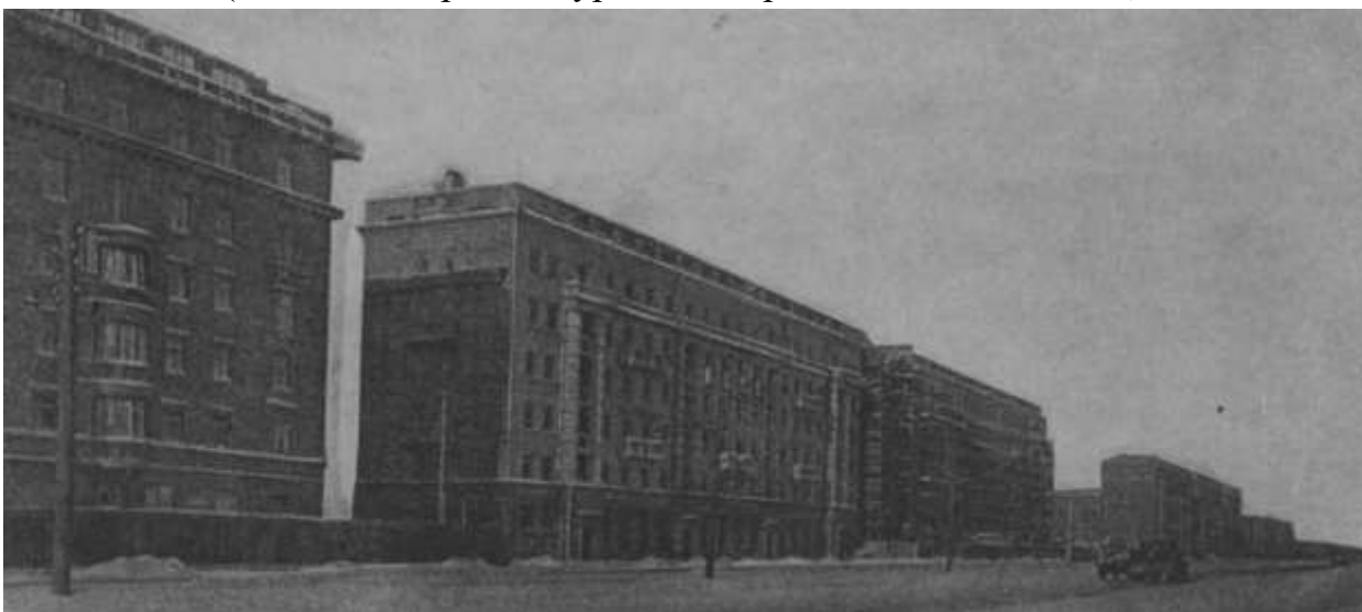
Илл. 14. Застройка квартала 26 по Московскому шоссе (источник: Архитектура Ленинграда. 1940. № 1. С. 9).
