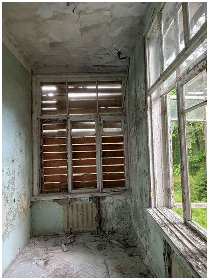
Фото 53. Выявленный объект культурного наследия «Дом купца Елисеева (ресторан) (деревянный)» по адресу: Санкт-Петербург, г. Зеленогорск Приморское шоссе, дом 520, литера Ц.
