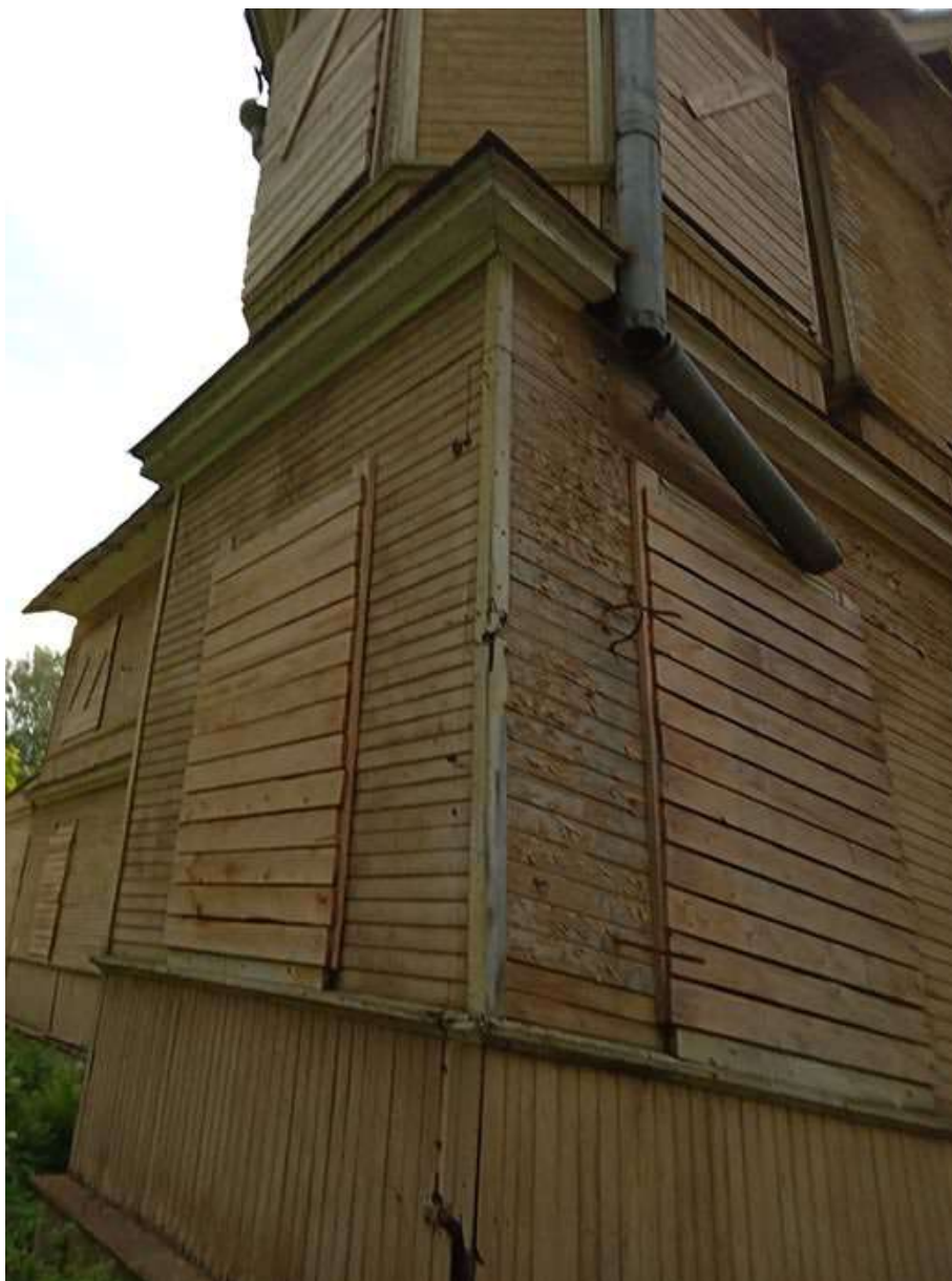
Фото 16. Выявленный объект культурного наследия «Дом купца Елисеева (ресторан) (деревянный)» по адресу: Санкт-Петербург, г. Зеленогорск Приморское шоссе, дом 520, литера Ц.
