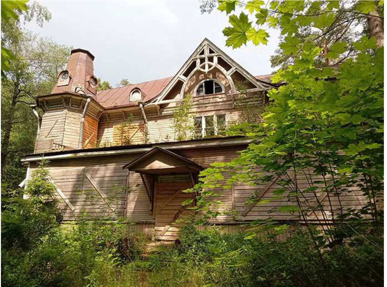
Фото 27. Выявленный объект культурного наследия «Дом купца Елисеева (ресторан) (деревянный)» по адресу: Санкт-Петербург, г. Зеленогорск Приморское шоссе, дом 520, литера Ц.
