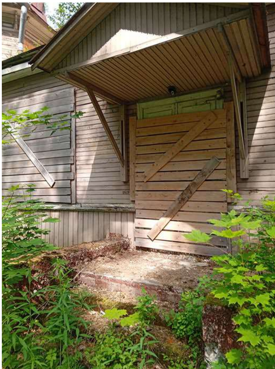
Фото 33. Выявленный объект культурного наследия «Дом купца Елисеева (ресторан) (деревянный)» по адресу: Санкт-Петербург, г. Зеленогорск Приморское шоссе, дом 520, литера Ц.
