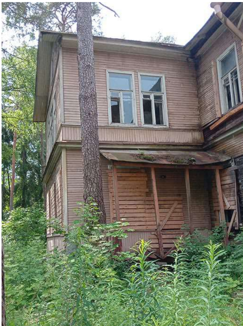
Фото 23. Выявленный объект культурного наследия «Дом купца Елисеева (ресторан) (деревянный)» по адресу: Санкт-Петербург, г. Зеленогорск Приморское шоссе, дом 520, литера Ц.
