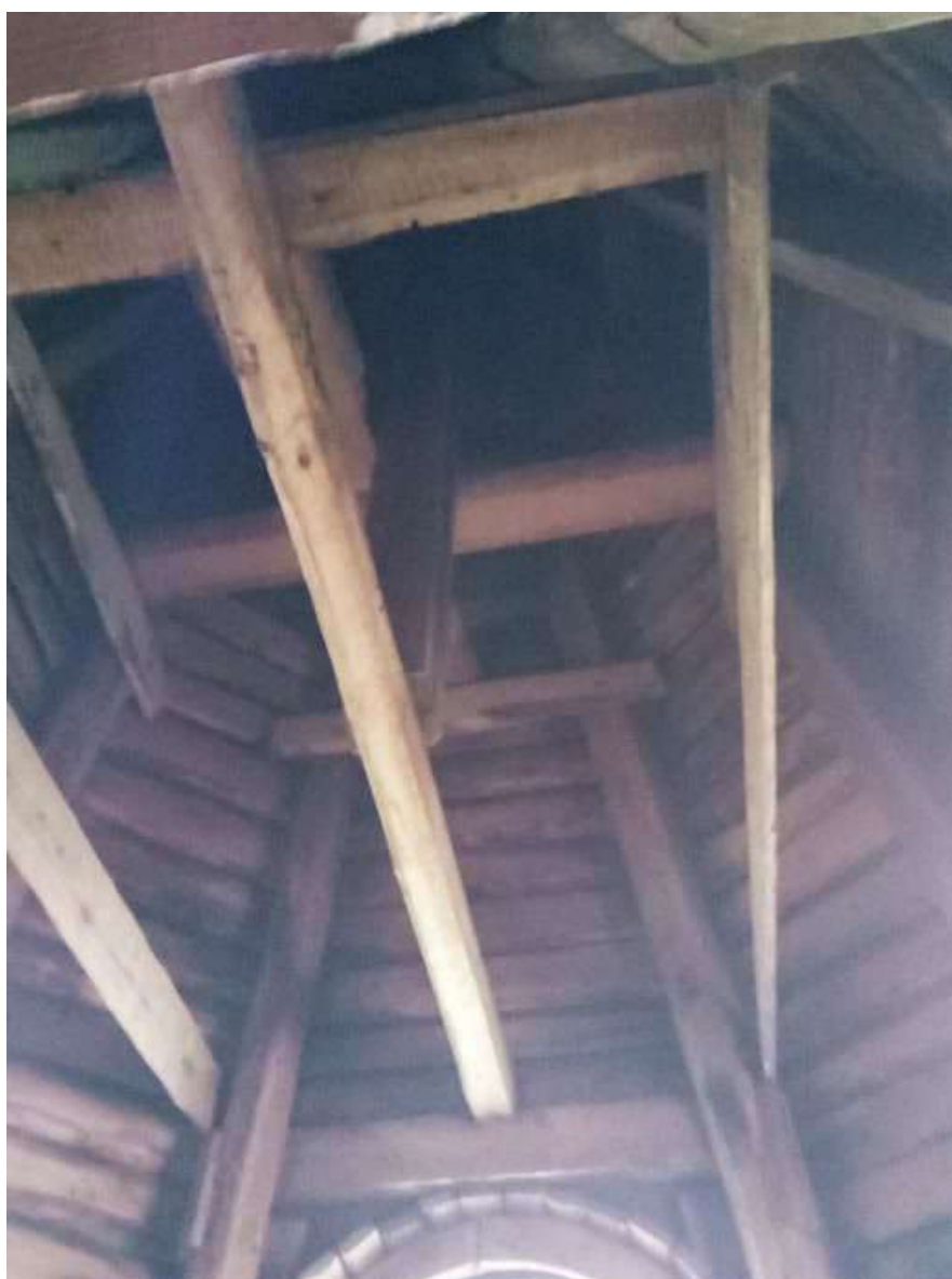
Фото 59. Выявленный объект культурного наследия «Дом купца Елисеева (ресторан) (деревянный)» по адресу: Санкт-Петербург, г. Зеленогорск Приморское шоссе, дом 520, литера Ц.
