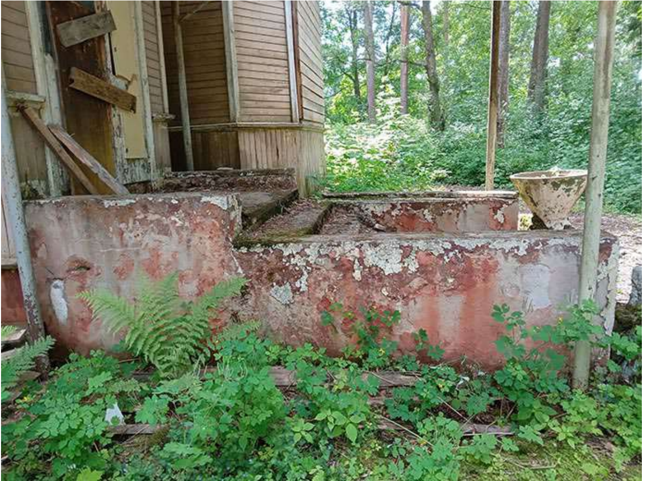
Фото 5. Выявленный объект культурного наследия «Дом купца Елисеева (ресторан) (деревянный)» по адресу: Санкт-Петербург, г. Зеленогорск Приморское шоссе, дом 520, литера Ц.
