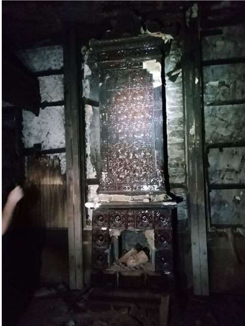
Фото 40. Выявленный объект культурного наследия «Дом купца Елисеева (ресторан) (деревянный)» по адресу: Санкт-Петербург, г. Зеленогорск Приморское шоссе, дом 520, литера Ц.
