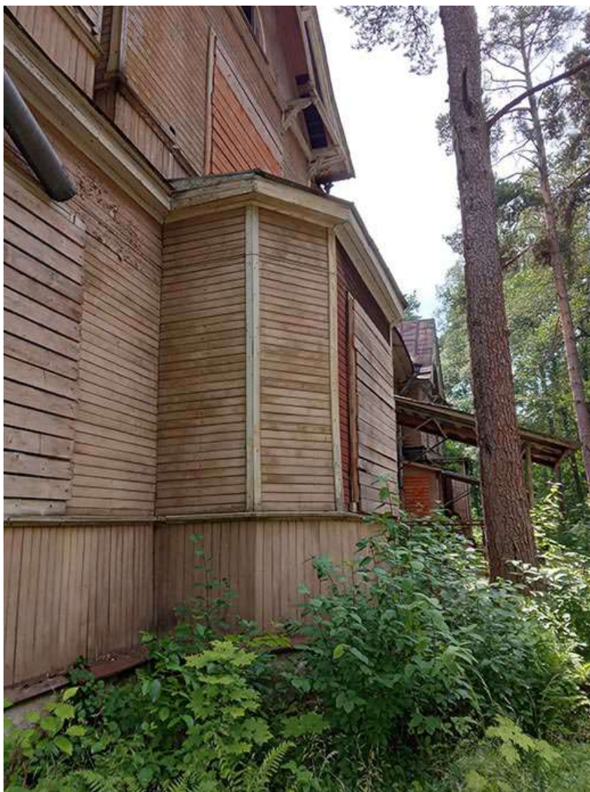
Фото 15. Выявленный объект культурного наследия «Дом купца Елисеева (ресторан) (деревянный)» по адресу: Санкт-Петербург, г. Зеленогорск Приморское шоссе, дом 520, литера Ц.
