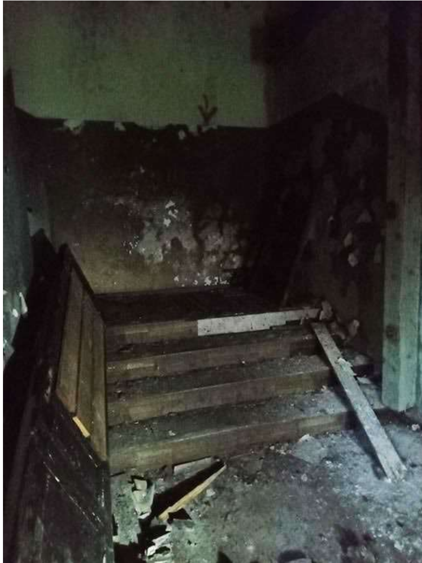
Фото 44. Выявленный объект культурного наследия «Дом купца Елисеева (ресторан) (деревянный)» по адресу: Санкт-Петербург, г. Зеленогорск Приморское шоссе, дом 520, литера Ц.
