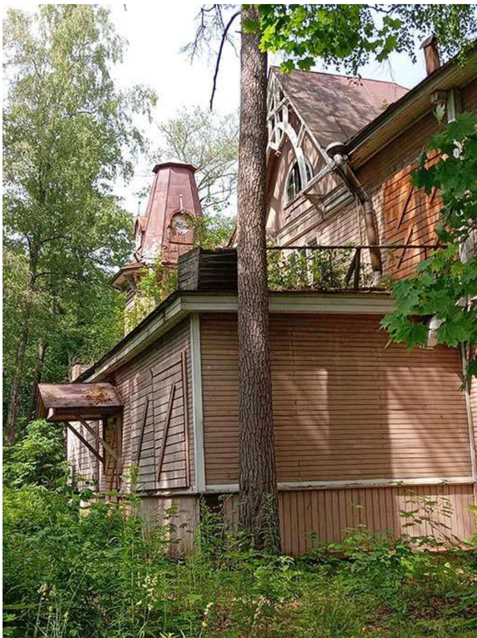
Фото 29. Выявленный объект культурного наследия «Дом купца Елисеева (ресторан) (деревянный)» по адресу: Санкт-Петербург, г. Зеленогорск Приморское шоссе, дом 520, литера Ц.
