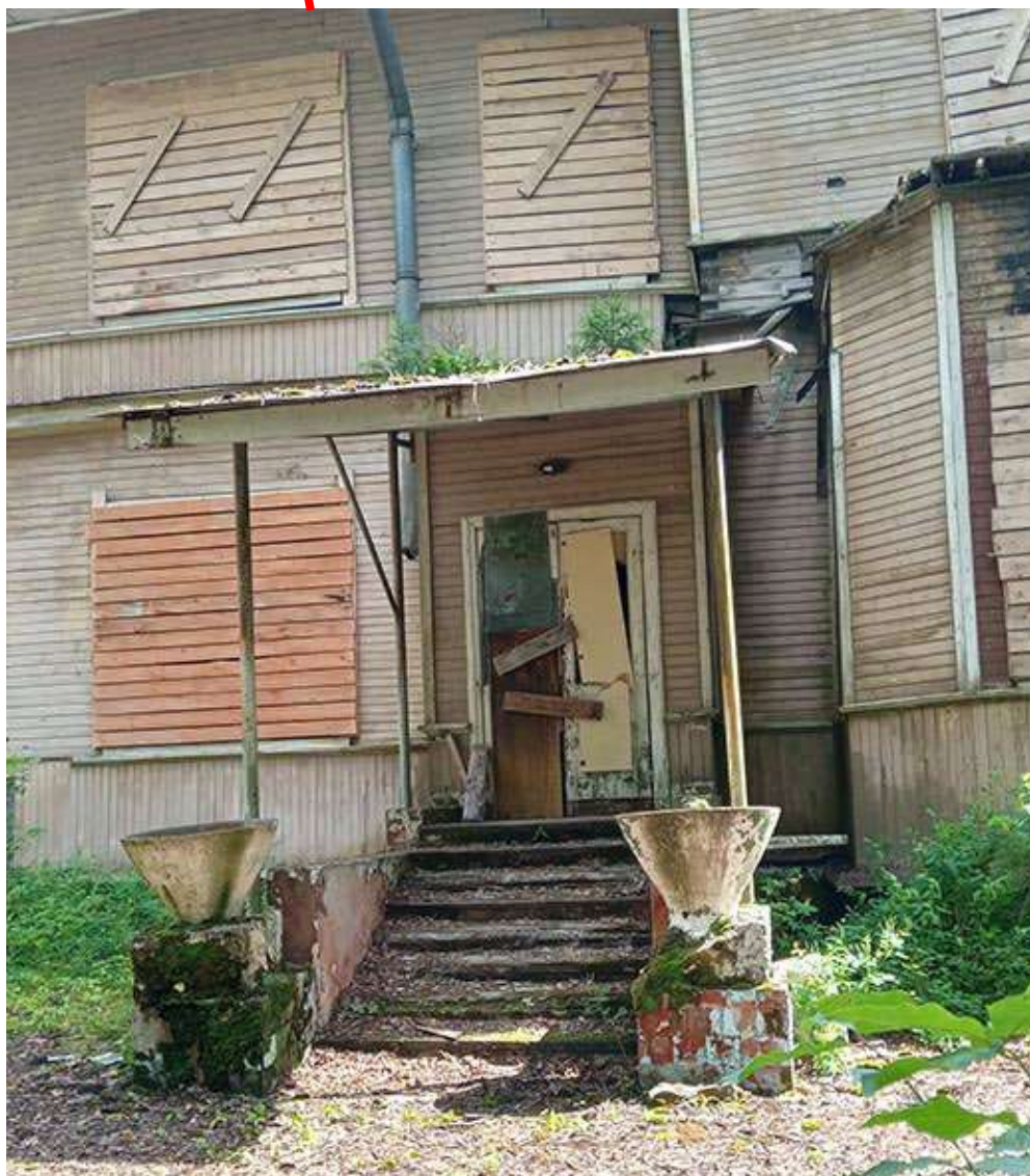
Фото 4. Выявленный объект культурного наследия «Дом купца Елисеева (ресторан) (деревянный)» по адресу: Санкт-Петербург, г. Зеленогорск Приморское шоссе, дом 520, литера Ц.
