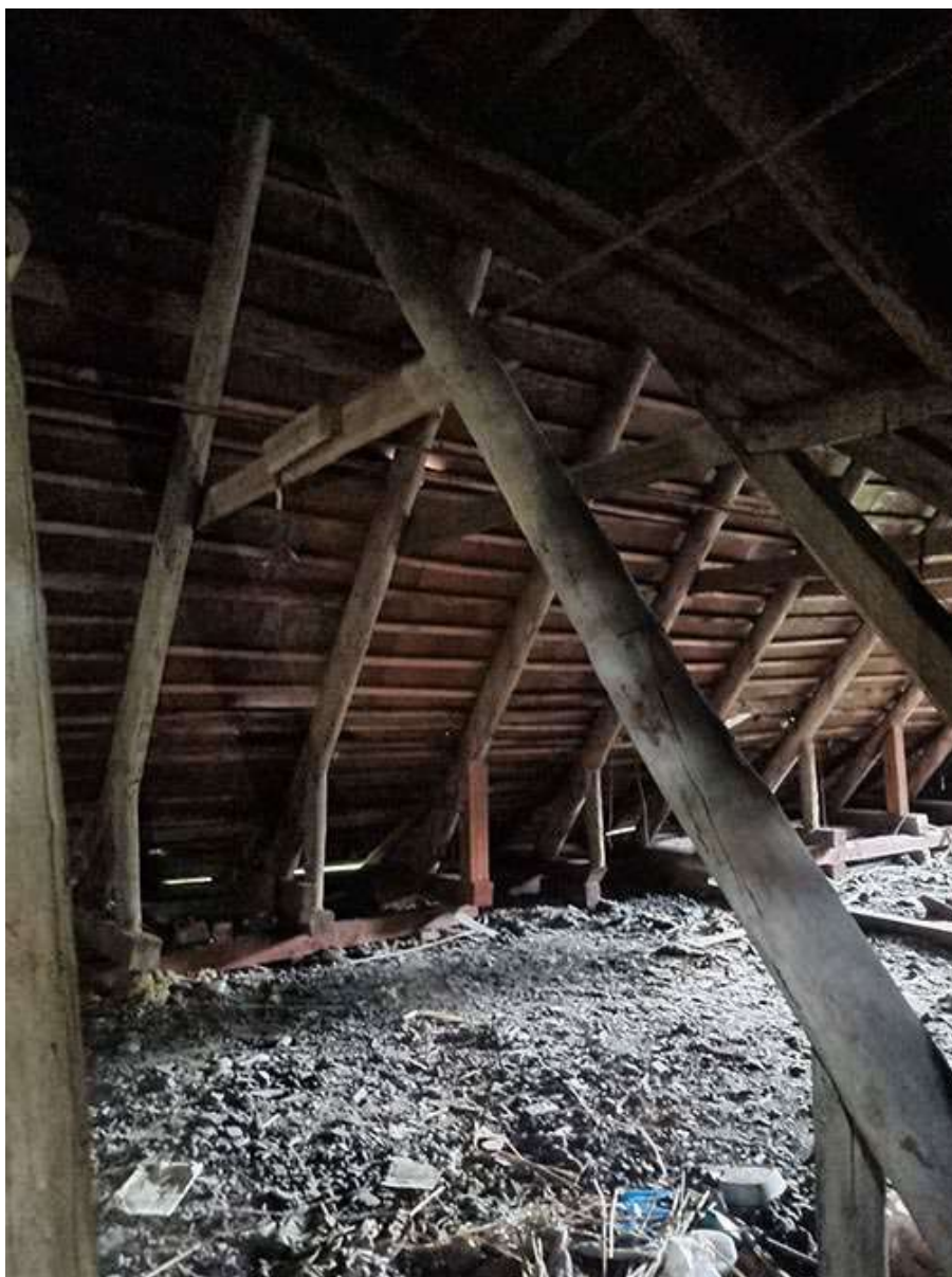
Фото 60. Выявленный объект культурного наследия «Дом купца Елисеева (ресторан) (деревянный)» по адресу: Санкт-Петербург, г. Зеленогорск Приморское шоссе, дом 520, литера Ц.
