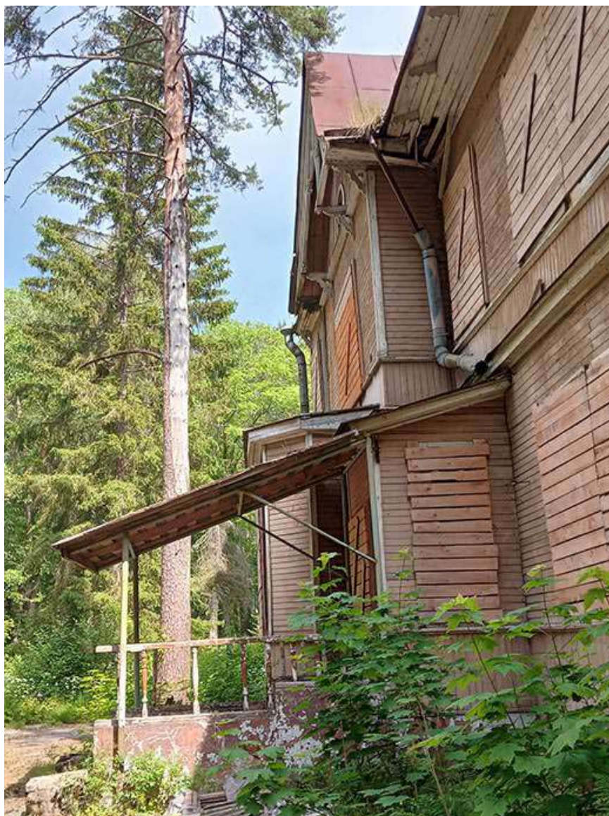
Фото 7. Выявленный объект культурного наследия «Дом купца Елисеева (ресторан) (деревянный)» по адресу: Санкт-Петербург, г. Зеленогорск Приморское шоссе, дом 520, литера Ц.
