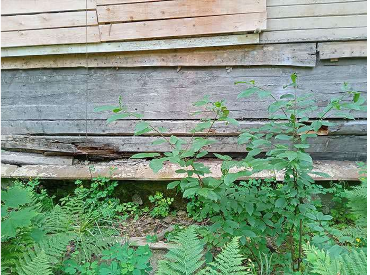
Фото 8. Выявленный объект культурного наследия «Дом купца Елисеева (ресторан) (деревянный)» по адресу: Санкт-Петербург, г. Зеленогорск Приморское шоссе, дом 520, литера Ц.
