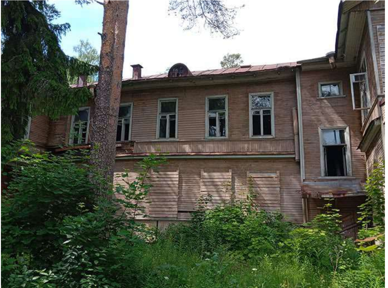
Фото 21. Выявленный объект культурного наследия «Дом купца Елисеева (ресторан) (деревянный)» по адресу: Санкт-Петербург, г. Зеленогорск Приморское шоссе, дом 520, литера Ц.
