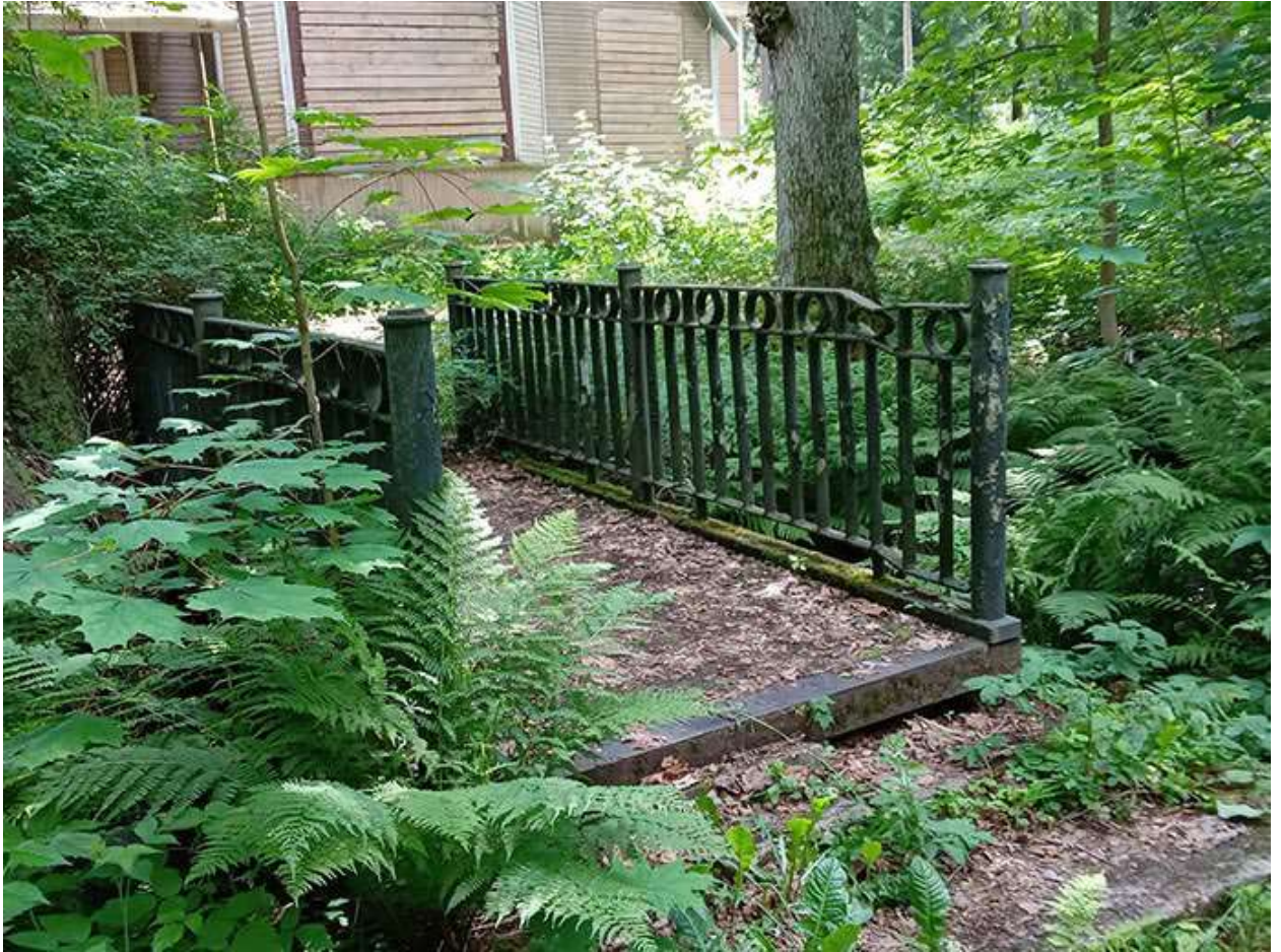
Фото 1. Выявленный объект культурного наследия «Дом купца Елисеева (ресторан) (деревянный)» по адресу: Санкт-Петербург, г. Зеленогорск Приморское шоссе, дом 520, литера Ц.
