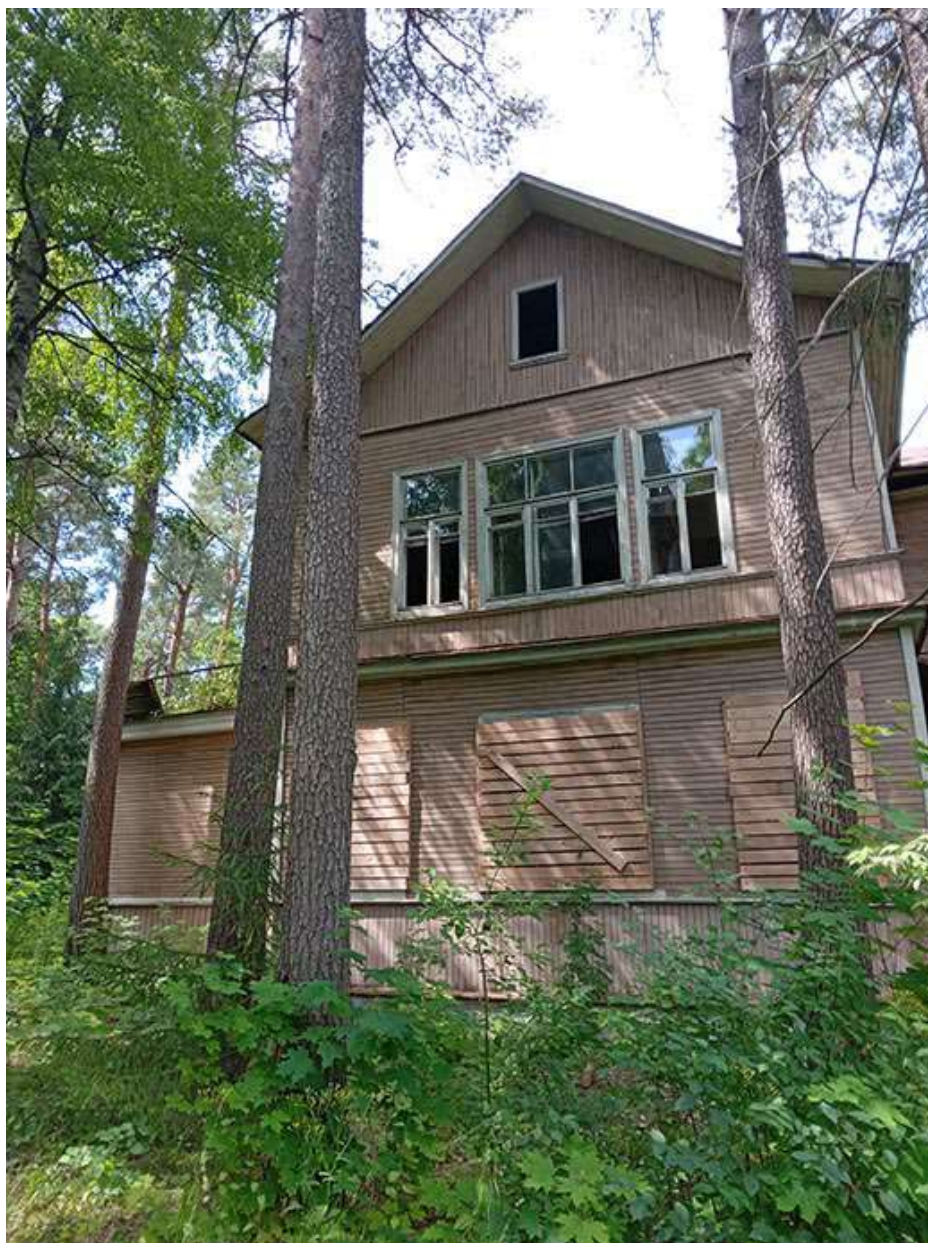
Фото 25. Выявленный объект культурного наследия «Дом купца Елисеева (ресторан) (деревянный)» по адресу: Санкт-Петербург, г. Зеленогорск Приморское шоссе, дом 520, литера Ц.
