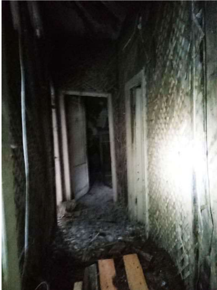
Фото 48. Выявленный объект культурного наследия «Дом купца Елисеева (ресторан) (деревянный)» по адресу: Санкт-Петербург, г. Зеленогорск Приморское шоссе, дом 520, литера Ц.
