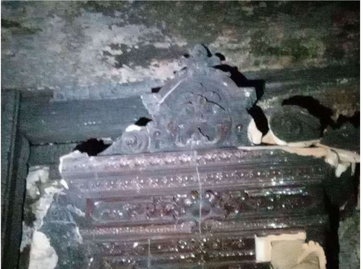
Фото 41. Выявленный объект культурного наследия «Дом купца Елисеева (ресторан) (деревянный)» по адресу: Санкт-Петербург, г. Зеленогорск Приморское шоссе, дом 520, литера Ц.
