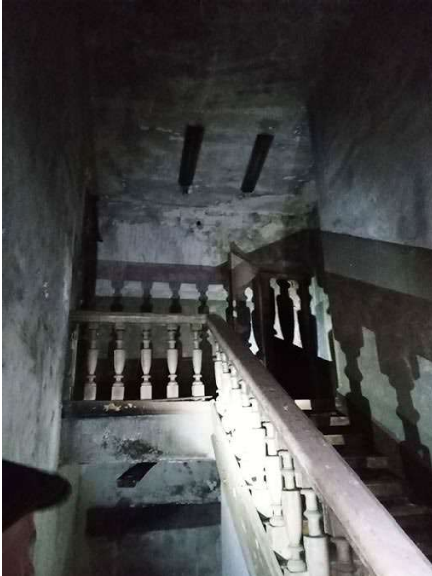
Фото 47. Выявленный объект культурного наследия «Дом купца Елисеева (ресторан) (деревянный)» по адресу: Санкт-Петербург, г. Зеленогорск Приморское шоссе, дом 520, литера Ц.
