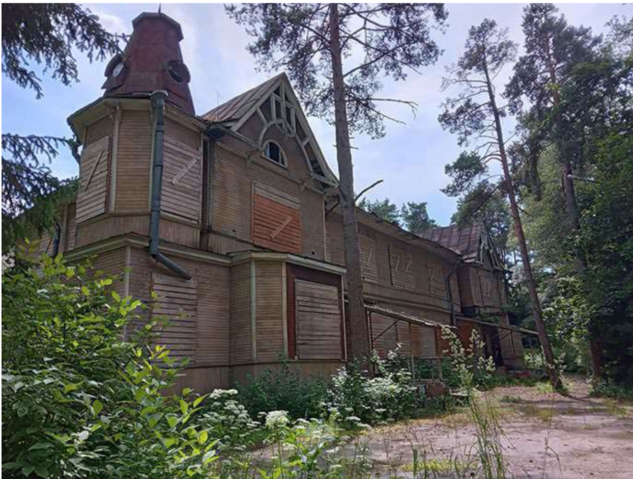
Фото 14. Выявленный объект культурного наследия «Дом купца Елисеева (ресторан) (деревянный)» по адресу: Санкт-Петербург, г. Зеленогорск Приморское шоссе, дом 520, литера Ц.
