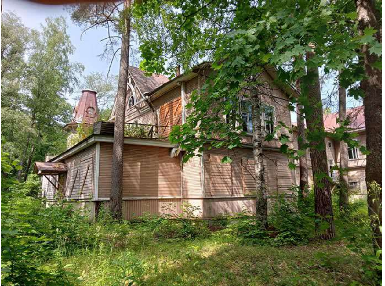
Фото 26. Выявленный объект культурного наследия «Дом купца Елисеева (ресторан) (деревянный)» по адресу: Санкт-Петербург, г. Зеленогорск Приморское шоссе, дом 520, литера Ц.
