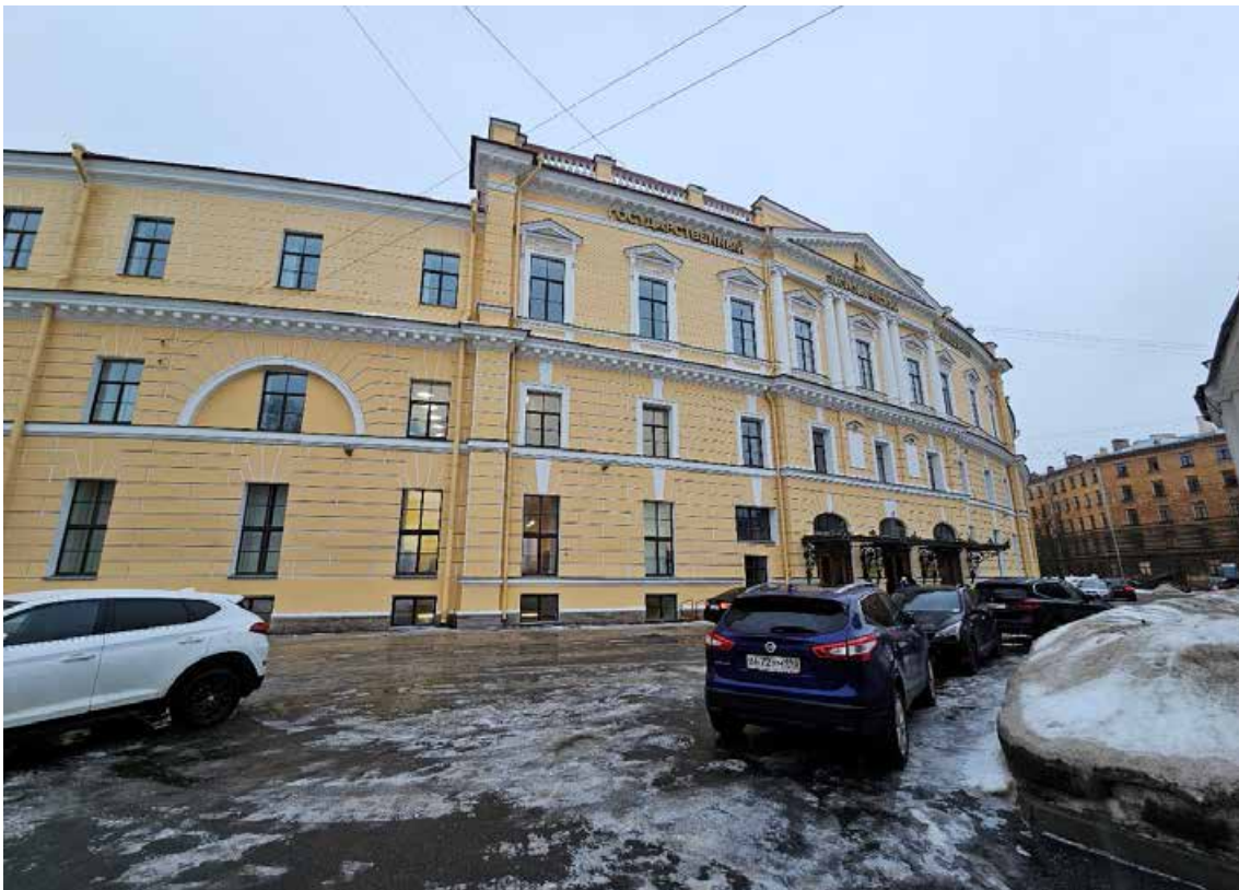
6. Объект культурного наследия федерального значения «Банк», расположенный по адресу: г. Санкт-Петербург, наб. кан. Грибоедова, д. 30-32, лит. А, входящий в состав объекта культурного наследия федерального значения «Банк Ассигнационный». Центральная часть северо-западного лицевого фасада по наб. канала Грибоедова.
