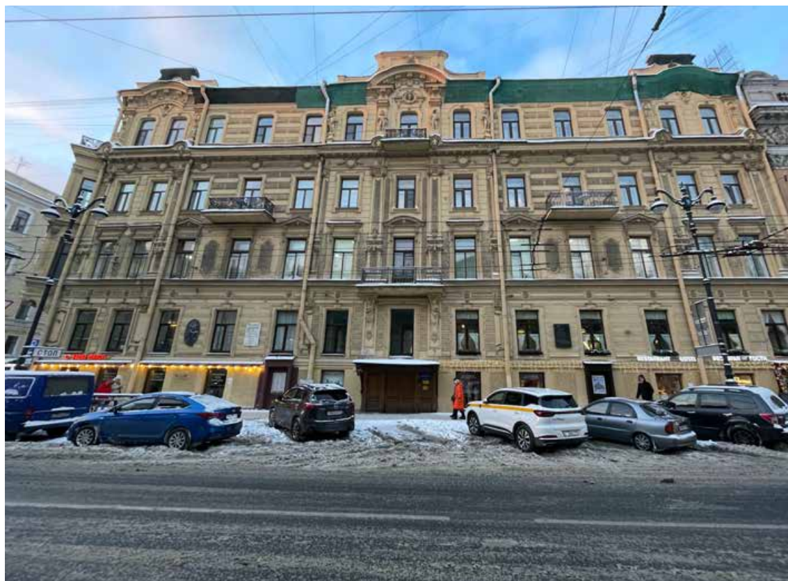
1. Лицевой фасад объекта со стороны ул. Малая Морская
