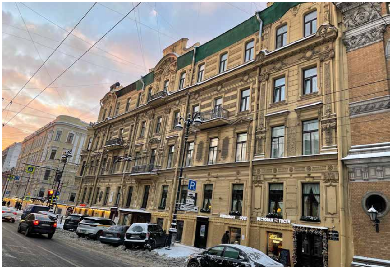
2. Лицевой фасад объекта со стороны ул. Малая Морская
